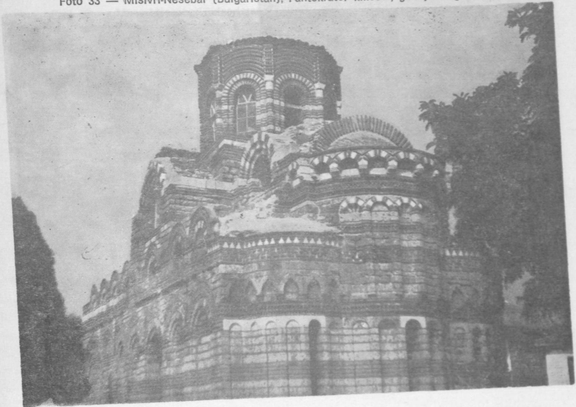
Foto 33 — Misivri-Nesebar (Bulgaristan), Pantokrator kilisesi, güneybatı görünüm
