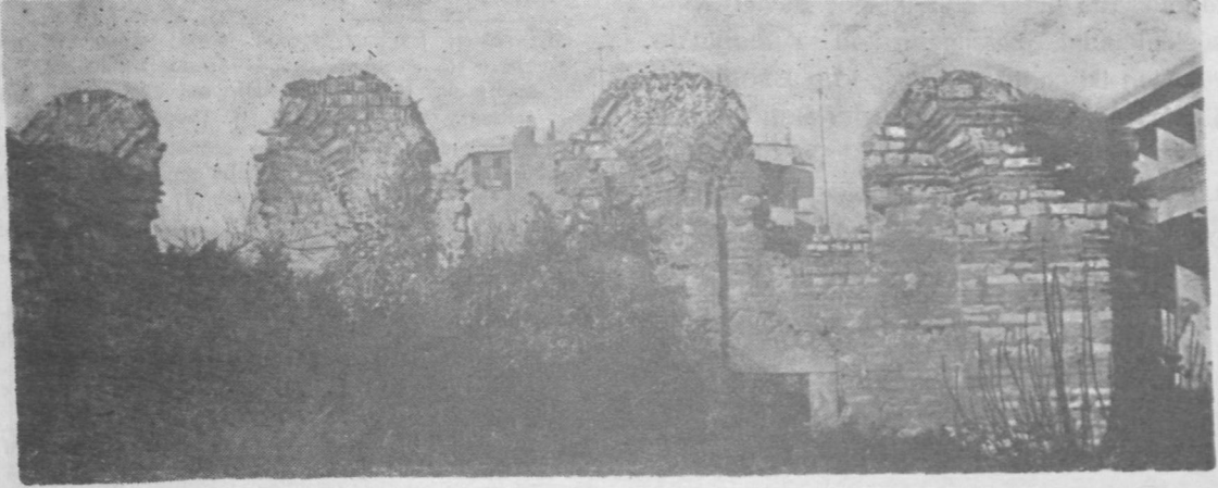
Foto 12 — İstanbul, İsa kapı mescidi, güney cephesi, genel görünüm
