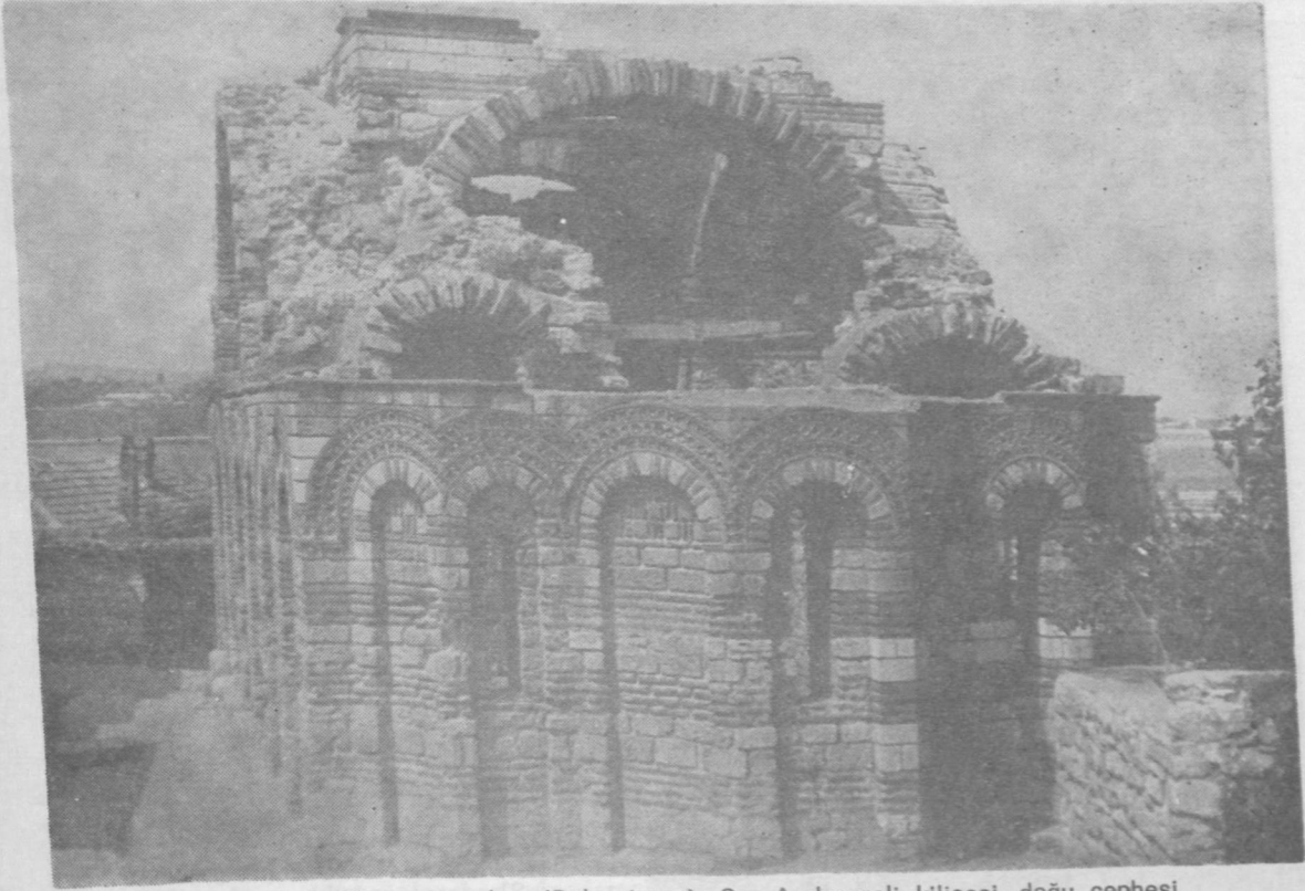
Foto 32 — Misivri-Nesebar (Bulgaristan), Sv. Archangeli kilisesi, doğu cephesi
