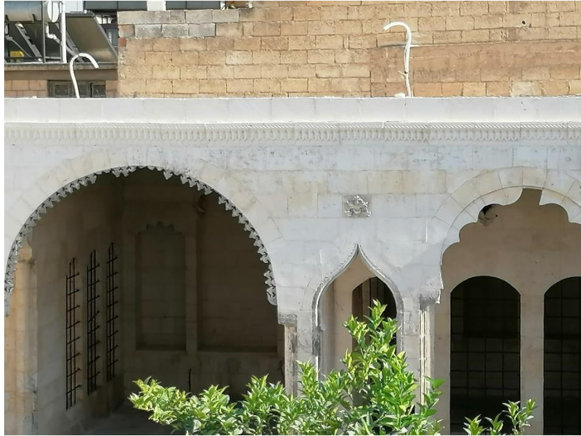
Fotoğraf 54. Güney Cephe Restorasyon Sonrası Genel Görünümü
