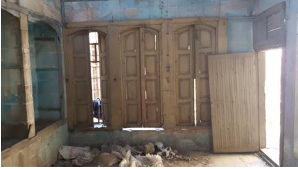
Şekil 0.39. Ahşap Kapı ve Pencere Kepenkleri
