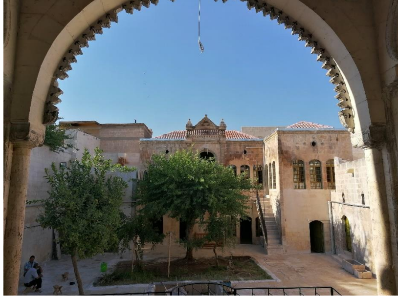
Fotoğraf 41. Güney Cephe Kemerli Girişinden Kuzey Cepheye Bakış
