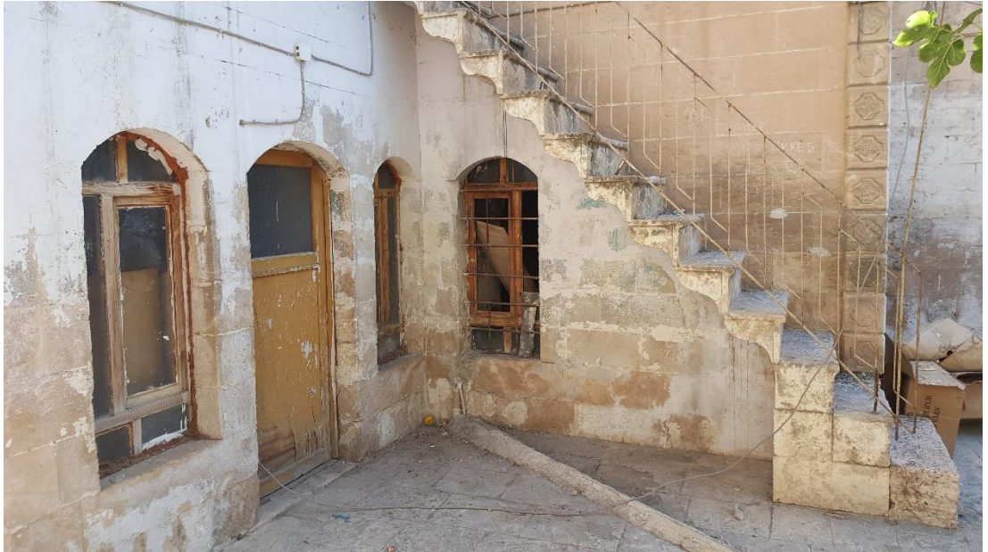
Fotoğraf 20. Kuzey Cephe Çıkış Merdiveni Yan Profili
