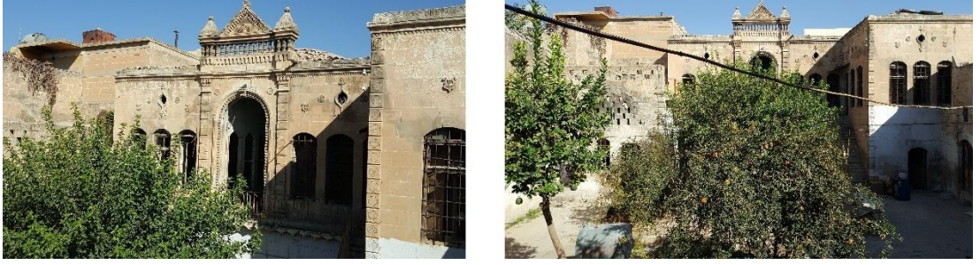
Şekil 0.30. Avlu İçindeki Kuzey Cephesinden Görünüş
