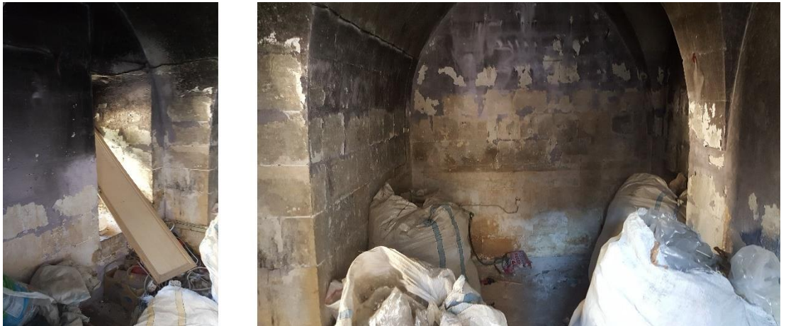
Şekil 0.20. Z-05 Nolu Kilerden İç Görünüş
