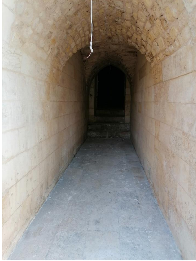
Fotoğraf 56. 1007 Nolu Sokaktan Girilen Tonozlu Giriş Bölümü
