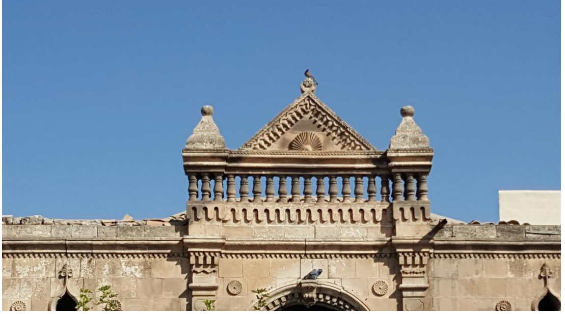
Şekil 0.31. Cephelerdeki Taş Silmeler
