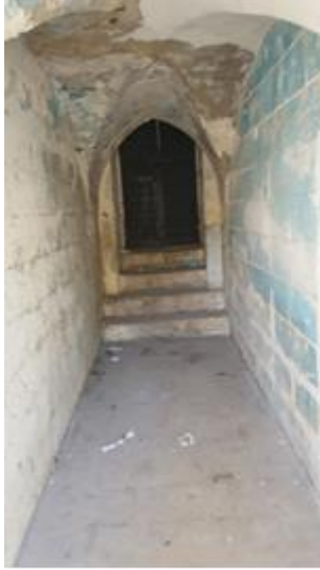
Şekil 0.10. Kapı Arası ve Demir Kapının İçten Görünüşü (7 Mart, 2019)
