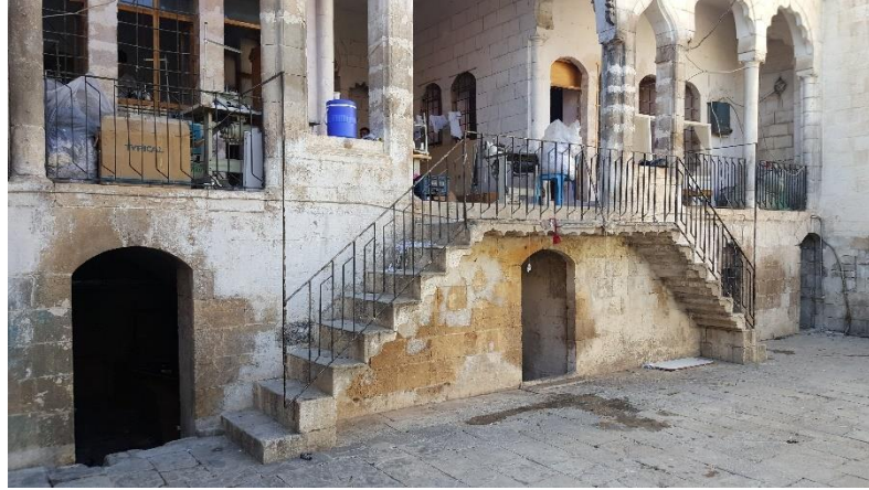
Şekil 0.12. Güney Eyvanına Ulaşılan Merdiven
