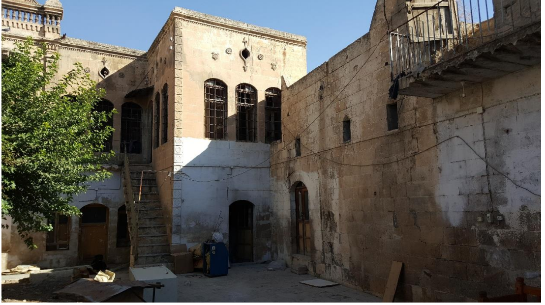
Fotoğraf 25. Kuzey Cephe
