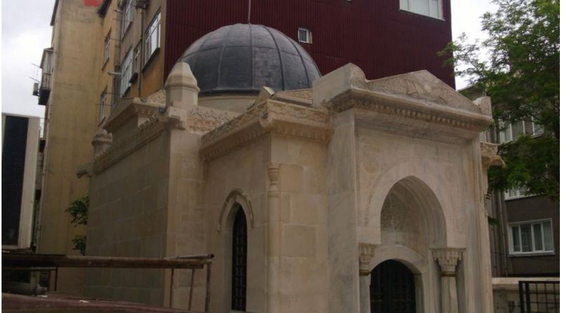
Şekil 3.105 : Restorasyon Sonrası Ahmed Cevad Paşa Türbesi (2012) (Url-18)
