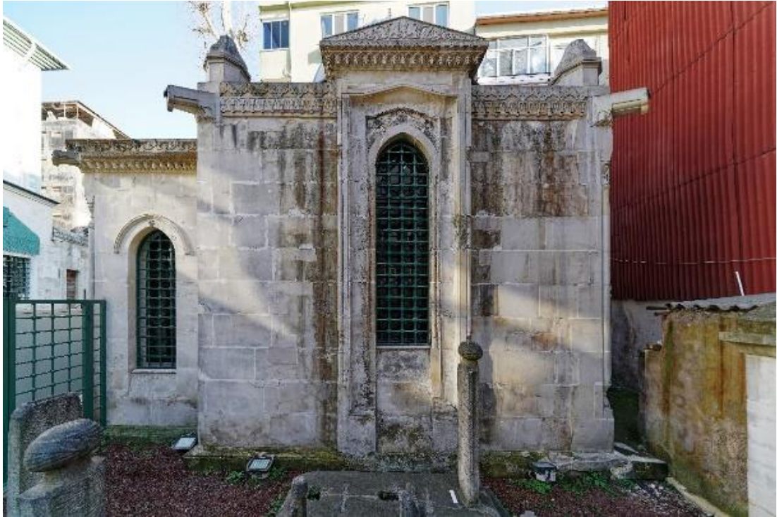
Şekil 3.108: Ahmed Cevad Paşa Türbesi Güneydoğu Cephesi (2022)
