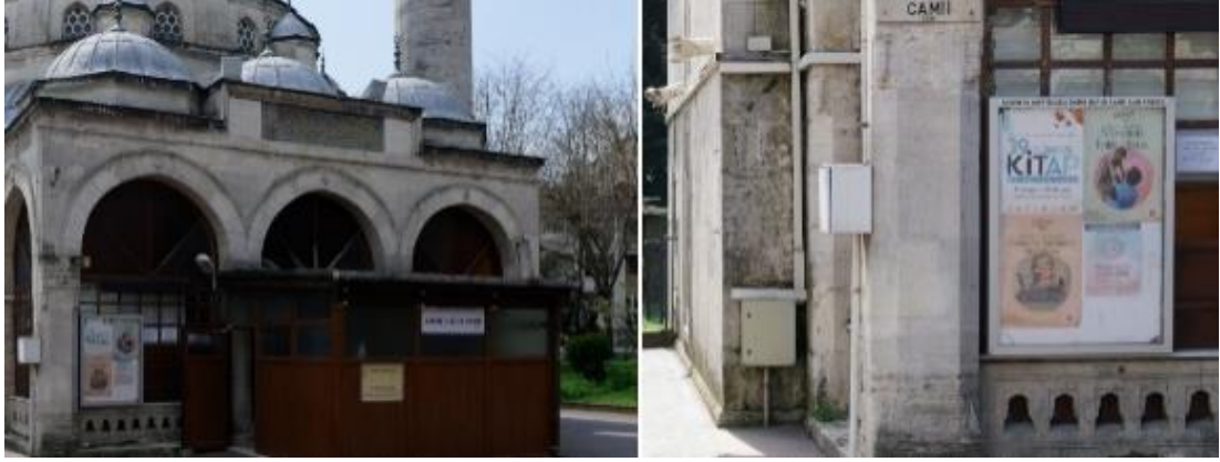
Şekil 3.52 : Amine Hatun Camii Cephedeki Niteliksiz Ekler (2022)
