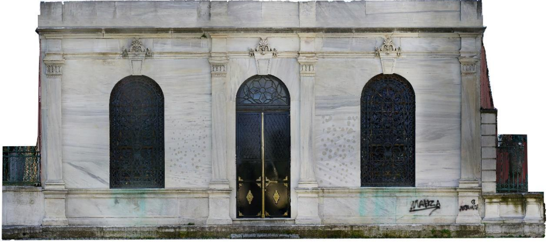
Şekil 3.122: Hasan Hüsnü Paşa Türbesi Giriş Cephesi (2022)
