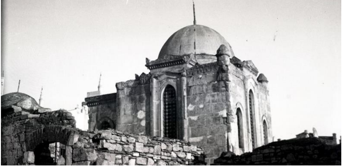
Şekil 3.104 : Ahmed Cevad Paşa Türbesi Arşiv Fotoğrafı (SALT) (Url-17)
