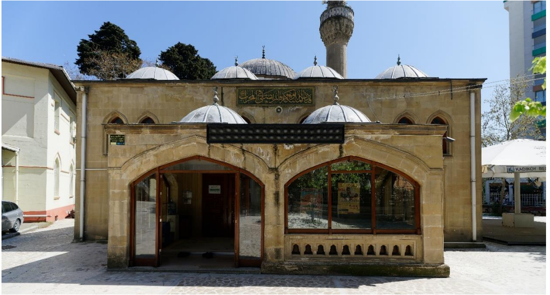
Şekil 3.29 : Bostancı Kuloğlu Cami Ek Yapı Görünümü (2022)
