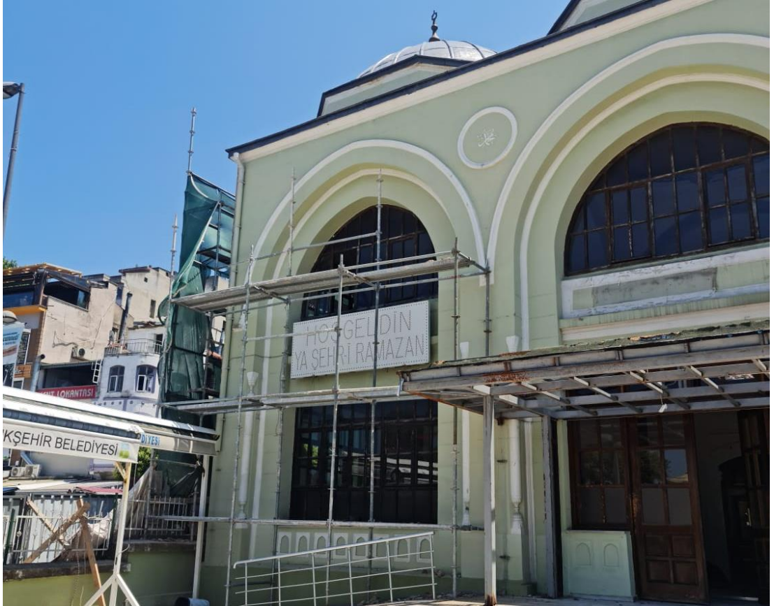
Şekil 3.89: Bandırma Haydar Çavuş Camii Giriş Cephesi (2022)
