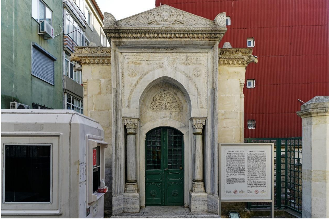
Şekil 3.107: Ahmed Cevad Paşa Türbesi Giriş Cephesi (2022)
