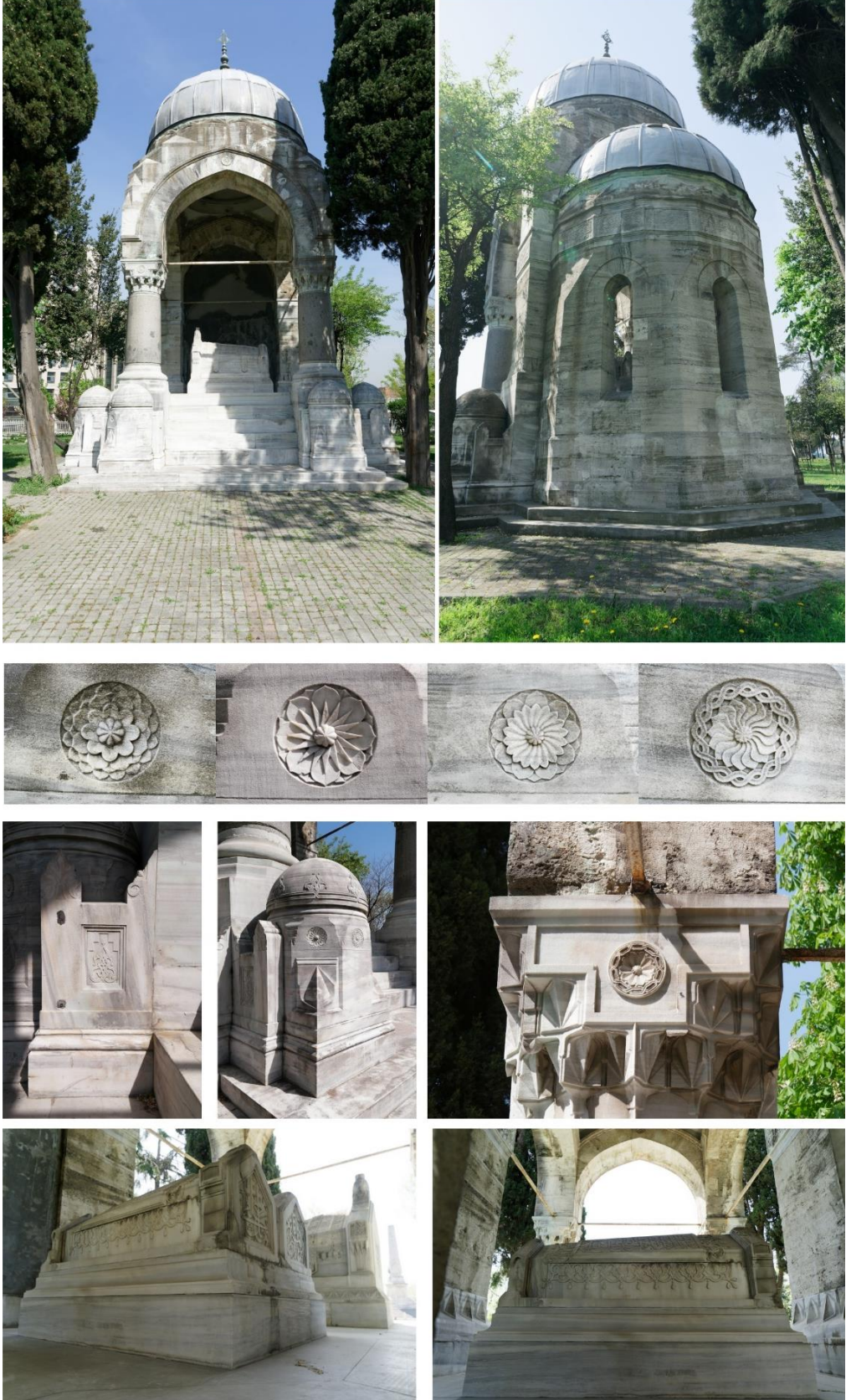
Ek A.13: Mahmut Şevket Paşa Türbesi
