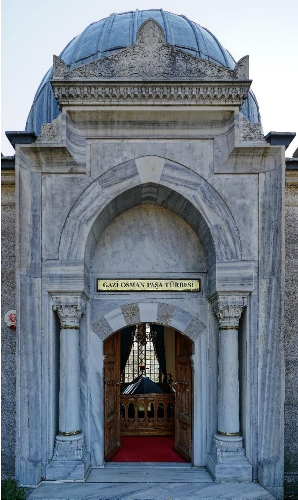
Şekil 3.132 : Gazi Osman Paşa Türbesi Giriş Cephesi (2022)
