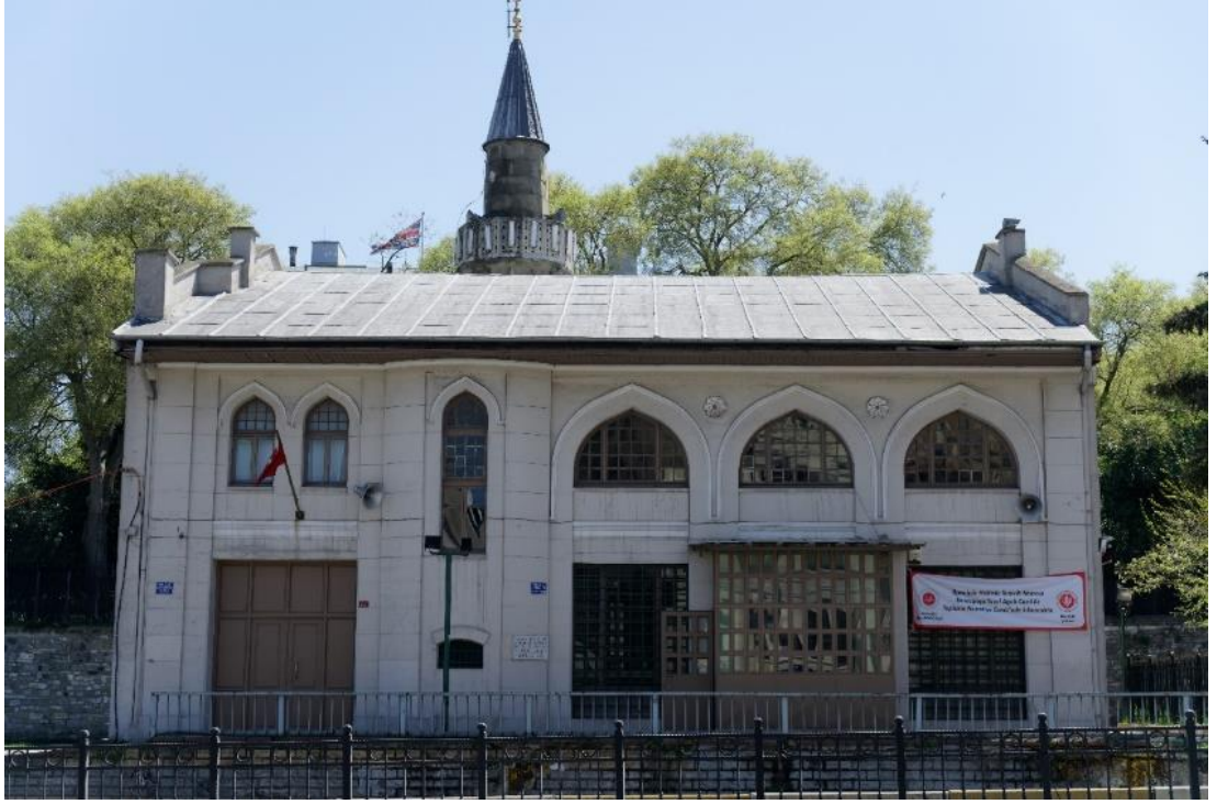
Şekil 3.63: Kamer Hatun Camii Kuzey Cephesi (2022)
