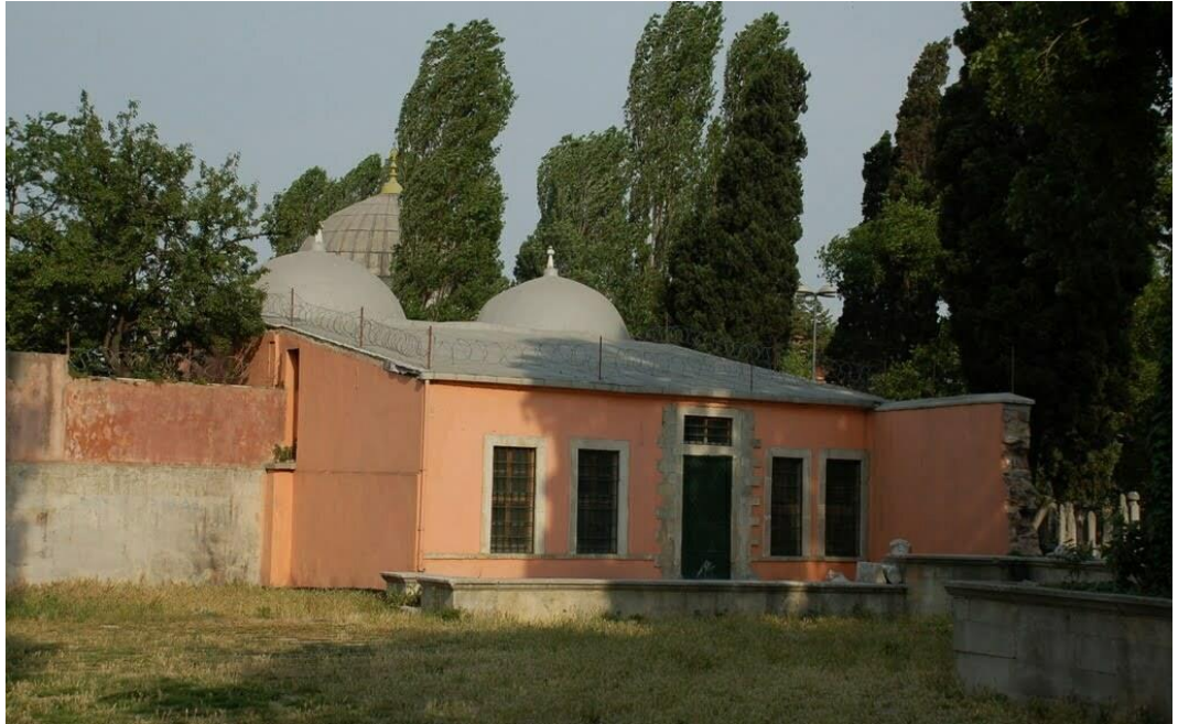
Şekil 3.123: Hasan Hüsnü Paşa Türbesi Arka Cephe Fotoğrafı (Url-21)
