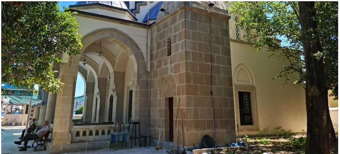
Şekil 3.43: Babek Camii Batı Cephe (2022)
