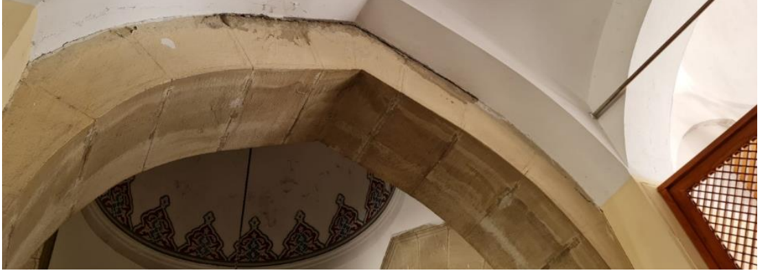
Şekil 3.28 : Bostancı Kuloğlu Cami Ek ve Özgün Yapı Birleşimleri (2022)
