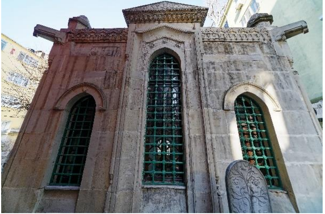
Şekil 3.109: Ahmed Cevad Paşa Türbesi Güneybatı Cephesi (2022)
