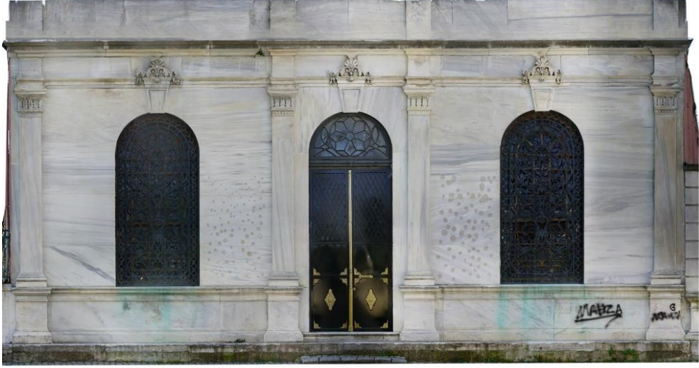
Ek A.11: Hasan Hüsnü Paşa Türbesi
