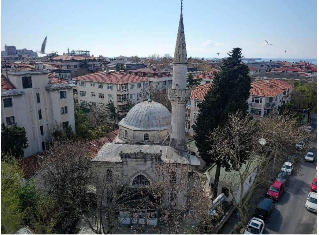
Şekil 3.3 : Yeşilköy Mecidiye Camii Cephesi (2022)
