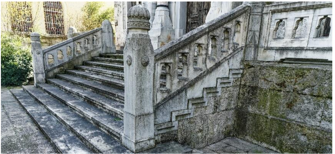
Şekil 3.113: Sultan V. Mehmed Reşad Türbesi Giriş Merdiveni (2022)
