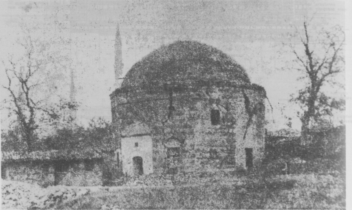
FOTO 2- TÛTÛNSÛZ BABA TÛRBESİ KUBBE KURŞUNLARI TOPLATILDIKTAN SONRA, GERGİ DEMİRLERİ PATLAMIS ŞEKLİYLE, 1953 ZELZELESİNDEN SONRAKİ HALİ (1957. H.Y. İDRİSOĞLU).
