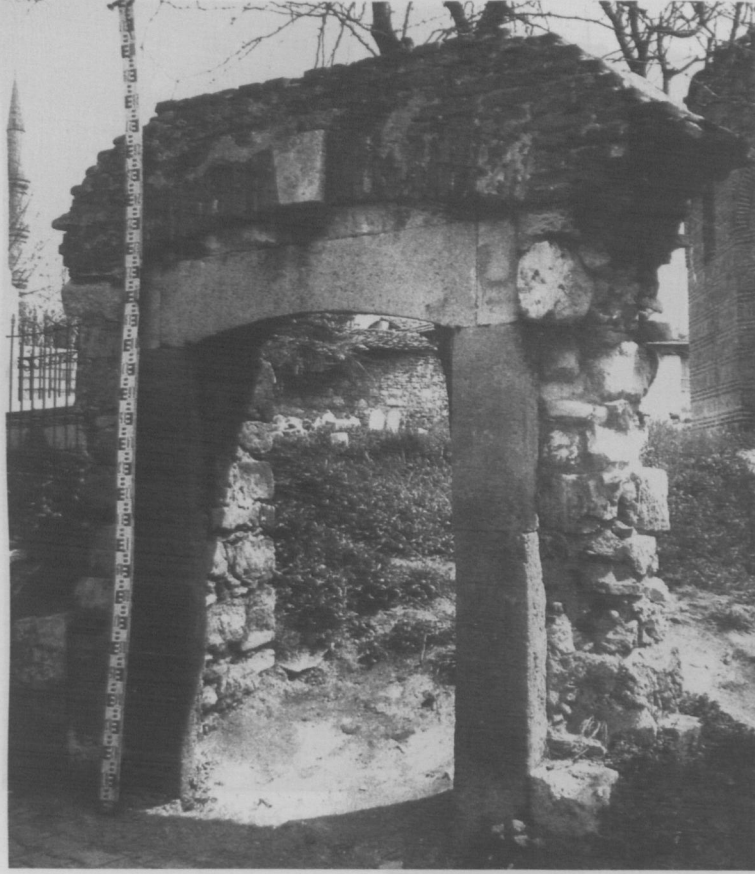
FOTO 14. TÜRBE AVLU GİRİŞİ ÖN GÖRÜNÜŞÜ (1997).
