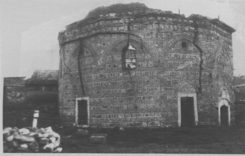
FOTO 9. KUZAY CEPHESİ (L-M-A-K) (1997).
