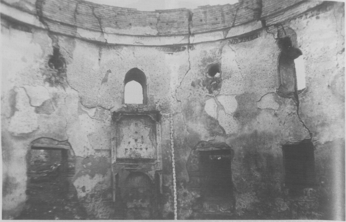
FOTO 36. MİHRAP CEPHESİ İÇ GÖRÜNÜŞÜ ( J-H-G-F-E ) ( 1997 ).
