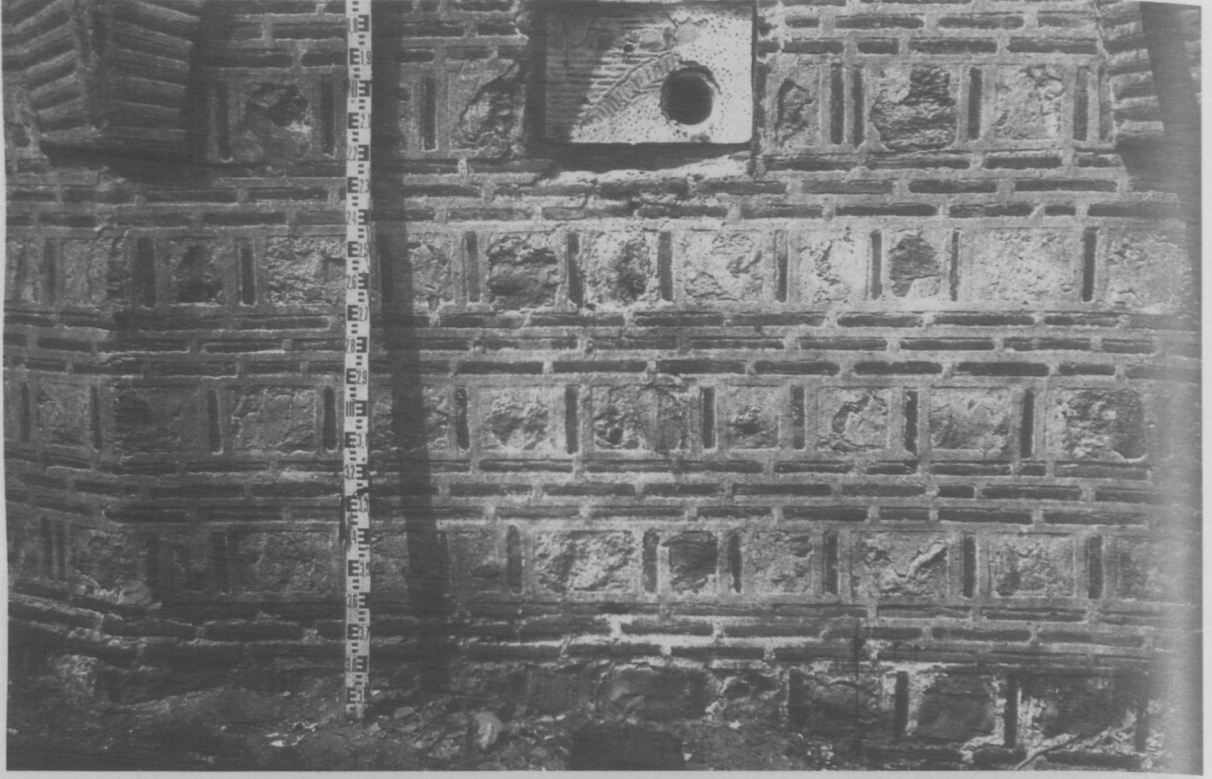
FOTO 18. DUVAR ÖRGÜ TEKNİĞİ / GÜNEY CEPHESİ (1977).
