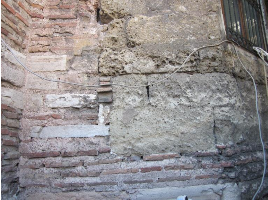
Şekil 2.12: Doğu cephesinde kullanılan od taşı bloklar
