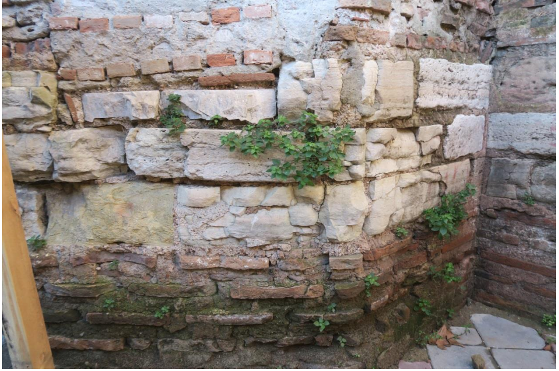
Şekil 2.9: Güney cepheye yakın köşedeki duvar örgüsü
