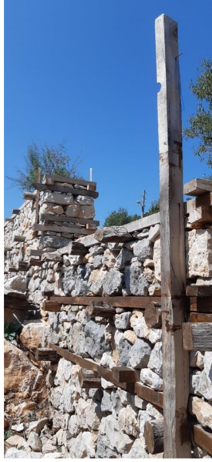
Şekil 3.95 Özgün duvar yapım tekniği örneği (2019)
