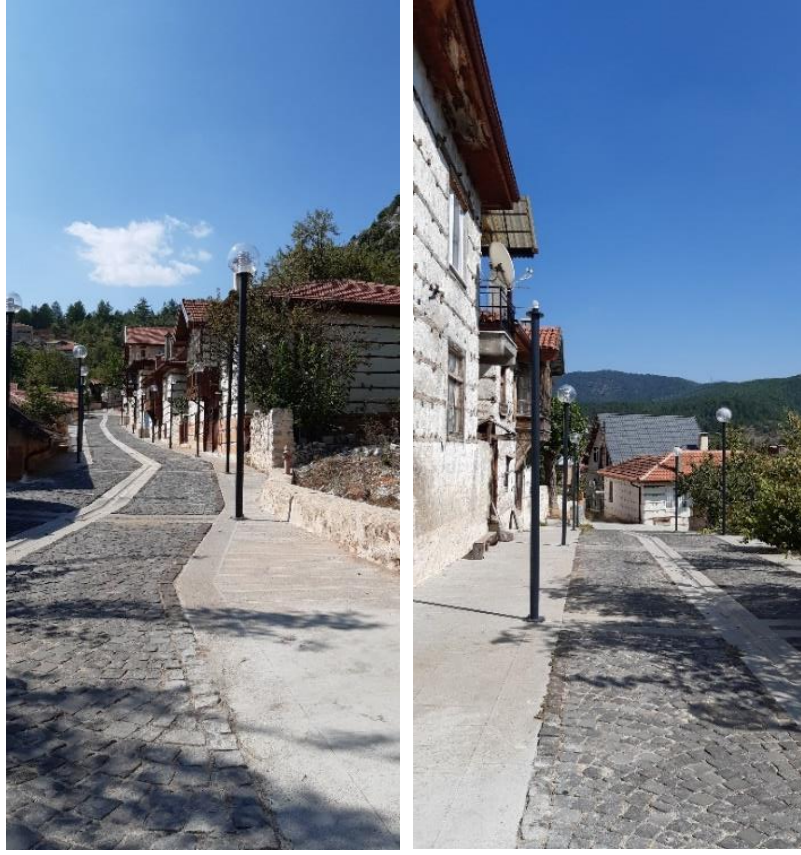
Şekil 3.68 Cevizli’de korumaya alınan sokak görüntüsü (2019)
