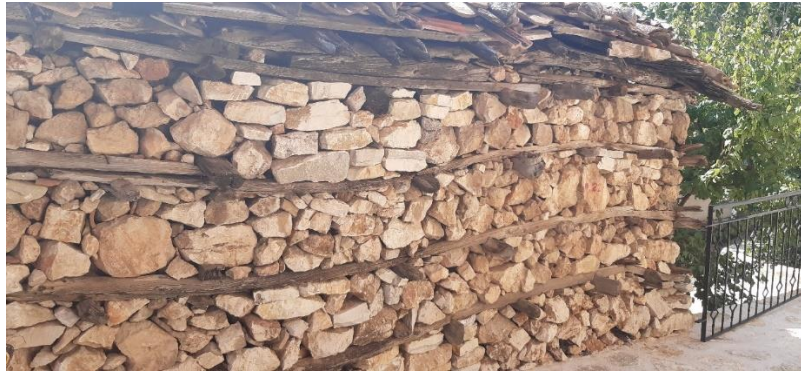
Şekil 3.24 Müdahale edilmemiş ve terkedilmiş yapının durumu (2019)
