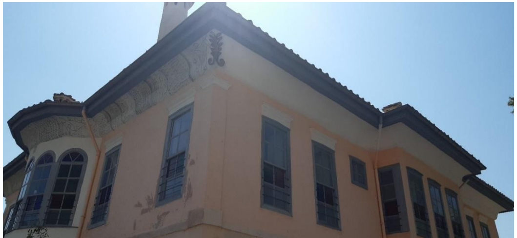
Şekil 3.32 Tescilli yapının günümüz durumu (2019)
