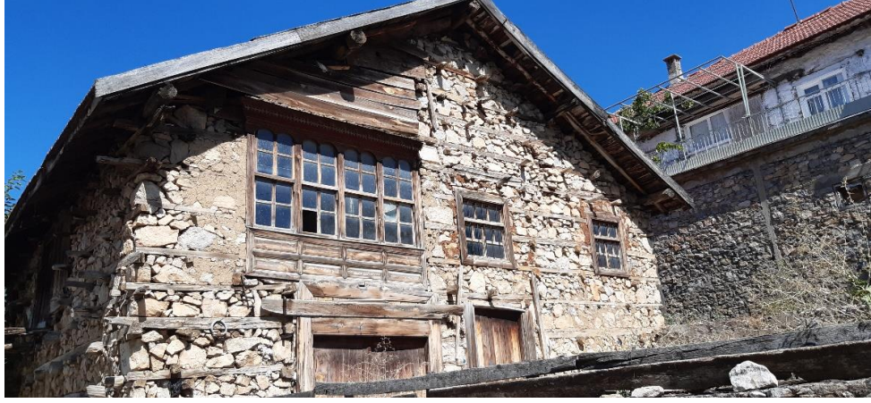
Şekil 3.16 Dış duvar örneği (2019)
