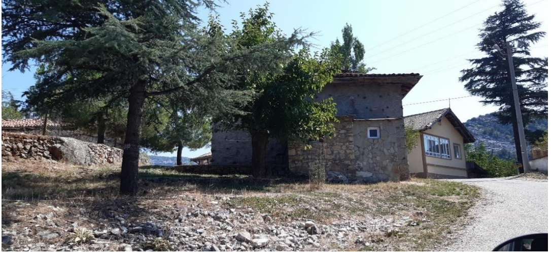
Şekil 3.47 Belenalan Mahallesinde yeni yapılan betonarme yapı (2019)
