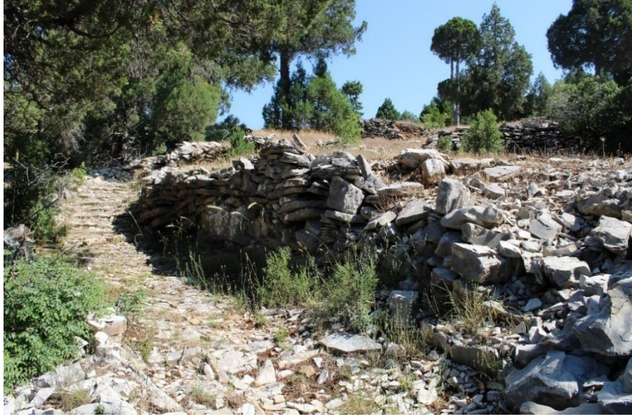
Şekil 3.97 Yol kenarlarındaki duvarların son hali (Akseki Belediyesi)
