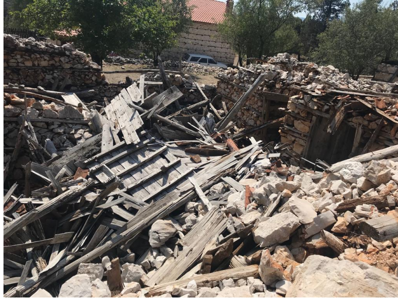
Şekil 3.94 Yıkılmış ve malzemeleri tekrar kullanılacak Düğmeli Ev örneği (2019)
