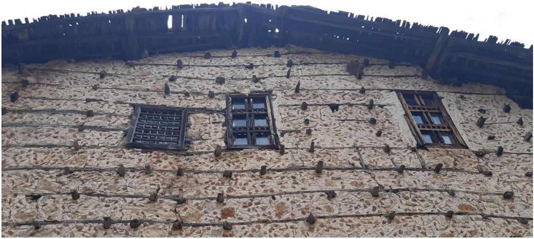
Şekil 3.1 Cephede düğmelerin(hatılların) görüldüğü Düğmeli Ev örneği (2020)
