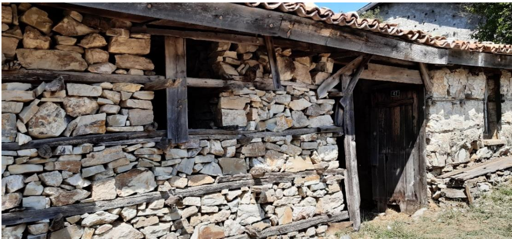
Şekil 3.10 Kuru duvar tekniği (2019)
