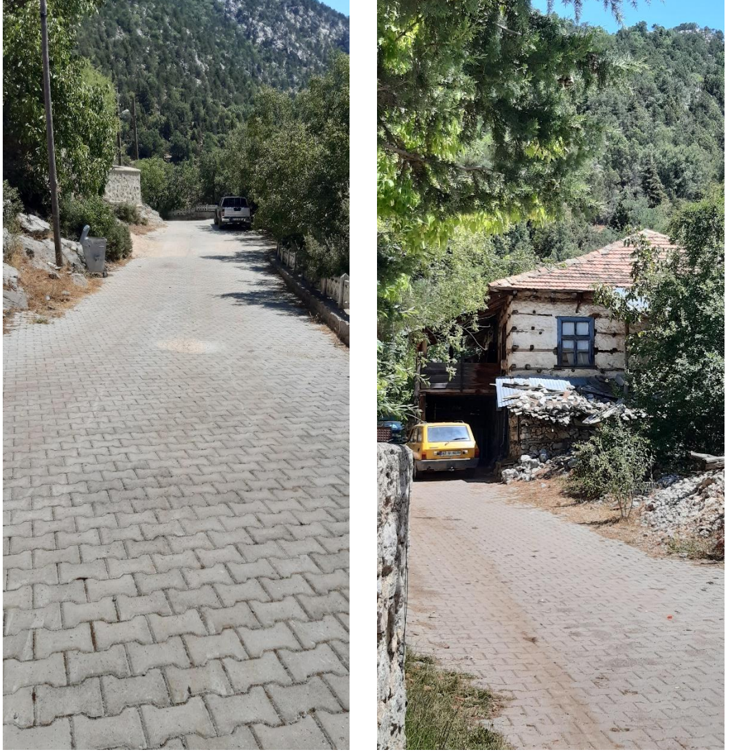
Şekil 3.86 Yeni yapılan köy yolları (2020)
