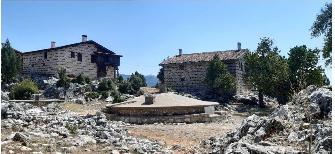
Şekil 3.96 Mahallenin genel durumu ve yeni yapılan Düğmeli Evler (2019)
