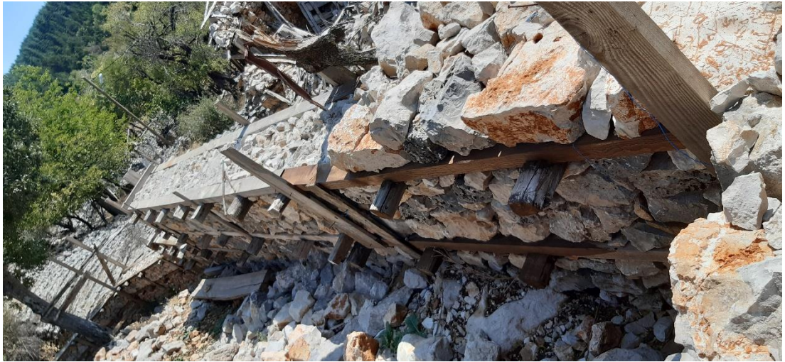
Şekil 3.5 Kuru duvar örme tekniđi uygulaması (2019)
