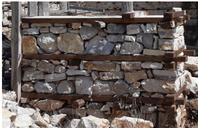
Şekil 3.14 Uygulanan hatıl birleşim detayı (2019)
