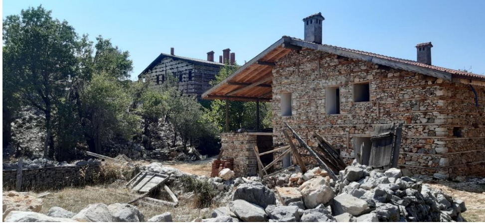
Şekil 3.91 Yapımı devam eden Düğmeli Ev örneği (2019)
