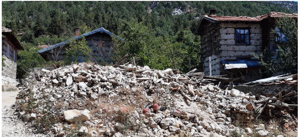
Şekil 3.71 Yıkılmış ve kullanılmayan harap durumdaki Düęmeli Evler (2020)
