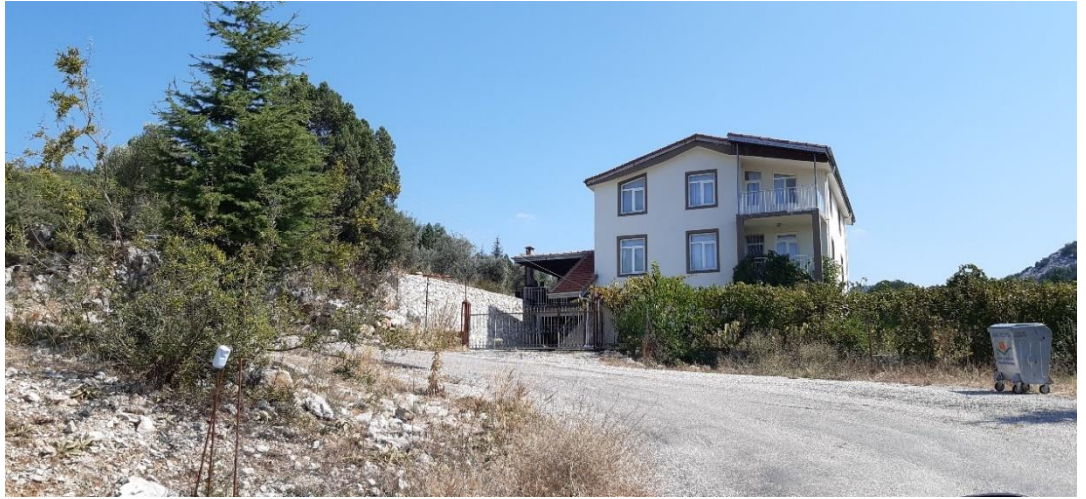
Şekil 3.48 Belenalan Mahallesinde yeni yapılan betonarme yapı (2019)
