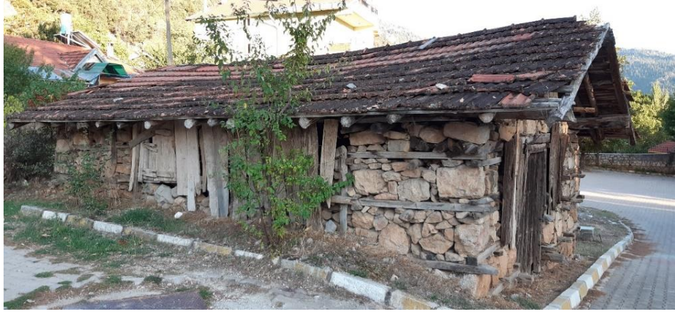
Şekil 3.79 Tescilsiz yapının günümüz durumu (2019)
