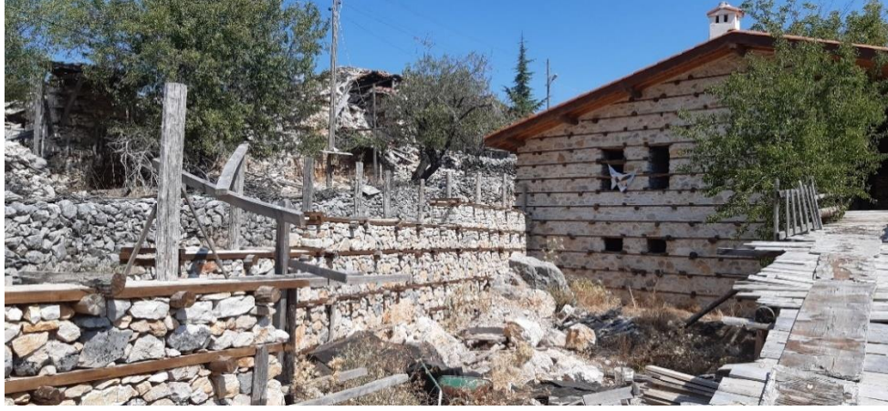
Şekil 3.90 Bahçe duvarı inşası devam eden Düğmeli Ev örneği (2019)
