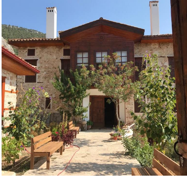
Şekil 3.23 Akseki’de korumaya alınan yapı ve bahçesi (2019)
