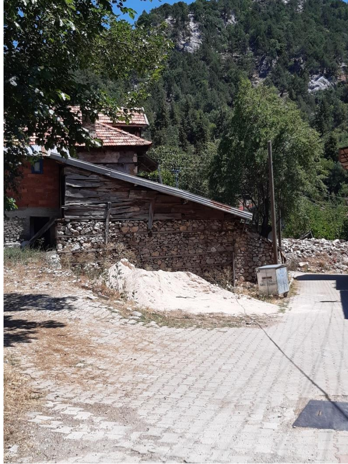
Şekil 3.85 Kullanılmayan yapının yıkılarak yok edilmiş son hali (2020)
