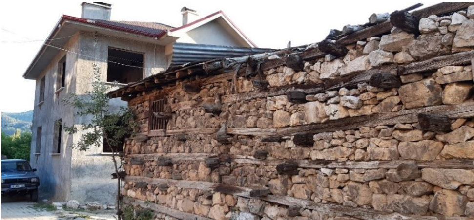
Şekil 3.77 Düğmeli evlerin yerine tercih edilen çok katlı betonarme yapı örneği (2019)
