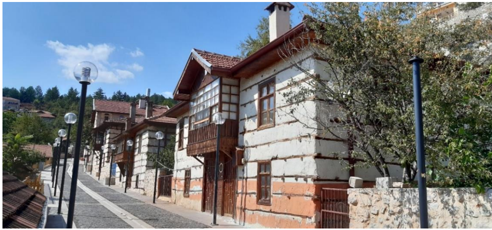
Şekil 3.67 Cevizli’de korumaya alınan sokak görüntüsü (2019)
