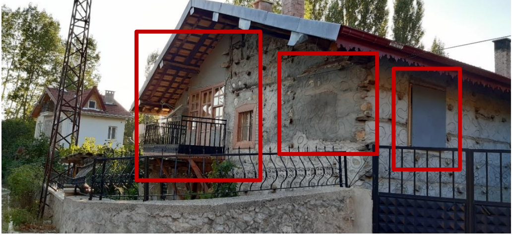
Şekil 3.76 Tescilsiz yapıya yapılan müdahaleler ve günümüz durumu (2019)
