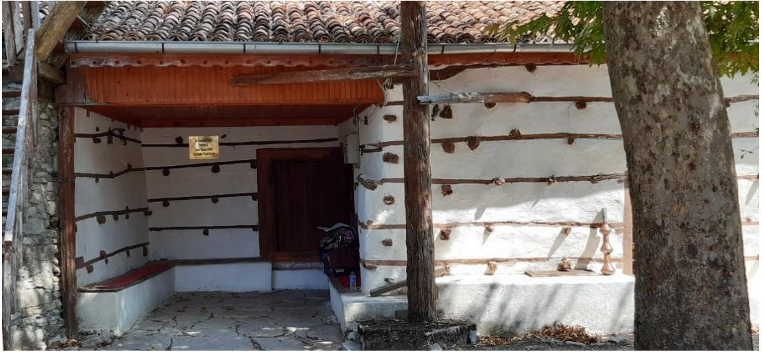
Şekil 3.44 Belenalan Mahallesi tescilli yapı örneği (Geleneksel Köy Camii, 2019)
