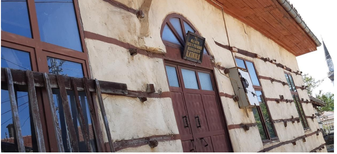
Şekil 3.43 Belenalan Mahallesi tescilli yapı örneği (İlkokul Binası, 2019)
