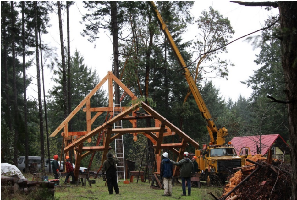
Şekil 4.18: Bileşenlerin yerde birleştirilip ayağa kaldırılması.
