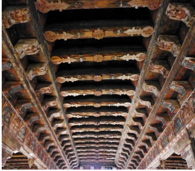
Őekil 5.2: Mahmutbey Camii'nde bulunan merkezi iřaretler (url-6).
