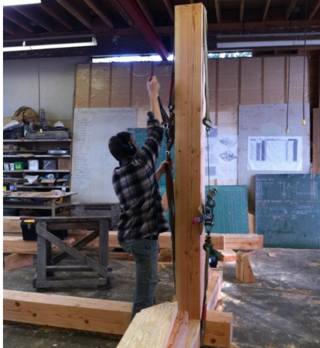
řekil 3.12: Palanga ile bileřenlerin sıkıřtırılması.
