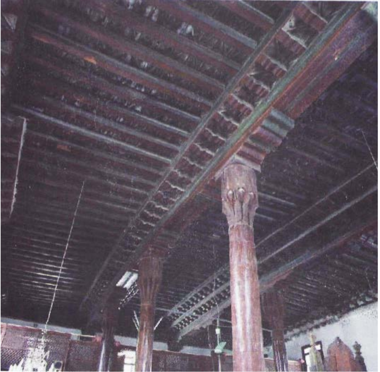
Şekil 5.12: Ayaş Câmii ahşap taşıyıcı elemanları (Karaçağ, 2010, s.119).
