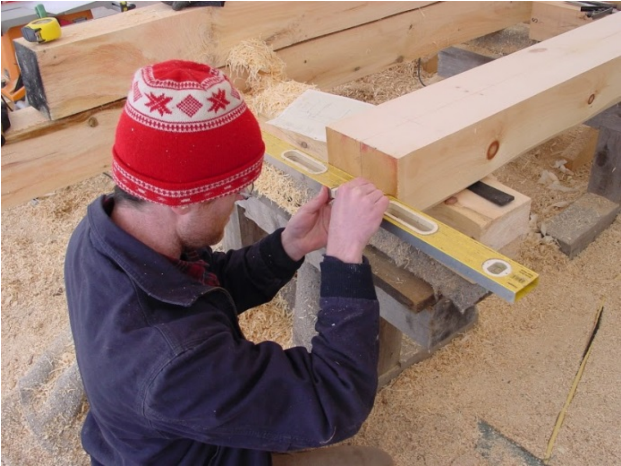
Şekil 4.4: Referans çizgilerinin çizilmesi (url-2).
