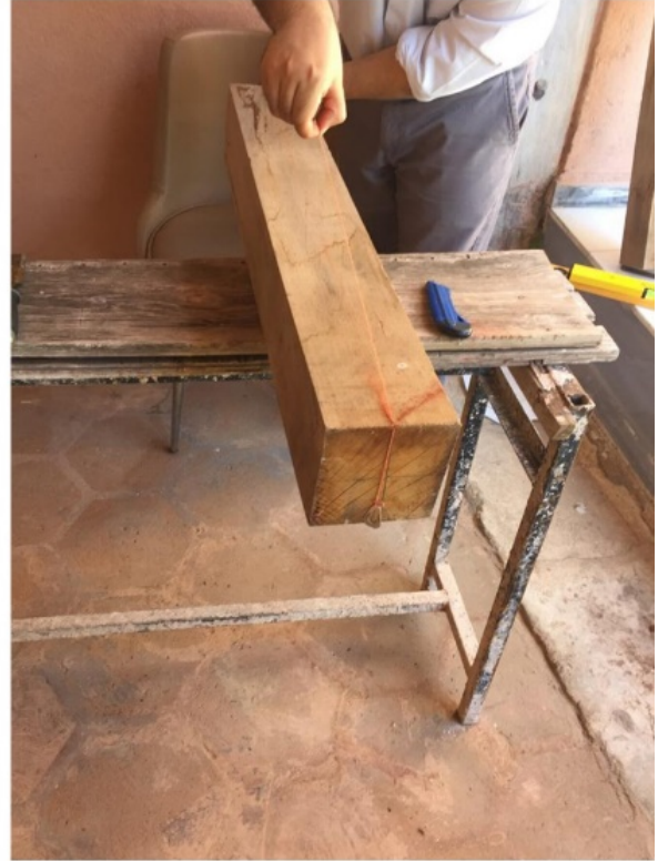
4) Merkez hatı'nın tesisi
