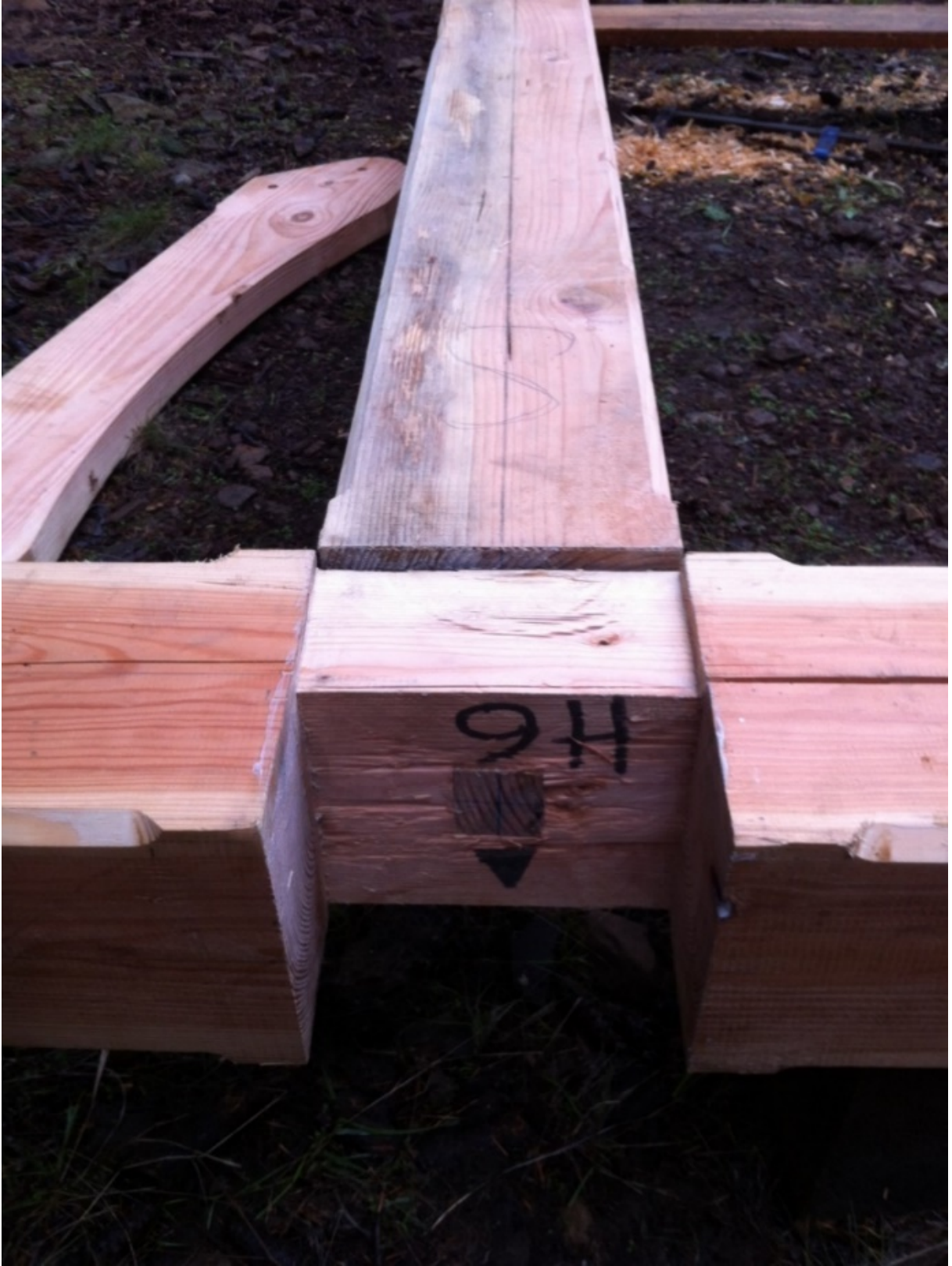
Şekil 2.19: Bir düğüm noktasındaki erkek ve dişi kertik zıvanalar.
