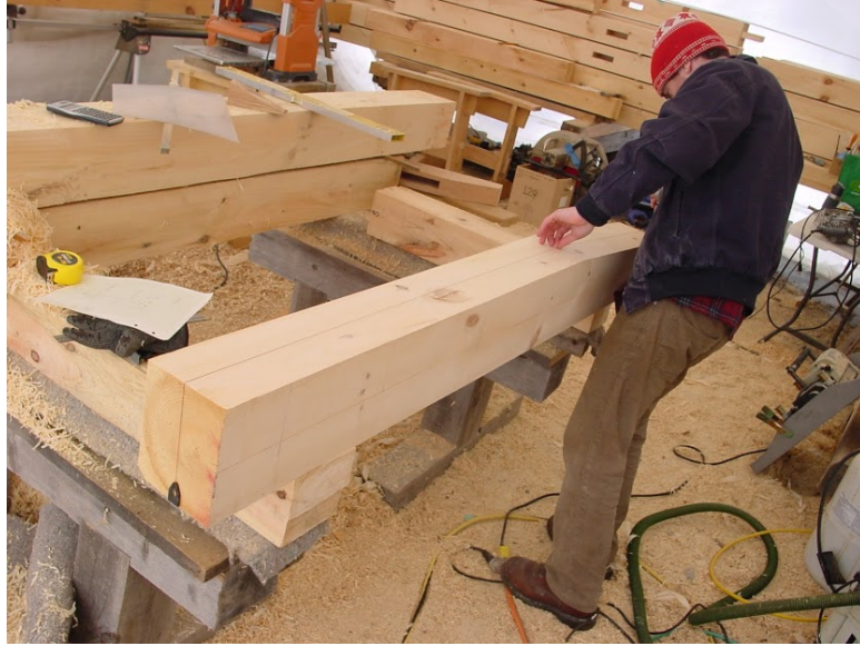
Şekil 4.6: Merkez hattının tesisi (url2).
