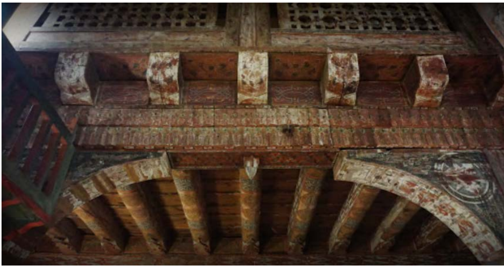
Şekil 5.21: Mahmutbey Câmii ahşap birleşimler (url-13).
