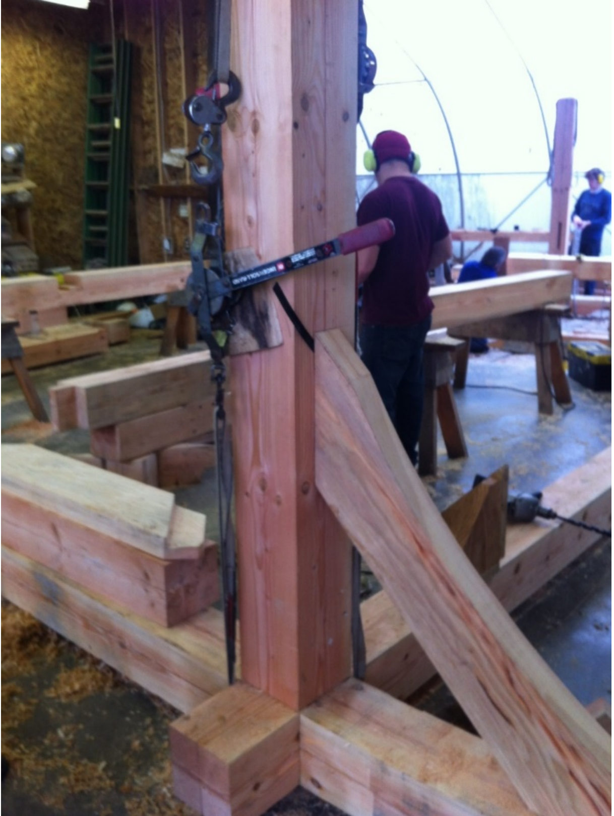
Şekil 4.12: Palanga ile ön birleşim yapılması.
