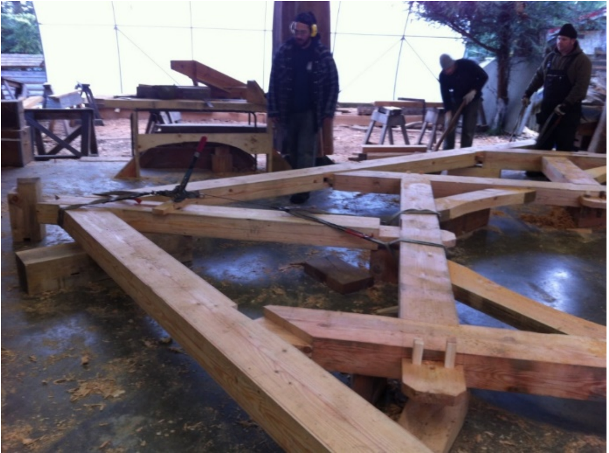
Şekil 4.14: Tek seferde ayağa kaldırılan duvarın ön birleşimi.
