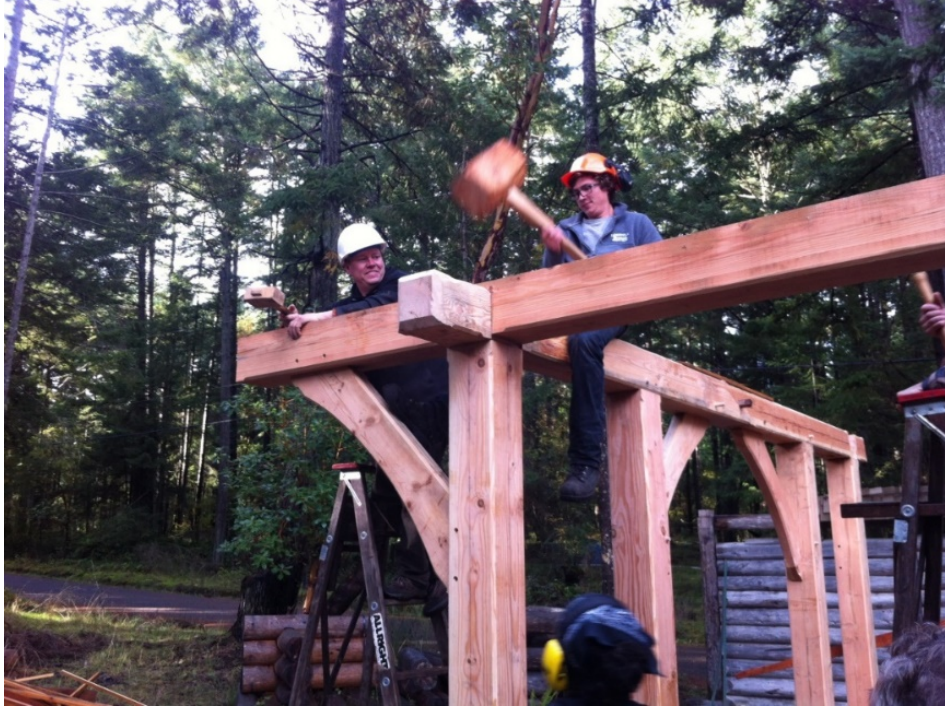
Şekil 4.17: Bileşenlerin ahşap balyoz ile birleştirilmesi.
