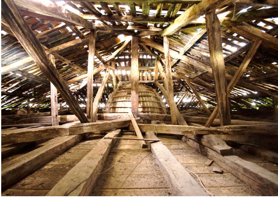
Şekil 5.14: Ghorcomi camii çatı taşıyıcı sistemi (url-10).
