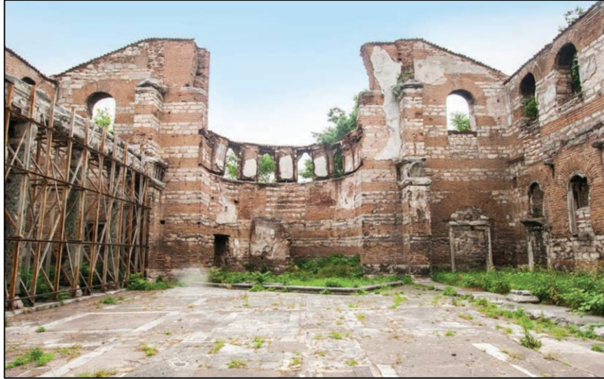
Şekil 3.5.3.1.2: İmrahor İlyas Bey Camii-Studios Bazilikası, naostan genel görünüm (Kudde ve Ahunbay 2016)
