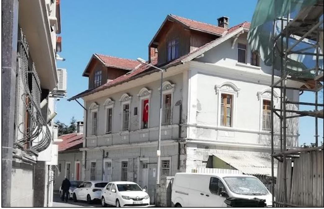
Şekil 3.5.2.2.1: TCDD lojman binası (2021)
