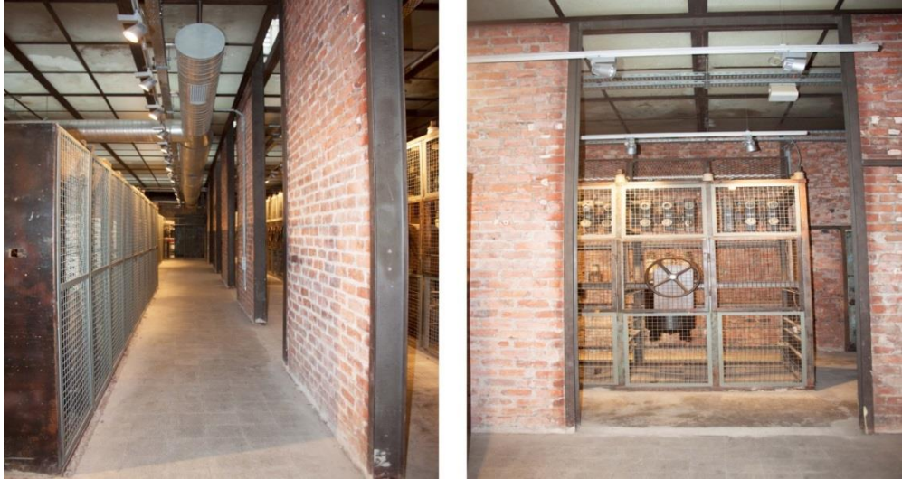
Resim 3.13: Yapının özgün haline yakın korunmaya çalışılan tavan ve çatı örtüsü (Kaynak: Zeynep Canan Karagöz).
