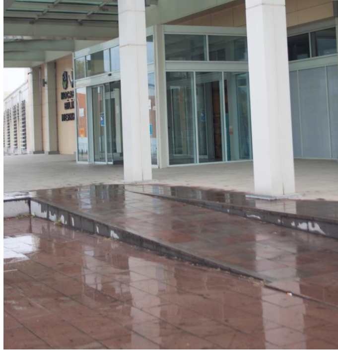
Resim 3.27: Yapı giriş rampası (Kaynak: Zeynep Canan Karagöz).
