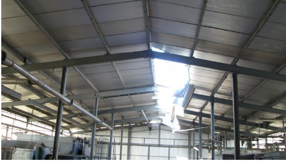
Resim 3.8: Hamur ünitesi 2. Kat çatı örtüsü ve kiriş sistemi (Kaynak: Kartal, 2009: s.76).
