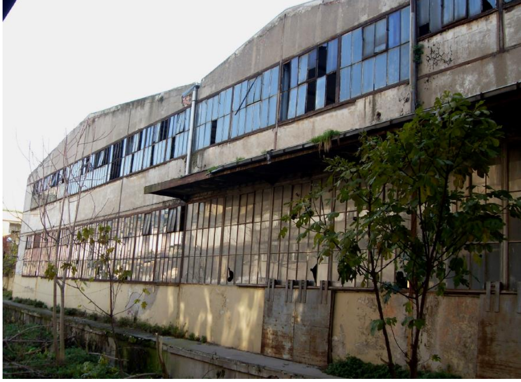
Resim 3.7: I. Kağıt fabrikası özgün pencere tipleri (Kaynak: Kartal, 2009: s. 63).
