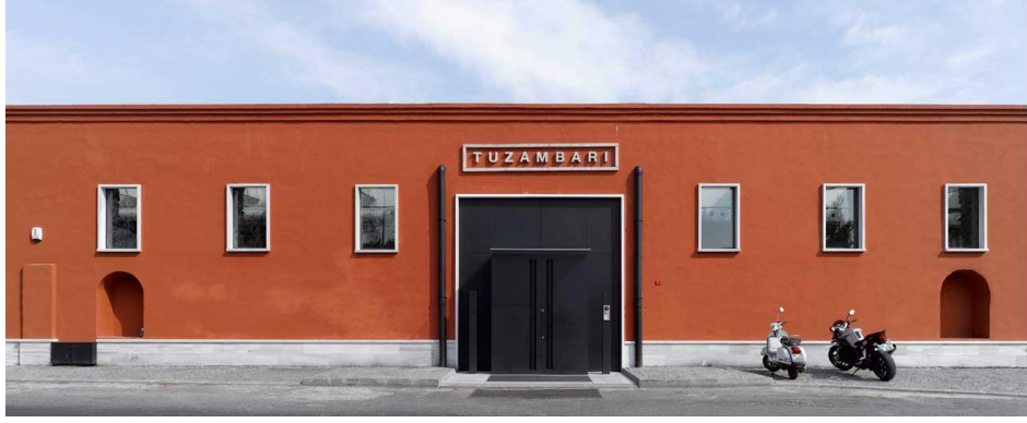
Resim 2.6: Yeniden İşlevlendirilmiş Kasımpaşa Tuz Ambarı Cephe görünümü (URL-67).
