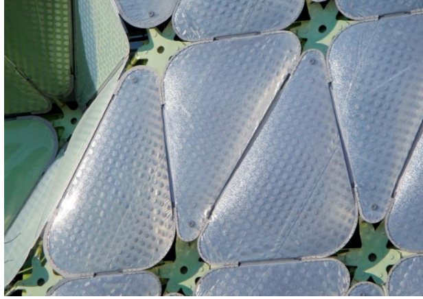
Şekil 5.14.2. Media-TIC Cephe Malzemesi, ETFE Katmanları (url 17)
