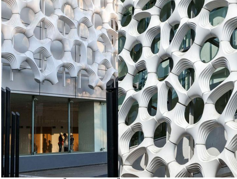
Şekil 3.6.6. Fotokatalitik Özellikte Cephe Örneği, Manuel Gea Gonzalez Hastanesi, Mexico City (url 43)
