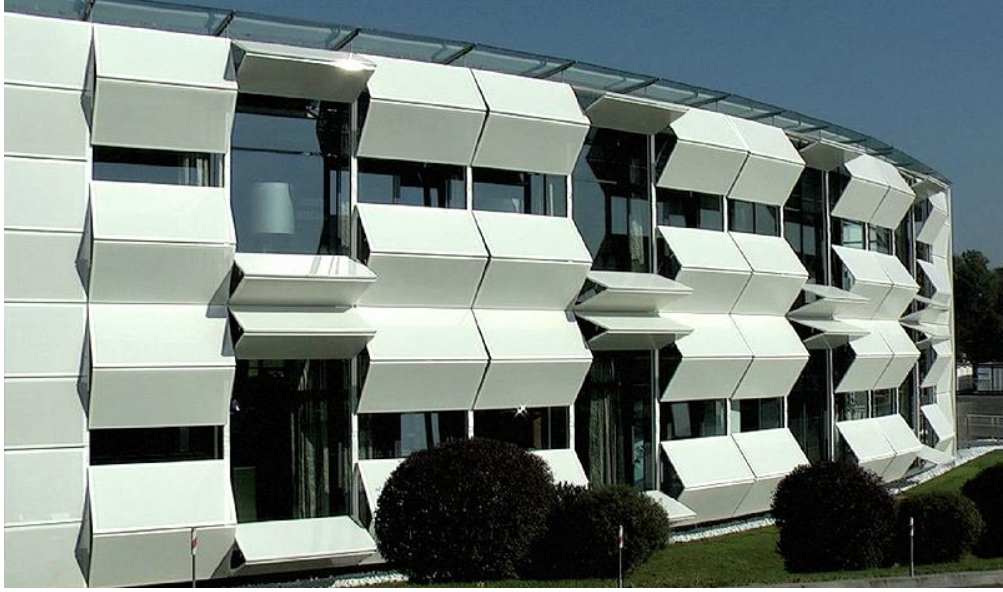
Şekil 5.8.1. Kiefer Teknik Showroom Cephe Görüntüsü (url 55)
