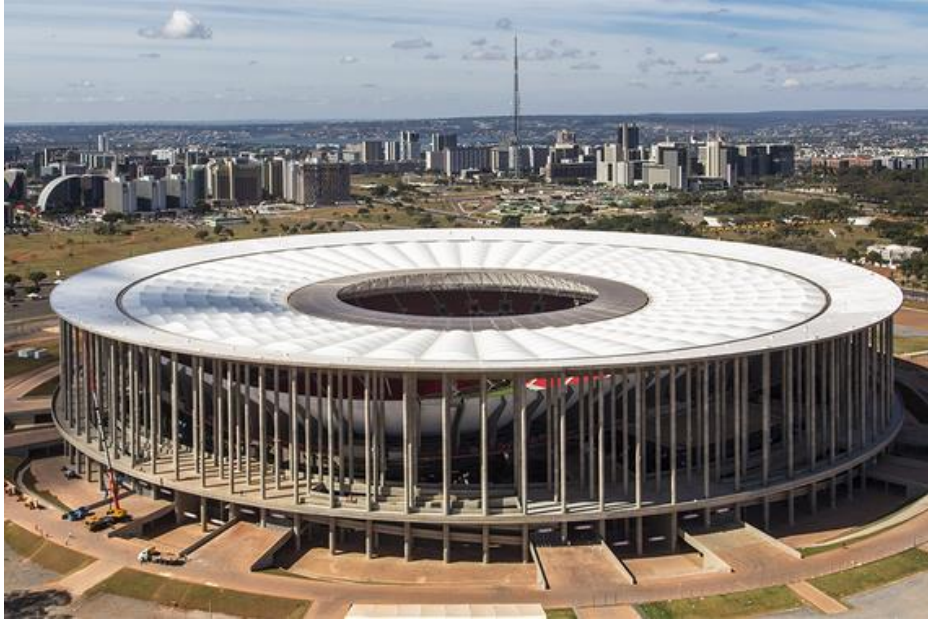
Şekil 3.6.2. Brezilya Stadyumu Fotokatalitik Membran Uygulaması (url 41)
