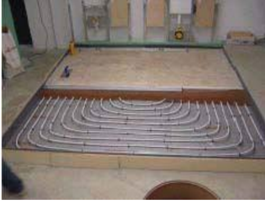
Şekil 3.2.1.3. Rubitherm 'in Zeminde Faz Değişiren Malzeme Uygulaması (url 18)
