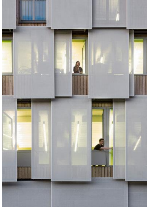
Şekil 3.6.7. Cephede Kirlilik Önleyici Tekstil Malzemesi Kullanımı (url 44)
