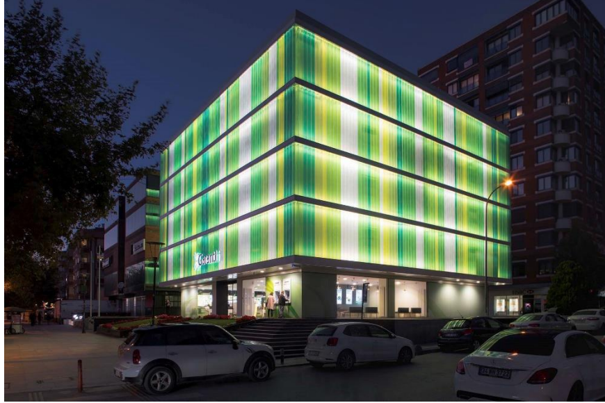
Şekil 4.62. Garanti BBVA Suadiye Şubesi Cephe Görünüşü (URL-105).
