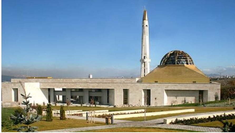
Şekil 3.17. Bilkent Üniversitesi Doğramacızade Ali Paşa Cami (URL-49).
