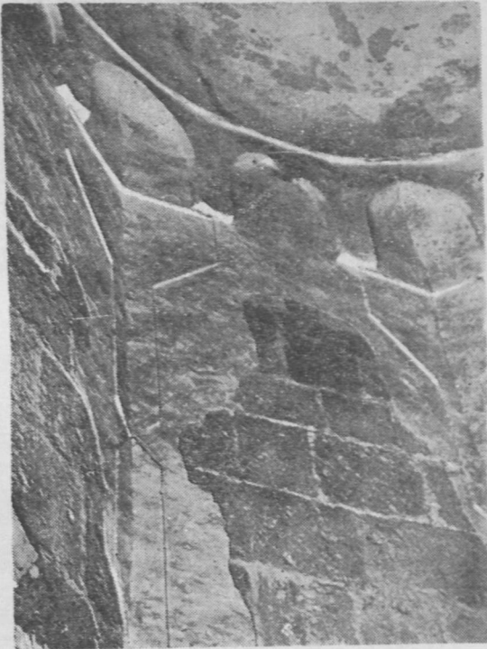
Bekâr Sultan Kümbeti iç sıvaları ve kubbeye geçiş bölümü
