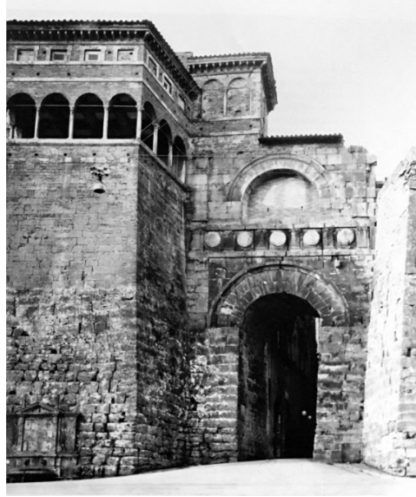
Resim 2.5 : Augustus Kemer, Perugia, M.Ö.310. Geçidin Etrüskler tarafından yapılan alt kısmında, kapı üzerinde yarım çember kemer görülmektedir[Fazio, Moffett, Wodehouse s:107].
