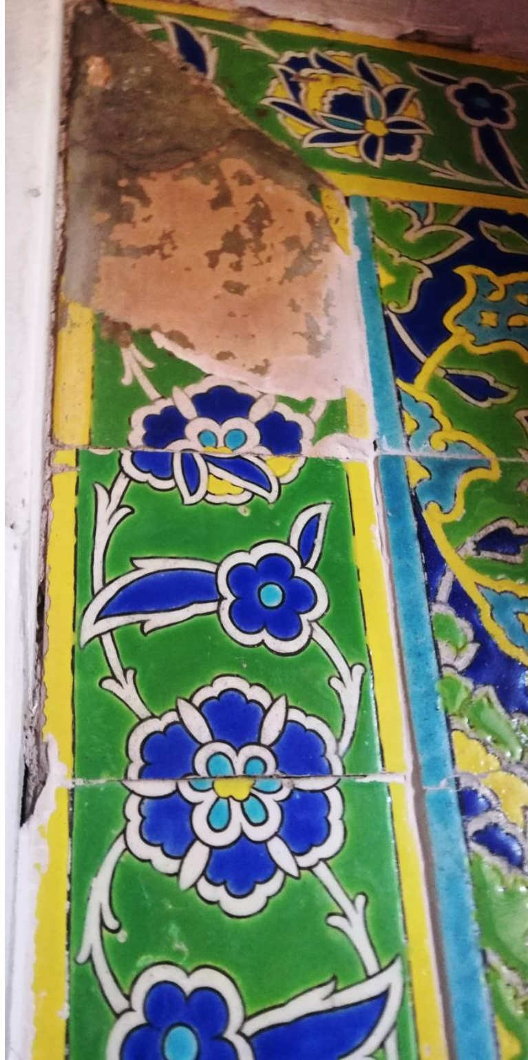
Resim 65: Sađ panoda ki Bordür çinilerinde kompozisyon akışından farklı başka bir bordürün restorasyon uygulaması
