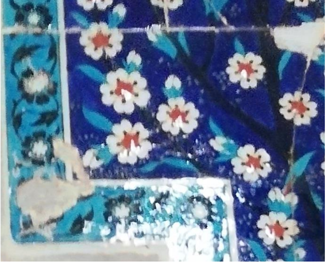
Resim 73: Türbe girişinden itibaren sağdan sola ikinci kenarda ki niş köşe pano büdüründe mevcut tahribat
