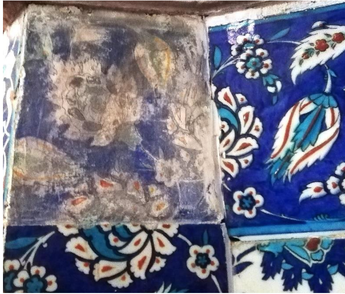
Resim 46: Alçı üzerine renk ve desen açısından yanlış köşe dönüşü uygulamasına örnek
