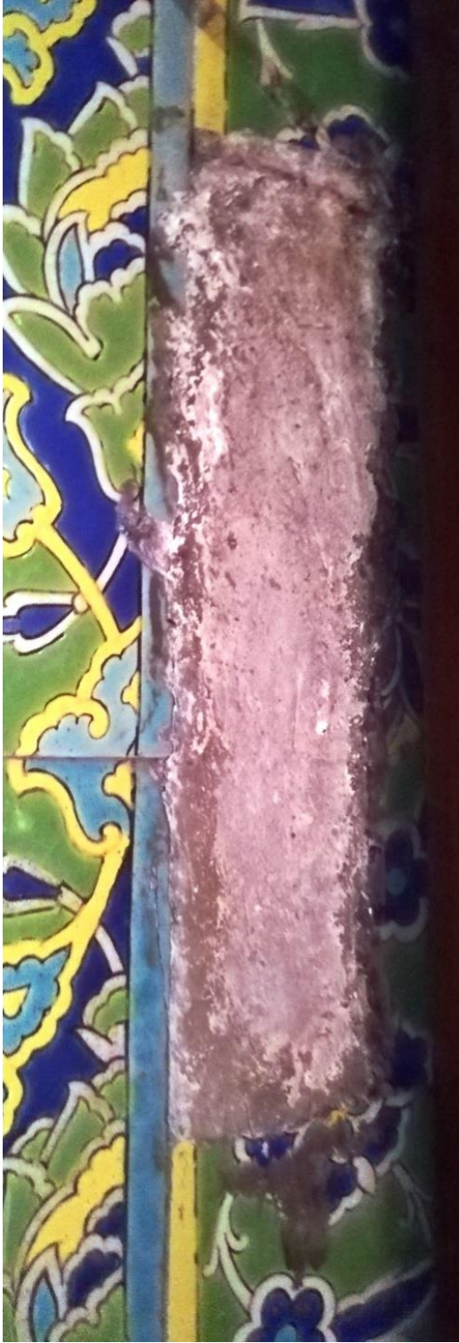
Resim 64: Sağ panoda yer alan yüzey kayıpları
