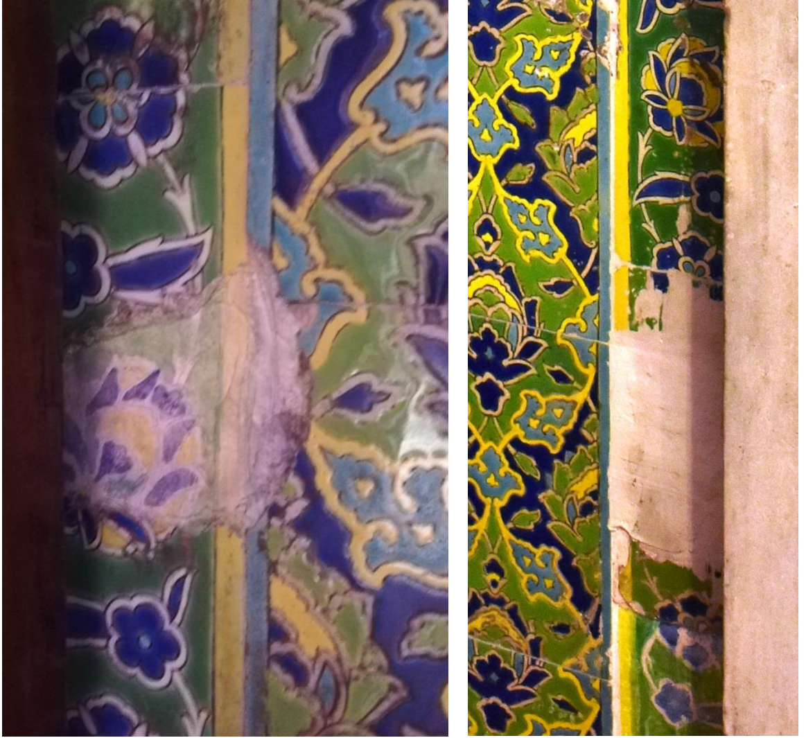
Resim 66: Sol kapı arkası panosunun aşağıdan yukarı üçüncü bordürünün yerinde olmayan kısmının görüntüsü
