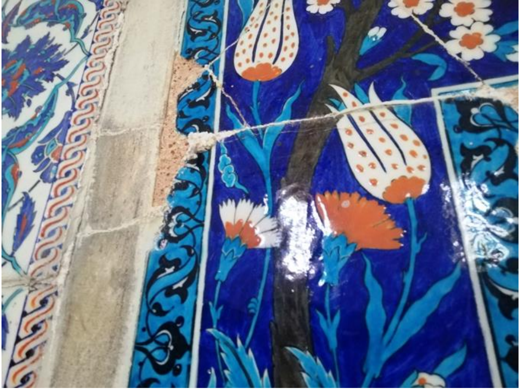
Resim 76: Girişin sağından itibaren ondördüncü kenarda yer alan panoyu çevreleyen rumeli bordürde ki parça kayıplarından (detay 1)
