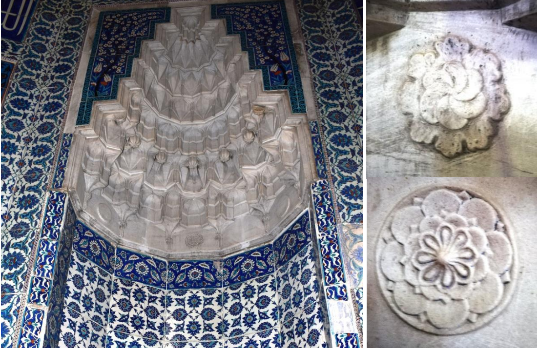
Resim 3: Haseki Hürrem Sultan Türbesi, mukarnasın altında yer alan farklı rozetler
