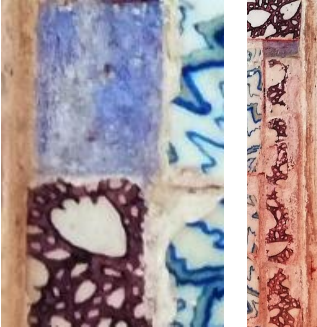
Resim 37: Sağ pano üst kenar bordürde yer alan küçük parça kayıpları
