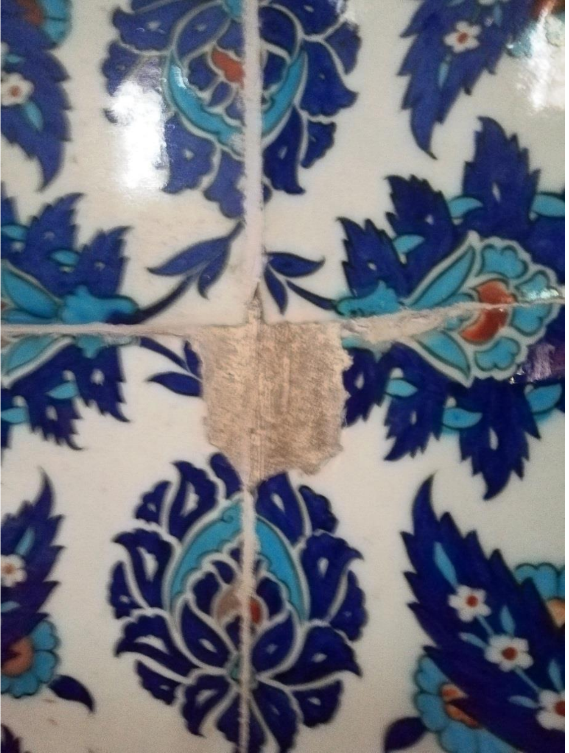
Resim 81: Hasara uramış karolar ve bu karoların birleşimlerinde oluşan tahribatlar
