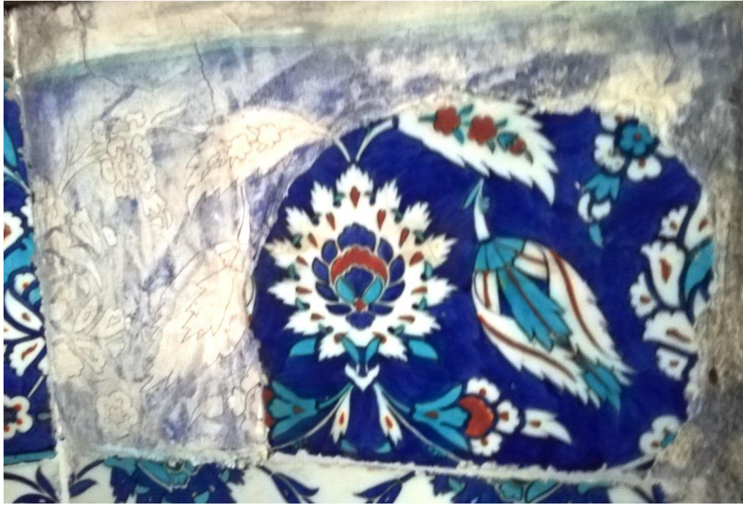
Resim 44: Onarım sırasında alçı ile doldurulan zemin de hatalı desen ve renk uygulaması
