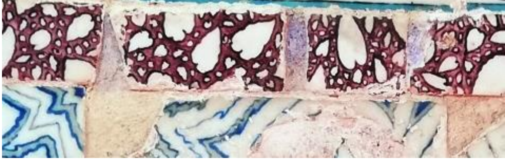
Resim 37: Sağ pano üst kenar bordürde yer alan küçük parça kayıpları
