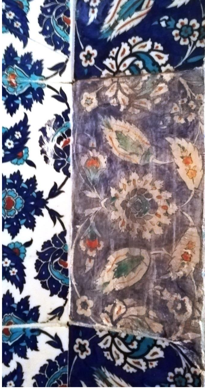
Resim 45: Renk ve desen açısından hatalı restorasyon uygulaması
