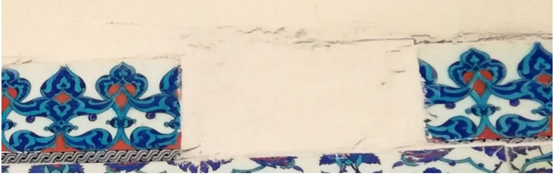
Resim 60: Türbenin tüm çinilerini çevreleyen bu bitiş bordürlerinden sadece ikinci kenarda ki mevcut parça kaybı
