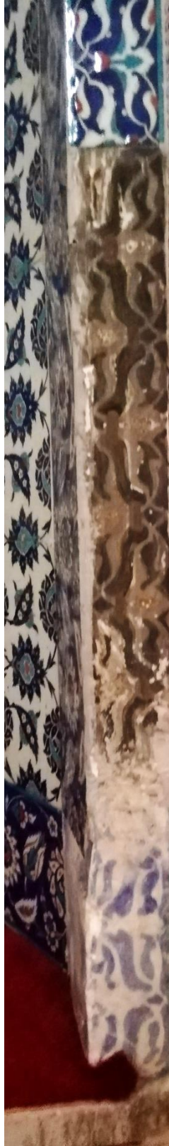
Resim 50: Dördüncü kenarda ki oldukça başarısız restorasyon uygulamasına bir başka örnek
