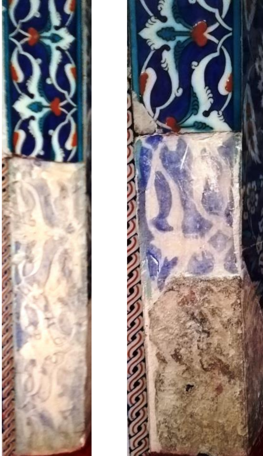
Resim 51: Diğer kenarlarda ki parça kayıpları ve alçı ile tamamlamalara örnekler
