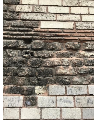
Fotoğraf 72: Tahtakale Hamamı Kantarcılar C. Ilıklık Ve Sıcaklık Duvarı Bütünlemesi (Ş.Y.2020)
