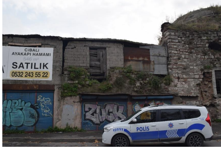
Fotoğraf 167: Ayakapı Hamamı Kuzey Cephesi Ilıklık Ve Sıcaklık Duvarlarının Briket ile İç İçe Girişi (Ş.Y.2020)
