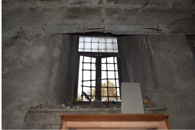
Fotoğraf 159: Ayakapı Hamamı Kuzey Cephesi Betonarme Döşemenin Kestiği Soyunmalık Penceresi (Ş.Y.2020)
