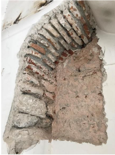
Fotoğraf 219: Yeşil Direkli Hamam Kadınlar Sıcaklığı Sıva Raspası (Güneydoğu Halvet Nişi) (Ş.Y.2020)
