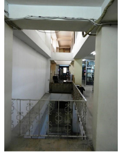
Fotoğraf 106: Hoca Paşa Hamam'ı Çağdaş Ek Bina İle Hamam Arasında Olan Galeri Boşlukları (Deniz A.2015)
