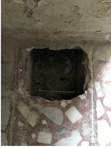
Fotoğraf 201: Yeşil Direkli Hamam Erkekler Ilıklığı Tıraşlık Döşemesi (Ş.Y.2020) Fotoğraf 202: Yeşil Direkli Hamam Erkekler Ilıklığı Cehennemliği (Ş.Y.2020)
