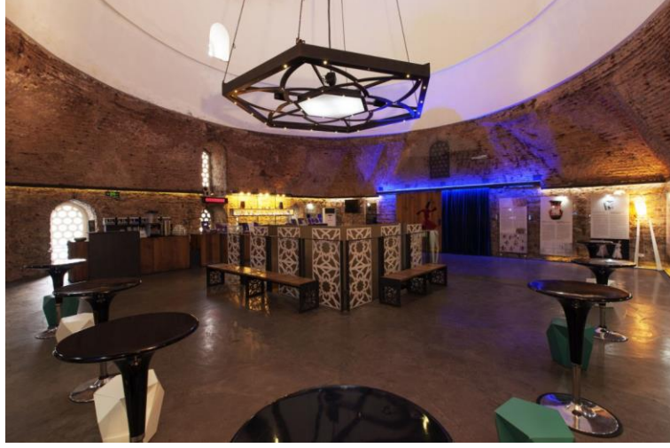
Fotoğraf 101: Hoca Paşa Hamam'ı Kadınlar Soyunmalık Cafe-Sergi Alanı ve Sergi Aydınlatması İçin Duvarlarda Oluşturulan Çelik Kasnak
