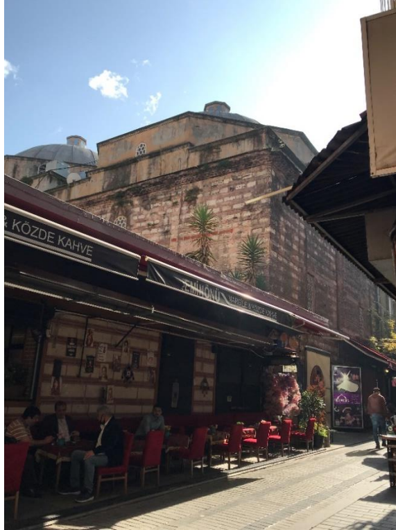
Fotoğraf 81: Hoca Paşa Hamam'ı Hamam Sokak'tan Genel Görünüm (Ş.Y.2020)
