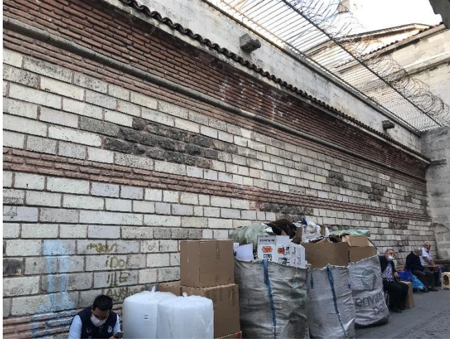
Fotoğraf 71: Tahtakale Hamamı Kantarcılar C. Ilıklık Ve Sıcaklık Duvarı Genel Görünüm (Ş.Y.2020)
