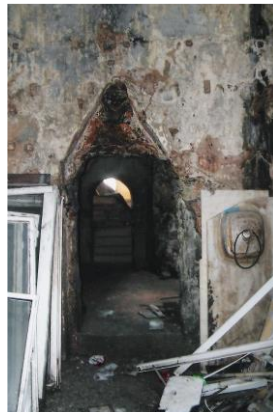
Fotoğraf 126: Ağa Hamamı Restorasyon Öncesi Ilıklık Görünümü (Şen Y., 2008)
