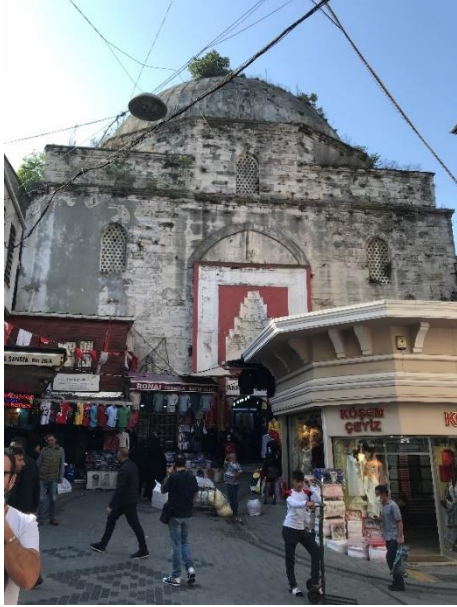
Fotoğraf 39: Mahmut Paşa Hamamı Doğu Cephesi (Ş.Y.2020)
