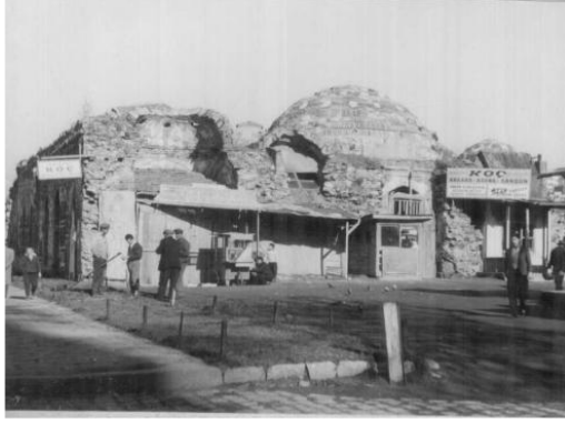
Fotoğraf 252: Yeşil Direkli Hamam Güney Cephesi Restorasyon Öncesi Görünümü (İst. 6 No.lu KVKBK Arşivi)
