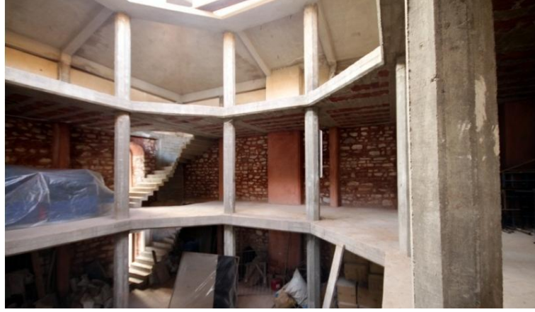
Fotoğraf 113: Ağa Hamamı Soyunmalık Bölümü Betonarme Katlar 2012 (agahamam.com)
