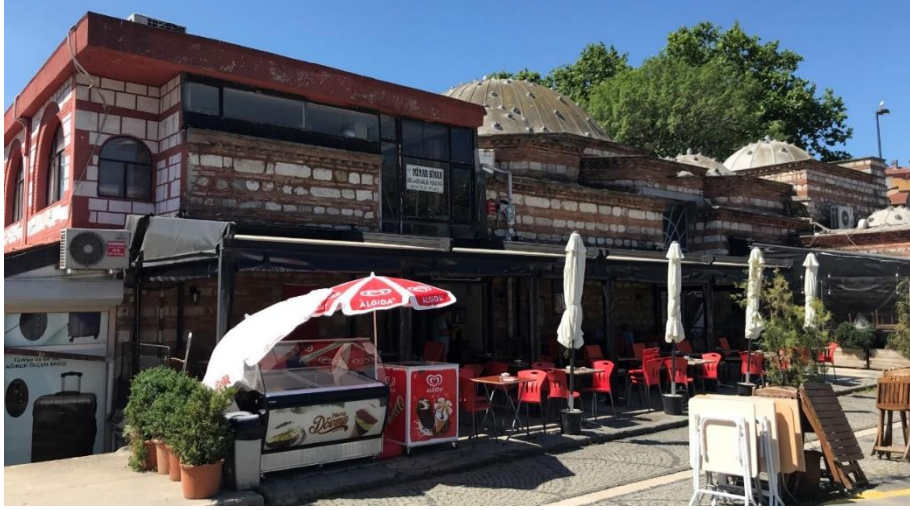
Fotoğraf 245: Yeşil Direkli Hamam Kuzey Cephesi Duvarına Bitişik YapılanTenteler (Ahmet Emre Bilgili, 2018)
