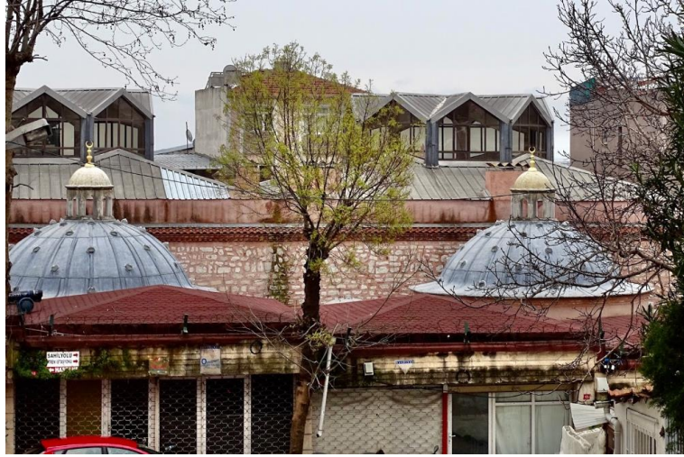
Fotoğraf 135: Ağa Hamamı Kuzey Cephesi Sıra Dükkânlar 2021 (Cenan T.) Hamamın su deposu galeri olarak işlevlendirilmiştir. Hamam su deposu duvarına bitişik sıra dükkânlar inşa edilmiştir.
