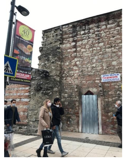
Fotoğraf 177: Yeşil Direkli Hamam Batı Cephesi Yıkılan Erkekler Soyunmalığı Duvar Kalıntısı (Ş.Y.2020)
