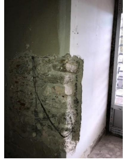
Fotoğraf 198: Yeşil Direkli Hamam Erkekler Ilıklığı Raspası (Tıraşlık Giriş Açıklığının Yanı) (Ş.Y.2020)
