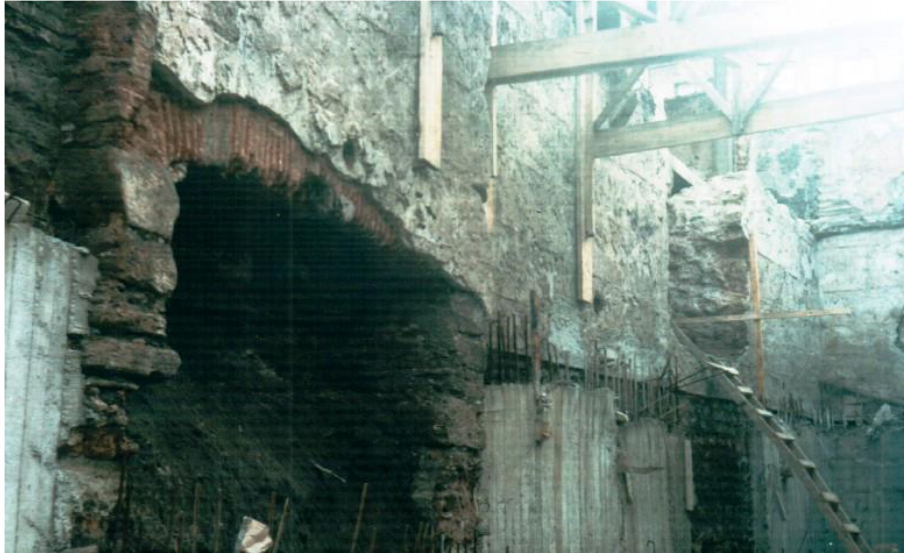
Fotoğraf 77: Tahtakale Hamamı Külhan Temizlikten Önceki Durumu (K.V.K.K. Arşivi, EK-3[4])
