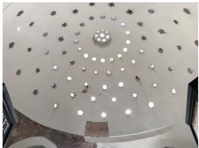
Fotoğraf 184: Yeşil Direkli Hamam Erkekler Ilıkl. Orta Kubbesi (Ş.Y.2020) Fotoğraf 185: Yeşil Direkli Hamam Kadınlar Sıcık. Ana Kubbesi Ve Fil Gözleri (Ş.Y.2020)
