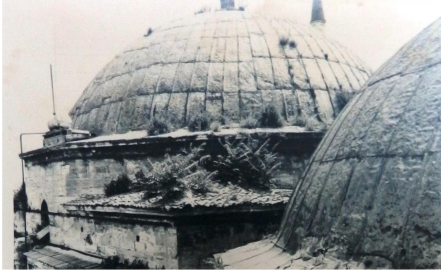
Fotoğraf 67: Tahtakale Hamamı Soyunmalık Kubbelerinde Oluşan Fiziksel ve Biyolojik Sorunlar (K.V.K.K. Arşivi, EK-3[4])
