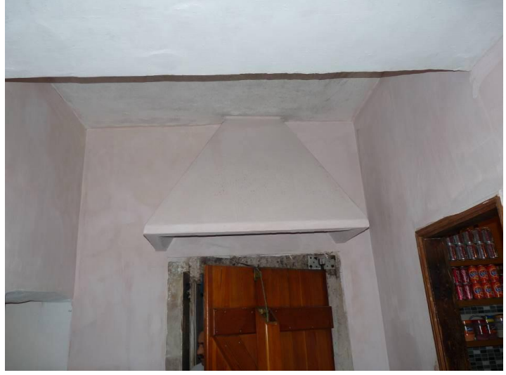
Fotoğraf 10: Çemberlitaş Hamamı, Yaşmaklı Hava Bacası (T. Cem Yaman)
