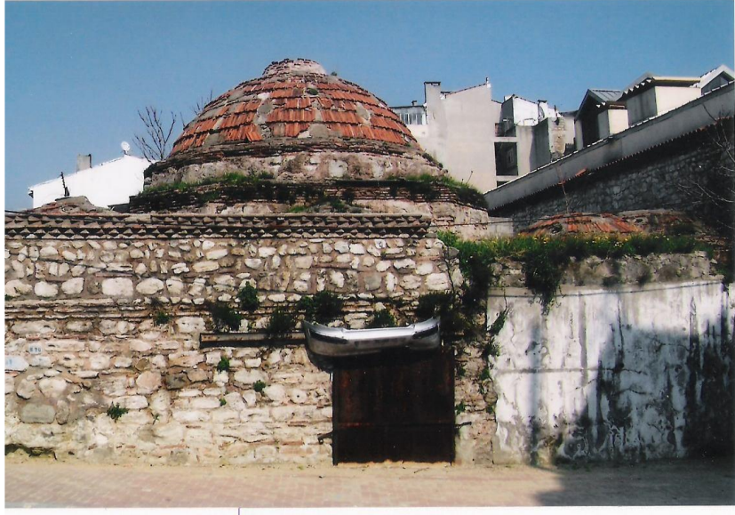
Fotoğraf 122: Ağa Hamamı Batı Cephesi Restorasyon Öncesi Görünümü (Şen Y., 2008)
