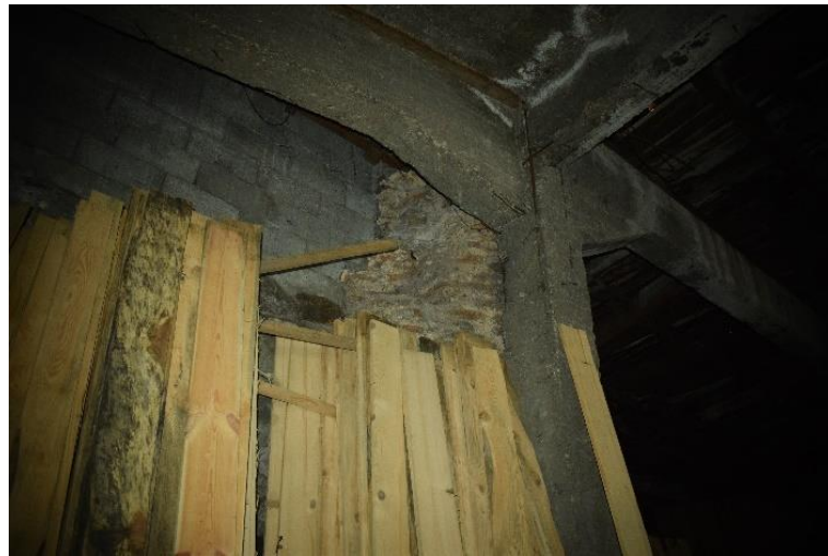
Fotoğraf 168: Ayakapı Hamamı Külhan Bölümüne Ait Duvar Kalıntısı (Ş.Y.2020)
