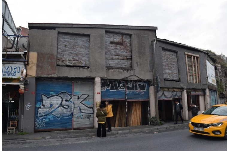
Fotoğraf 166: Ayakapı Hamamı Kuzey Cephesi Ek Yapı (Ş.Y.2020)
