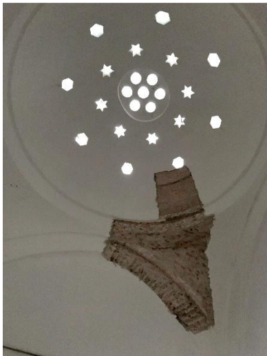
Fotoğraf 184: Yeşil Direkli Hamam Erkekler Ilıkl. Orta Kubbesi (Ş.Y.2020) Fotoğraf 185: Yeşil Direkli Hamam Kadınlar Sıcık. Ana Kubbesi Ve Fil Gözleri (Ş.Y.2020)
