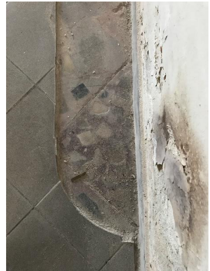
Fotoğraf 223: Yeşil Direkli Hamam Erkekler Sıcaklığı Güneybatı Halvet Döşemesi (Ş.Y.2020)
