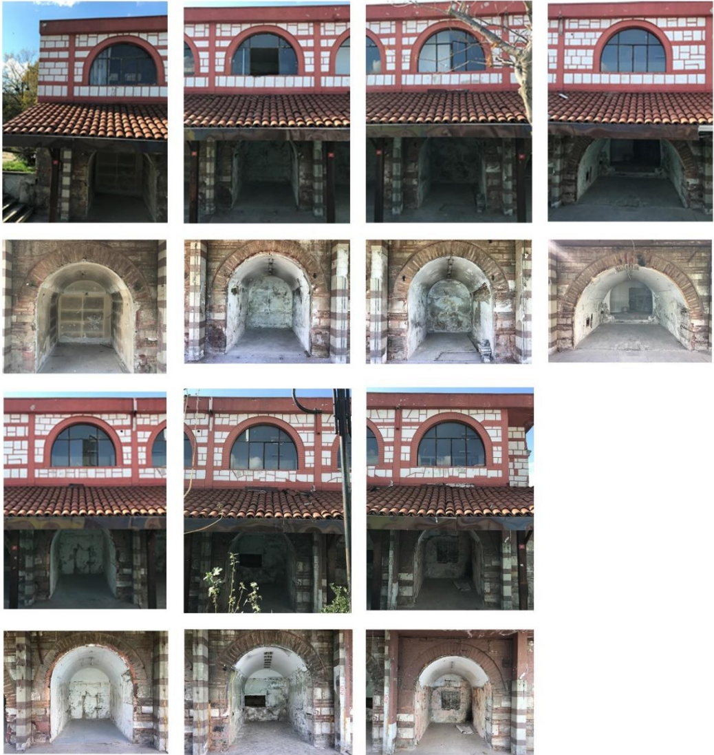
Fotoğraf 231: Yeşil Direkli Hamam Doğu Cephesi Ek Yapı Çukur Dükkânlar (Ş.Y.2020)
