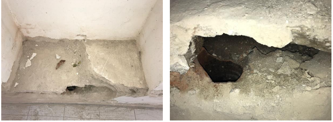
Fotoğraf 221: Yeşil Direkli Hamam Kadınlar Sıcaklığı Güneydoğu Halvet Nişi Altındaki Toprak Künk (Ş.Y.2020)
