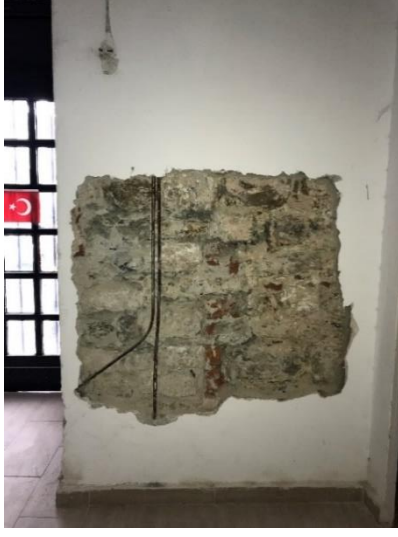
Fotoğraf 197: Yeşil Direkli Hamam Erkekler Ilıklığı Raspası (Orta Kubbeli Kısım Giriş Açıklığının Yanı) (Ş.Y.2020)
