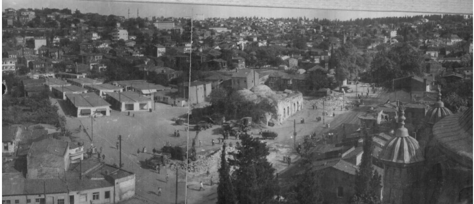
Fotoğraf 242: Yeşil Direkli Hamam Restorasyon Öncesi Görünümü Kuzeybatı Cephesi (İst. 6 No.lu KVKBK Arşivi'nden)
