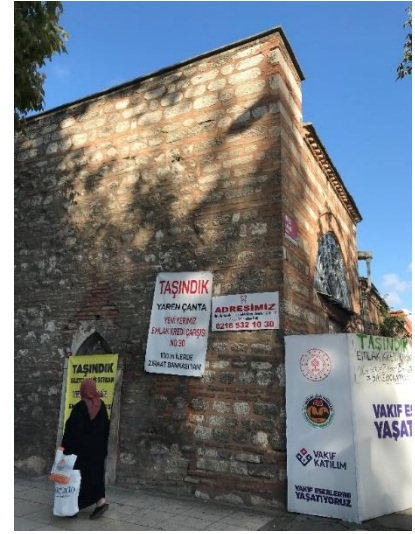
Fotoğraf 179: Yeşil Direkli Hamam Batı Cephesi Yıkılan Kadınlar Soyunmalığının Yeniden Örülen Duvarı (Ş.Y.2020)
