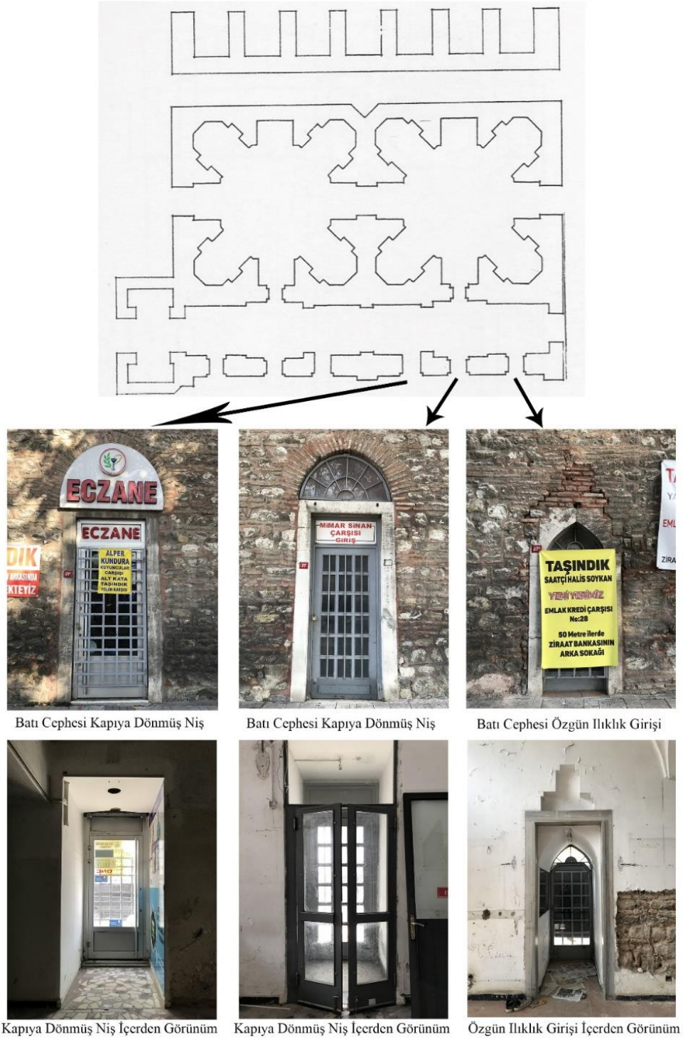
Şekil 45: Yeşil Direkli Hamam Restorasyon Sonrası Batı Cephesi Kadınlar ılıkığına Geçiş (Ş.Y.2020)
