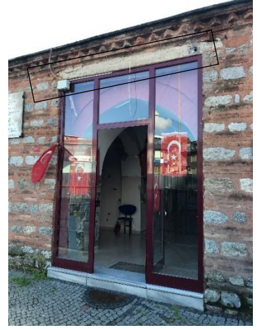
Fotoğraf 248: Yeşil Direkli Hamam Kuzey Cephesi Hela Duvarında Kalan Tente İzi (Ş.Y.2020)
