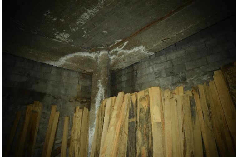
Fotoğraf 169: Ayakapı Hamamı Külhan Sonunun Betonarme İle Devam Etmesi (Ş.Y.2020)
