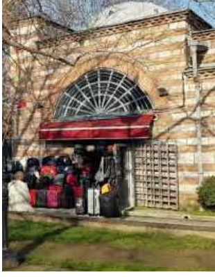
Fotoğraf 255: Yeşil Direkli Hamam Güney Cephesi Duvarına Bitişik Yapılan Tente 2018
