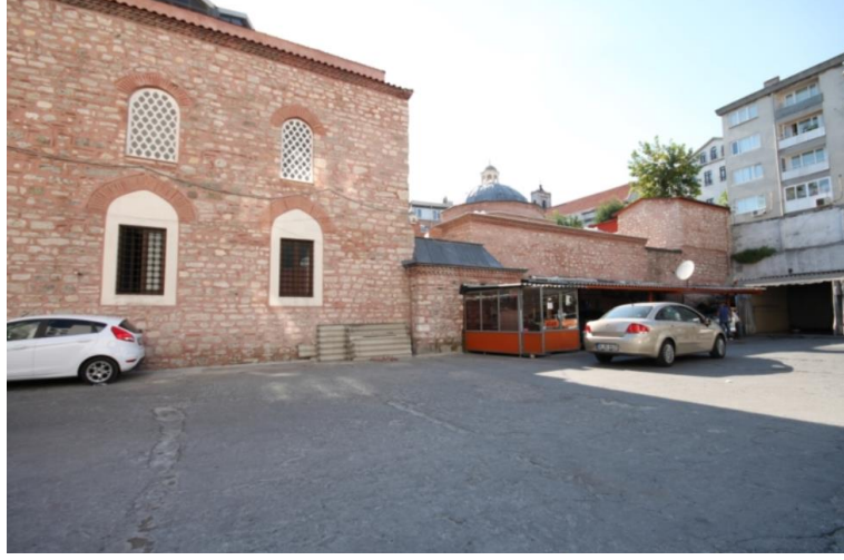
Fotoğraf 134: Ağa Hamamı Doğu Cephesi Bitişik Ek Yapı 2012 (agahamamı.com) Yapının doğu cephesinde ılıklik ve sıcaklık duvarına bitişik ek yapı yapılmıştır. Yapının bu cephesi otopark olarak kullanılıyor.
