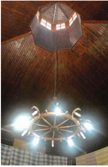
Fotoğraf 29: Ankara Karacabey Hamamı, Soyunmalık Mahali Ahşap Kırma Çatı ve Ahşap aydınlık feneri (www.dijimecmua.com)
