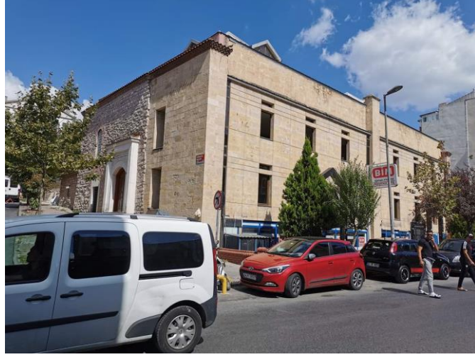
Fotoğraf 111: Ağa Hamamı Ön Cephesi (Mehmet Dilbaz 2019)
