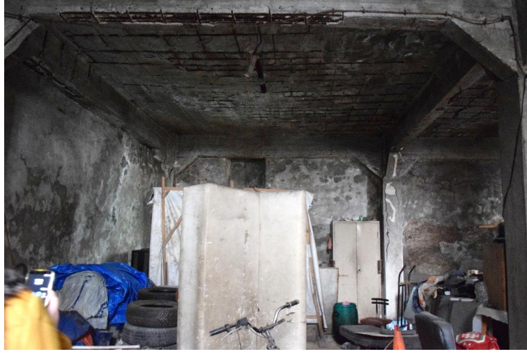
Fotoğraf 156: Ayakapı Hamamı Güney Soyunmalık Ek Betonarme Döşeme (Ş.Y.2020)
