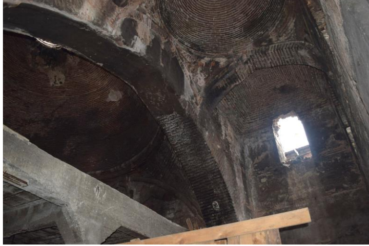
Fotoğraf 149: Ayakapı Hamamı Rüzgarlık - Soyunmalık Birleşimi (Ş.Y.2020)
