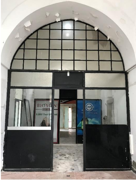
Fotoğraf 195: Yeşil Direkli Hamam Kadınlar Fotoğraf 196: Yeşil Direkli Hamam Ilıklığı Alüminyum Doğrama Kullanımı 2020 Erkekler Ilıklığı Alüminyum Doğrama (Ş.Y.2020) Kullanımı (Ş.Y.2020)
