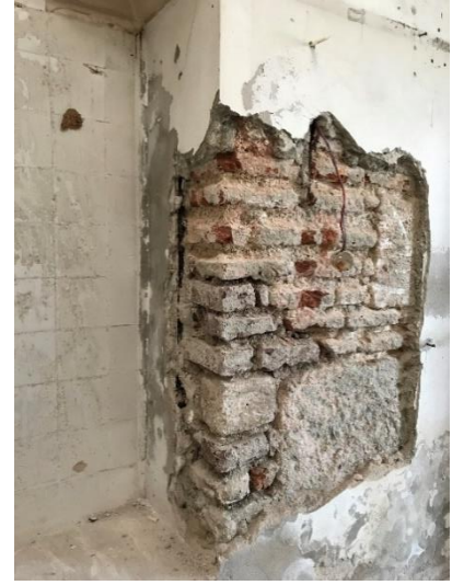
Fotoğraf 218: Yeşil Direkli Hamam Erkekler Sıcaklığı Sıva Raspası (Güneydoğu Halveti) (Ş.Y.2020)
