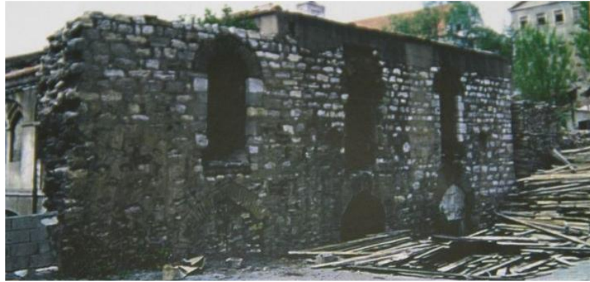
Fotoğraf 119: Ağa Hamamı Doğu Cephesi Restorasyon Öncesi Görünümü (agahamam.com)
