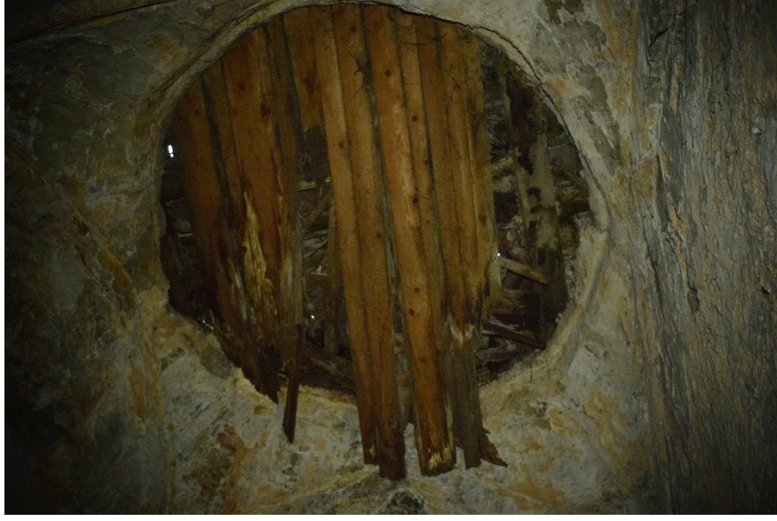
Fotoğraf 162: Ayakapı Hamamı Ilıklık Kapatılan Kubbe (Ş.Y.2020)
