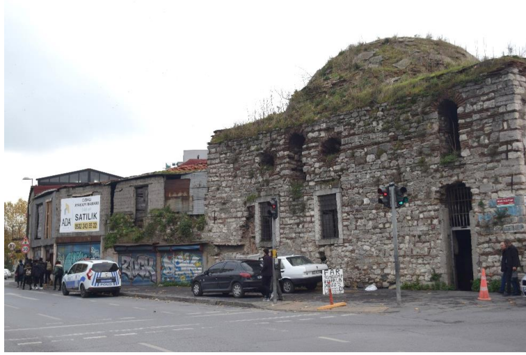
Fotoğraf 150: Ayakapı Hamamı Abdülezelpaşa Caddesi, Kuzey Cephesi Genel Görünüm (Ş.Y.2020)
