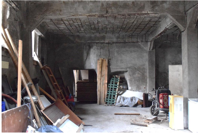
Fotoğraf 155: Ayakapı Hamamı Kuzey Soyunmalık Ek Betonarme Döşeme (Ş.Y.2020)
