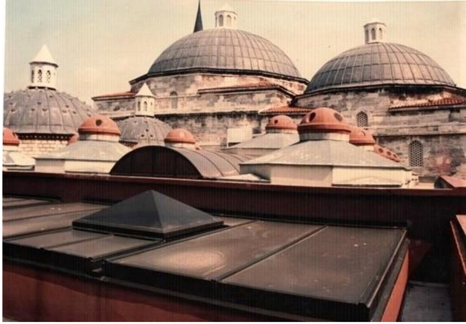
Fotoğraf 68: Tahtakale Hamamı Üst Örtü ve Çağdaş Konik Kubbelerin Dıştan Genel Görünümü (Kuban, Doğan, 1993)
