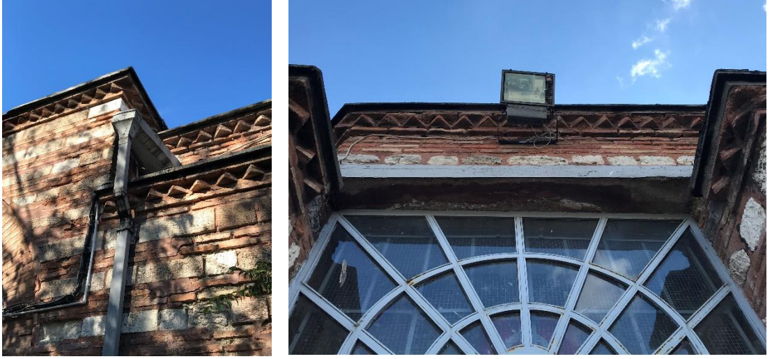
Fotoğraf 186: Yeşil Direkli Hamam Fotoğraf 187: Yeşil Direkli Hamam Kuzey Güney Cephesi Kirpi Saçak Kullanımı (Ş.Y.2020) Cephesi Kirpi Saçak Kullanımı (Ş.Y.2020)
