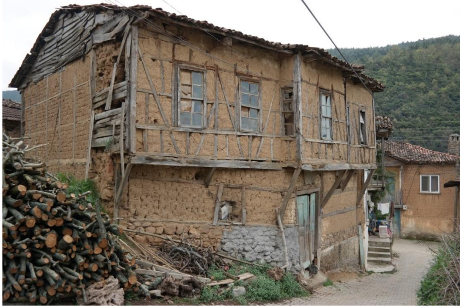
Şekil 4.67 Ahşap çarkı arası kerpiç kullanılan yapı örneği. Ada/Parsel Numarası: 930/188 (M. R. Çakan Arşivi, 2018)
