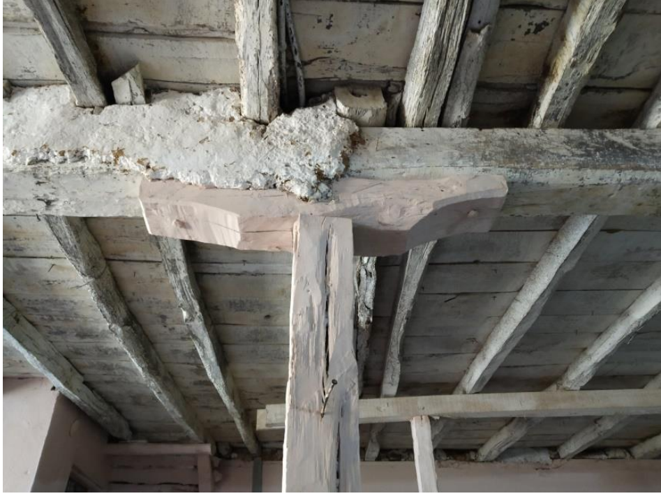
Şekil 4.70 Tek tabanlı döşemelerde kullanılan başlık örneği. Hisardere 23, Ada/Parsel Numarası: 930/298 (M. R. Çakan Arşivi, 2018)
