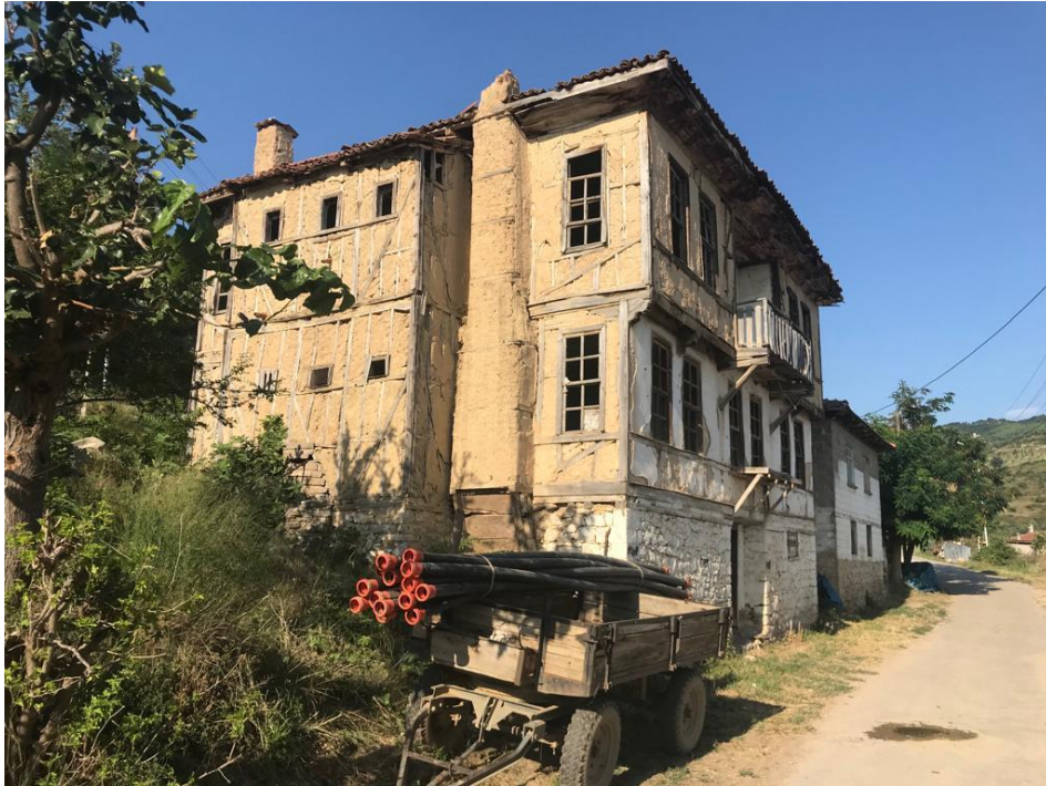
Şekil 3.18 Ömerli Köyü'nde sivil mimarlık örneği (A. Ertuğrul Arşivi, 2019)
