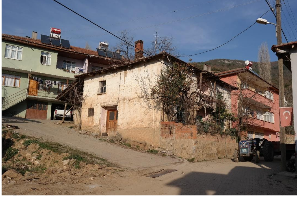
Şekil 4.22 Önde kireç sıvalı geleneksel yapı, arkada boyalı betonarme yapılar (M. R. Çakan Arşivi, 2019)
