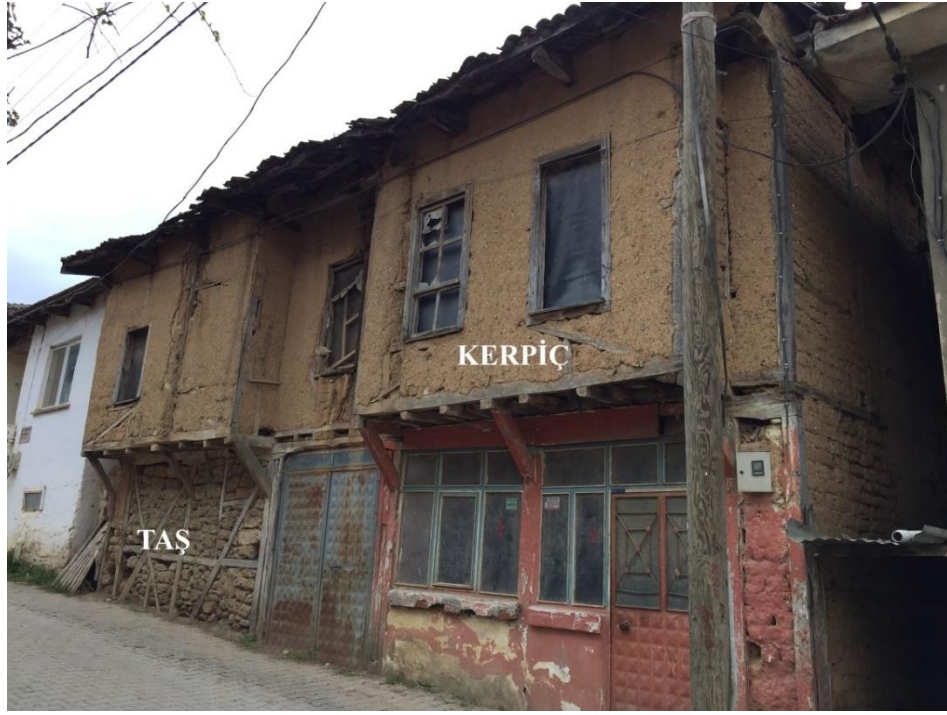
Şekil 4.64 Yapılarda çoklu malzeme kullanımı (M. R. Çakan Arşivi, 2018)
