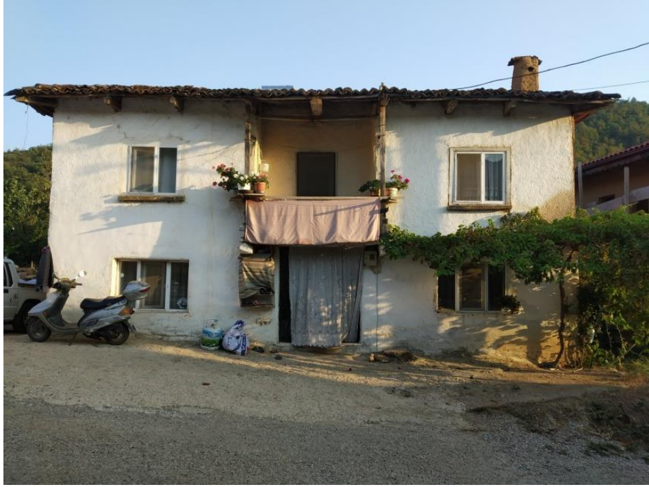
Şekil 4.60 Çıkmalık bulunan cephe örneği. Hisardere 14, Ada/Parsel Numarası: 921/11 (M. R. Çakan Arşivi, 2018)
