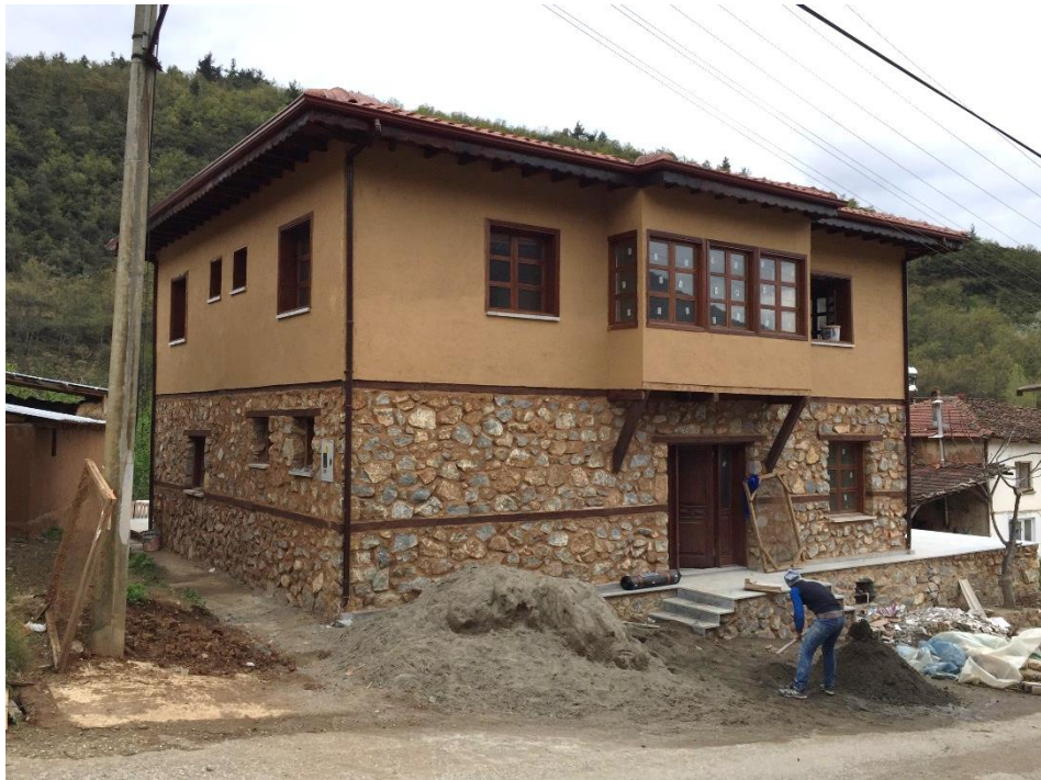
Şekil 4.20 İnşaatı devam etmek olan yapı (M.R. Çakan Arşivi, 2019)
