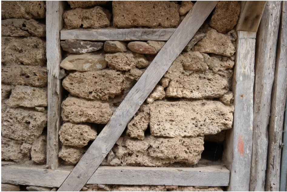
Şekil 4.71 Ahşap arası taş malzeme kullanımı (M. R. Çakan Arşivi, 2018)
