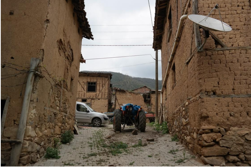
Şekil 4.15 Kerpiç malzeme kullanımı (M. R. Çakan Arşivi, 2019)
