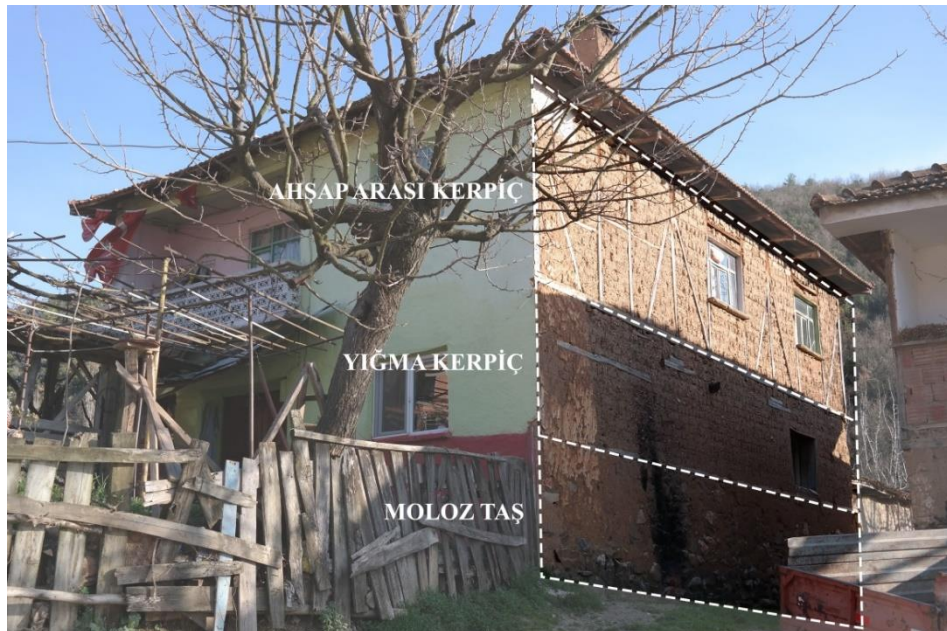
Şekil 4.65 Yapım sistemi örneği. Hisardere 15, Ada/Parsel Numarası: 921/4 (M. R. Çakan Arşivi, 2018)
