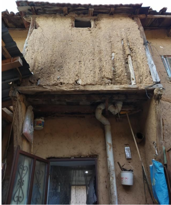
Şekil 4.47 Konuttaki tuvaletin dışardan görünümü. Hisardere 14, Ada/Parsel Numarası: 921/11 (M. R. Çakan Arşivi, 2018)
