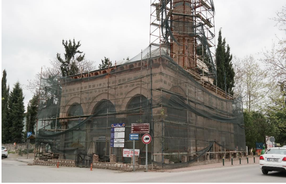
Şekil 3.11 Mahmud Çelebi Camii'nde restorasyon çalışması (M. R. Çakan Arşivi, 2019)
