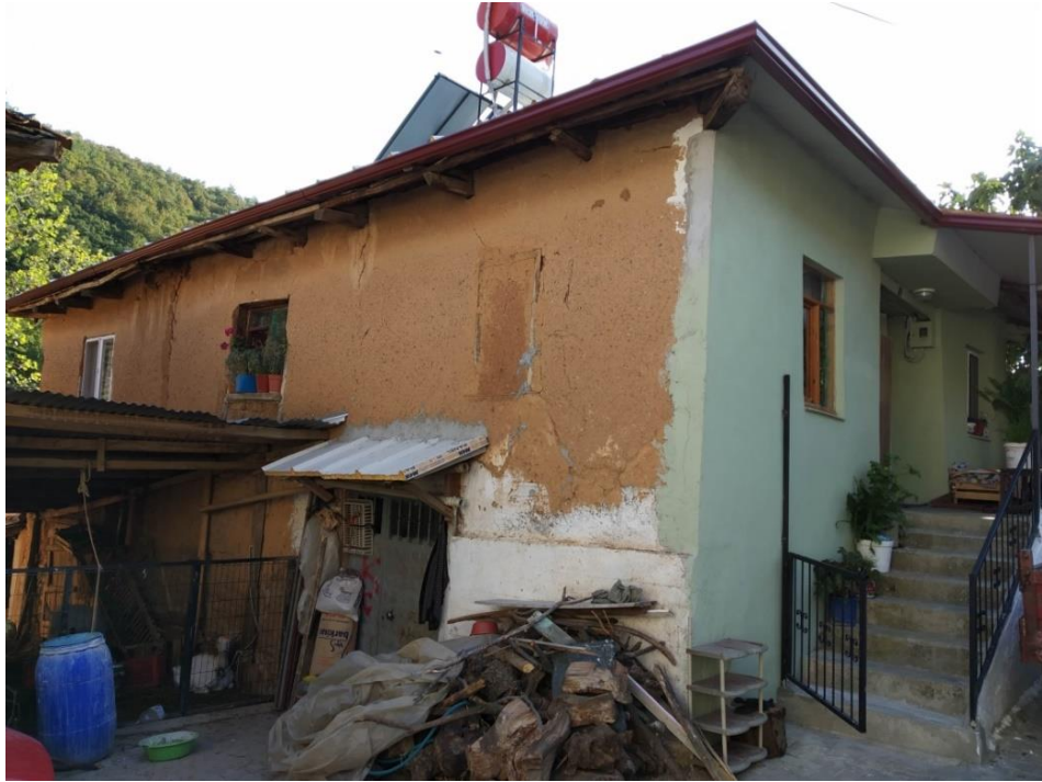
Şekil 4.17 Eğime yerleşmiş bir yapı. Hisardere 1, Ada/Parsel Numarası: 921/12 (M. R. Çakan Arşivi, 2018)
