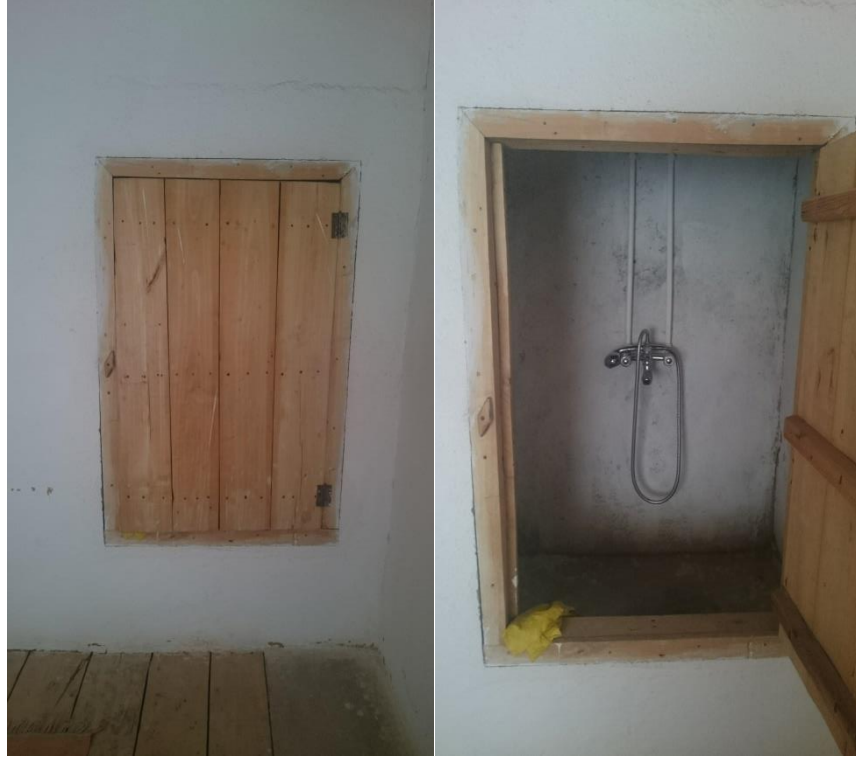
Şekil 4.42 Oda içerisinde hamamlık kapısı ve içi. Hisardere 5, Ada/Parsel Numarası: 928/2 (M. R. Çakan Arşivi, 2018)
