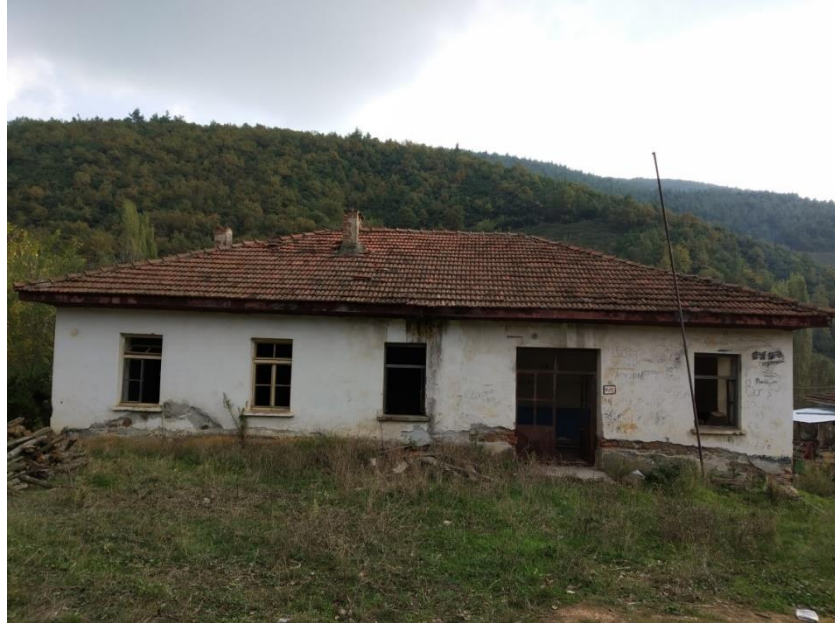
Şekil 4.10 Köyde bulunan eski okul yapısı. Hisardere 4, Ada/Parsel Numarası: 930/139 (M. R. Çakan Arşivi, 2018)
