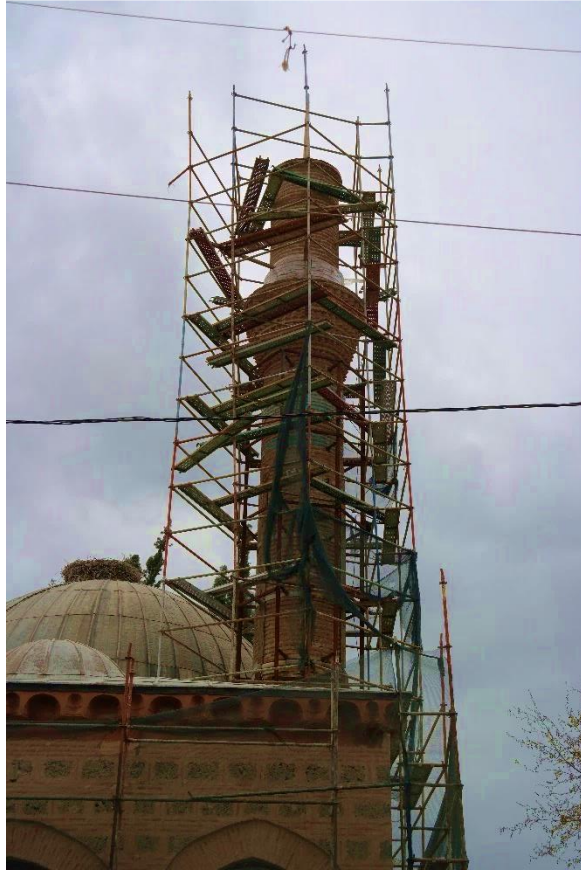
Şekil 3.12 Mahmud Çelebi Camii minaresinde restorasyon çalışması (M. R. Çakan Arşivi, 2019)
