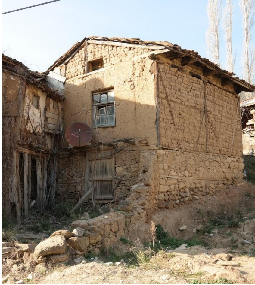
Şekil 4.84 Alt katı dam üst katı samanlık. Ada/Parsel Numarası: 930/188 (M. R. Çakan Arşivi, 2018)
