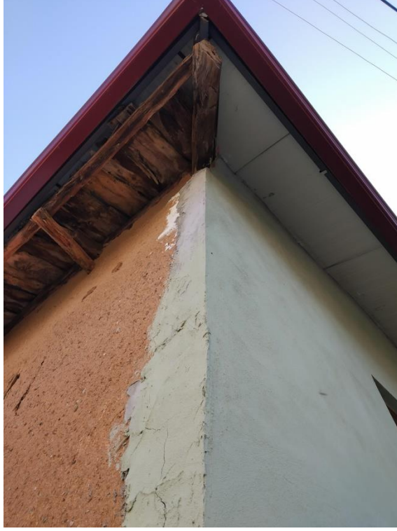
Şekil 4.62 Çatıya geçişte kullanılan saçak örneği. Hisardere 1, Ada/Parsel Numarası: 921/12 (M. R. Çakan Arşivi, 2018)
