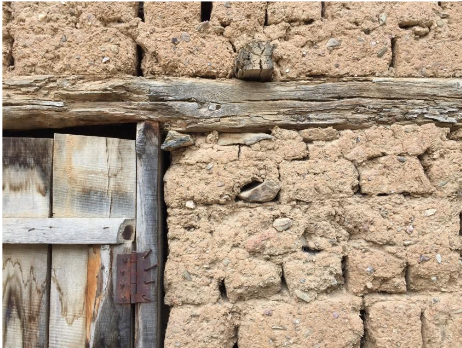
Şekil 4.69 Kerpiç blokların yanyana dizilmesi ve ahşap hatılların kullanılması örneği. Hisardere 11, Ada/Parsel Numarası: 924/1 (M. R. Çakan Arşivi, 2018)
