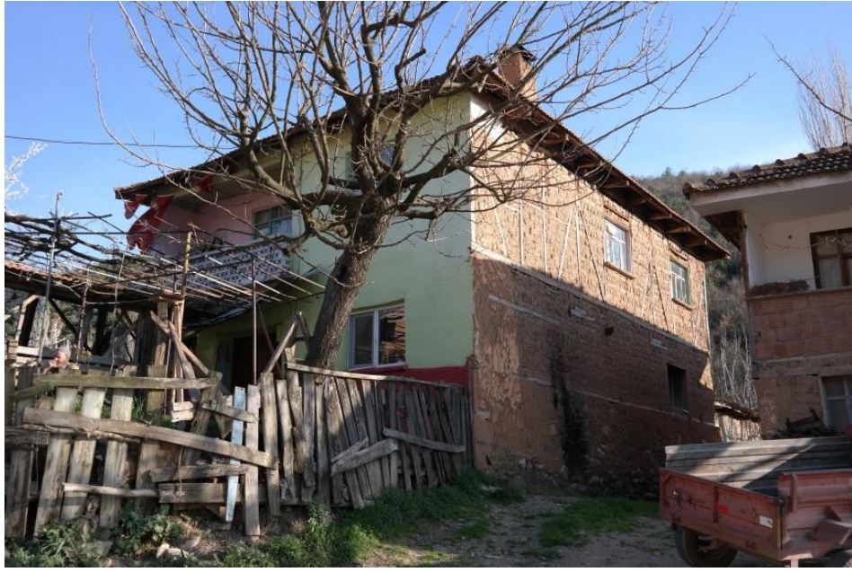
řekil 4.58 n cephe sıvası korunmuř, yan cephelerinin sıvası kaybolmuř konut rneđi. Hisardere 15, Ada/Parsel Numarası: 921/4 (M. R. akan Arřivi, 2018)
