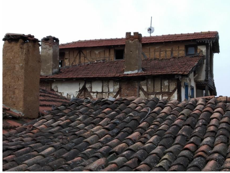
Şekil 4.63 Çatılarda alaturka kiremit ve marsilya kiremiti kullanımı (M. R. Çakan Arşivi, 2018)
