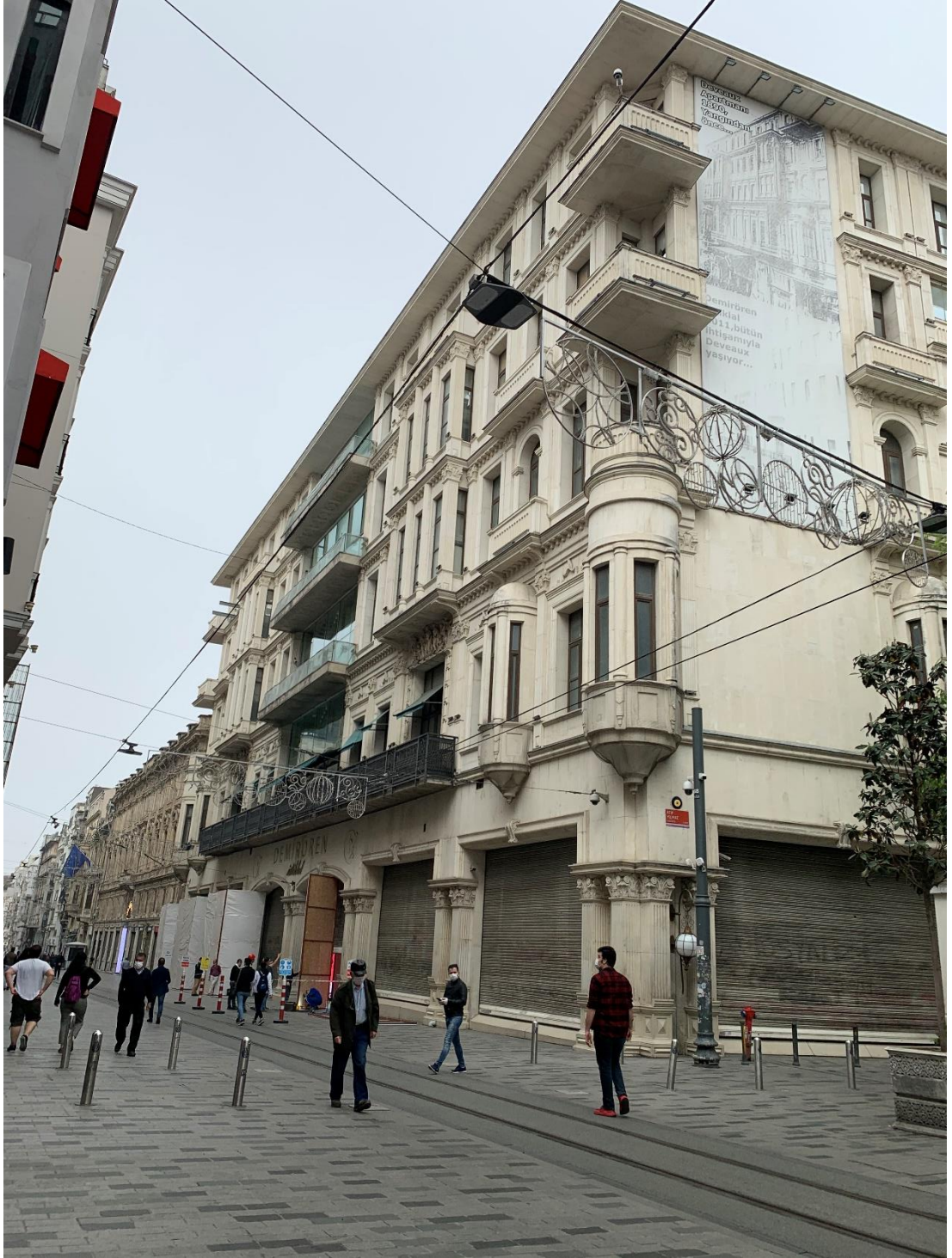
Şekil 5.51: Demirören AVM İstiklal Caddesi Cephesi (Özbek, B.)
