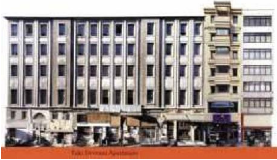
Şekil 5.44: Yangından Sonra Deveaux Apartmanları Dönem Eki-Saray Sineması 1950 (Baruh,2016).
