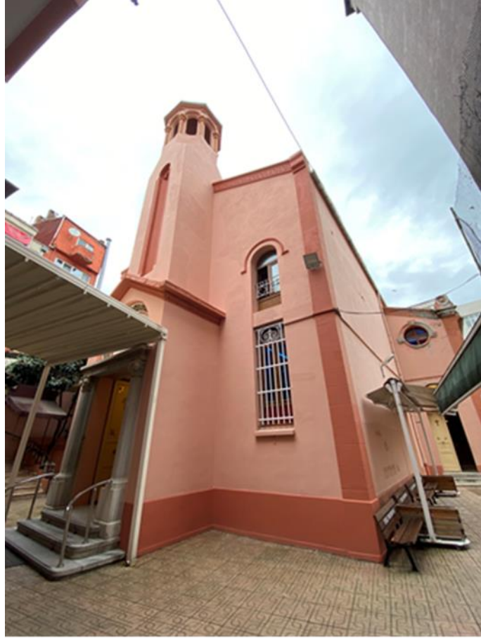
Şekil 5. 102 Surp Vartanants Ermeni Kilisesi'nin batı cephesi (Özcan, 2021)
