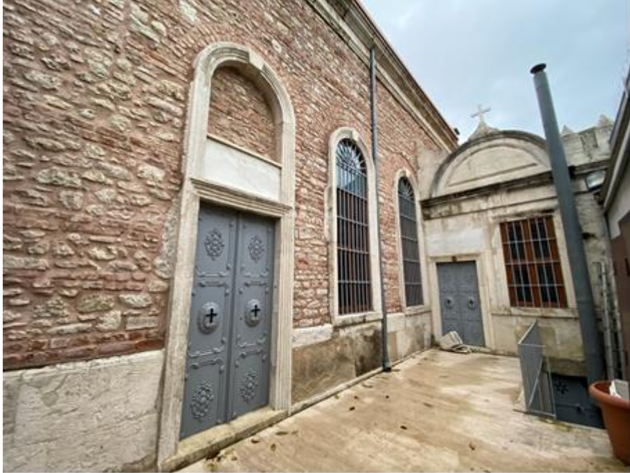
Şekil 5. 35 Surp Hagop Ermeni Kilisesi güney cephesi (Özcan, 2021)
