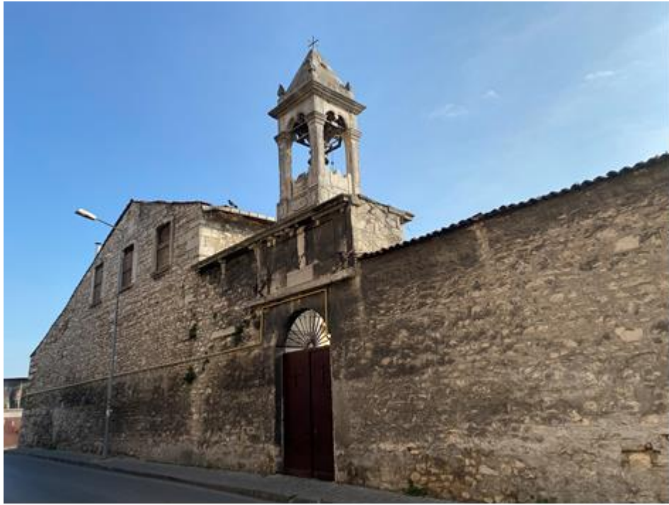
Şekil 5. 46 Surp Nigoğayos Ermeni Kilisesi batı cephesi (Özcan, 2021)
