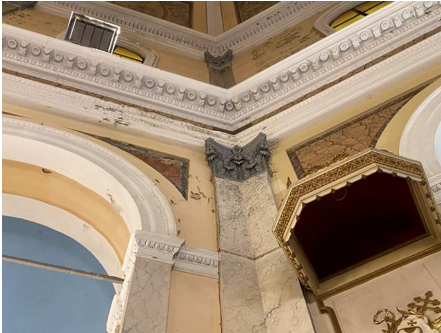
Şekil 5. 213 Surp Hovhan Vosgeperan Ermeni Katolik Kilisesi, silmede aşınmalar (Özcan, 2021)
