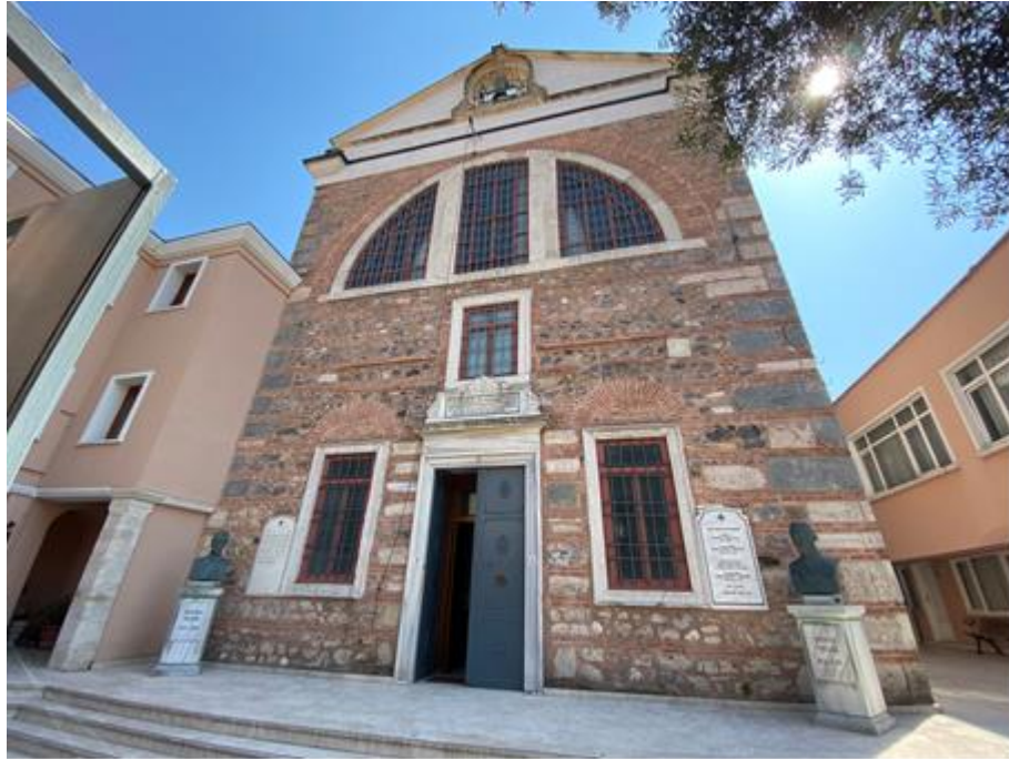
Şekil 5. 130 Surp Asdvadzadzin Ermeni Kilisesi batı cephesi (Özcan,2022)
