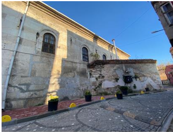
Şekil 5. 14 Balat Surp Hireşdagabet Kilisesi'nin güney cephesinde bulunan derz boşalmaları ve bitkilenme (Özcan 2021)
