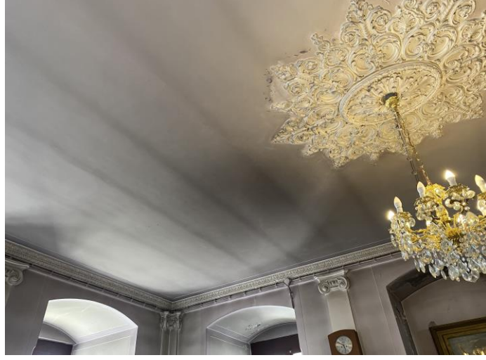
Şekil 5. 188 Surp Garabed Ermeni Kilisesi'nin narteks bölümünde oluşan islenme (Öykü, 2022)
