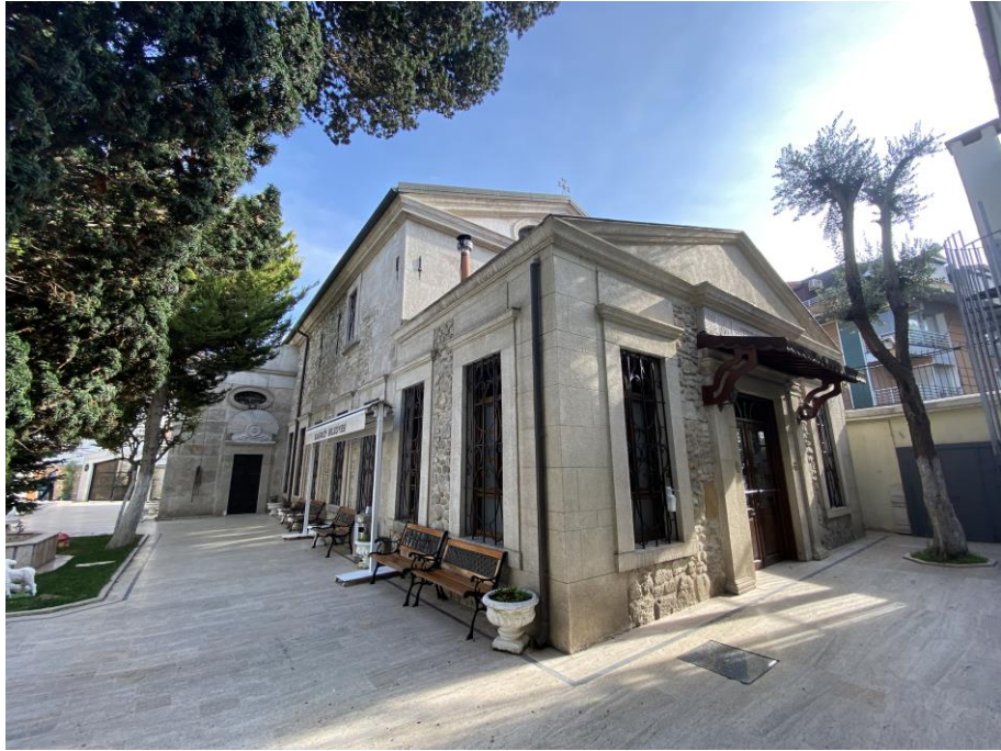
Şekil 5. 77 Yeşilköy Surp Stepanos Kilisesi'nin batı cephesi (Özcan, 2021)
