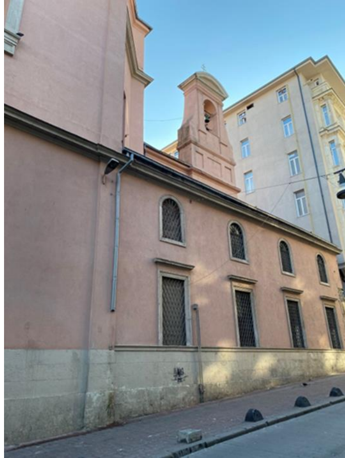
Şekil 5. 211 Surp Hovhan Vosgeperan Ermeni Katolik Kilisesi cephede siyah kabuk oluşumu ve yıkanmalar (Özcan, 2021)
