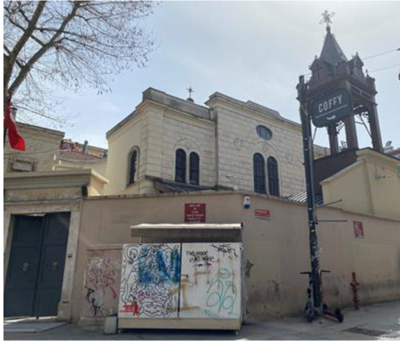
Şekil 5. 154 Surp Takavor Kilisesi'nin kuzeybatı cephesi (Özcan, 2022)
