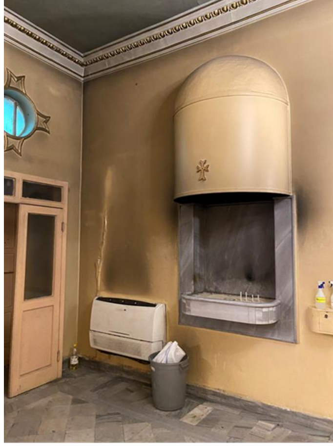
Şekil 5. 113 Surp Vartanants Ermeni Kilisesi islenme sorunu (Özcan, 2021)
