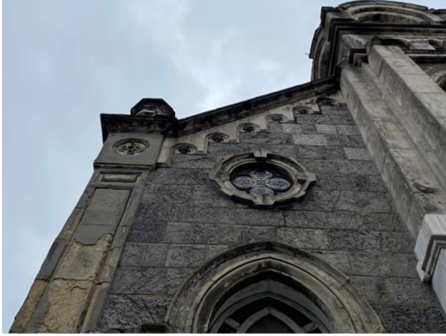
Şekil 5. 244 Aynalıçeşme Avedaragan Amenasurp Yerrortutyun Ermeni Kilisesi'nin batı cephesi üzerinde oluşan don etkisi (Özcan, 2022)
