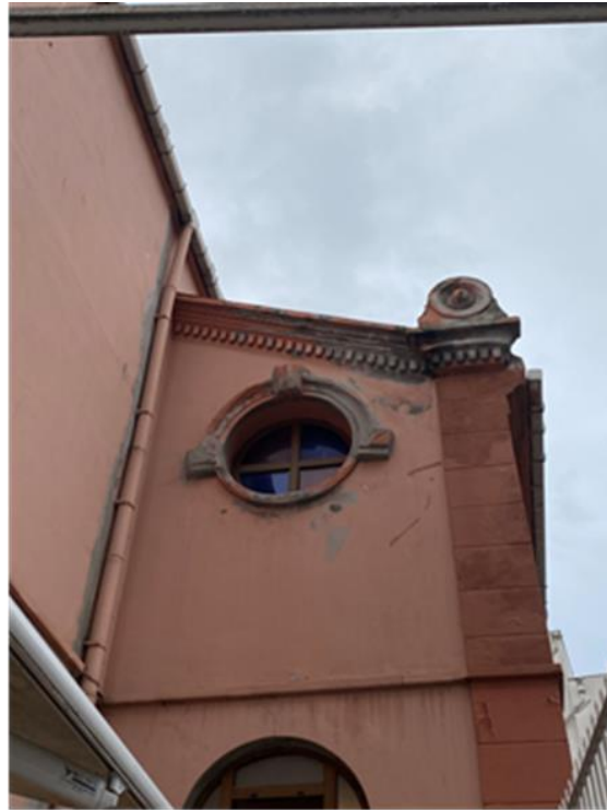
Şekil 5. 112 Cephe duvarı üzerinde sıva uygulaması (Özcan, 2021)
