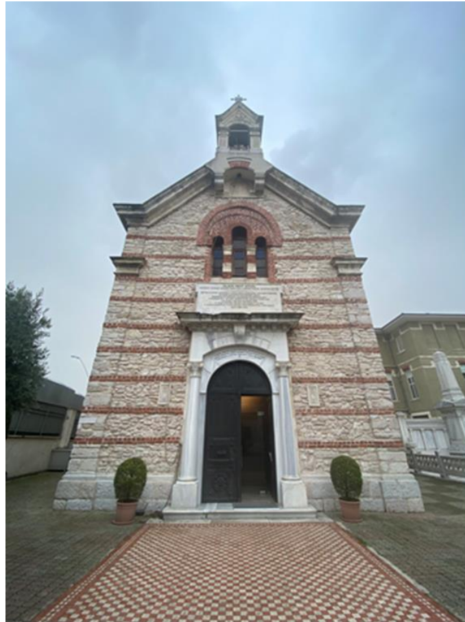
Şekil 5. 90 Surp Pırgiç Ermeni Kilisesi'nin batı cephesi (Özcan, 2021)
