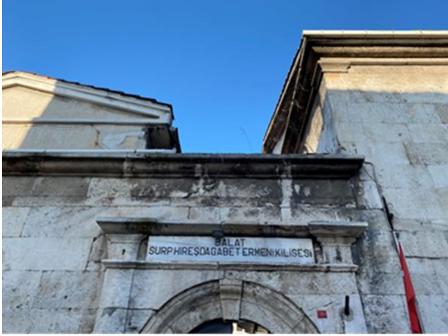
Şekil 5. 16 Balat Surp Hıreşdagabet Kilisesi'nin giriş kapısı üzerinde bulunan siyah kabuk oluşumu. (Özcan, 2021)
