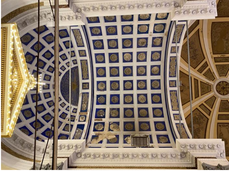
Şekil 5. 218 Surp Hovhan Vosgeperan Ermeni Katolik Kilisesi apsit üzerinde bulunan tonozda aşınma (Özcan, 2021)
