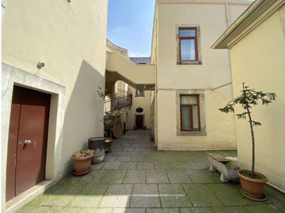
Şekil 5. 159 Surp Takavor Kilisesi'nin güney cephesi (Özcan, 2022)
