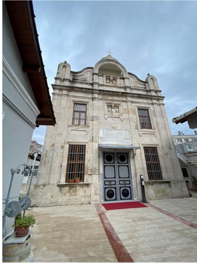
Şekil 5. 33 Surp Hagop Ermeni Kilisesi batı cephesi (Özcan, 2021)
