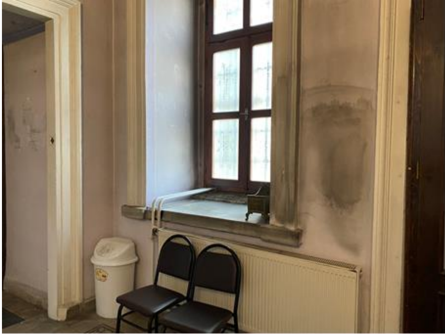
Şekil 5. 187 Surp Garabed Ermeni Kilisesi'nin vaftiz odasında bulunan islenme (Öykü, 2022)
