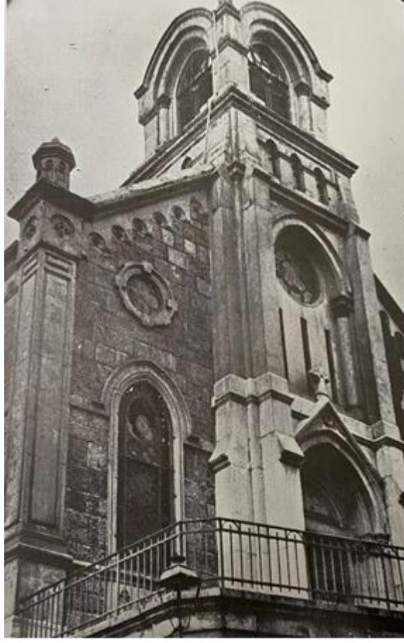
Şekil 5. 236 Aynalıçeşme Amenasurp Yerrortutyun (Üçhoran) Protestan Ermeni Kilisesi'nin ön (giriş) cephesi (1938) (Tuğlacı, 1991, s.317)
