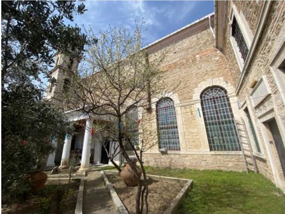
Şekil 5. 176 Surp Garabed Ermeni Kilisesi'nin güney cephesi (Öykü, 2022)
