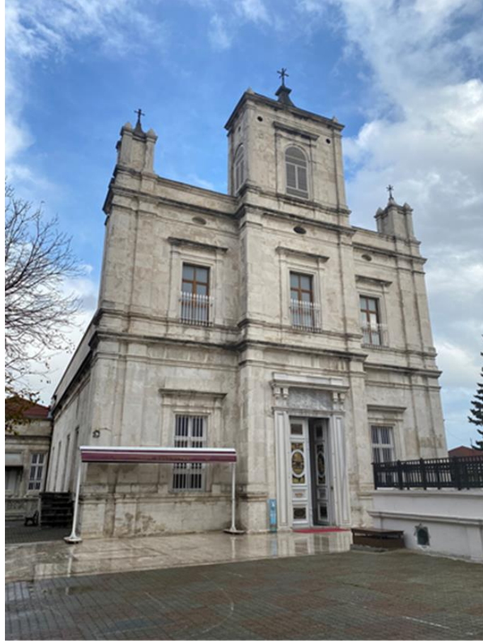
Şekil 5. 19 Surp Kevork Ermeni Kilisesi batı cephesi (Özcan, 2021)
