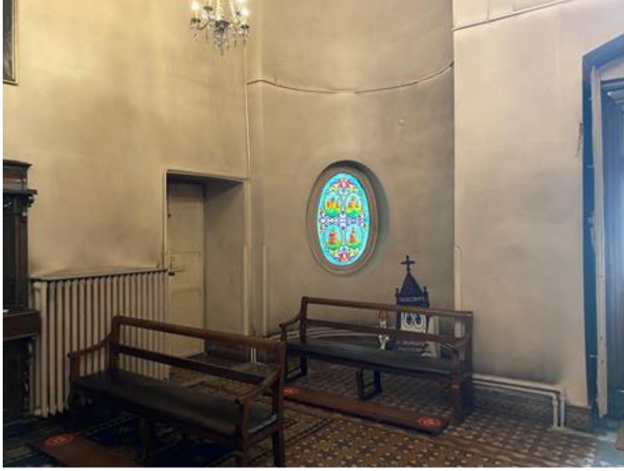
Şekil 5. 170 Surp Takavor Ermeni Kilisesi'nin vaftiz odasında oluşan islenme (Özcan, 2022)
