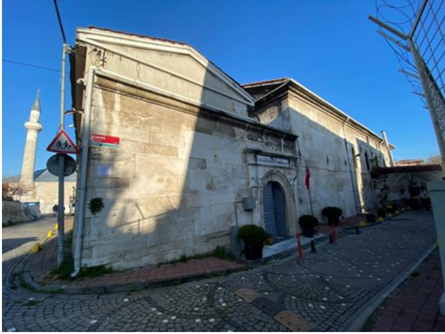
Şekil 5. 3 Balat Surp Hireşdagabet Kilisesi Güney cephesi (Özcan 2021)
