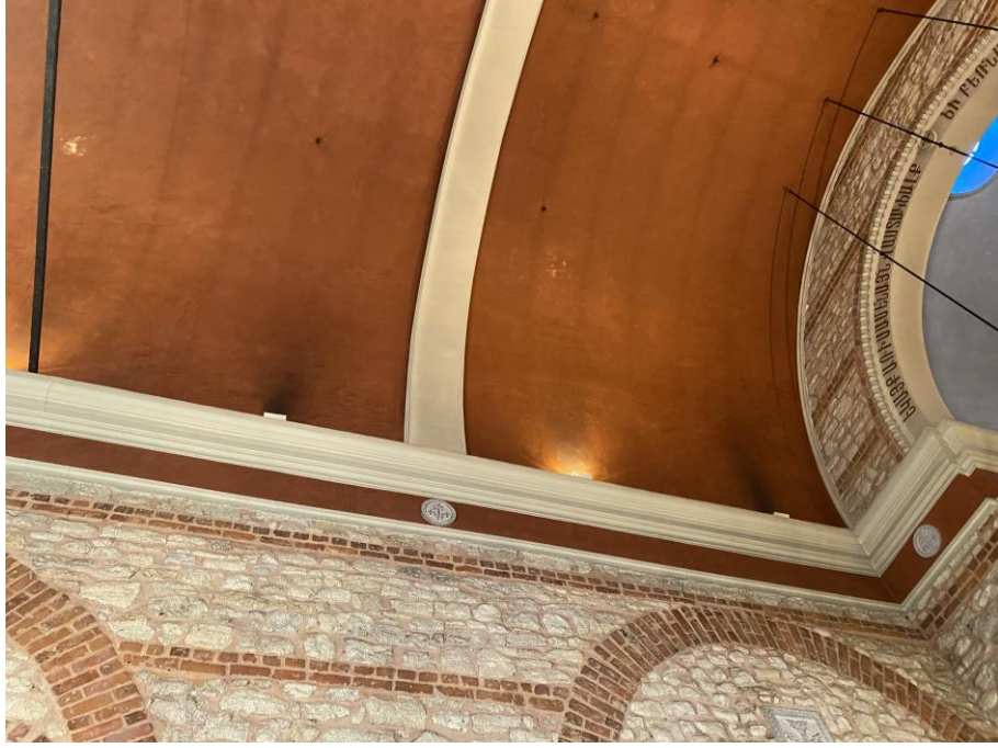
Şekil 5. 98 Surp Pırgiç Ermeni Kilisesi'nin tonozunda bulunan islenme sorunu (Özcan, 2022)
