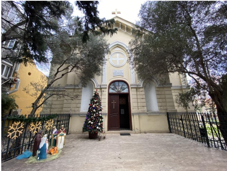
Şekil 5. 222 Surp Levon Ermeni Katolik Kilisesi batı cephesi (Özcan, 2022)
