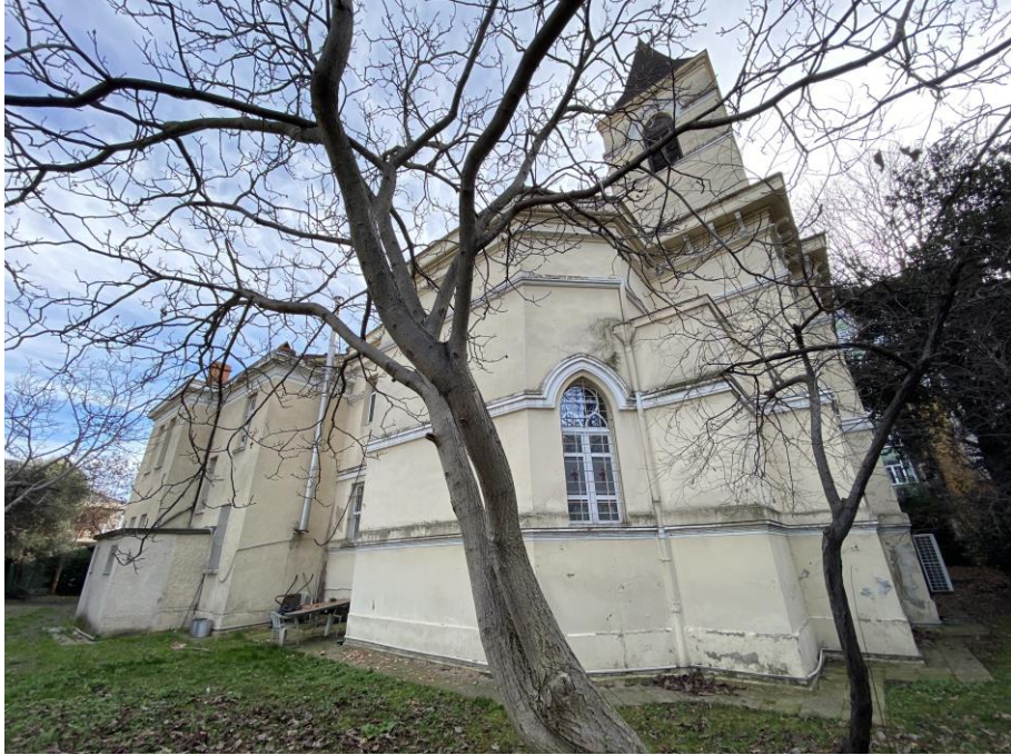
Şekil 5. 224 Surp Levon Ermeni Katolik Kilisesi doğu cephesi (Özcan, 2022)
