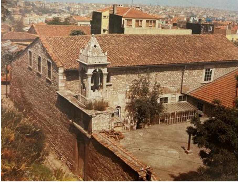
Şekil 5. 45 Topkapı Surp Nigoğayos Kilisesi'nin yan cephesi ve çan kulesi (1995) (Tuğlacı, 1991, s.176)
