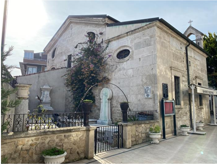
Şekil 5. 75 Yeşilköy Surp Stepanos Kilisesi'nin doğu cephesi (Özcan, 2021)
