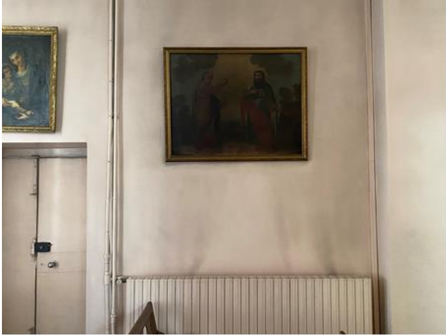
Şekil 5. 171 Surp Takavor Ermeni Kilisesi'nin naos bölümünde oluşan islenme (Özcan, 2022)
