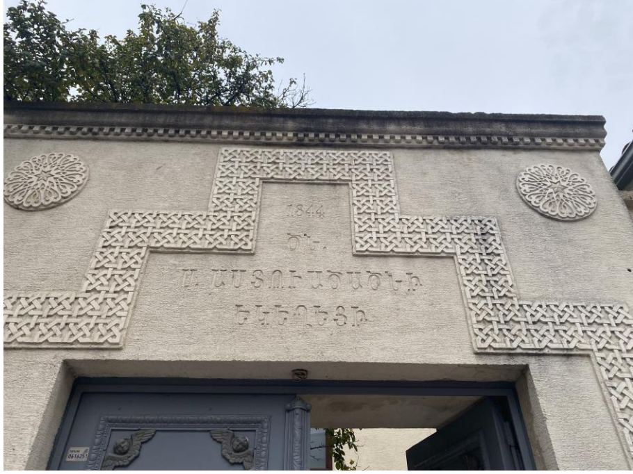
Şekil 5. 69 Surp Asdvadzadzin Kilisesi'nin avlusuna giriş kapısı üzerinde bulunan siyah kabuk oluşumu ve yıkanmalar (Özcan, 2021)
