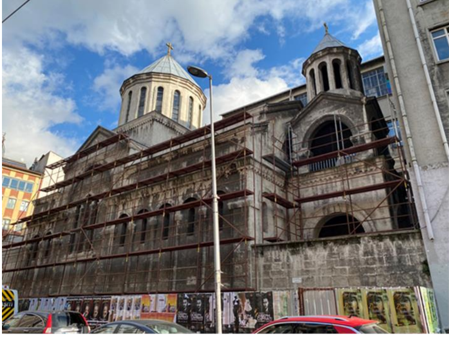
Şekil 5. 116 Surp Krikor Lusavoriç Ermeni Kilisesi'nin kuzey cephesi (Özcan, 2021)
