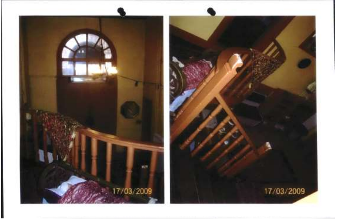
Şekil A. 11. Kütahya Konağı 2009 yılına ait giriş kapısı ve fevkâni kat döşeme fotoğrafları. (Kütahya Kültür Varlıklarını Koruma Bölge Kurulu Müdürlüğü)
