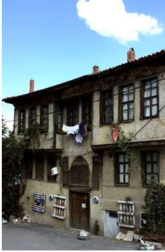
Şekil C. 3. 141 ada 19 parsel konut yapısı giriş cephesi (Ocak, 2019).
