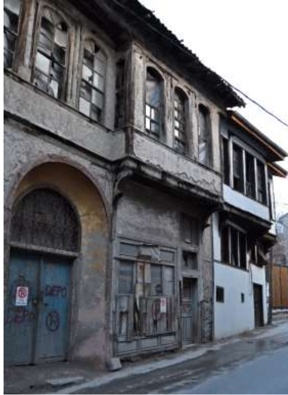
Şekil 4. 9. 106 ada 80 parsel konut yapısı ve bitişik nizamda bulunan tescilli yapı (Mayıs, 2018).
