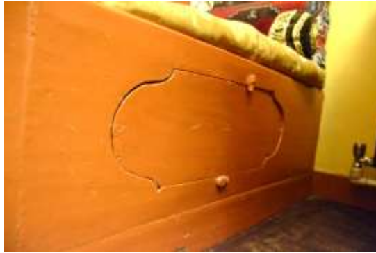
Şekil B. 66. 2-03 numaralı baş oda sediri, elmalık detayı (Eylül, 2018).
