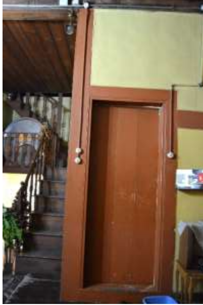
Şekil B. 47. 2-06 numaralı oda kapısı, divanhâneden görünüş (Eylül, 2018).
