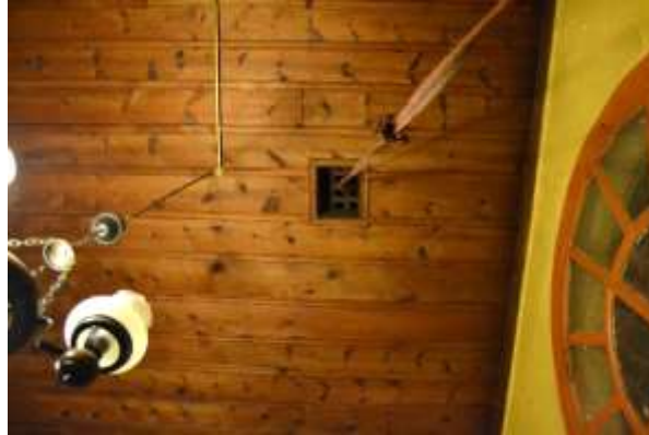
Şekil B. 14. Z-01 numaralı giriş holü tavanında ahşap ızgara (Eylül, 2018).
