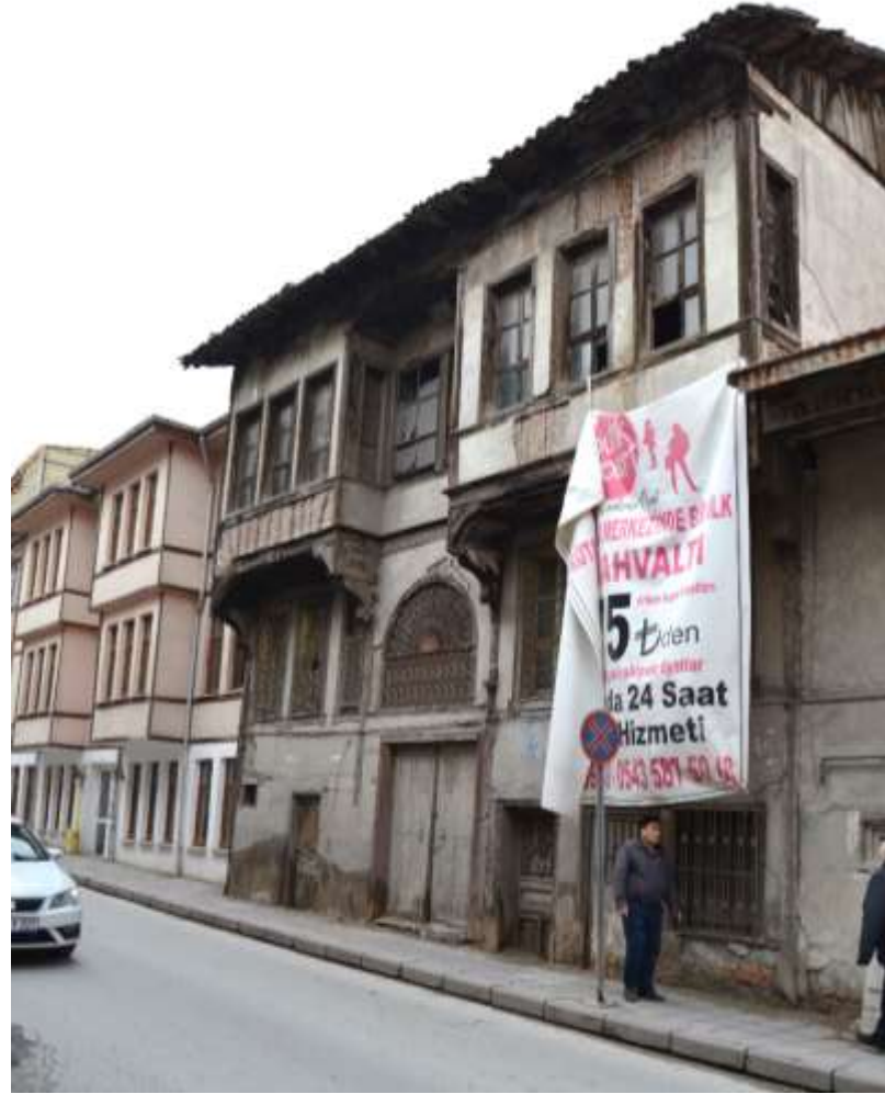
Şekil C. 2. 84 ada 38 parsel konut yapısı çıkma düzeni (Ocak, 2019).
