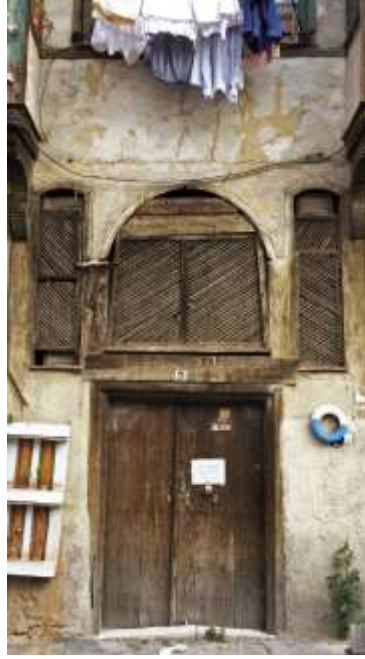
Şekil 4. 8. 141 ada 19 parsel konut yapısı (Eylül, 2018).
