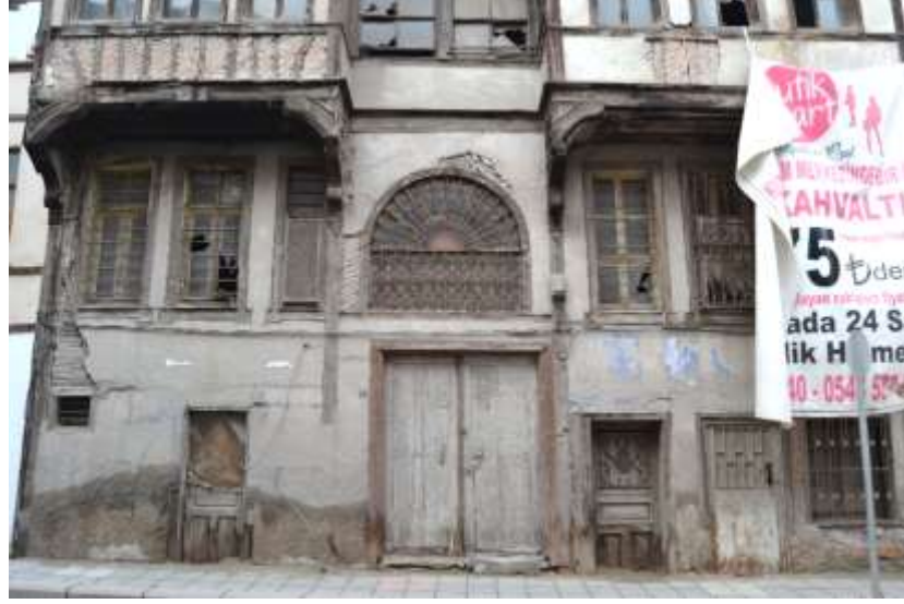
Şekil C. 1. 84 ada 38 parsel konut yapısı giriş cephesi (Ocak, 2019).
