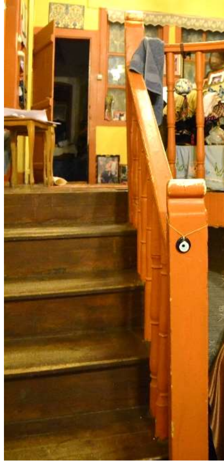
Şekil B. 9. Zemin kat ile fevkâni kat bağlantısını sağlayan merdiven (Eylül, 2018).
