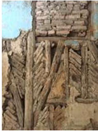
Şekil B. 95. Kütahya Konağı güneybatı cephesi ahşap karkas strüktür dolgu malzemesi olarak harman tuğla kullanılmıştır (Mayıs, 2016).
