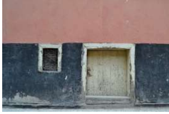
Şekil B. 21. Z-03 numaralı kazan dairesi pencereleri dış görünüş (Ocak, 2019).
