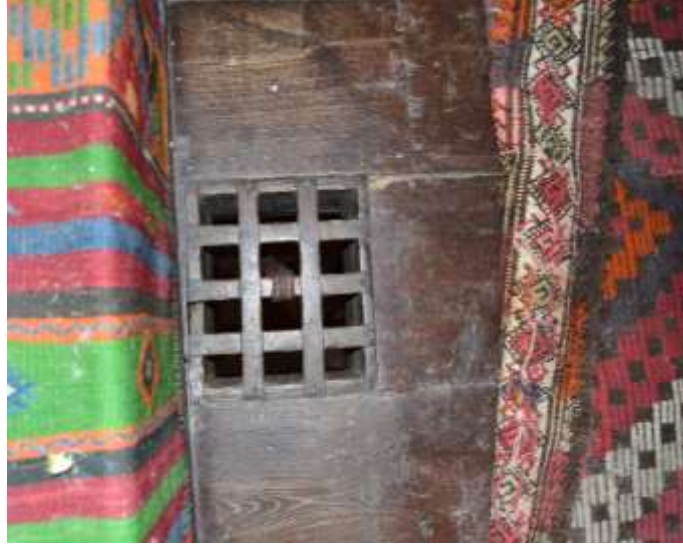
Şekil B. 43. Z-01 numaralı giriş holü ile 2-01 numaralı divanhâne bağlantısını sağlayan ahşap ızgara, ikinci kat döşemesinden görünüş (Eylül, 2018).
