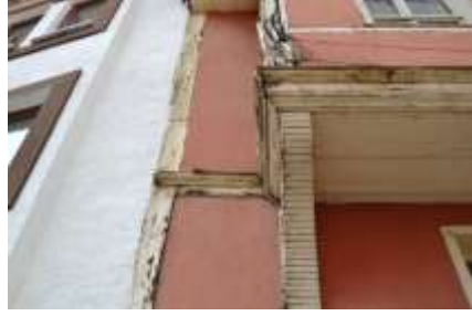
Şekil B. 100. Kütahya Konağı güneydoğu cephesi ahşap kat silmesi (Ocak, 2019).
