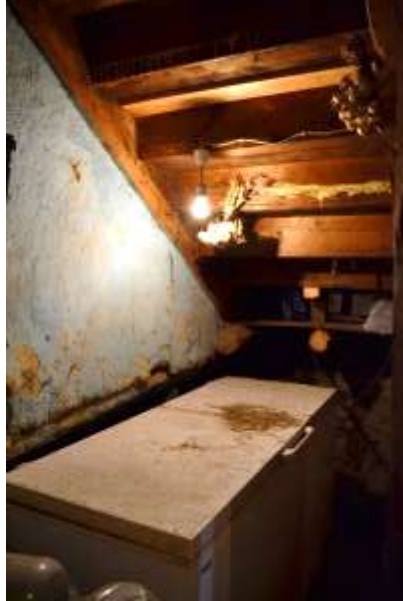
Şekil B. 101. Z-05 numaralı hol kuzeybatı duvarı (Ocak, 2019).
