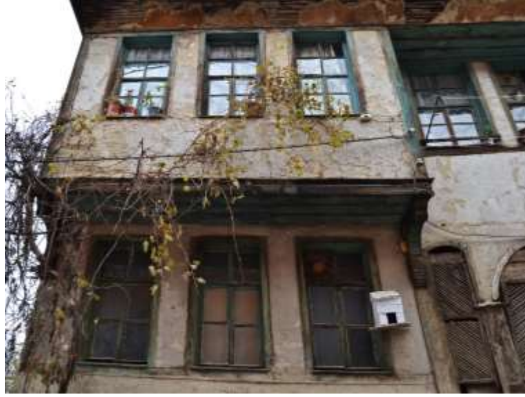
Şekil 4. 7. 141 ada 19 parsel konut yapısı (Ocak, 2019).
