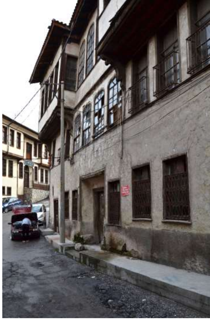
Şekil C. 5. 99 ada 33 parsel konut yapısı giriş cephesi (Ocak, 2019).
