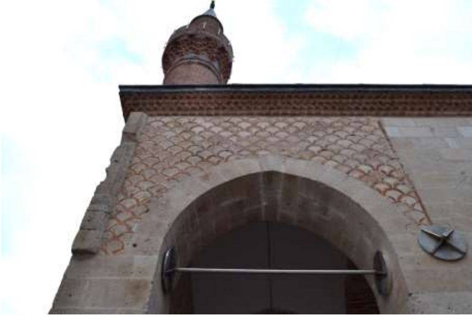
Şekil 2. 29. 2017 yılı onarımında eklenen güçlendirme (Şubat, 2019).
