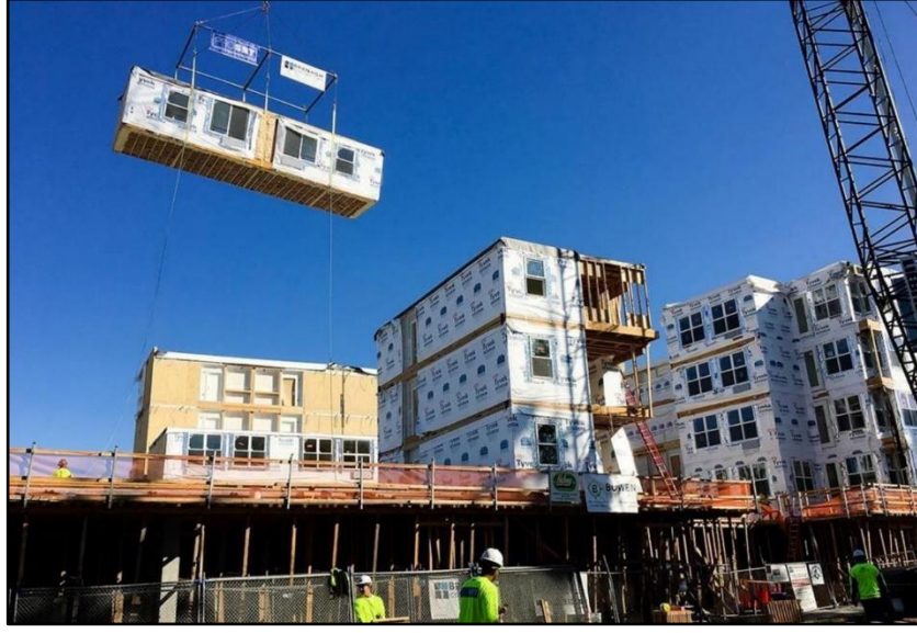
Resim 2-6: Şantiye Sahasında Bir Modülün İstiflenmesi (Littman, 2017).
