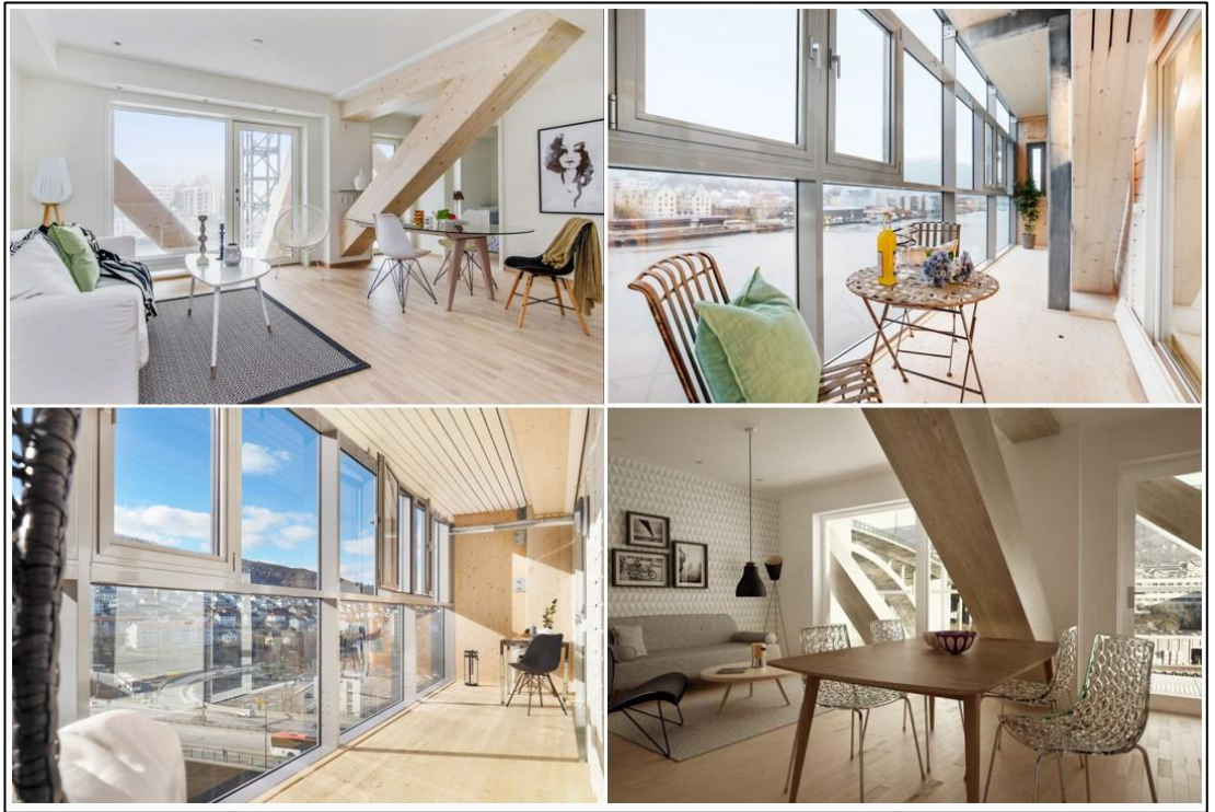
Resim 4-7: Treet Yapısı İç Mekân Görünümü (Sol üstte güç katı dairelerinde treet'in strüktürel niteliği olan ana taşıyıcılar görülmekte) (Url-39), (Url-40).
