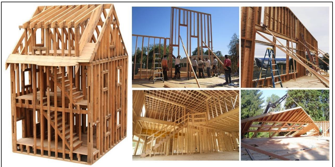
Resim 2-3: Balon Çerçeve Sistem Yapımı Örneği (Url-5).
