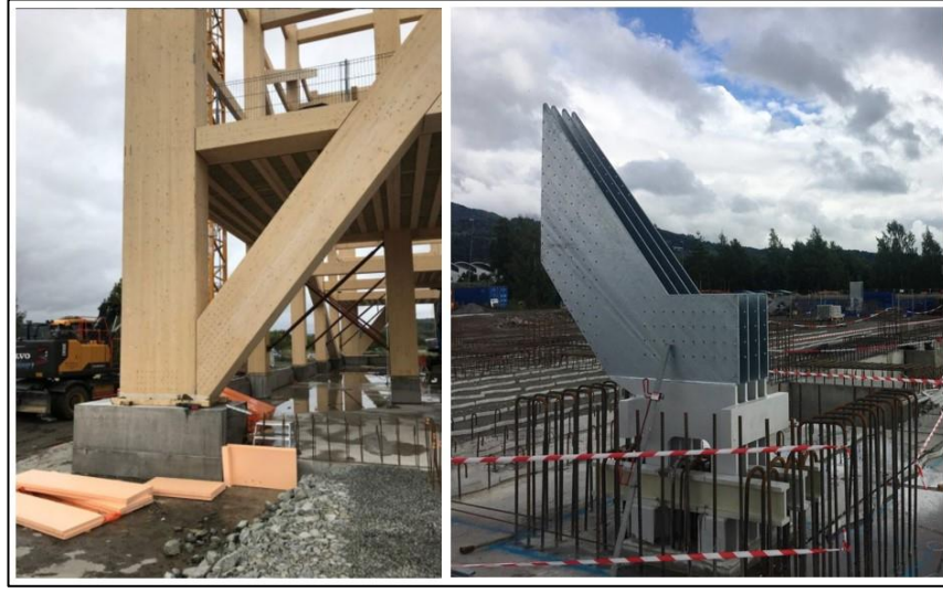
Resim 4-22: Mjøstårnet Yapısı Çelik Bağlantıları (Url- 45), (Url- 46).
