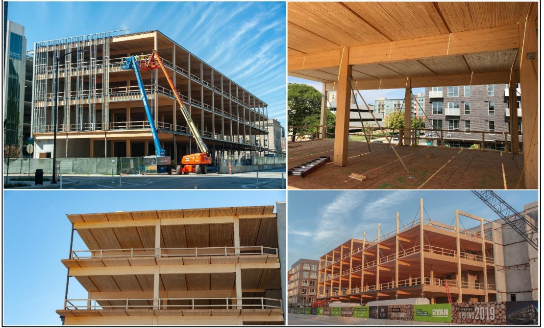
Resim 3-41: 111 East Grand Yapısı İnşa Aşaması (Url-33).
