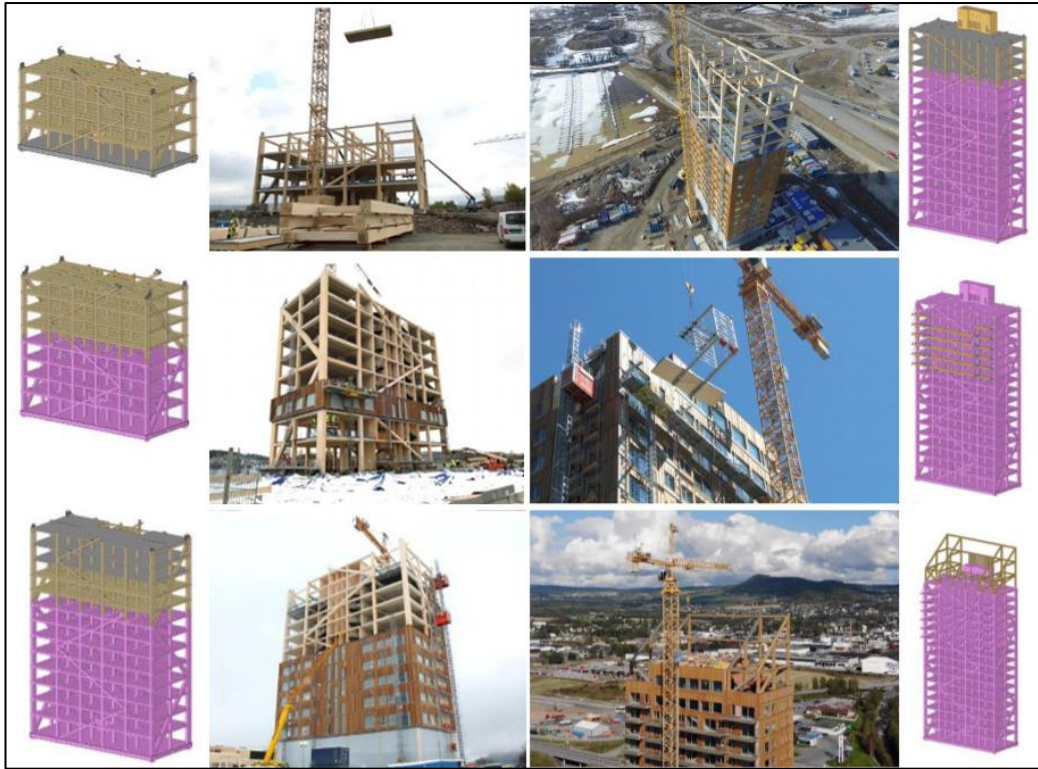
Şekil 4-18: Mjøstårnet Yapım Aşamaları (Abrahamsen, 2018).
