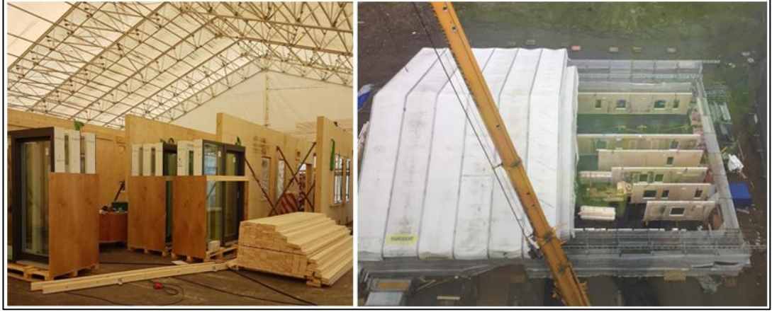
Resim 4-17: Montaj Çadırı ve Geçici Çatı (Tiainen, 2019).
