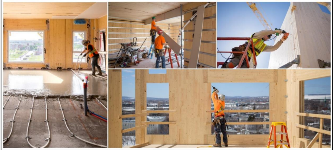
Resim 4-10: Isıtma, elektrik ve tesisat bağlantıları montajları (Cecobois, 2018).
