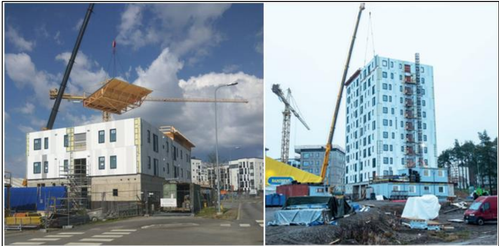
Resim 4-18: Lighthouse Yapısı Yapım Aşaması (Tiainen, 2019).
