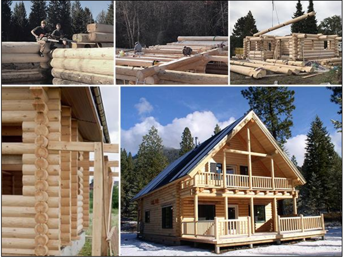
Resim 2-1: Kütük yığma sistem örneği (Url-2).
