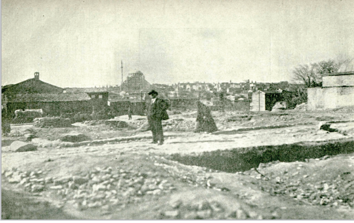
Şekil 12. Semiz Ali Paşa Medresesi'nden Edirnekapı'ya yol çalışması (Mecmua, 1929)
