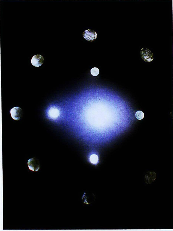
Res. 34: Hamamın sıcaklık kubbesindeki ışık gözleri.
