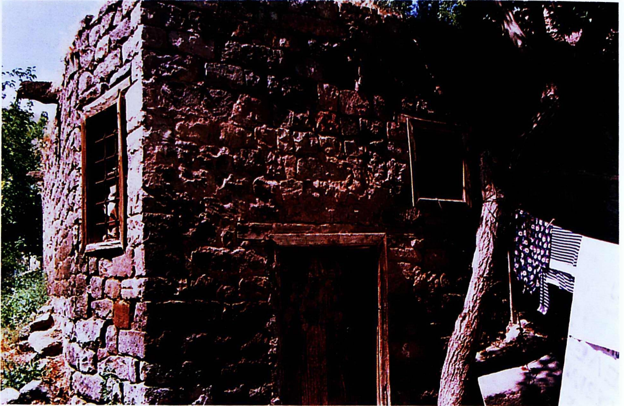
Res.54: Han'ın arka cephesinden görünüm (doğu cephesi).
