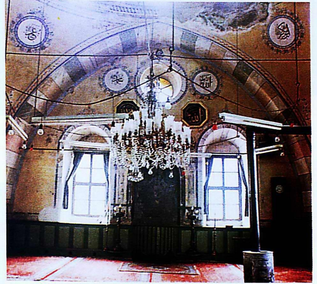
Res. 24: Harimin güney cephesinin içten genel görünüşü.
