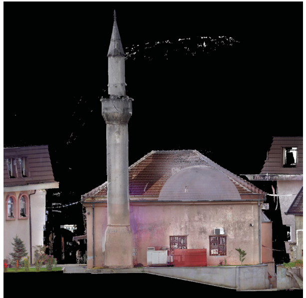
Şekil 2. Emir Alaaddin Camisi ölçüm datalarından elde edilen ortofoto, batı cephe (AY-MİR Mimarlık Müh. Ltd. 2015).
