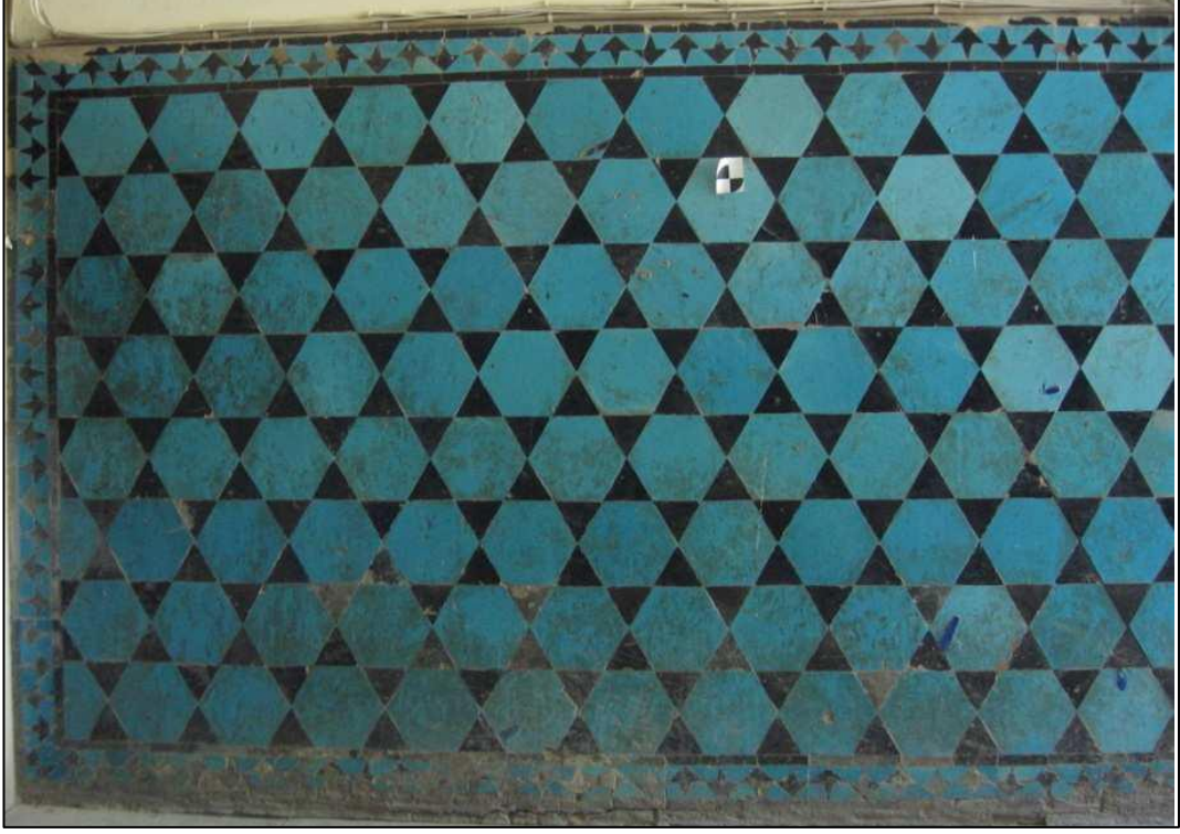
R. 34: Bursa Yeşil Camii Batı Şahnişi Duvarındaki Çiniler
