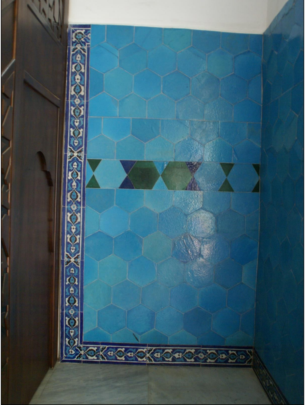
R. 56: Bursa Muradiye Camii Mihrap Duvarında Minberin Batı Tarafında Kalan Çiniler
