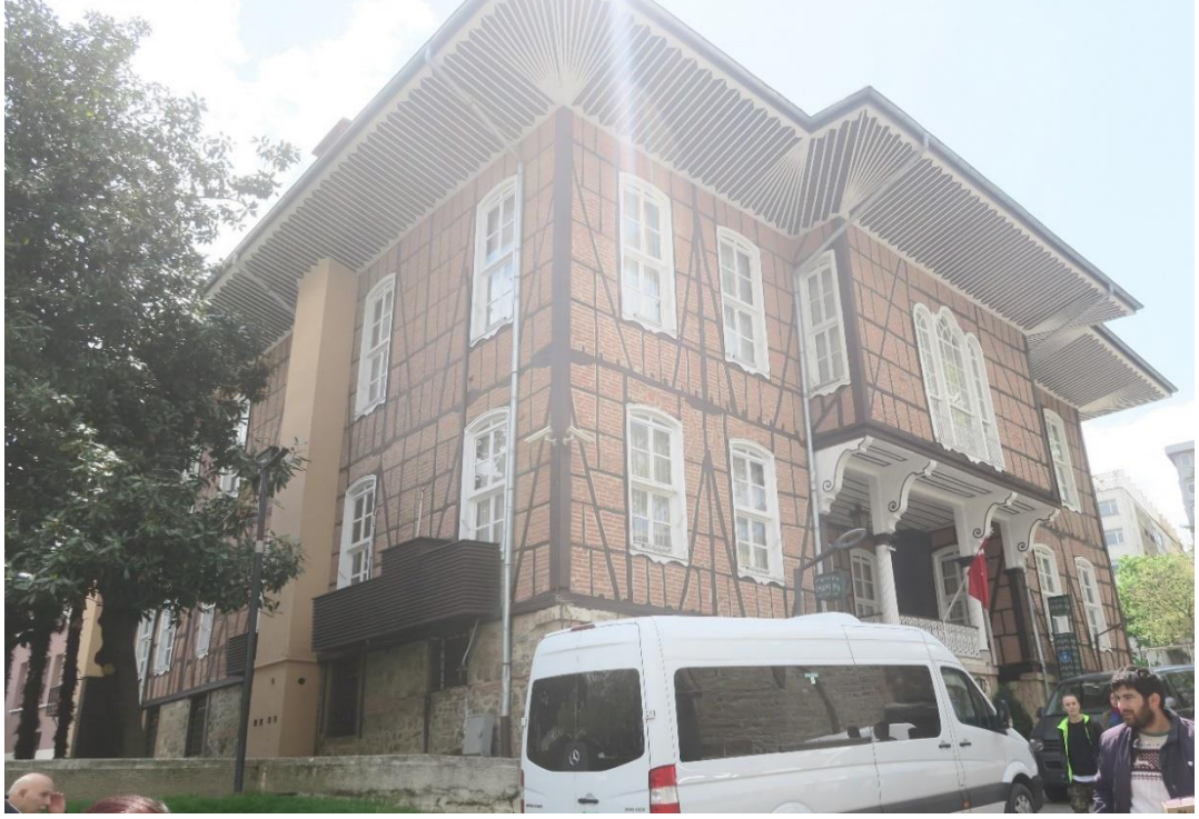
Şekil 2.9: Ahmet Vefik Paşa Dönemi Tarihi Belediye Binası (2019)
