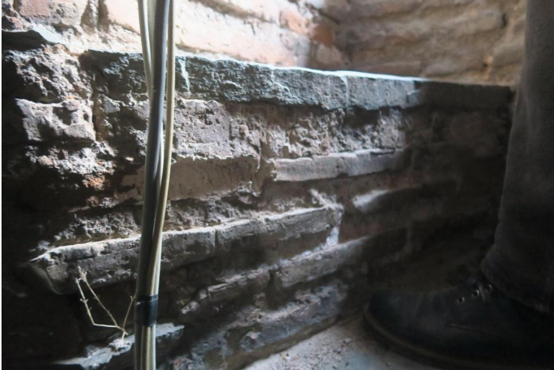
Şekil 5.40 : Doğu Minaresi Merdiven Basamağı (2019)
