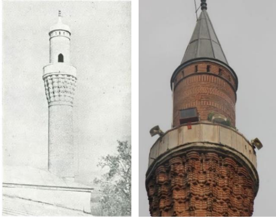
Şekil 5.18 : Minarede Miğfer Kühah (Ayverdi,1966)- Kurşun Kühah (2019)
