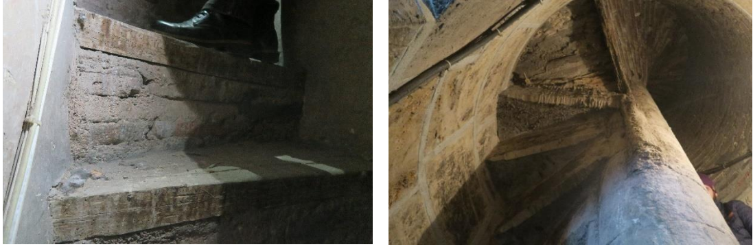
Şekil 5.27 : Ulu Cami Minare Basamağı - Ulu Camii Minare Çekirdeği (2019)
