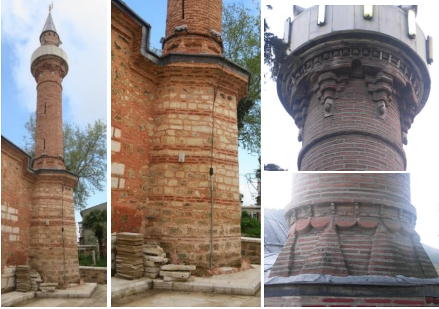
Şekil 5.7 : Alaaddin Camii Minaresinin Kaide, Küp, Gövde ve Şerefesi (2019)
