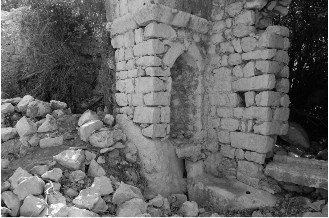
Şekil C. 54. Naosun kuzeybatı köşesindeki paye (Solda batı haç kolunun kuzey duvarı; sağda kuzey haç kolunun batı duvarı üzerindeki kemerli niş), 2010 (©BOGA Arşivi).
