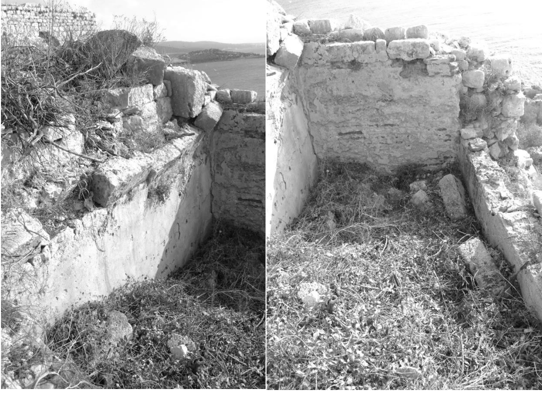
Şekil C. 27. Güney Sarnıç'ın içerisindeki hidrolik sıvalı tuğla duvar örgüsü ve korunan tonoz blokları, 2017 (©BOGA Arşivi).
