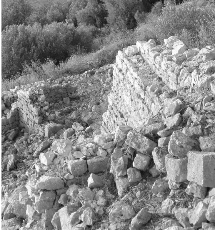
Şekil C. 30. Güney Sarnıç'ın doğu görünüşü, 2017 (©BOGA Arşivi).
