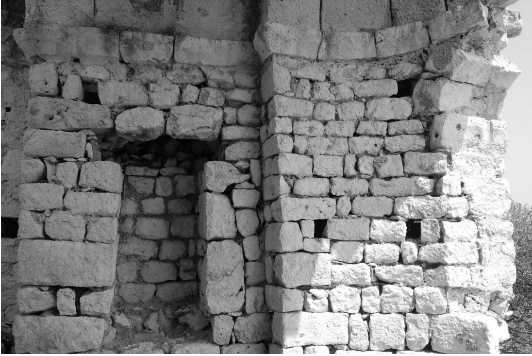
Şekil C. 59. Doğu haç kolunun kuzey duvarı üzerindeki düz atkılı niş. Sağda apsis penceresine ait üç adet kesme taş blok görülebilir, 2010 (©BOGA Arşivi).
