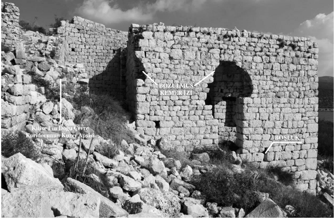
Şekil C. 41. Yapının güney cephesi, 2017 (©BOGA Arşivi).
