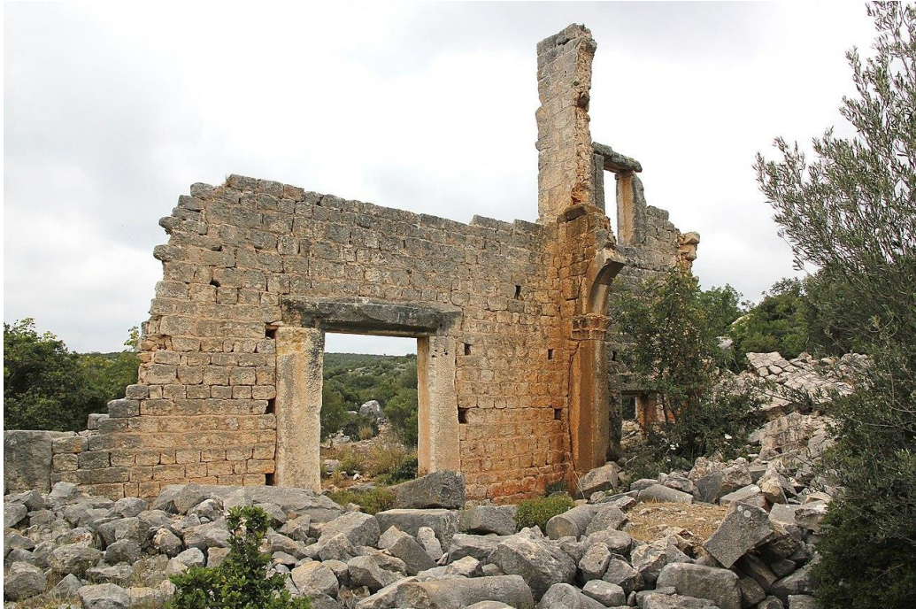
Şekil D. 18. Çatıören Kilisesi'nin naosunun batı duvarı, 2016 (e.t.: 11.03.19, e.a.: https://commons.wikimedia.org/wiki/Category:%C3%87at%C4%B1%C3%B6ren#/media/File:%C3%87at%C4%B1%C3%B6ren07.jpg ).
