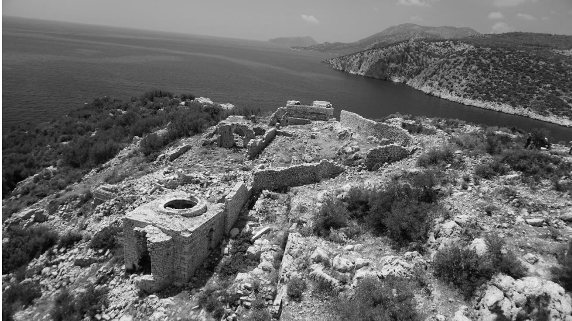
Şekil C. 2. Yapı grubuna doğudan bakış, 2017 hava fotoğrafı (Fotoğraf: Medet Elmalı, ©BOGA Arşivi).
