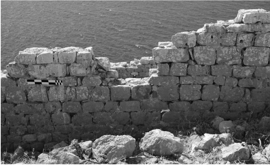
Şekil C. 36. Naosun kuzey duvarının kuzeyden görünüşü, Kilise 1'in kuzey cephesi (orta bölümü), 2017 (©BOGA Arşivi).
