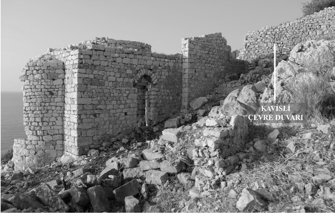
Şekil C. 40. Yapının kuzey cephesi. Soldan sağa doğru apsis, naos ve narteks, 2013 (©BOGA Arşivi).
