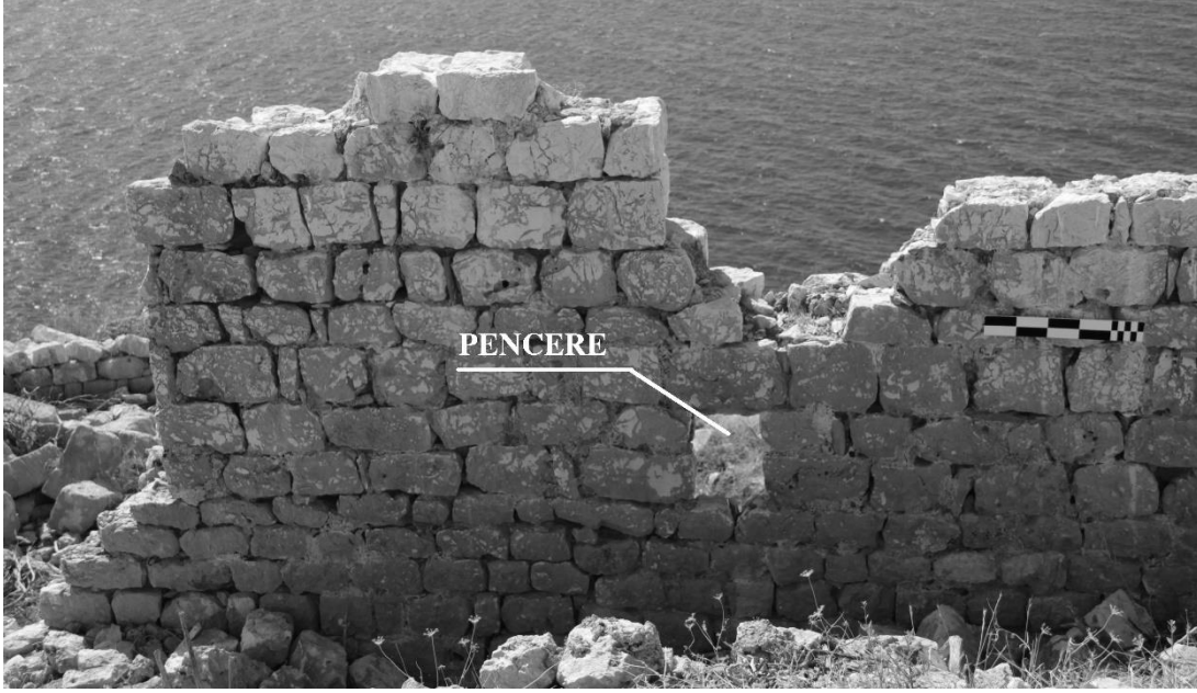
Şekil C. 35. Naosun kuzey duvarının kuzeyden görünüşü, Kilise 1'in kuzey cephesi (doğu bölümü), 2017 (©BOGA Arşivi).
