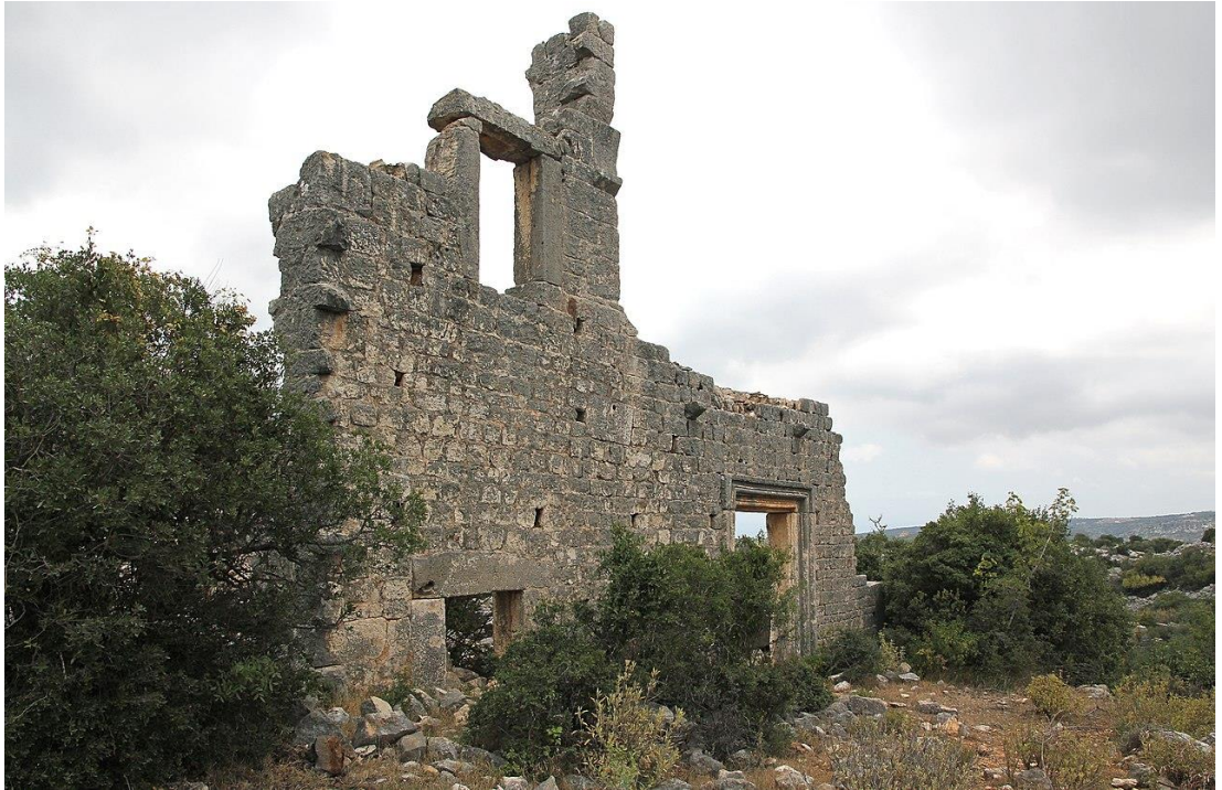
Şekil D. 10. Çatıören Kilisesi'nin narteksinin doğu duvarı, 2016 (e.t.: 11.03.19, e.a.: https://commons.wikimedia.org/wiki/Category:%C3%87at%C4%B1%C3%B6ren#/media/File:%C3%87at%C4%B1%C3%B6ren03.jpg ).
