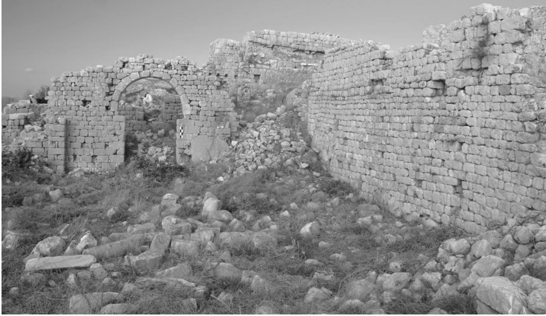
Şekil C. 13. Naosun batı duvarı ve kuzeybatı köşesi, 2017 (©BOGA Arşivi).
