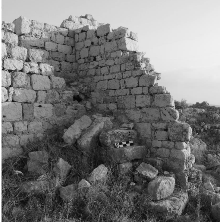
Şekil C. 67. Güney cephesine dik konumlanan duvar ve “L” planlı merdivenin ilk altı basamağı, 2017 (©BOGA Arşivi).
