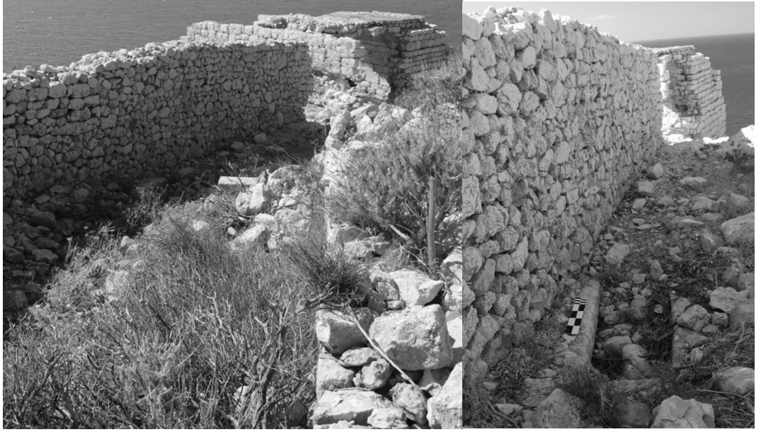
Şekil C. 78. Solda duvarın kuzeyden görünüşü ve Büyük Sarnıç ile ilişkisi. Sağda duvara bitişik konumlanan mezar, 2017 (©BOGA Arşivi).
