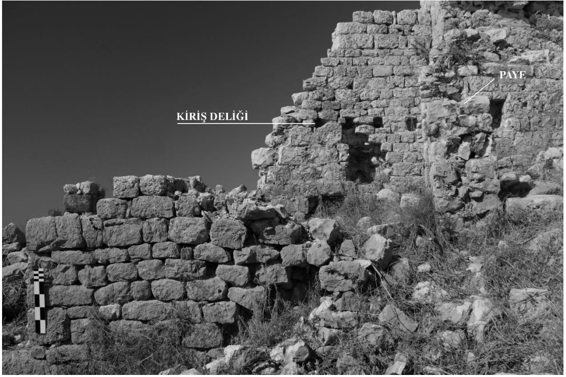
Şekil C. 10. Narteksin batı duvarının kuzey yönü ve arkada Büyük Sarnıç'ın doğu cephesi, 2017 (©BOGA Arşivi).
