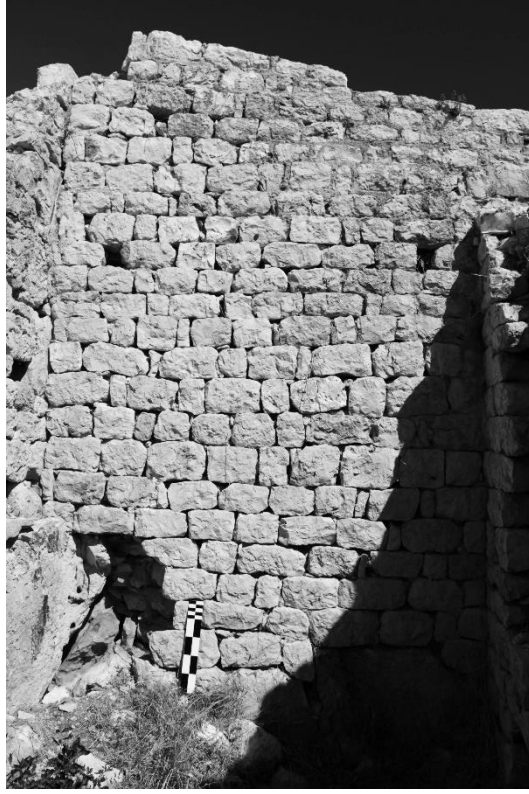
Şekil C. 47. Narteksin kuzey duvarı, 2017 (©BOGA Arşivi).
