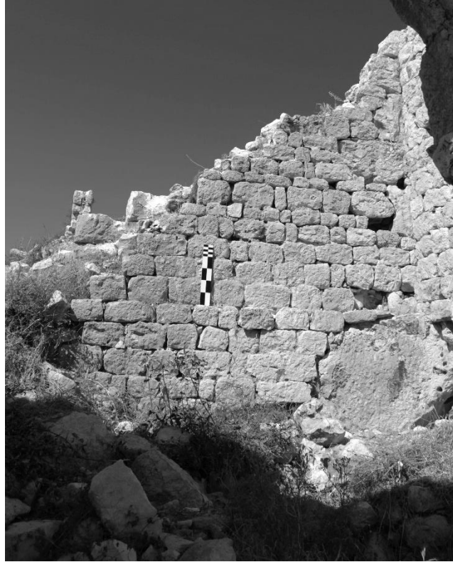
Şekil C. 46. Narteksin batı duvarı, 2017 (©BOGA Arşivi).
