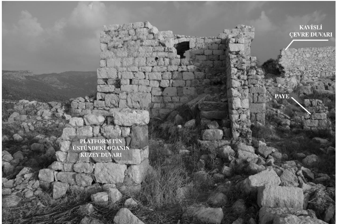
Şekil C. 66. Yapının güney cephesi, 2017 (©BOGA Arşivi).
