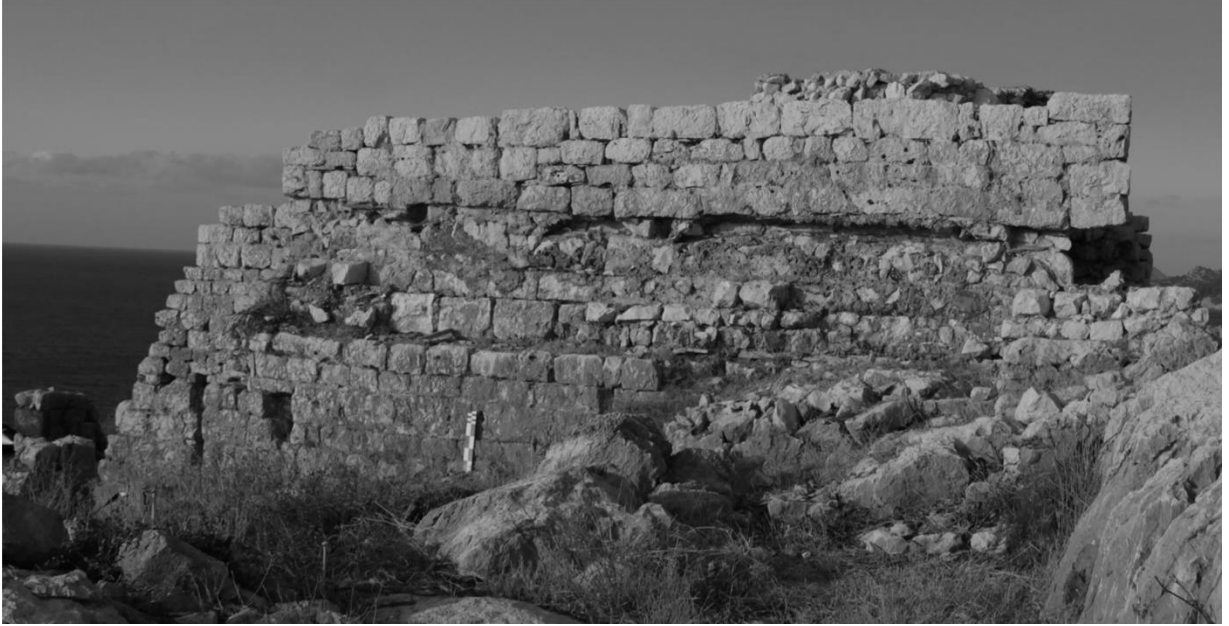
Şekil C. 68. Yapının doğu cephesi, 2017 (©BOGA Arşivi).
