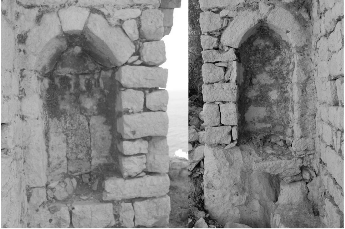
Şekil C. 62. Sırasıyla Kuzey haç kolunun doğu ve batı duvarları üzerindeki nişler, 2010 (©BOGA Arşivi).
