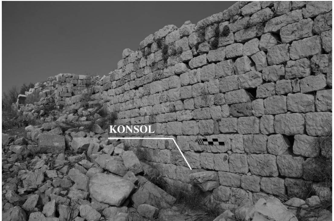
Şekil C. 26. Güney nefin güney duvarı üzerindeki konsolun yandan görünüşü, 2017 (©BOGA Arşivi).
