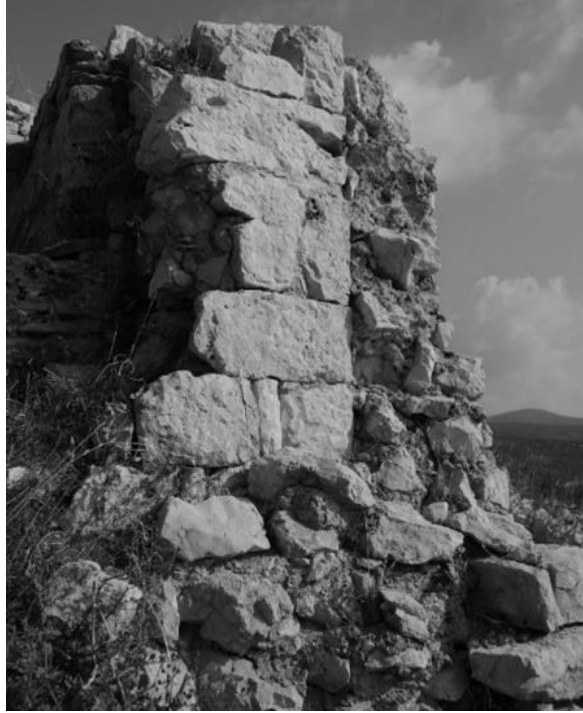
Şekil C. 81. Güney Sarnıç'ın güçlendirilmiş doğu duvarı, 2017 (©BOGA Arşivi).
