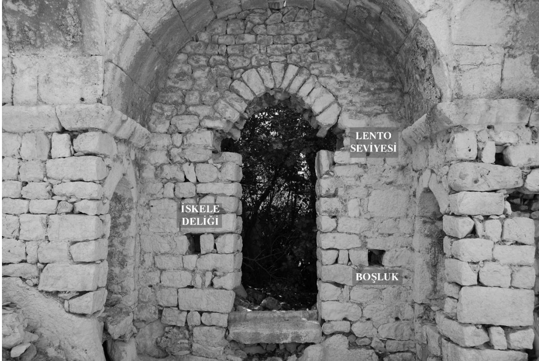
Şekil C. 52. Kuzey haç kolunun kuzey duvarı, 2010 (©BOGA Arşivi).
