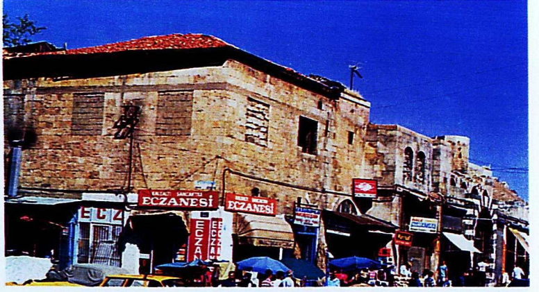
Res. 8: Gaziantep Millet Hanı, doğu cephe.
