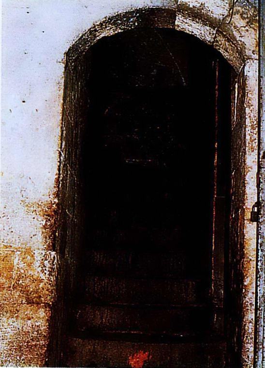
Res. 21: Gaziantep Belediye Hanı, batı avlu geçidindeki merdiven.
