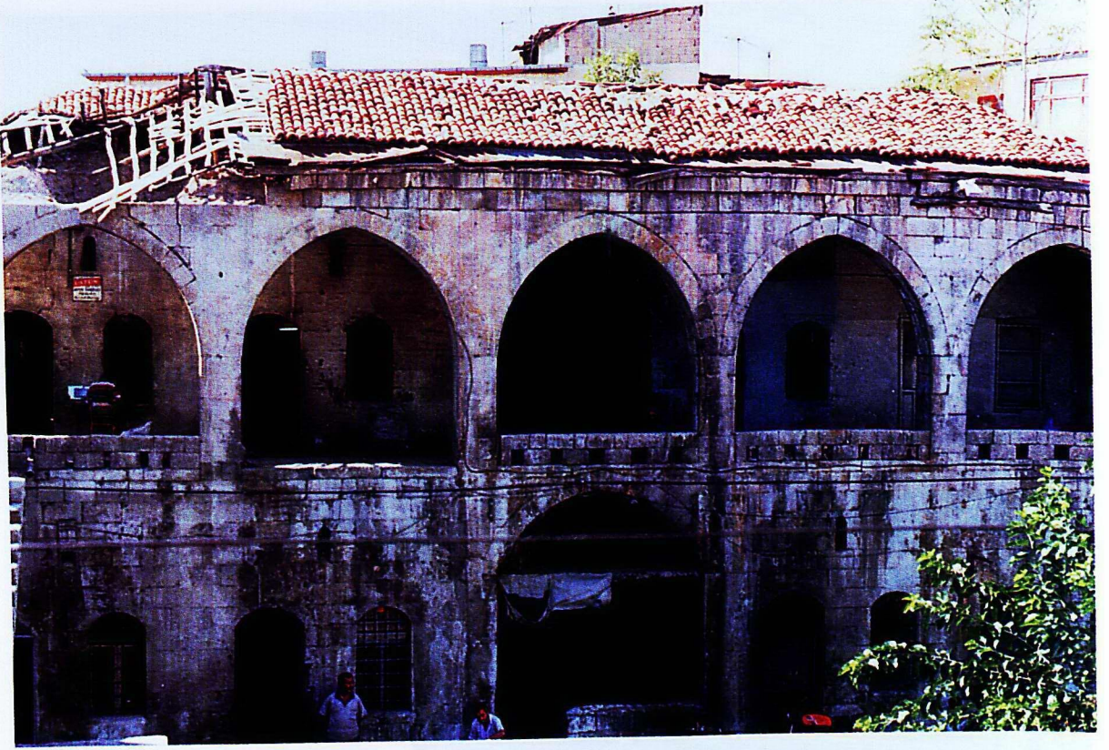
Res. 12: Gaziantep Millet Hanı avlunun güney kanadı.
