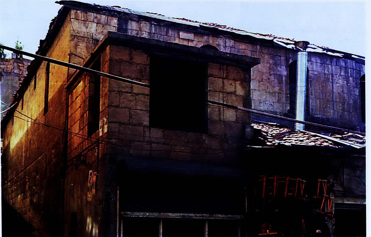
Res. 2: Gaziantep Yüzükü Hanı, kuzey ve batı cepheden görünüş.
