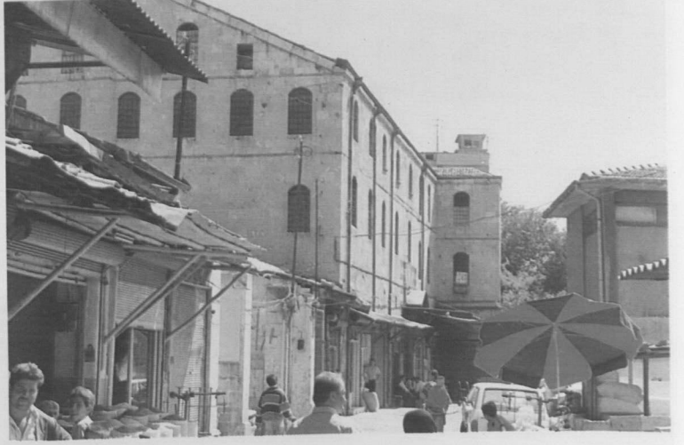
Res. 37: Gaziantep Kürkçü Hanı, sabunhanenin batı ve güney cepheleri.
