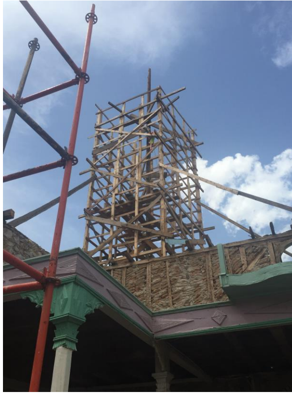
Şekil 4.20 Ahşap Minare direği, 2016
