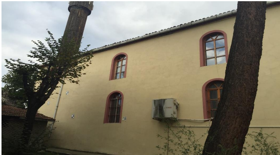
Şekil 4.21 Batı Cephesi Görünüşü, 2015
