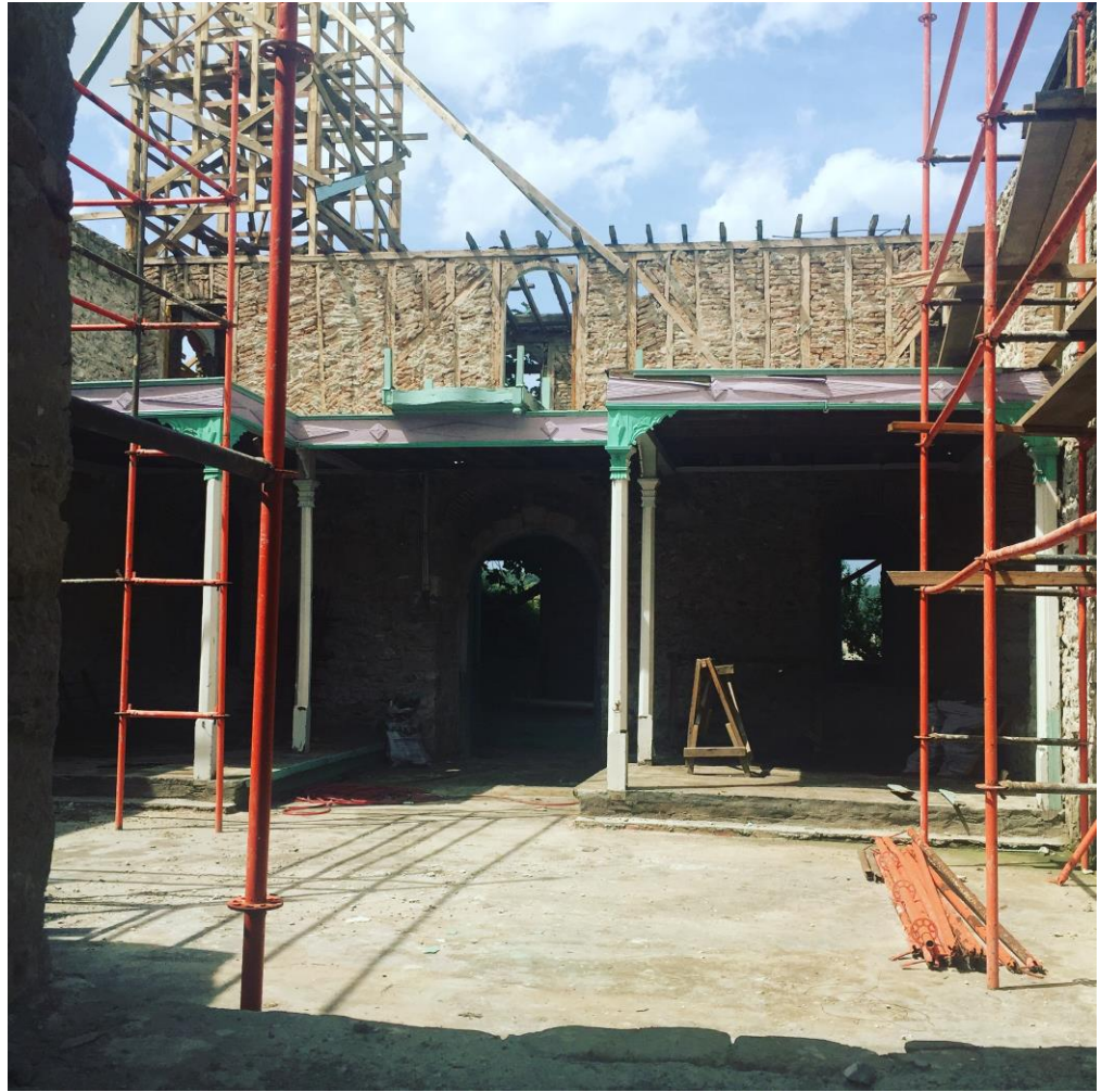
Şekil 4.15 Kadınlar Mahfili Taşıyıcı Ahşap Dikmeler (Raspa sonrası), 2016
