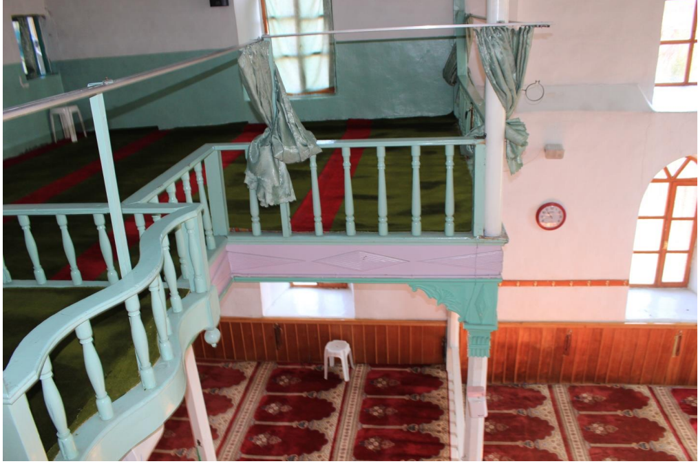
Şekil 4.14 Kadınlar Mahfili Taşıyıcı Ahşap Dikmeler, 2015
