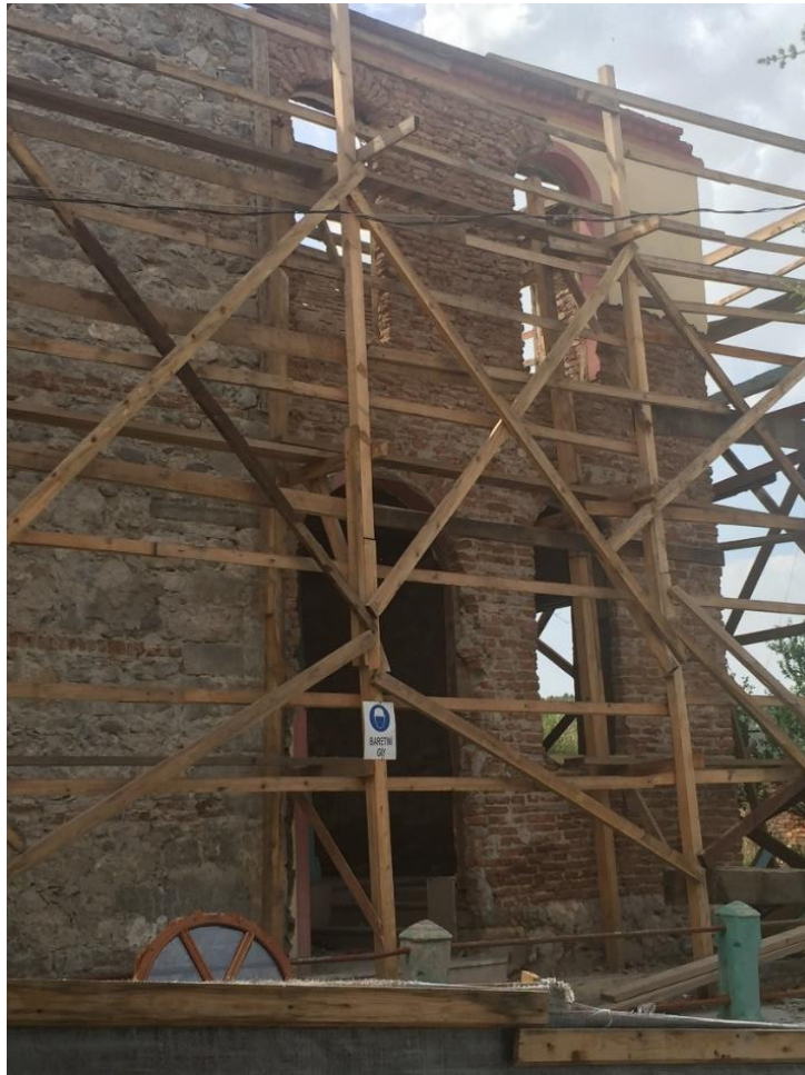
Şekil 4.28 Doğu Cephesi Giriş Bölümü (Raspa sonrası), 2016
