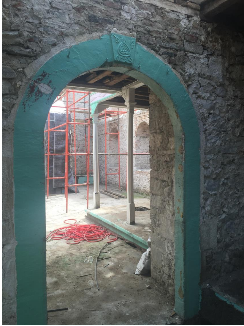
Şekil 4.7 Harim giriş açıklığı (Raspa sonrası), 2016
