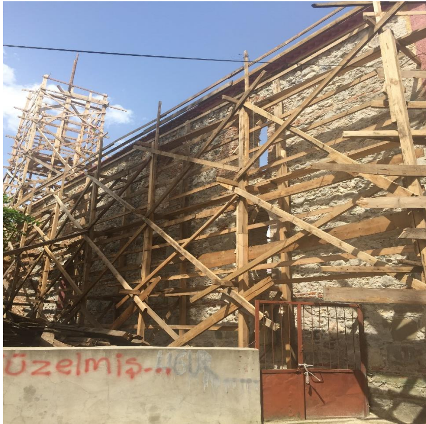
Şekil 4.23 Batı Cephesi Raspa Sonrası, 2016
