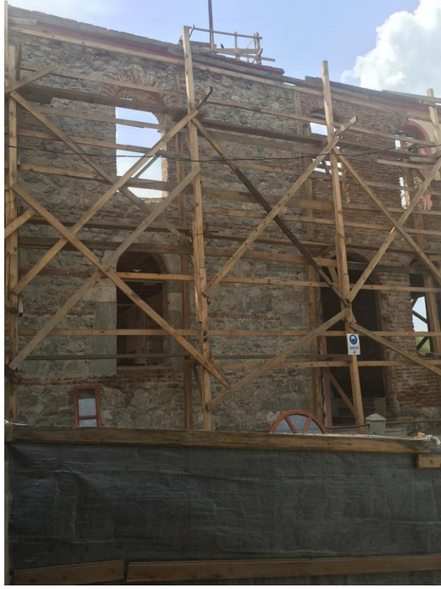
Şekil 4.40 Doğu cephesi Duvar Örgüsü Raspa sonrası, 2016
