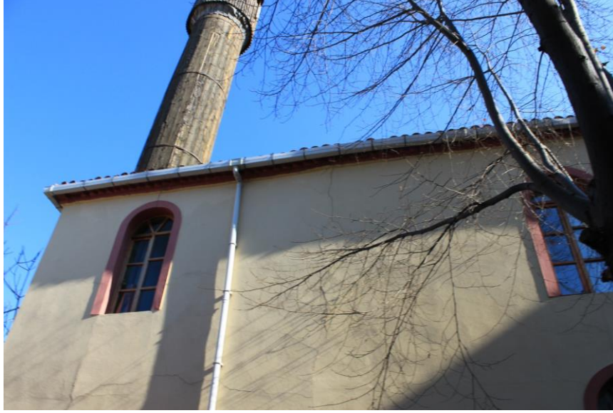
Şekil 4.22 Batı Cephesi Minare Köşesi, 2015
