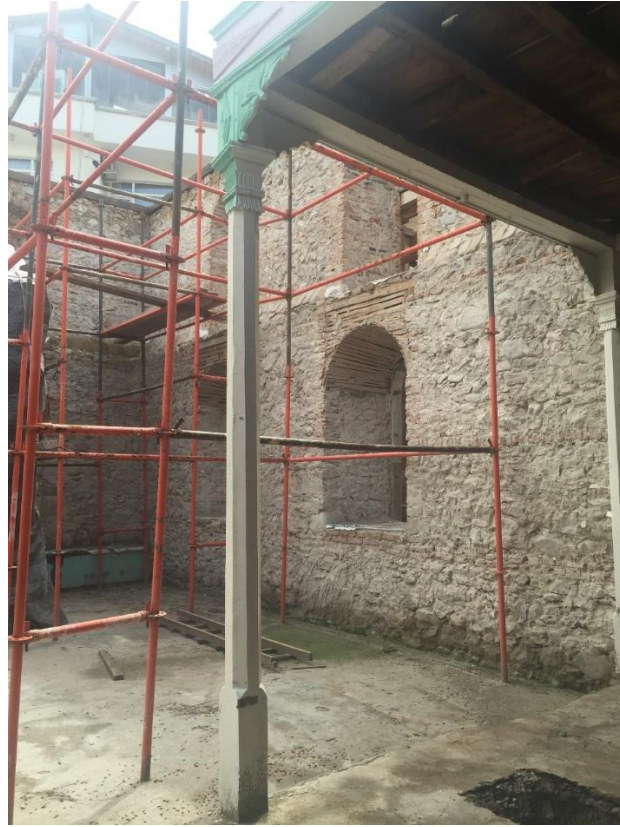
Şekil 4.25 Batı Cephesi iç kısım Görünüşü (Raspa sonrası), 2015
