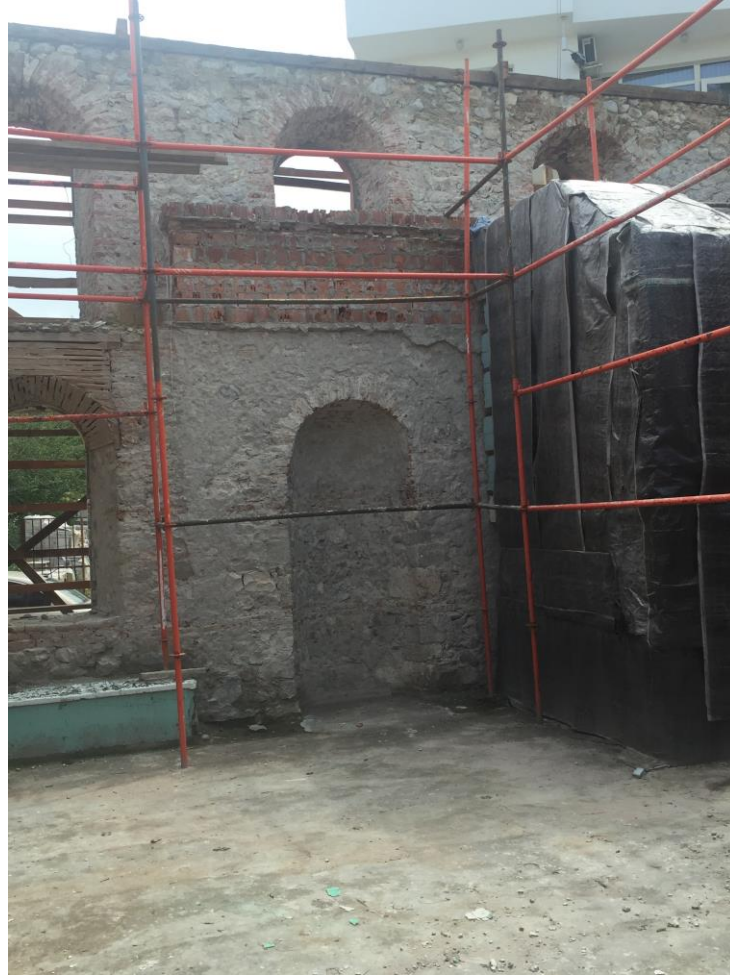
Şekil 4.35 Güney Cephesi Görünüş iç kısım (Raspa sonrası), 2016
