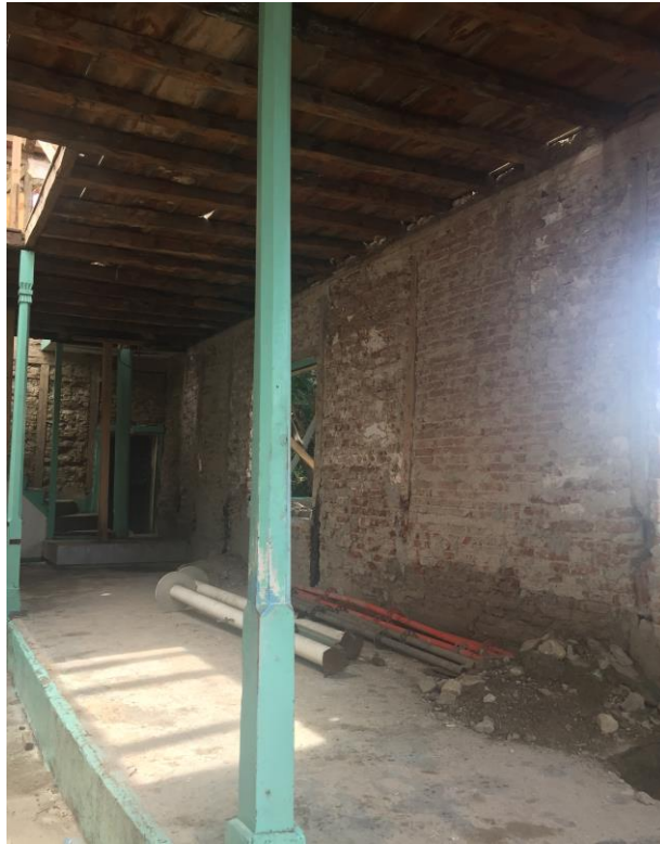
Şekil 4.31 Kuzey Cephesi Görünüşü iç kısım (Raspa sonrası), 2016
