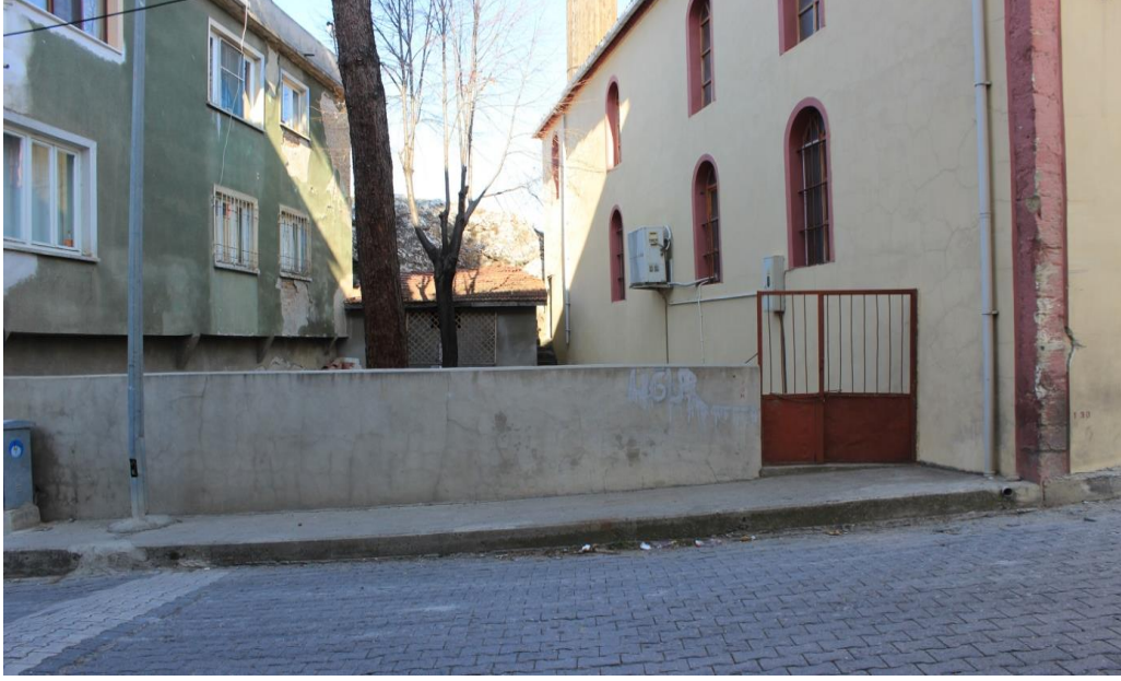
řekil 4.2 Kaya Camii Bahe kısmı, 2015
