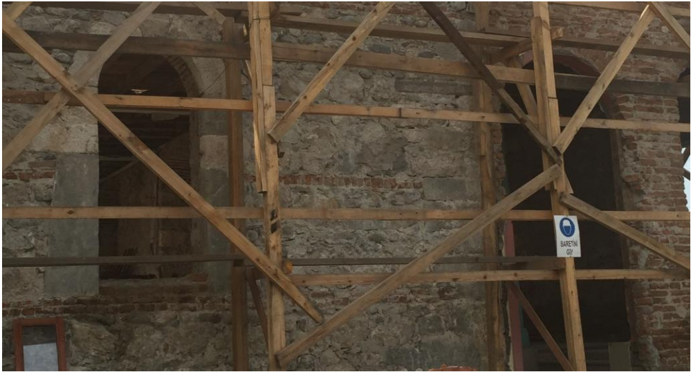
Şekil 5.8 almasıık duvar örgü sistemi ( cami giriş kapısı), 2016
