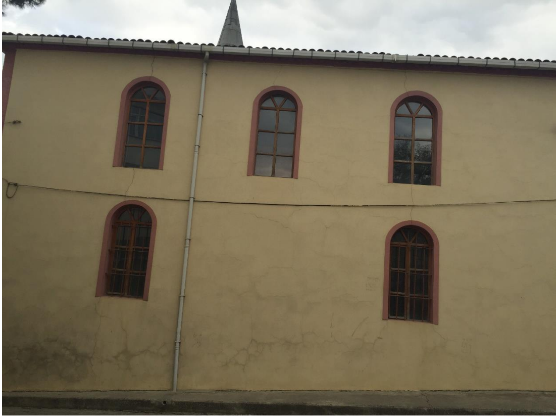
Şekil 4.33 Güney Cephesi Görünüşü, 2015
