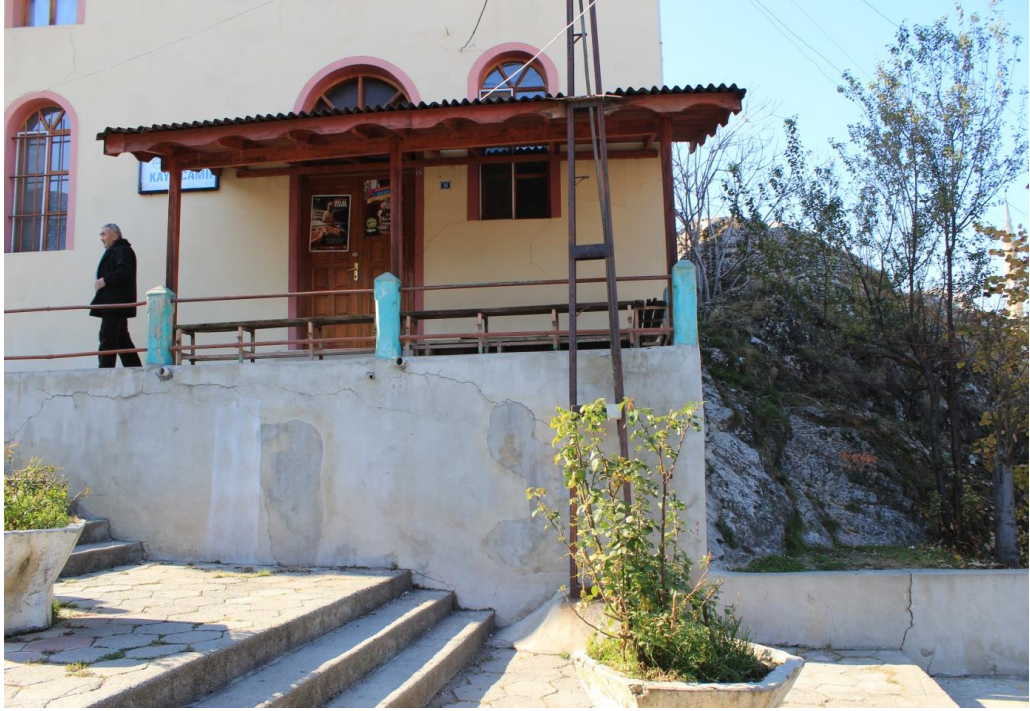
Şekil 4.27 Doğu Cephesi Giriş Bölümü, 2015
