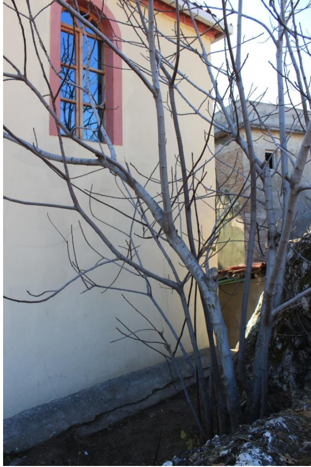
Şekil 4.30 Kuzey Cephesi Görünüşü, 2015
