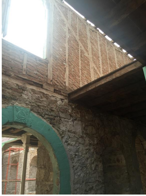
Şekil 5.7 farklı dönem duvar örgü sistemi ( harim giriş kapısı), 2016
