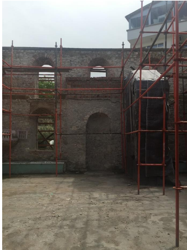
Şekil 4.38 Harim Bölümü Raspa sonrası, 2016
