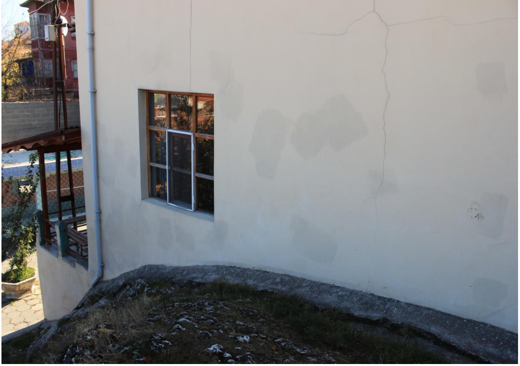
Şekil 4.32 Kuzey Cephesi muhdes Pencere, 2015
