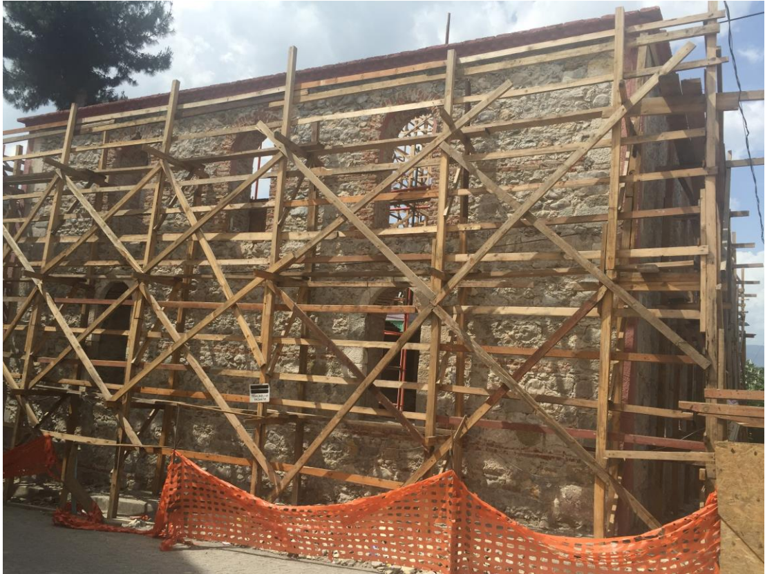
Şekil 4.34 Güney Cephesi Görünüşü (Raspa sonrası), 2016
