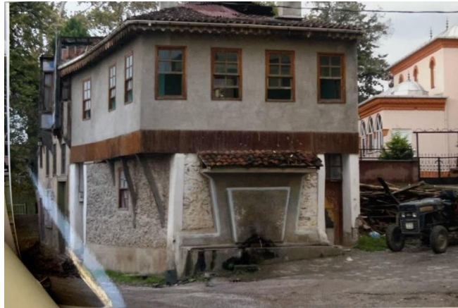
Şekil 4.20: Günümüze ulaşmayan eşme yapısı 6
