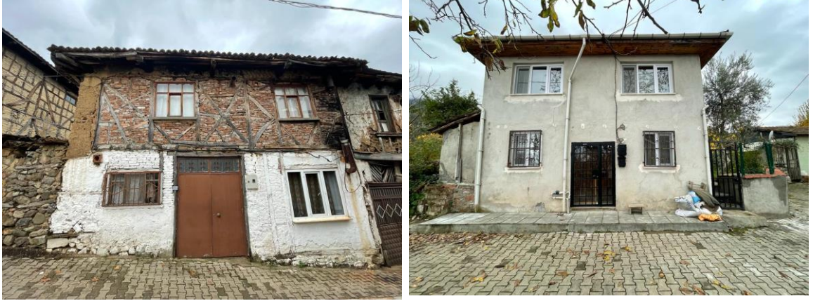
Şekil 5.6: Değiştirilen giriş kapısı, boyutu değiştirilen pencereler ve özgün olmayan malzeme değişimleri (C. Ş. Ekmen Arşivi,2023).
