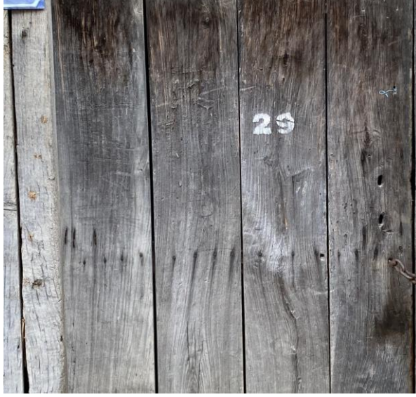
Şekil 5.14: Böceklerin ahşap malzemeye etkisini gösteren örnek (C. Ş. Ekmen Arşivi,2023).
