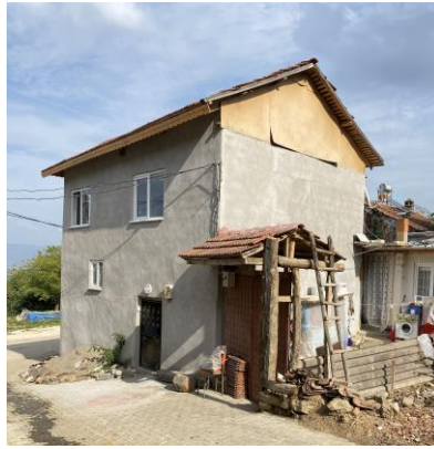
Şekil 5.10: Geleneksel konut yapılarında çimento sıva uygulaması örneği (C. Ş. Ekmen Arşivi,2023).
