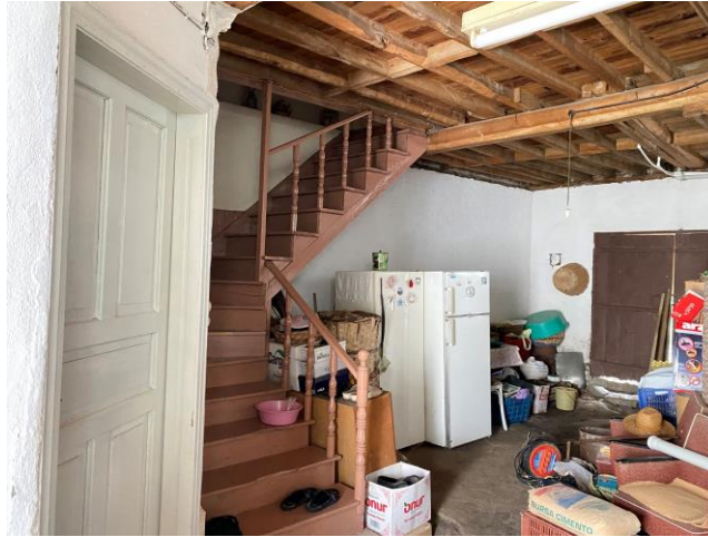
Şekil 5.12: Geleneksel konut yapısında bulunan merdivene uygulanan boya müdahalesi (C. Ş. Ekmen Arşivi,2023).
