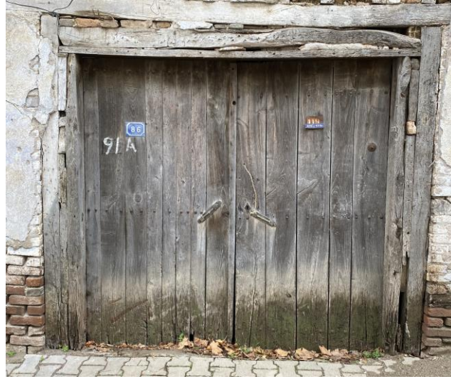
Şekil 5.13: Nem ve rutubetin ahşap kapıya etkisini gösteren örnek (C. Ş. Ekmen Arşivi,2023).
