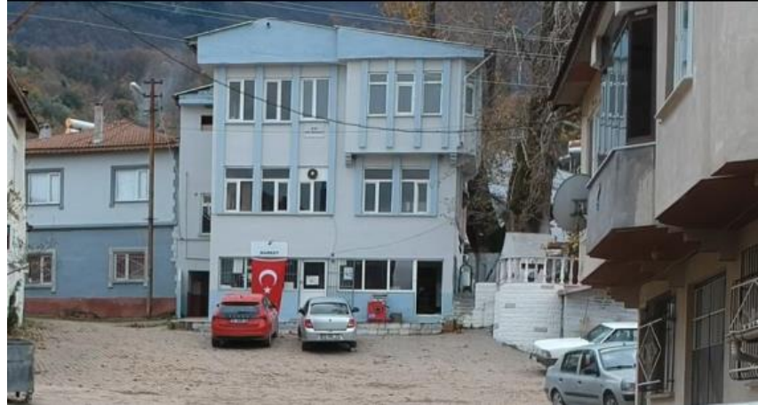
Şekil.4.22: Muhtarlık binası (C. Ş. Ekmen Arşivi,2023).
