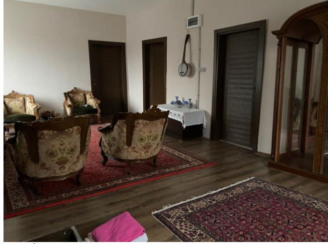
Şekil 5.11: İç kapı ve döşeme malzemesinin özgün olmayan malzeme ile değiştirilmesi (C. Ş. Ekmen Arşivi,2023).
