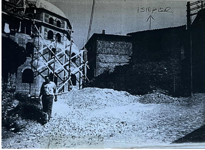
Şekil 4.17: 1982 yılında çekilmiş cami inşaatı 5
