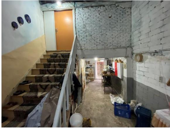
Şekil 5.3: Muhdes duvar ekleri ile ikiye bölünen geleneksel konut yapısı (C. Ş. Ekmen Arşivi,2023).
