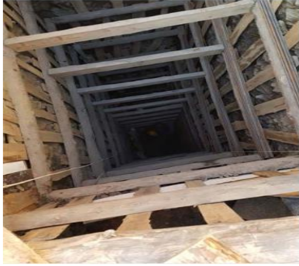
Şekil 1. 7: Kuyu Tipi Duvar Yöntemi
