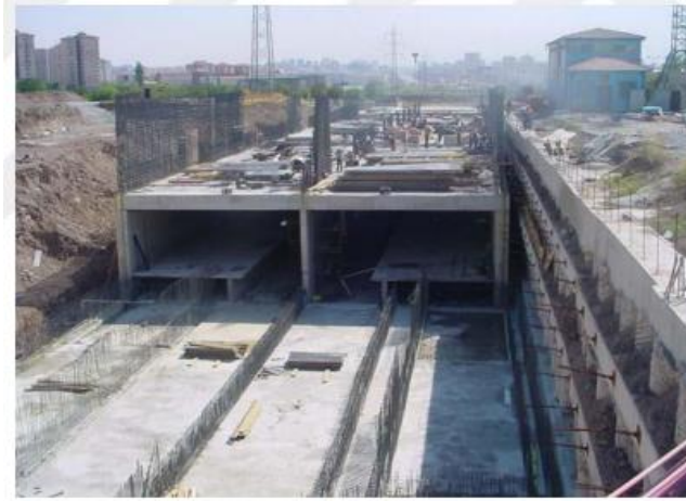
Şekil 1. 6: Aç-Kapa Kazı Yöntemi[4]
