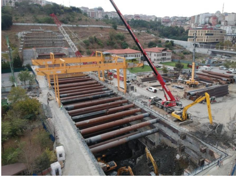
Şekil 2. 13: Gergili destek yapı örneği[18]
