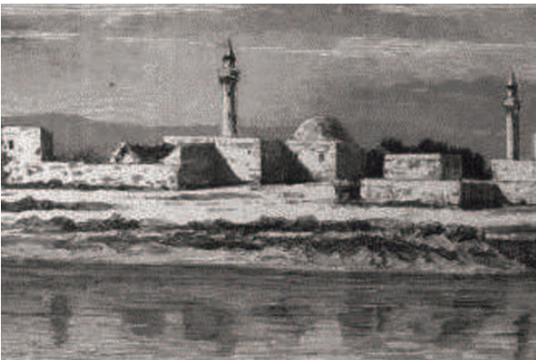
Fotoğraf 27a. Zeylâ'da muhtemel kare mekânlı dendanları olmayan Osmanlı türbe örneği http://i.ebayimg.com/00/s/OTYwWDEyODA=/z/qiUAAOSwRLZT6h97/$_57.JPG
