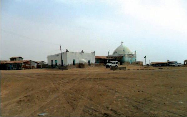
Fotoğraf 5. Şeyh İbrahim Türbesi kuzeydoğu görünüşü.
