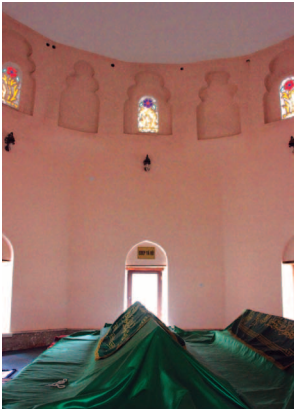
Fotoğraf 35a. Ankara'da Karacabey Türbesi kubbe eteğinde görülen dilimli ve sıralı nişler ( http://www.mustafacambaz.com/details.php?image_id=34855 ; 28.03.2015).
