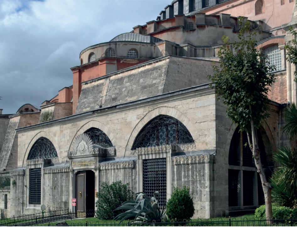
Resim 1 Ayasofya Hünkâr Kasrı'nın dış cephesinden görünüm
