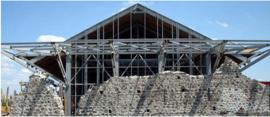
Şekil 96. Kazıklı Kervansarayı Restorasyon Aşamaları (url-47)
