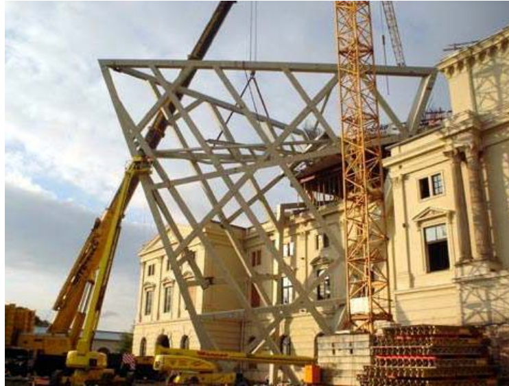
Şekil 205. Dresden Müzesi Ek Yapım Aşaması (url-85)
