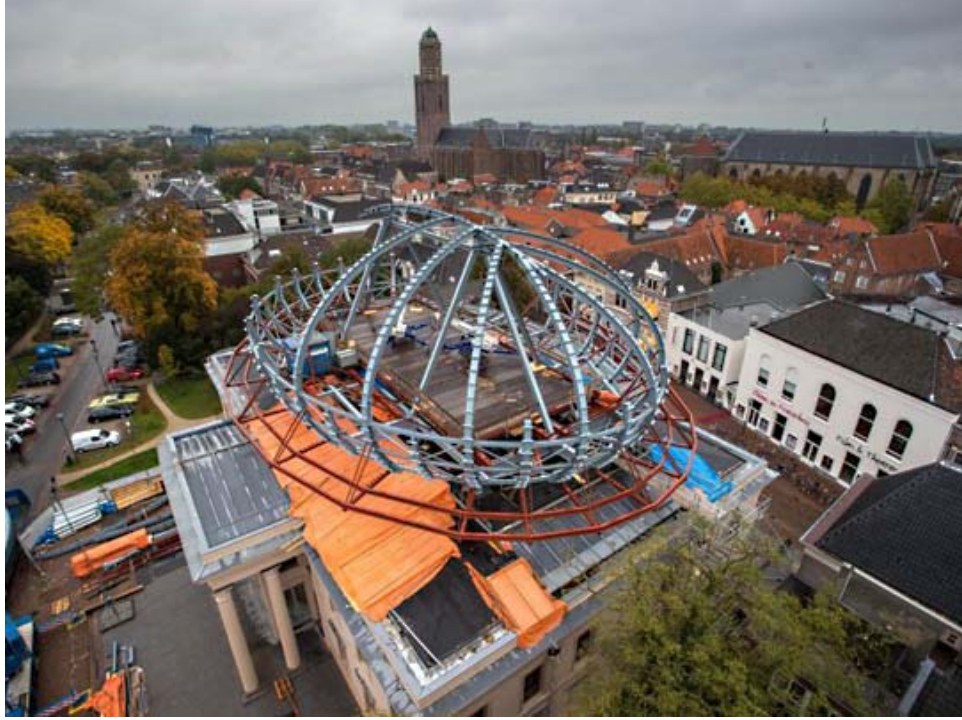
Şekil 169. Fundatie Müzesi Ek Yapı Strüktürü (url-66)
