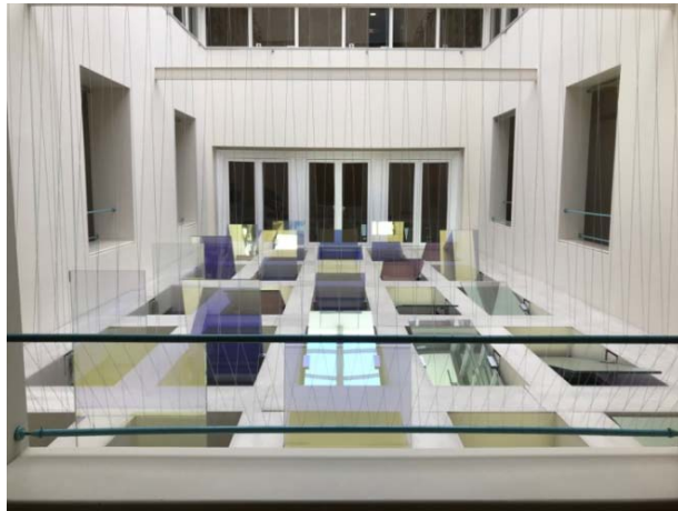
Şekil 78. Salt Galata Şeffaf Cam Paneller Üst Görünüm
