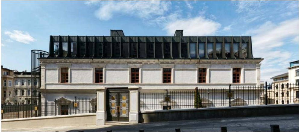
Şekil 61. Beyoğlu Belediye Binası Çatı Eki
