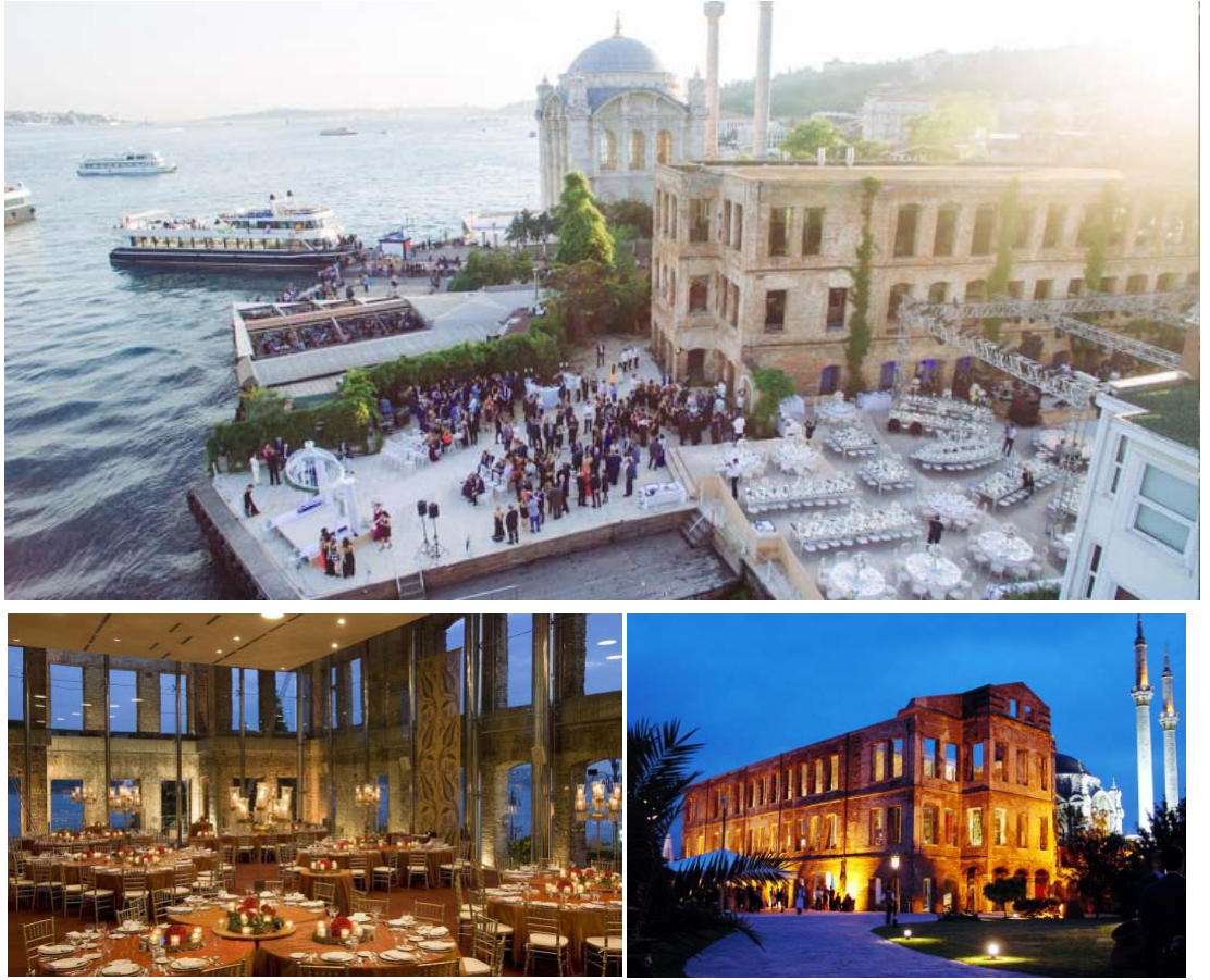
Şekil 121. Esmâ Sultan Yalısı Restorasyon Sonrası
