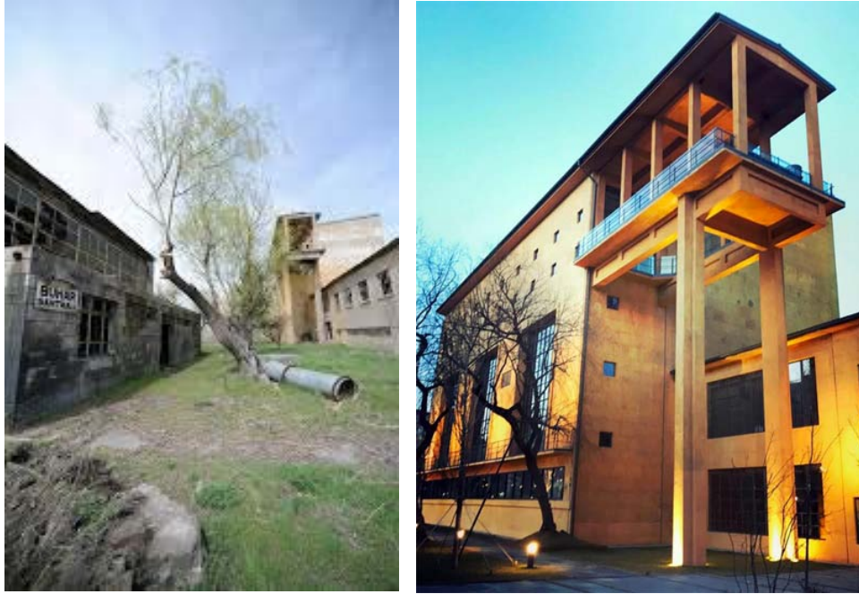
Şekil 104. Elektrik Santrali Restorasyon Öncesi ve Sonrası (url-48,url-49)
