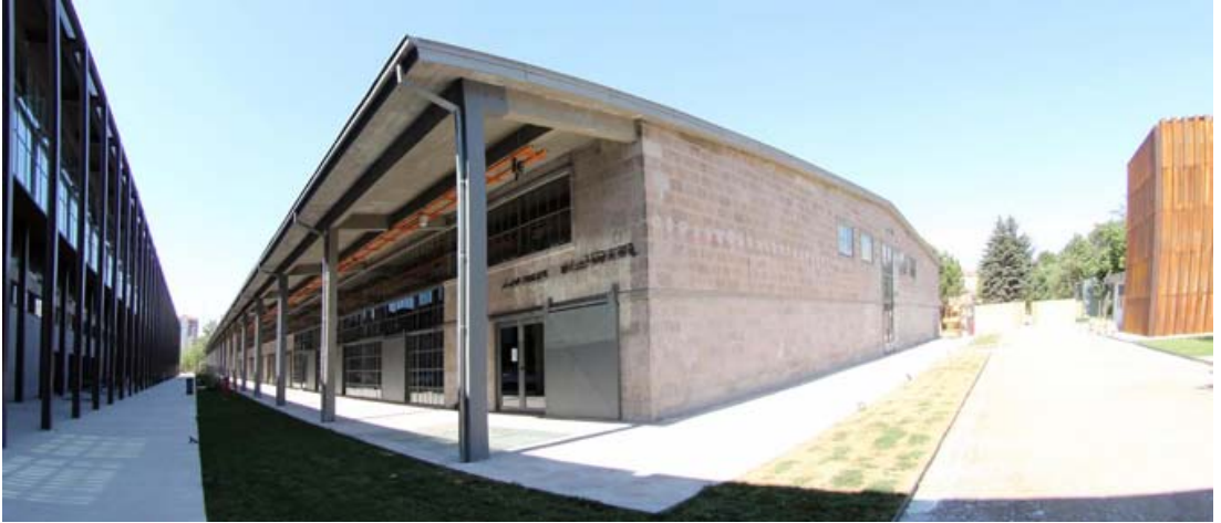
Şekil 102. AGÜ Sümer Kampüsü Ambar Binası (url-49)
