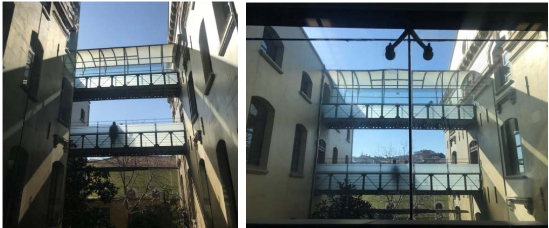
Şekil 90. A ve C Blokları Arasına Eklenen Çelik Köprü
