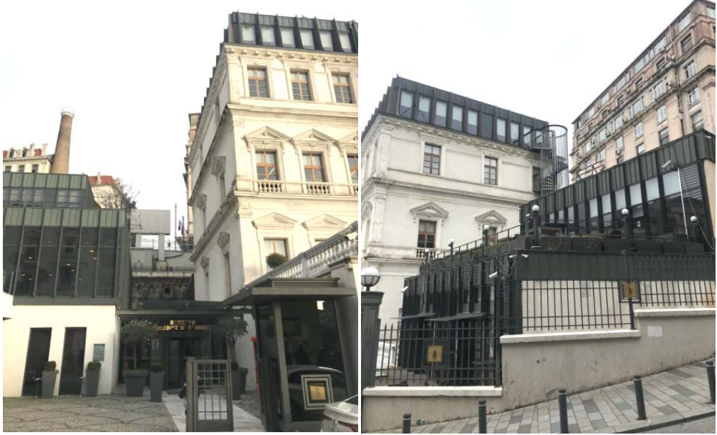
Şekil 60. Beyoğlu Belediye Binası Ek Yapıları
