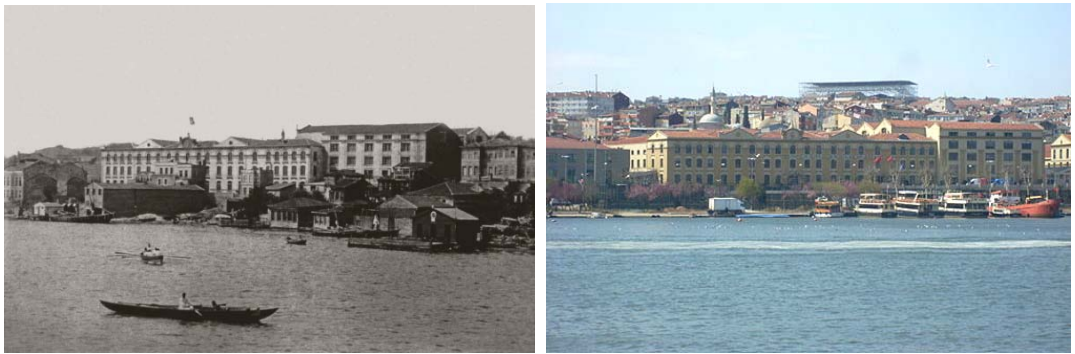
Şekil 86. Cibali Tütün Fabrikası Restorasyon Öncesi ve Sonrası (Kadir Has Üniversitesi Cibali Kampüsü) (Alper, 2018), (url-45)
