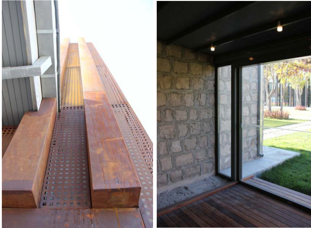
Şekil 105. AGÜ İtfaiye Binası Detayları (Restorasyon Sonrası) (url-49)
