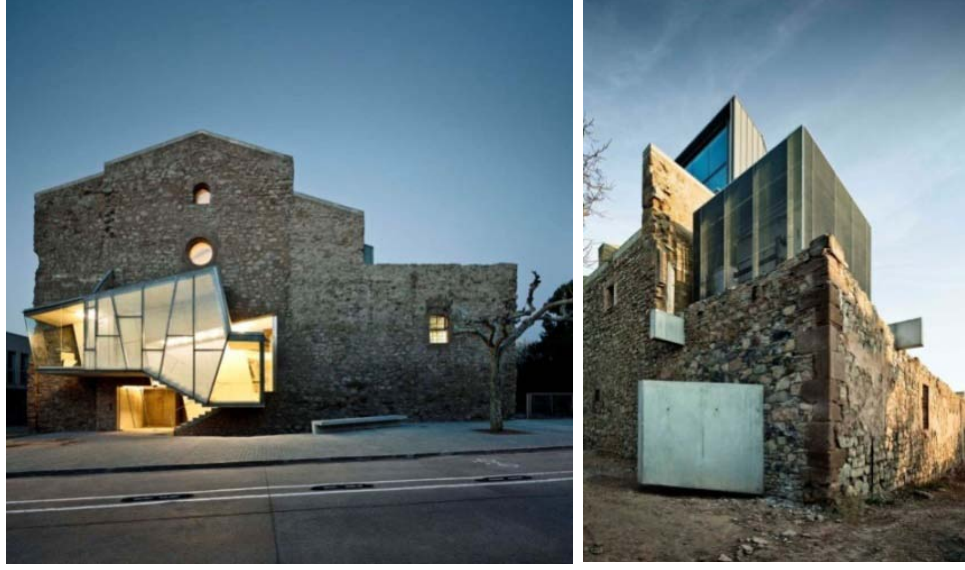
Şekil 181. Sant Francesc Kùltür Merkezi Cephesi Çağdaş Eklemeler (url-68)
