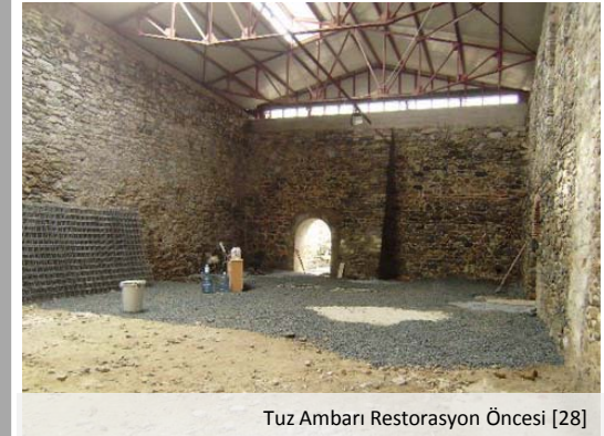
Tuz Ambari Restorasyon Öncesi [28]
