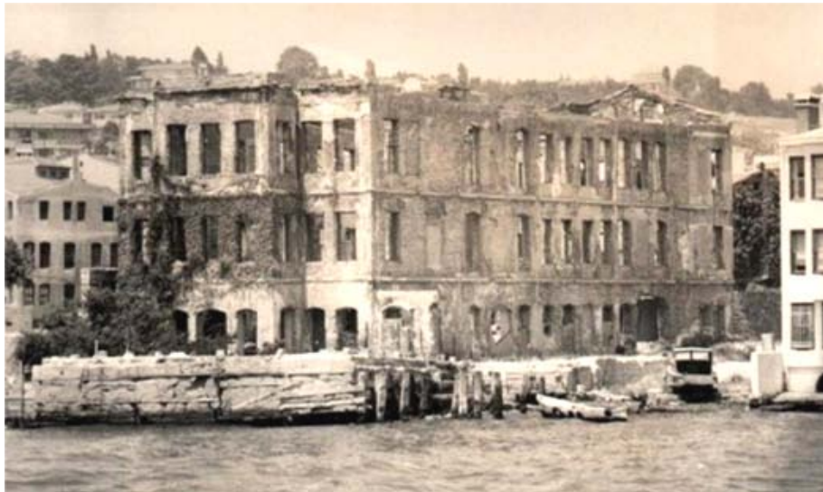
Şekil 114. Esmâ Sultan Yalısı Restorasyon Öncesi (Salt Arşivi)
