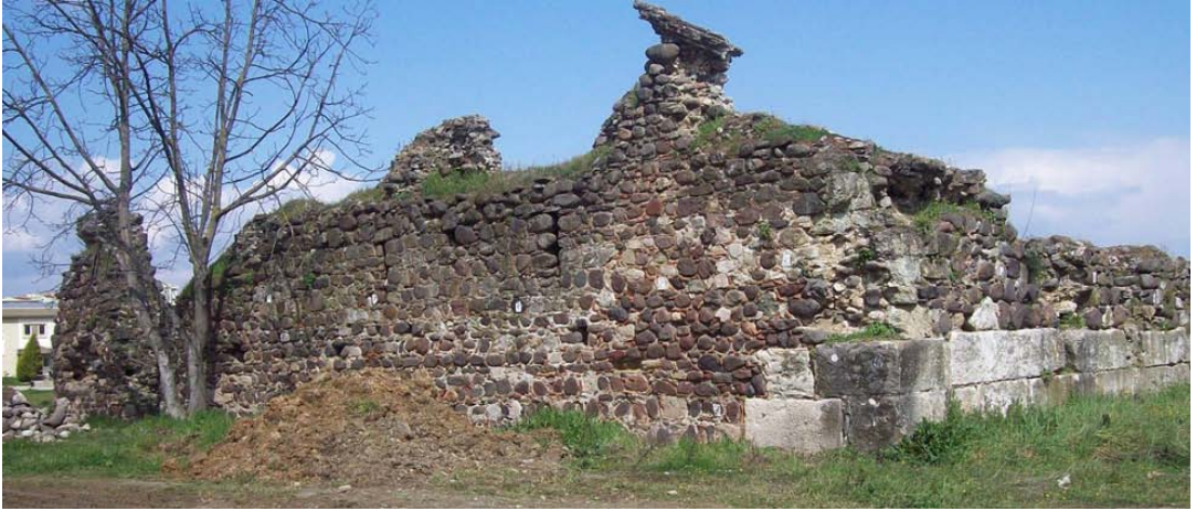
Şekil 94. Kazıklı Kervansarayı Restorasyon Öncesi (url-47)
