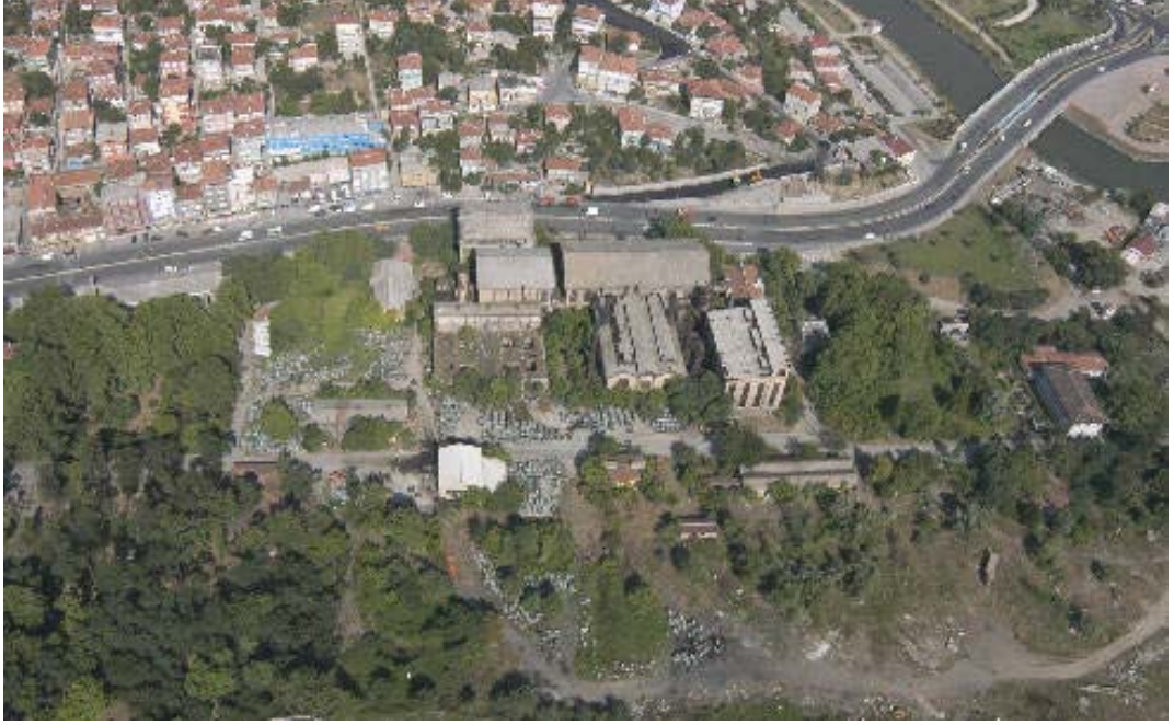
Şekil 46. Restorasyon Öncesi Silaharağa Elektrik Santrali (url-36)
