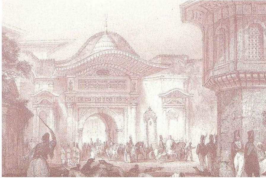
Görsel 2. 2: 19. yy. ortaları Topkapı Saray giriş kapısı. Thomas Allom, (H. Aydın, 2013, s. 96)
