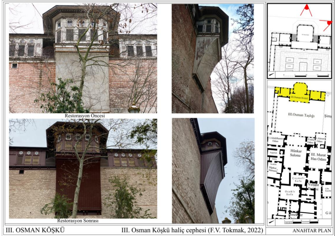
Görsel 4. 24: III. Osman Köşkü halic cephesi 2018-2022 onarımları (F.V. Tokmak, 2022)
