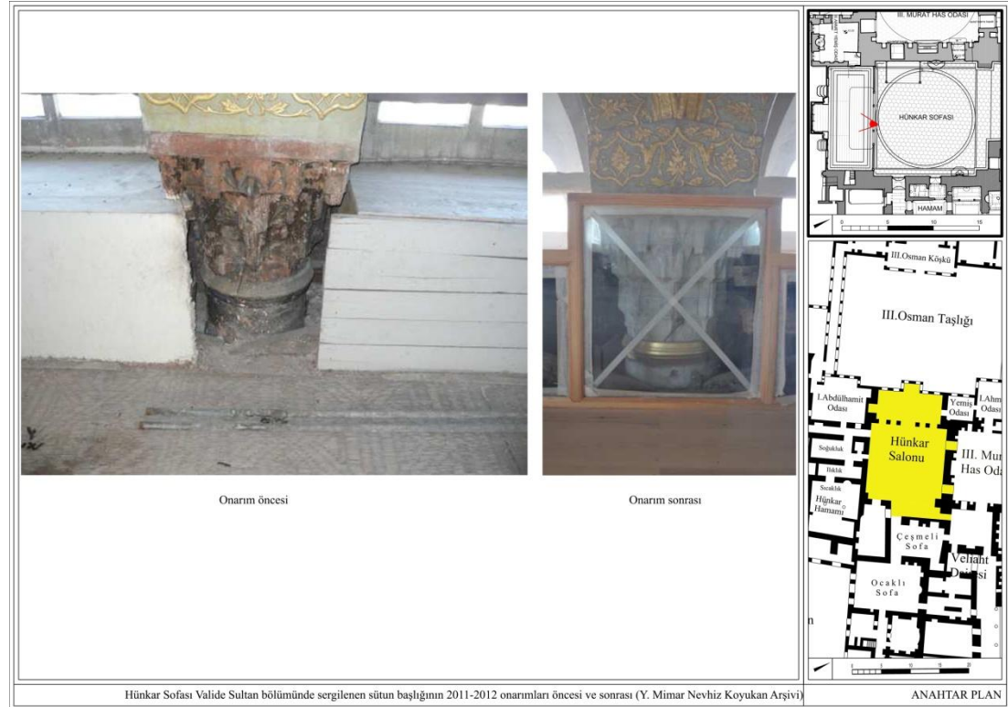
Görsel 3. 73: Hünkar Sofası Valide Bölümünde sergilenen sütun başlığının 2011-2012 onarım öncesi ve sonrası görünümü (Y. Mimar N. Koyukan Arşivi)
