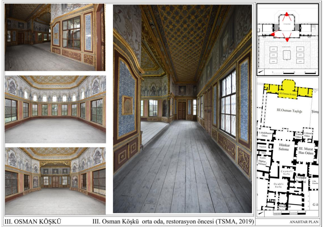
Görsel 4. 30: III. Osman Köşkü orta oda, restorasyon öncesi (TSMA,2019)
