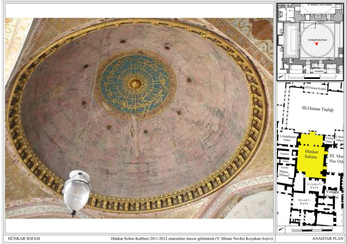
Görsel 3. 70: Hünkar Sofası 2011-2012 Onarımları öncesi görünümü (Y. Mimar N. Koyukan Arşivi)
