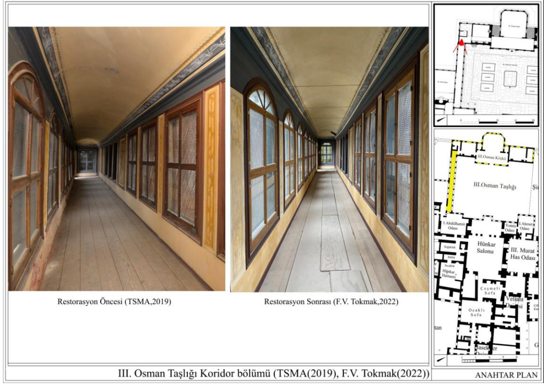
Görsel 4. 33: III. Osman Taşlığı koridor bölümü restorasyon öncesi sonrası (F.V. Tokmak, 2022)
