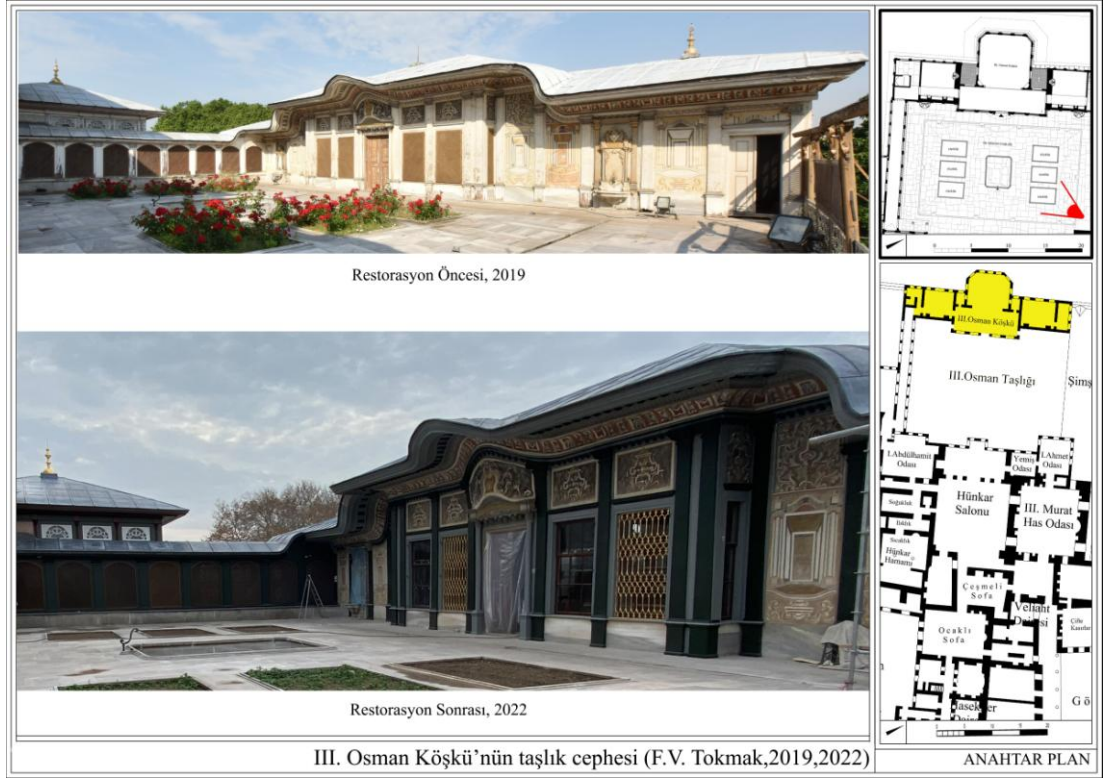
Görsel 4. 28: III. Osman Köşkü taşlık cephesi restorasyon öncesi sonrası
