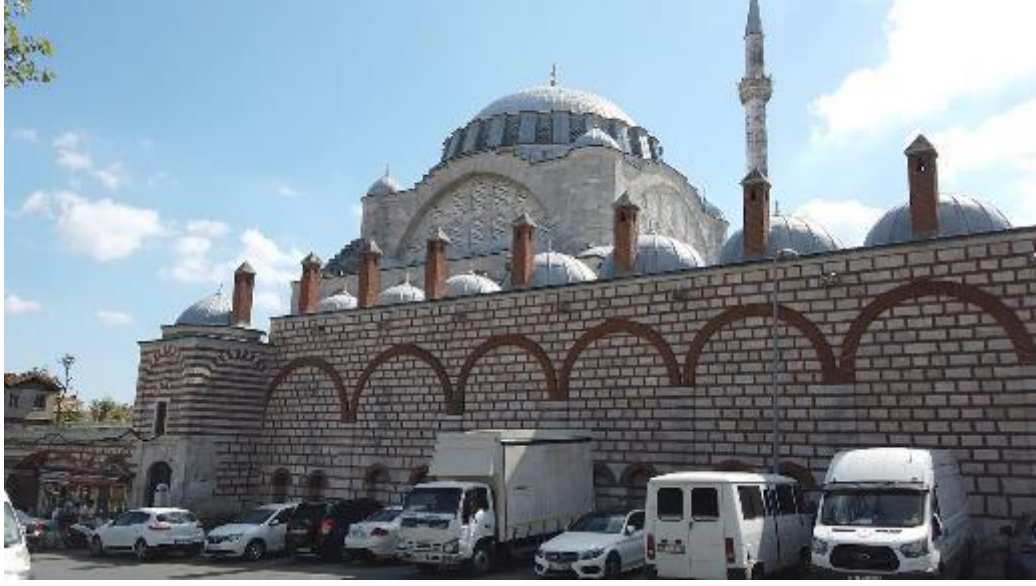
Resim 5. 60. Mihrimah Sultan Camii Medrese Duvarlarındaki Eski Dükkânların İzleri (Fotoğraf: Ayşe Nur Atmaca / Çekim Tarihi: 06.05.2024)
