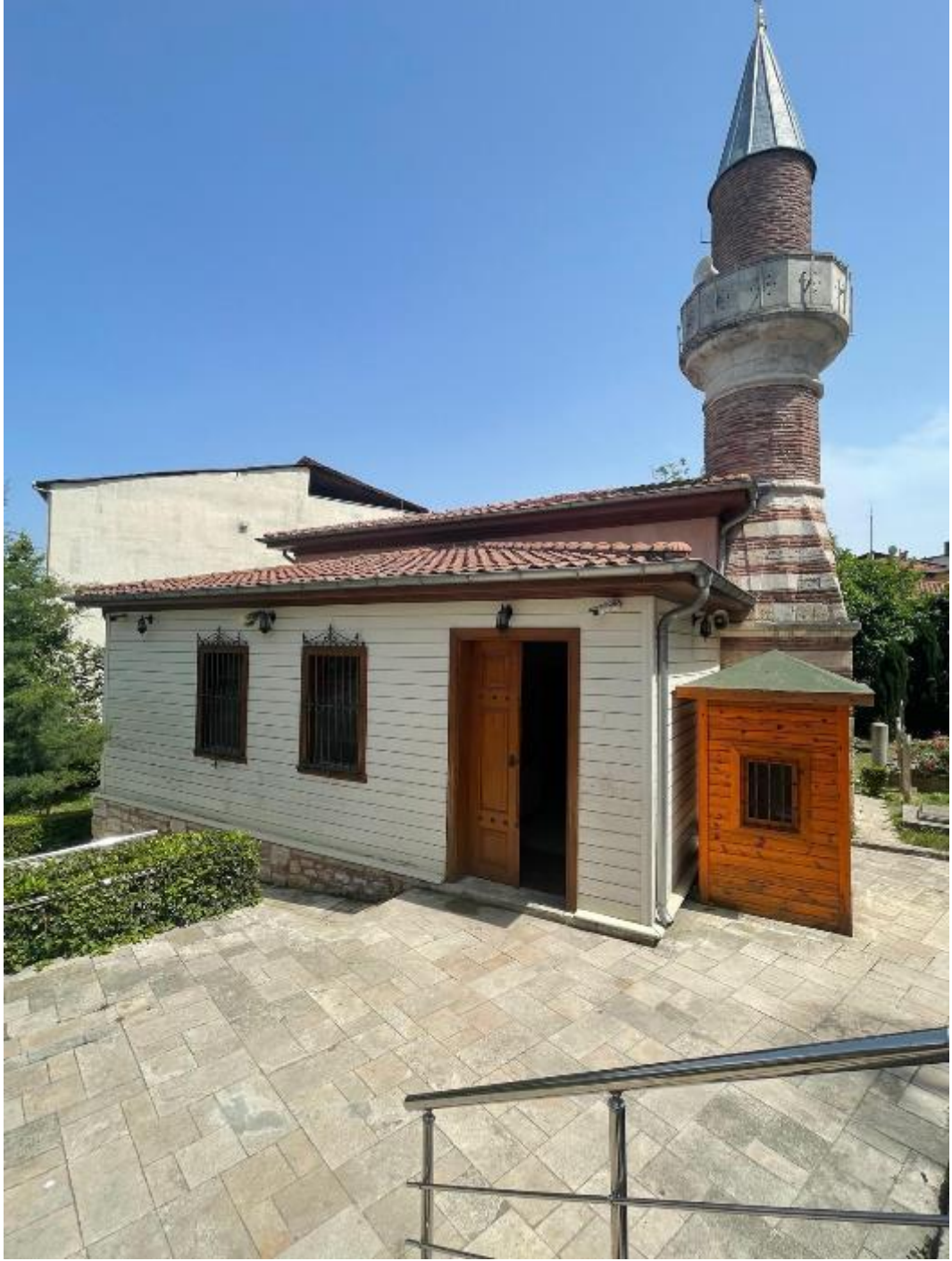
Resim 5. 43. Babüssaade Ađası Davut Ađa Camii Restorasyon Sonrası Görünümü (Fotođraf: Ayşe Nur Atmaca / Çekim Tarihi: 22.05.2024)
