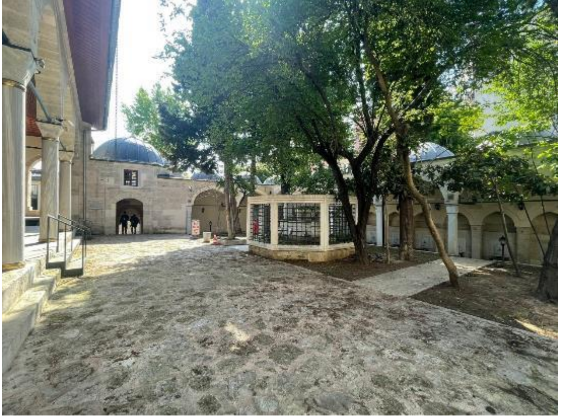
Resim 5. 83. Mesih Ali Paşa Camii Avlusu (Ortada Mesih Ali Paşa'nın haziresi, bir alt kotta şadırvan duvarı) (Fotoğraf: Ayşe Nur Atmaca / Çekim Tarihi: 06.05.2024)
