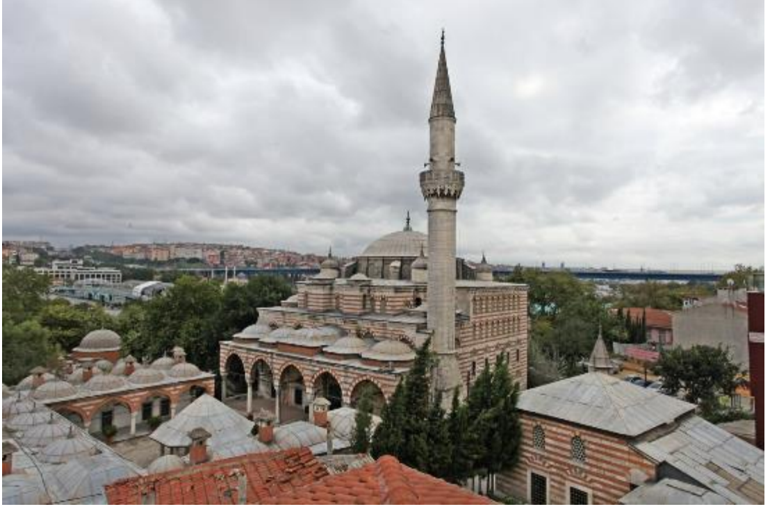
Resim 5. 20. Zal Mahmud Paşa Külliyesi (Url-39)
