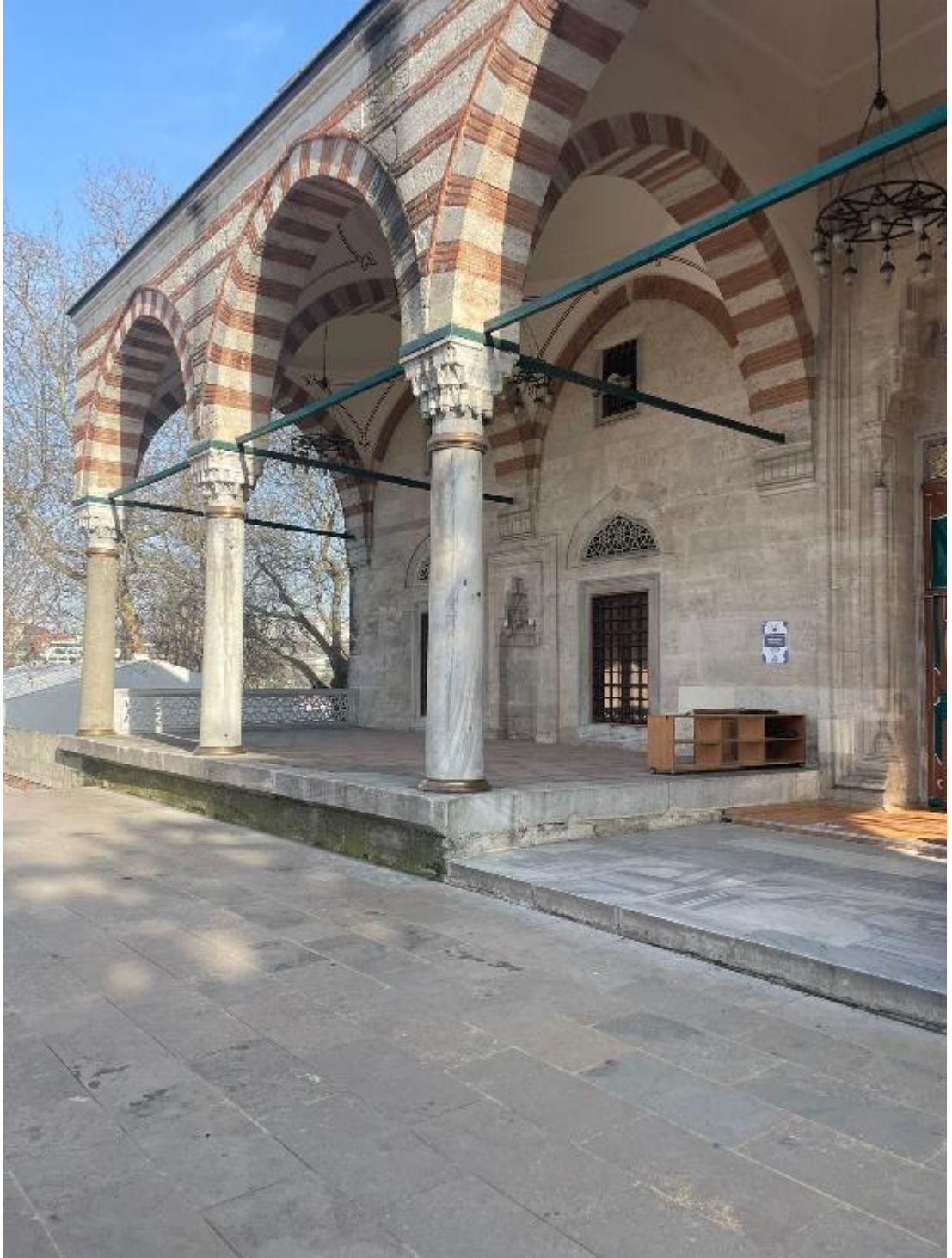
Resim 5. 23. Zal Mahmud Paşa Camii Revaklı Son Cemaat Yeri (Fotoğraf: Ayşe Nur Atmaca / Çekim Tarihi: 29.02.2024)
