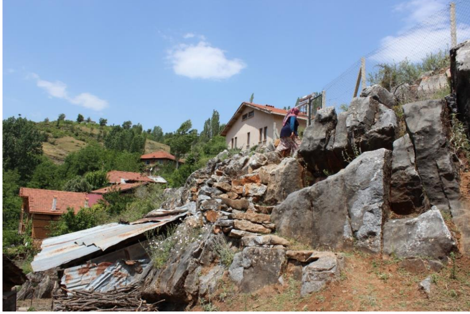
Şekil 3. 62: Dedeler köyü sokak ulaşımı için taştan yapılan merdiven örneği (B. S. Saldamlı Arşivi, 2022)
