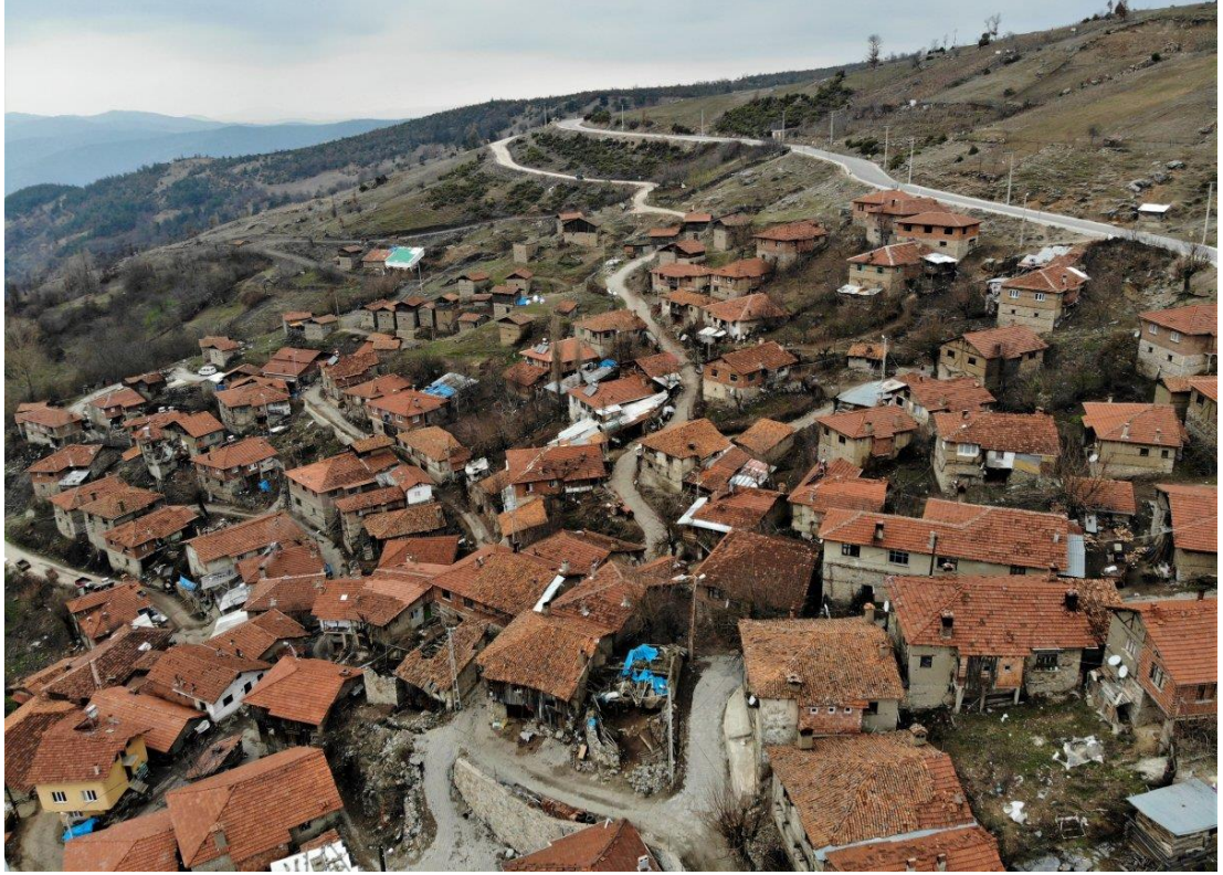
Şekil 3. 40: Dedeler köyü genel görünüm 25
