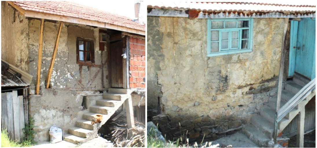
Şekil 3. 71: Konut yapısında cepheden döşeme kirişlerinin görünüşü (B. S. Saldamlı Arşivi, 2022)
