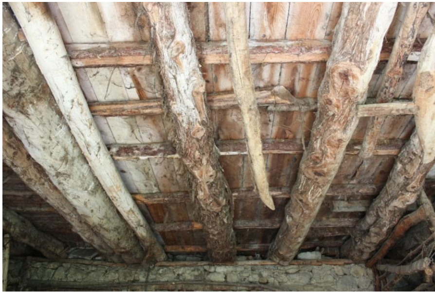
Şekil 3. 68: Zemin kat-birinci kat arası döşeme örneği (B. S. Saldamlı Arşivi, 2022)
