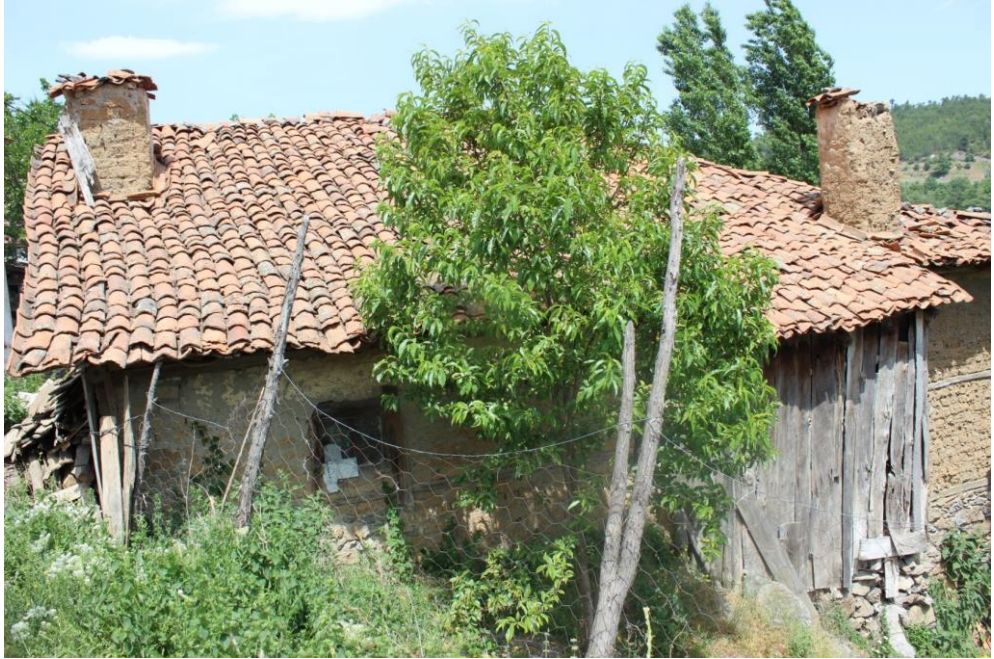
Şekil 3. 26: Çatı örtüsünde alaturka kiremit örneği (B. S. Saldamlı Arşivi, 2022)
