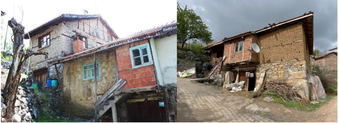
Şekil 3. 66: Konutlarda çoklu malzeme kullanımı örnekleri (B. S. Saldamlı Arşivi, 2022)
