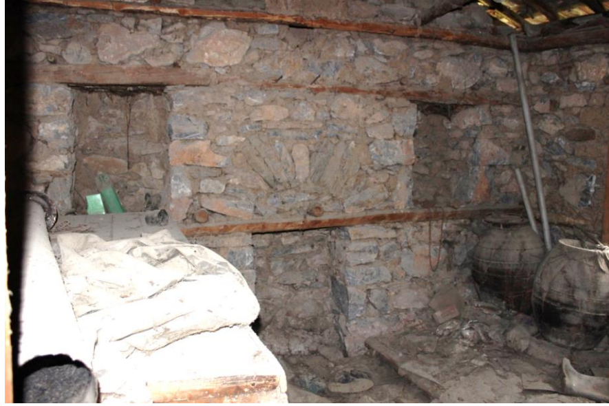
Şekil 3. 67: Yapıda üst kattaki odanın sıvasız kullanımı (B. S. Saldamlı Arşivi, 2022)
