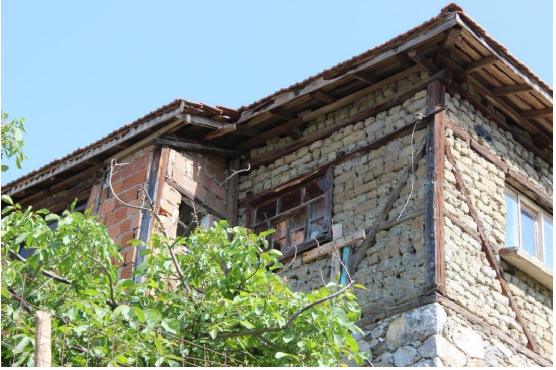
Şekil 3. 70: Hıms sistemde kerpiç kullanımı örneği (B. S. Saldamlı Arşivi, 2022)
