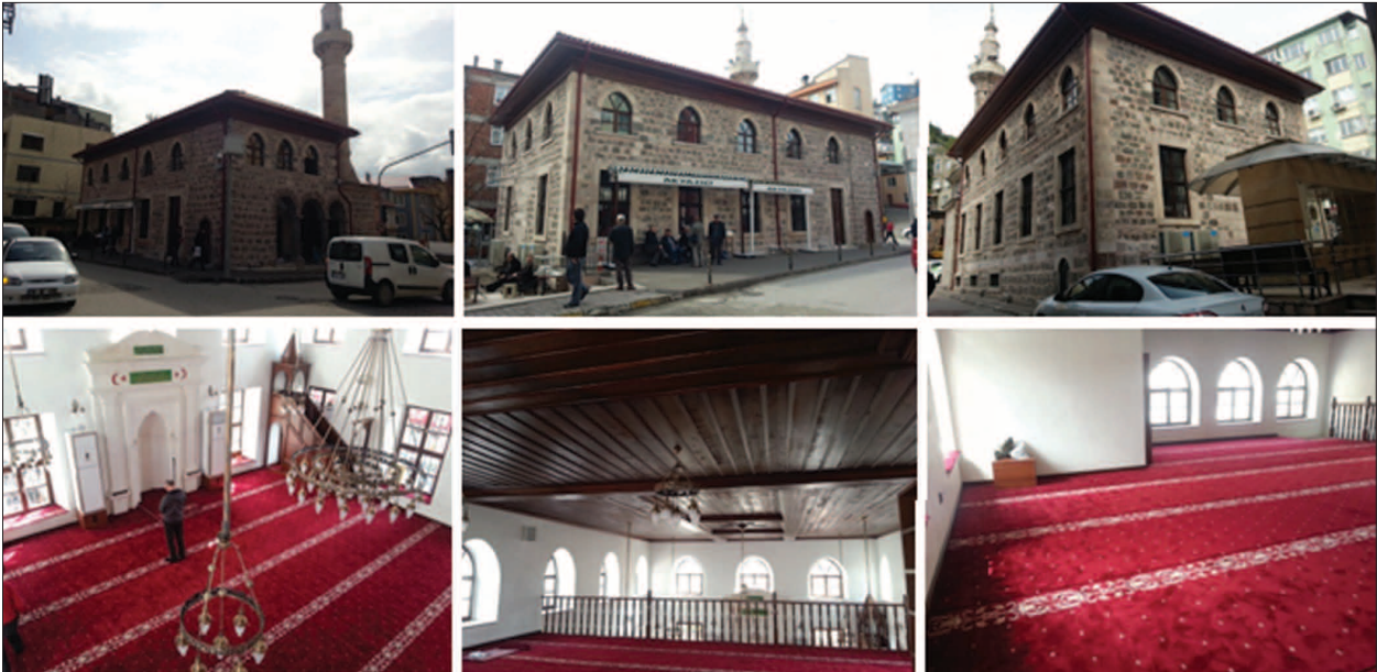
Fotoğraf 28. Çınarlar Camisi onarım sonrası fotoğrafları.
