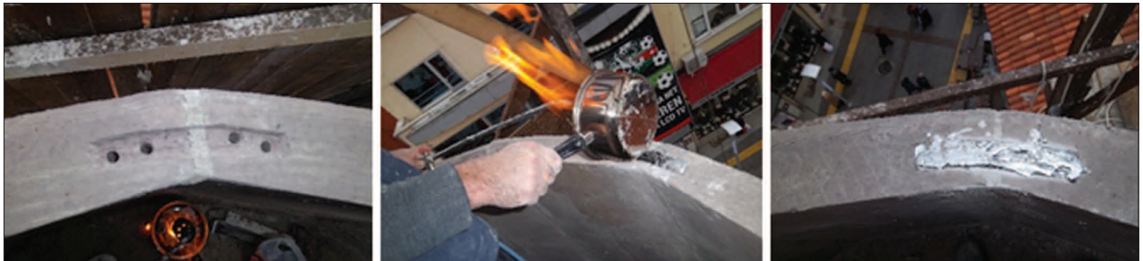
Fotoğraf 20. Kurşun kenet yapılması fotoğrafları.
