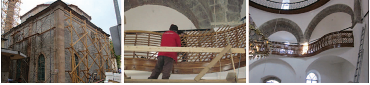
Fotoğraf 13. Hacı Miktad Camisi cephe, minare ve korkuluk işleri fotoğrafları.
