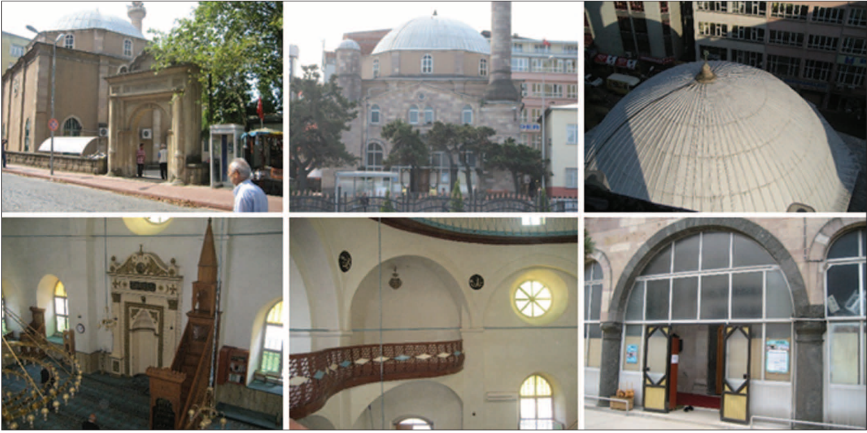
Fotoğraf 10. Hacı Miktad Camisi onarım öncesi fotoğrafları.
