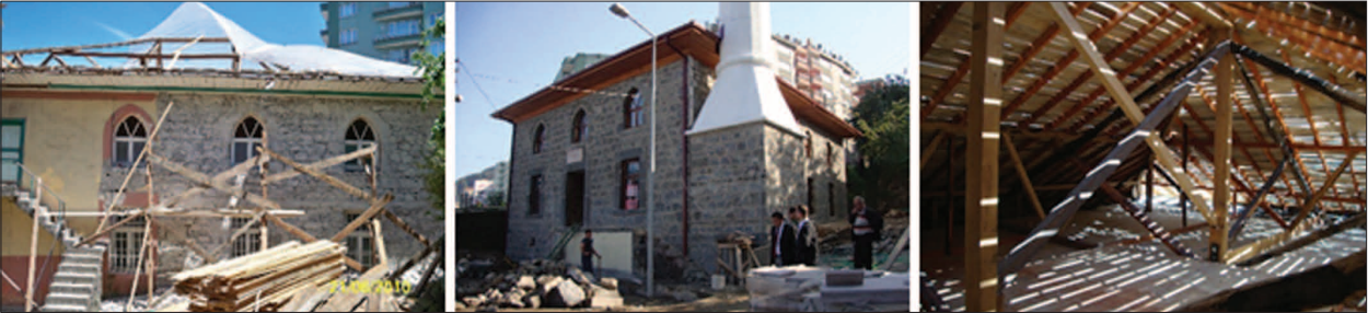
Fotoğraf 7. Gemilerçekeği Camisi cephe ve çatı işleri fotoğrafları.
