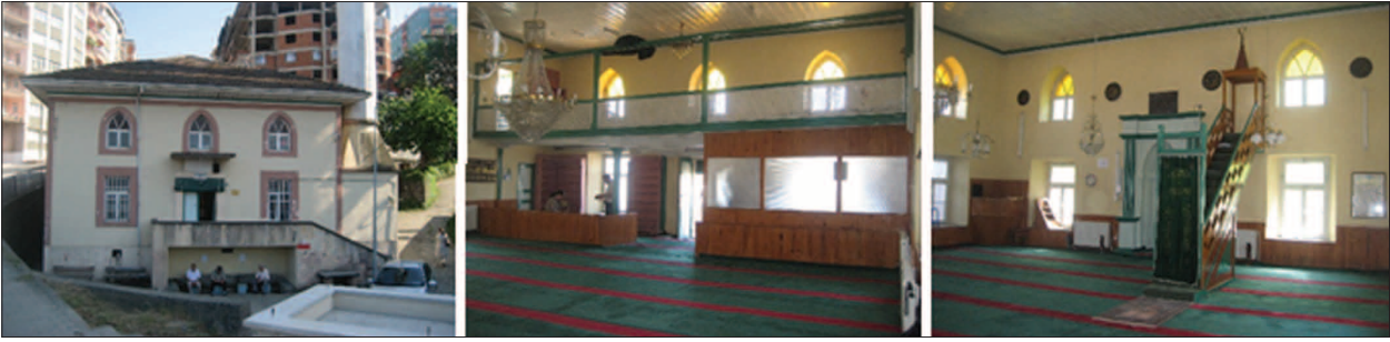
Fotoğraf 5. Gemilerçekeği Camisi onarım öncesi fotoğrafları.
