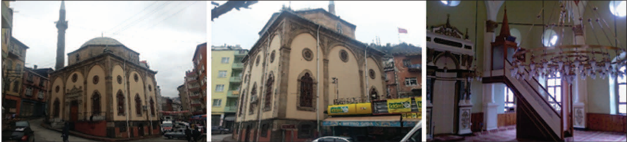
Fotoğraf 21. Kapu Camisi onarım öncesi fotoğrafları.
