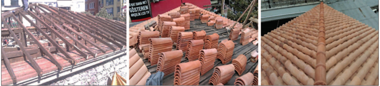
Fotoğraf 17. Şeyh Keramet'in Camisi çatı onarımı işleri fotoğrafları.
