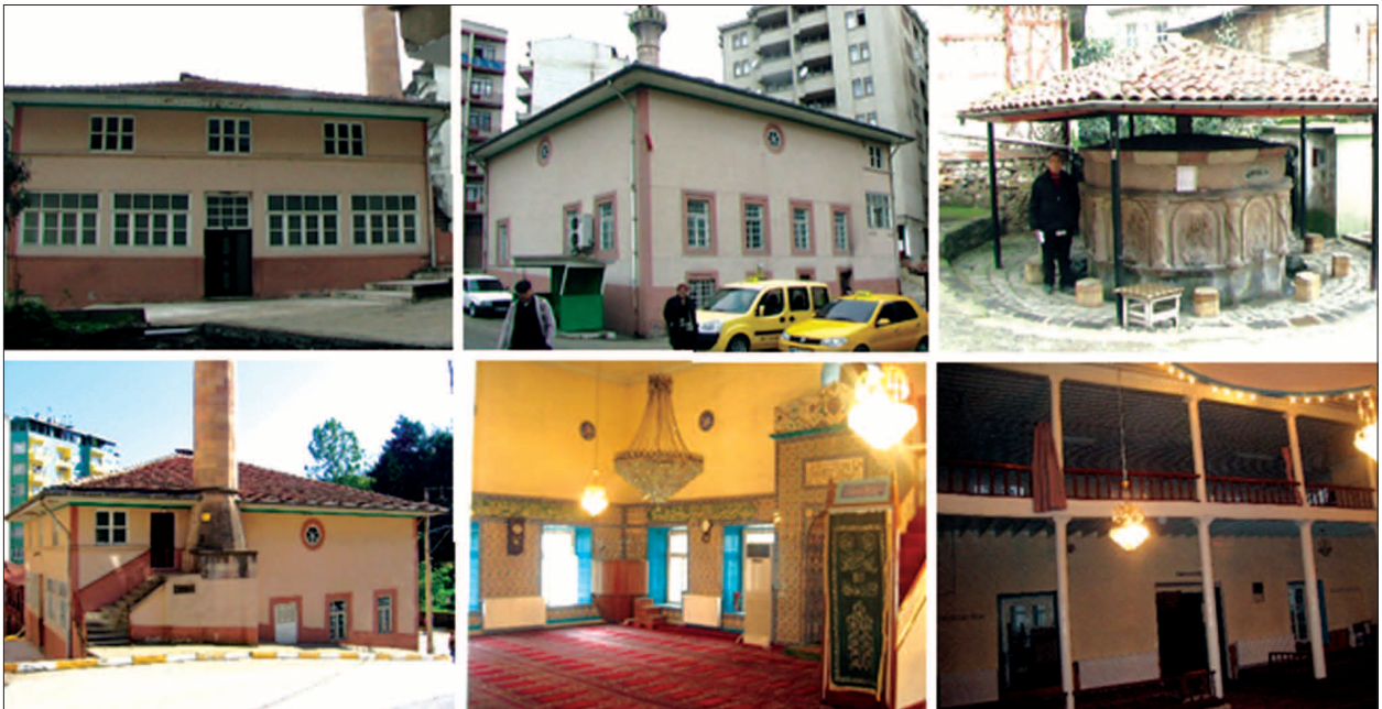
Fotoğraf 1. Hacı Hüseyin Camisi'nin restorasyon öncesi durumuna ait fotoğraflar.
