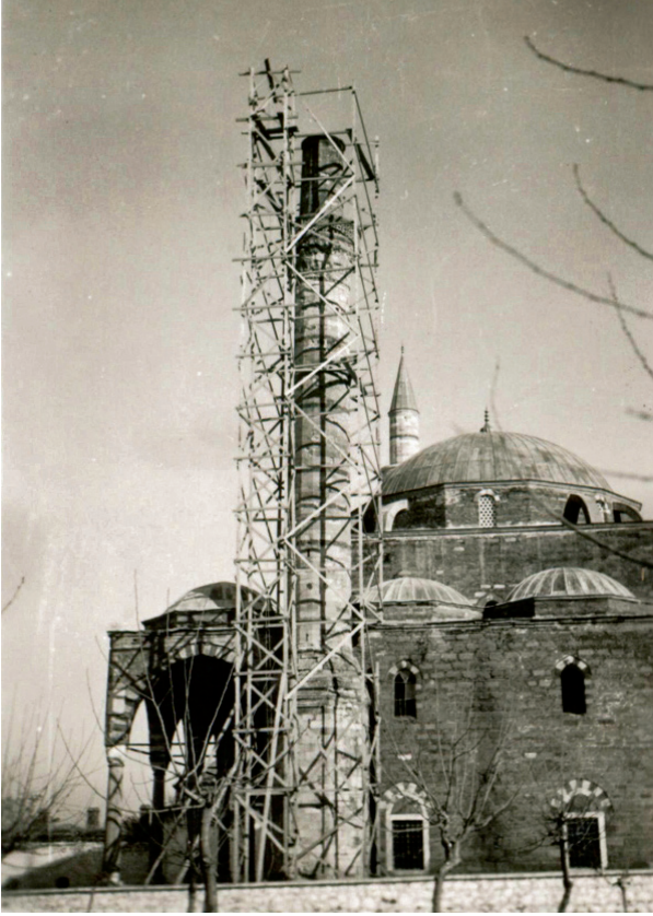
Manisa Ulu Camii restorasyonu (20.12.1953)
