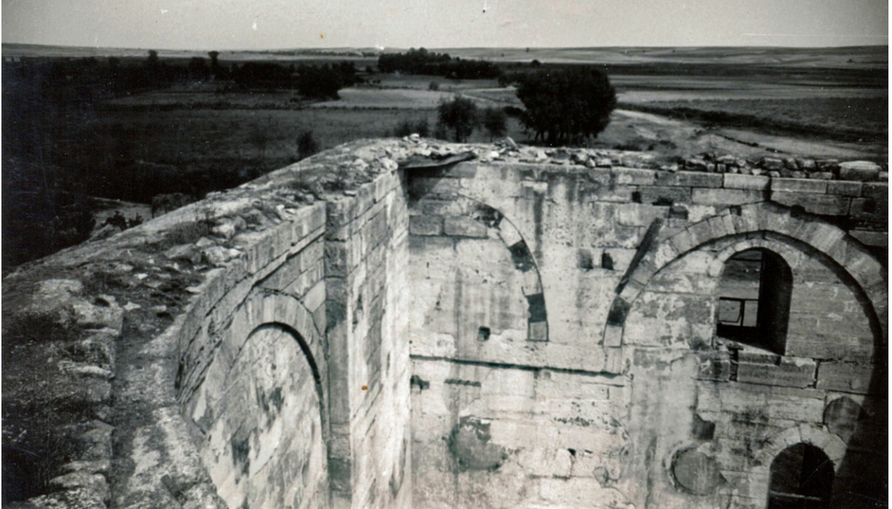
Süreyya Yücel'in restorasyonunda görev aldığı yapılardan Selçuk İsa Bey Camii
