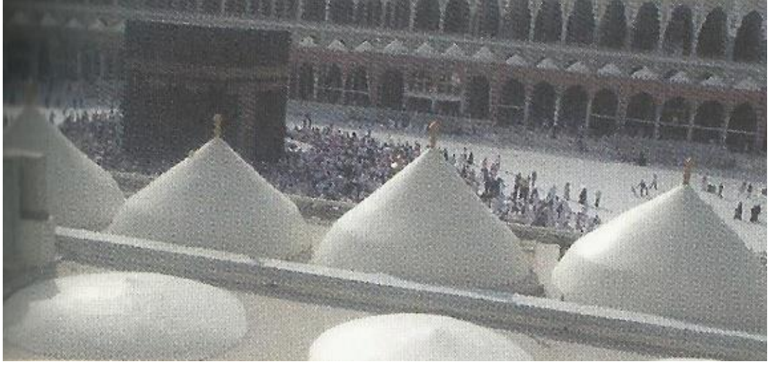
Resim 4.1 II. Selimin Emri Ve Mimar Sinan'ın Planlamasıyla İnşa Edilen Soğan Kubbeler
