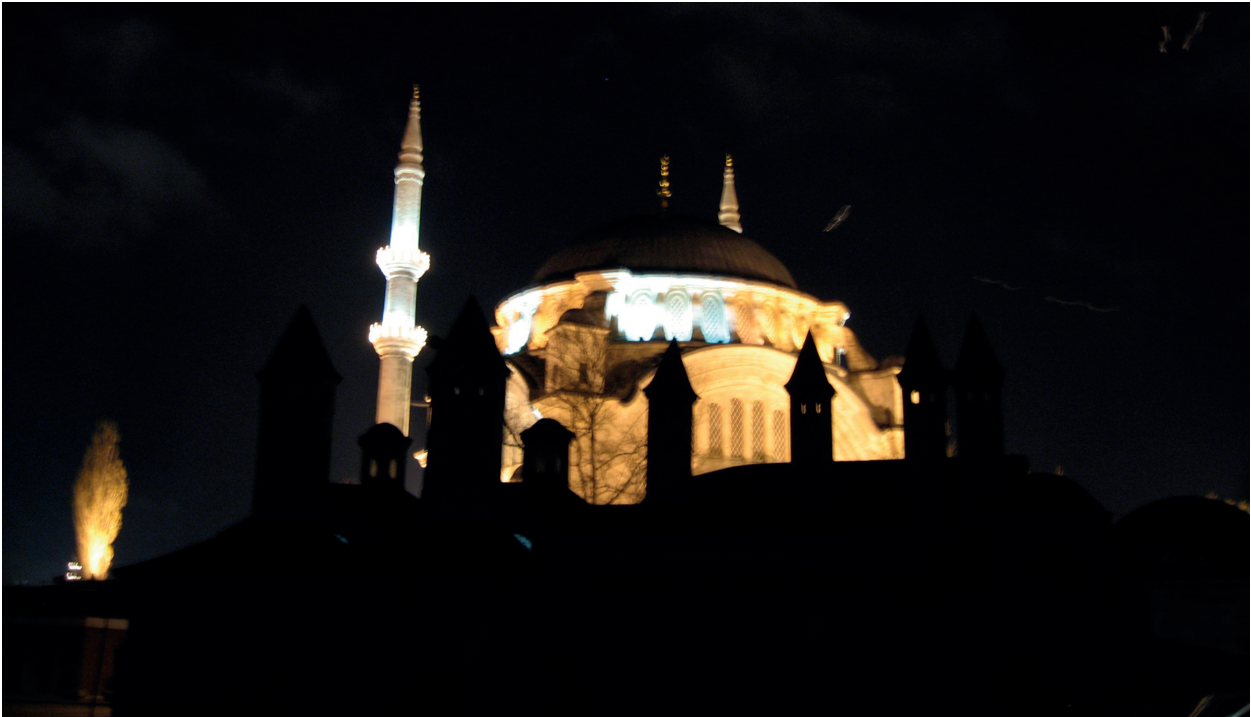
Fotoğraf 1. Gece, aydınlatma düzeni çerçevesinde caminin görünümü (Fatih Köse)
