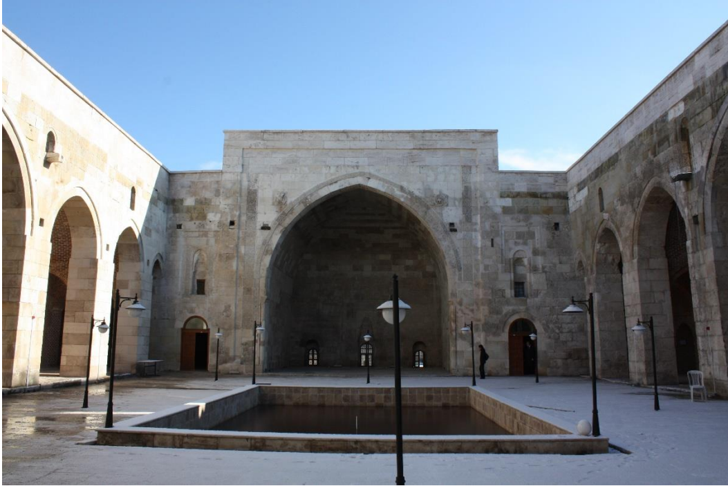
Şekil 24. I. İzzeddîn Keykâvus (Şifahîye) Darüşşifası, Restorasyon Sonrası (Vakıflar Genel Müdürlüğü Dijital Arşivi)
