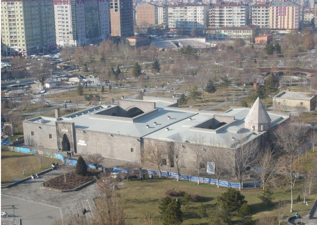
Şekil 15. Yapılan Restorasyon Çalışmaları Sonrası (Vakıflar Genel Müdürlüğü Arşivi)
