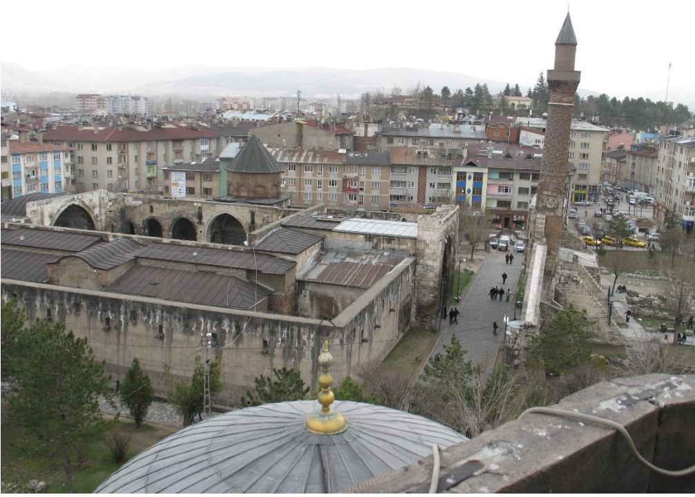
Şekil 18. I. İzzeddîn Keykâvus (Şifahiye) Darüşşifası Restorasyon Öncesi Fotoğraflar (Vakıflar Genel Müdürlüğü Dijital Arşivi)
