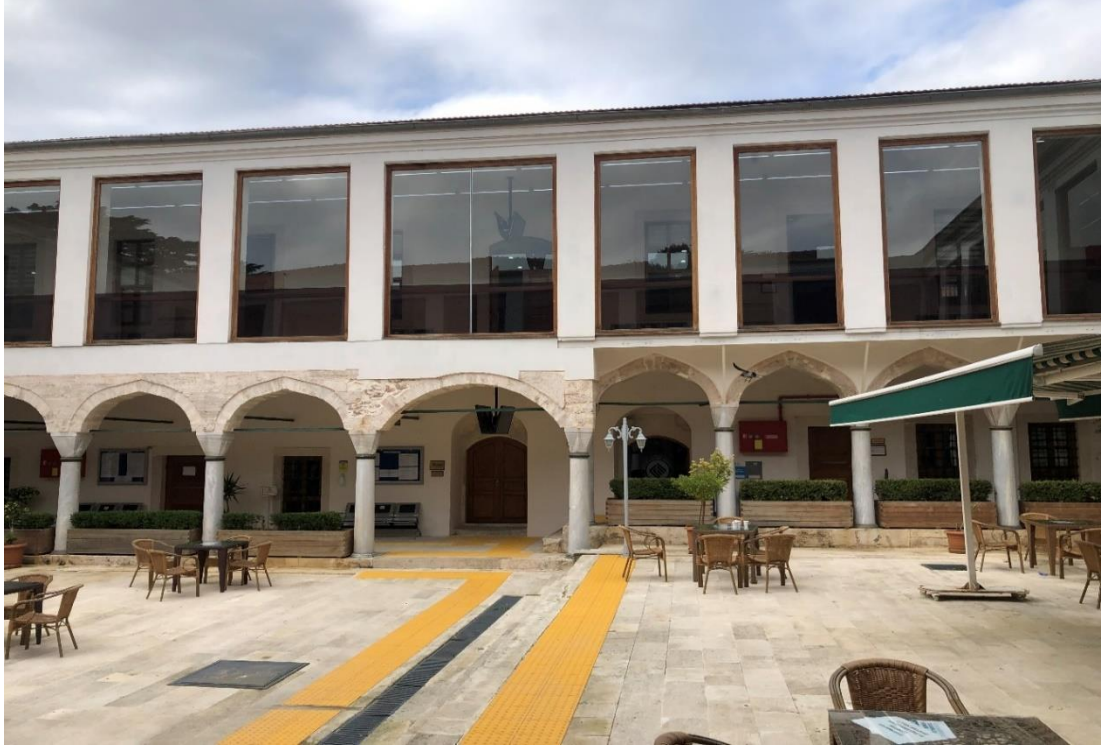
Şekil 101. Darüşşifa Değişim Sonrası Avludan Görünüm (Ersoy,2021)
