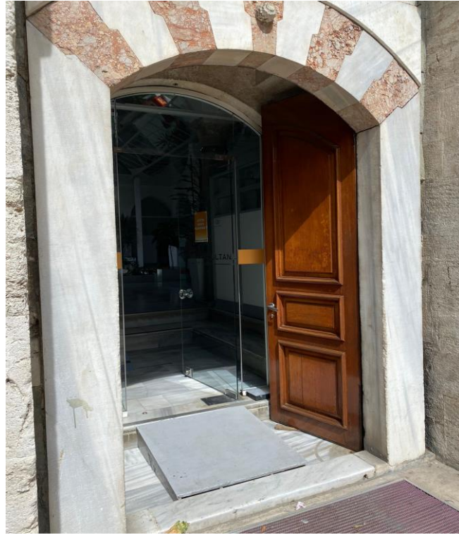
Şekil 108. Mihrimah Sultan Medresesi Girişi (Ersoy Bıçme, 2023)
