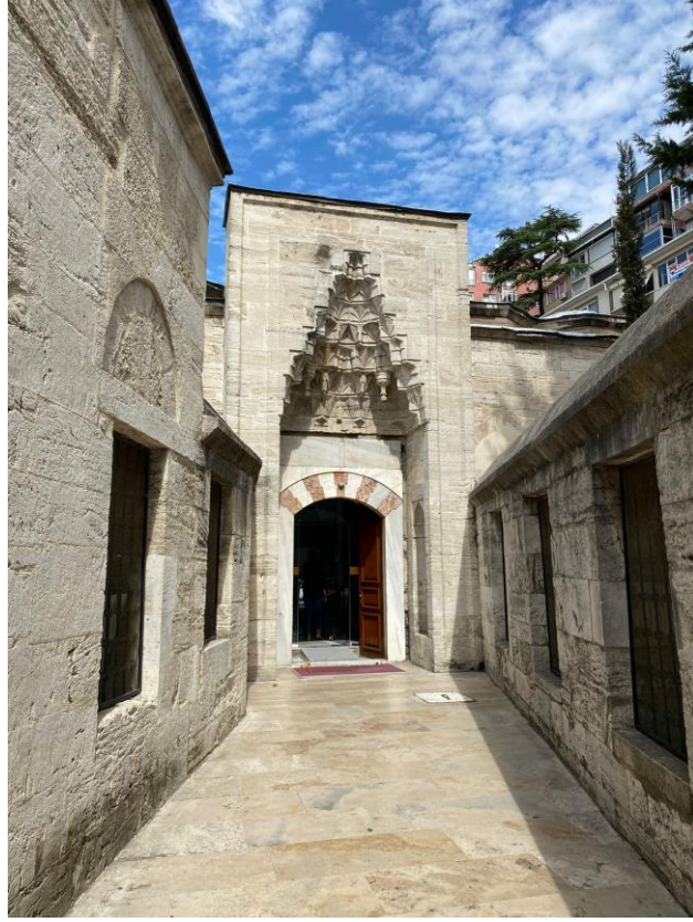
Şekil 107. Mihrimah Sultan Medresesi Girişi (Ersoy Bıçme, 2023)
