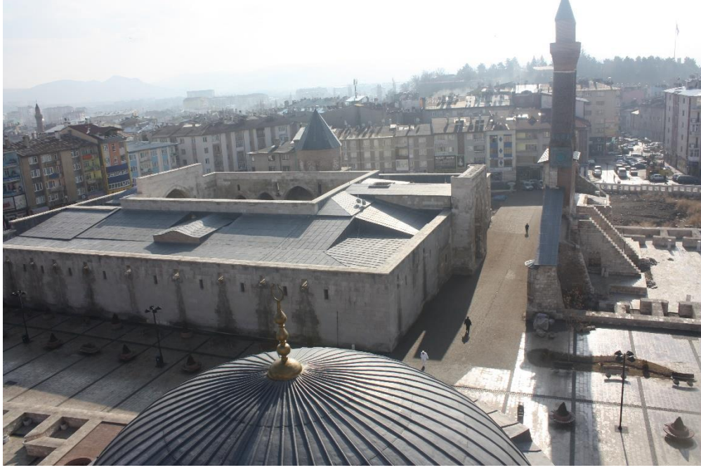
Şekil 23. I. İzzeddîn Keykâvus (Şifahîye) Darüşşifası, Restorasyon Sonrası (Vakıflar Genel Müdürlüğü Dijital Arşivi)
