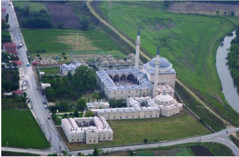
Şekil 65. Tunca Nehri'nin Kenarında II. Bayezid Külliyesi'nin Tamamı (Nişikli, 2019)
