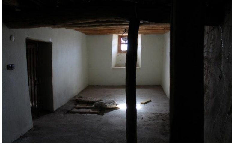
Şekil 3.25: Arapgir İlçesindeki Konağın Deposu ve Alt Depoya İnen Bölümü (Yazarın Fotoğraf Arşivi)
