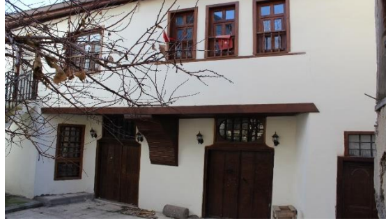
Şekil 3.23: Malatya/Arapgir ilçesinde Bulunan Konağın Dış Cephesi(Yazarın Fotoğraf Arşivi)
