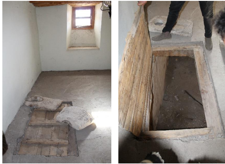
Şekil 3.26: Arapgir İlçesindeki Konağın Deposu (Yazarın Fotoğraf Arşivi)
