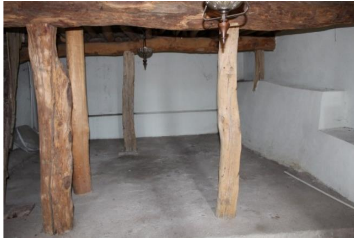
Şekil 3.24: Arapgir İlçesindeki Konağın Deposu(Yazarın Fotoğraf Arşivi)
