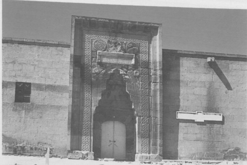
Res. 2: Gevher Nesibe Şifhanesi taçkapısı onarım sonrası görünümü.
