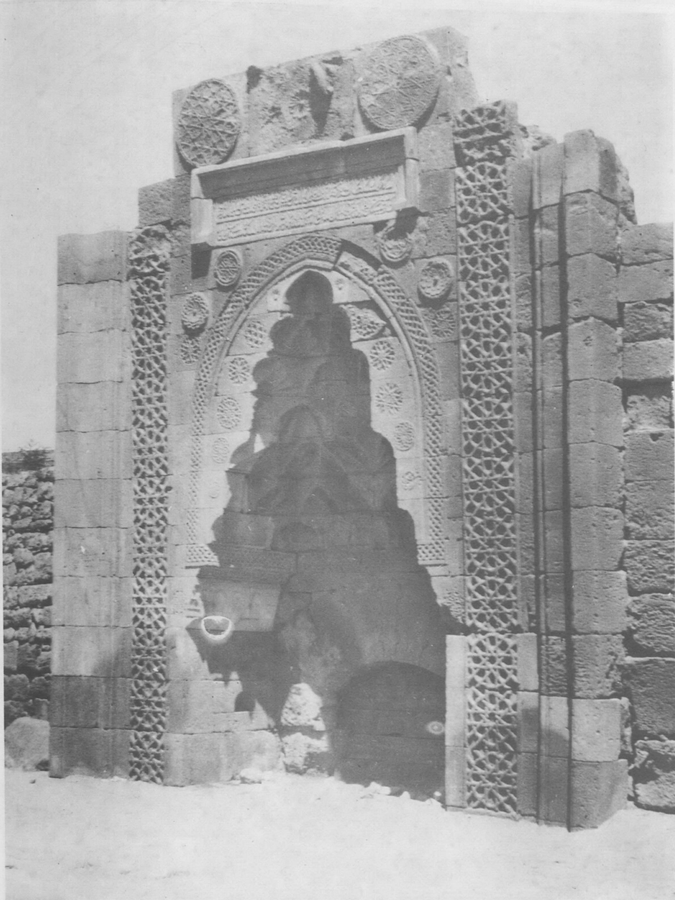
Res. 1: Gevher Nesibe Sifahanesi taçkapisı onarım öncesi görünümü
