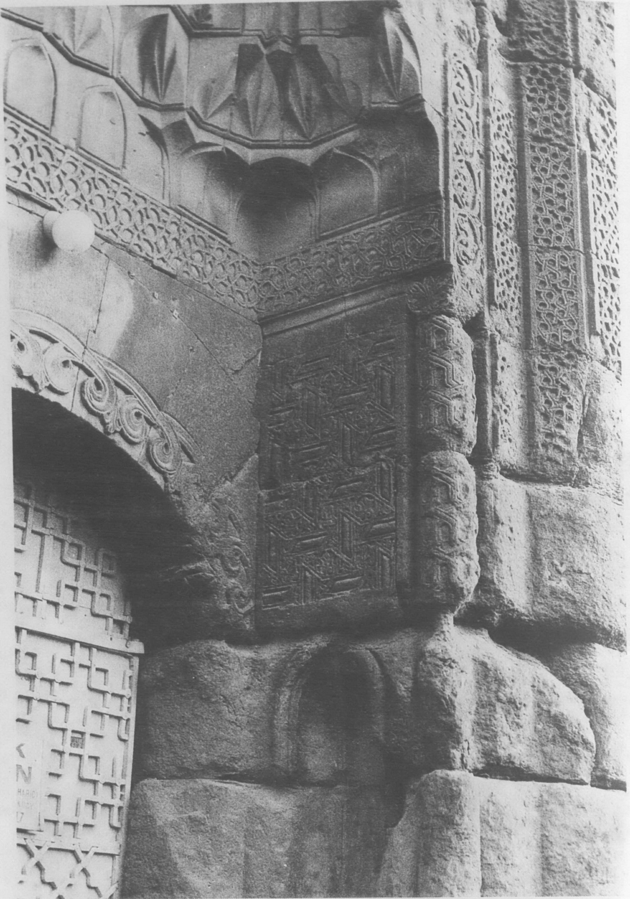
Res. 5: Hunat Hatun Medresesi taçkapı ön girintisi sağ (güney) yüzü.
