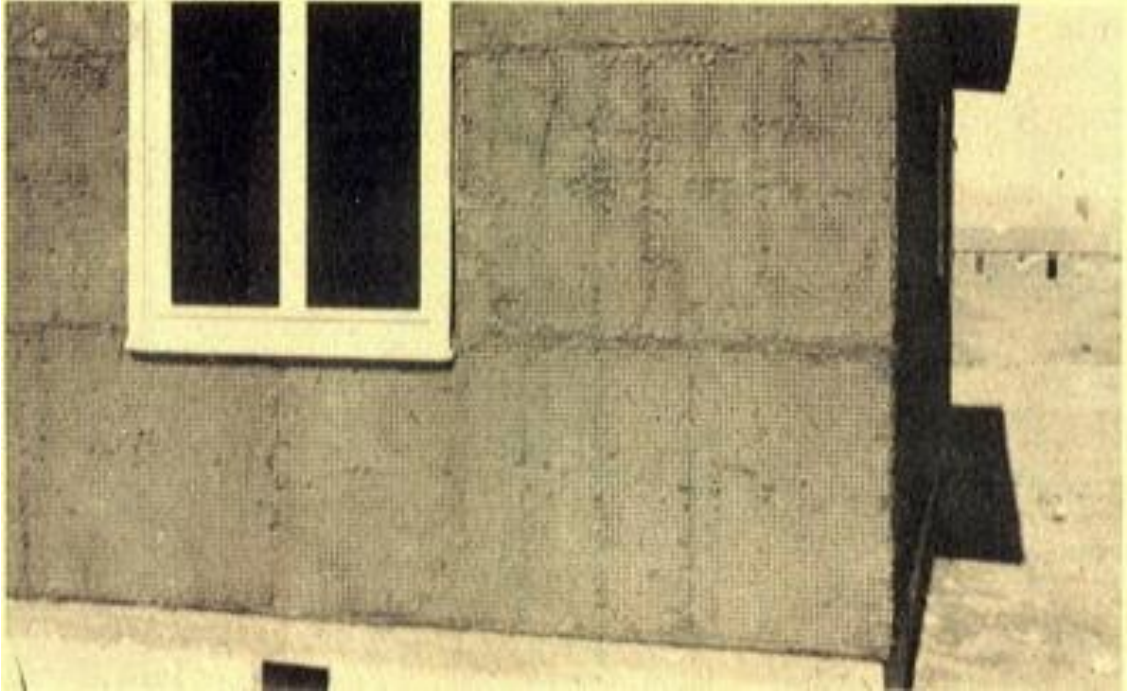
Şekil 18. Staubsciegel Sıva Teli İle Kaplanmış Duvar (Koyunoğlu, 1977)
