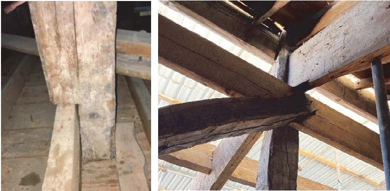
Şekil 4 - Çatı sisteminde kullanılan birleşim örnekleri
