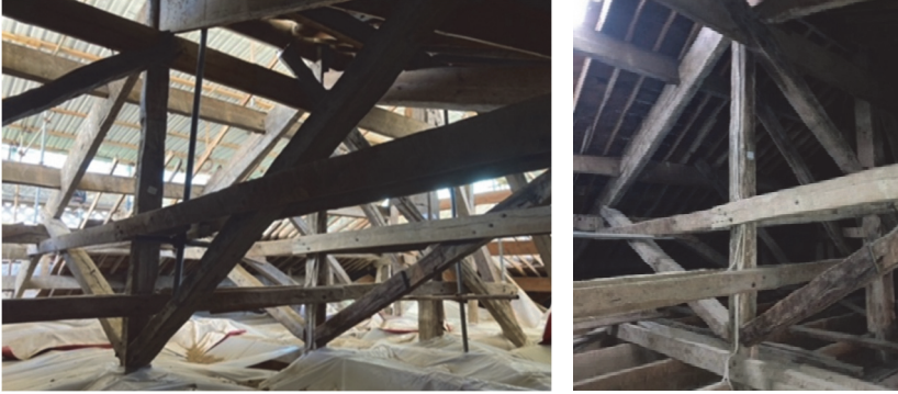
Şekil 3 - Valide Sultan Dairesi taşıyıcı sistemi
