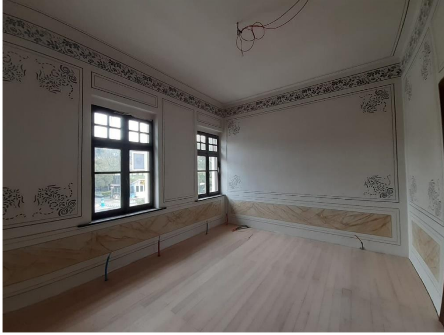
Şekil 6.136. Kırklareli Gar Binası 113 numaralı odasının duvarlarındaki kalem işi motifleri, filetolar ve mermer taklidi uygulaması görülmektedir.
