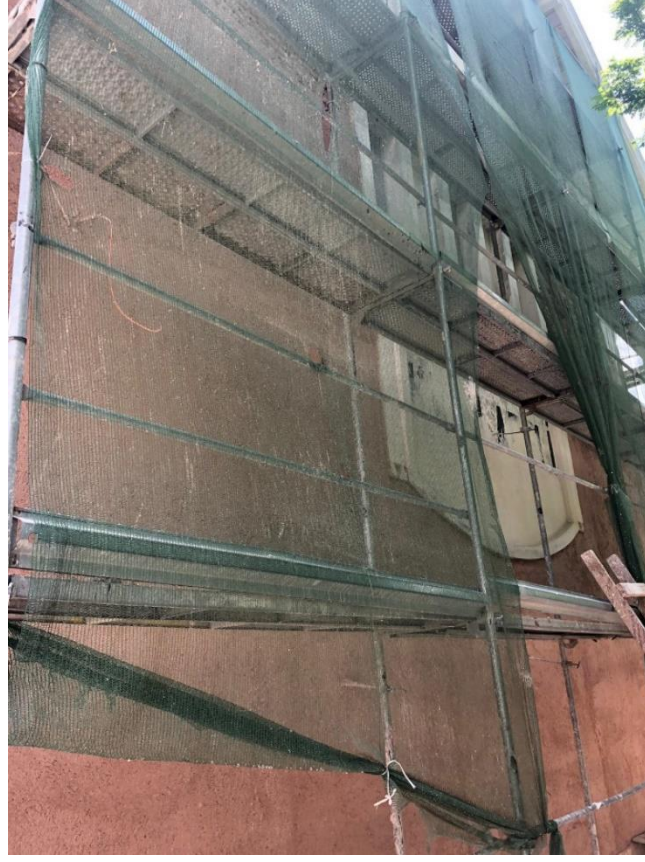
Şekil 6.91. Yapının Güney cephesindeki kaba sıva uygulaması görülmektedir.
