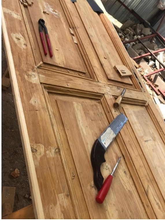
Şekil 6.150. Kırklareli Gar Binası 113 numaralı odasının kapı kanadının tamamlanan ahşap konservasyon uygulaması görülmektedir.
