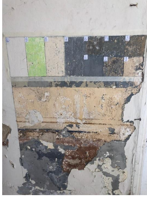
Şekil 6.38. Z01 numaralı odanın duvarlarında araştırma raspası sonucu ortaya çıkan 10 tabaka badana rengi ,filetolar ve mermer taklidi görülmektedir.
