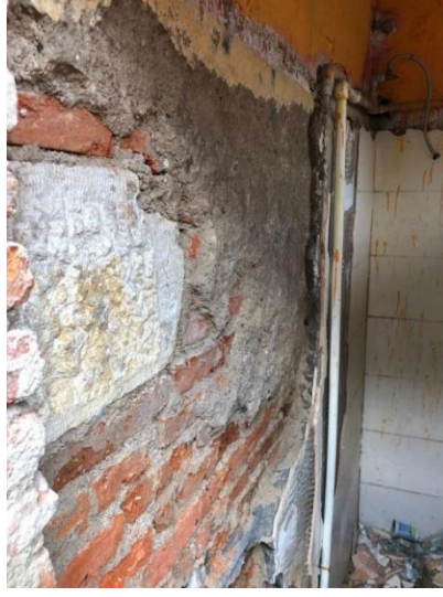
Şekil 5.8. Kırklareli kagir tuvalet yapısı- İç duvarlar çimento esaslı sıvanın raspasının yapıldığı görülmektedir.
