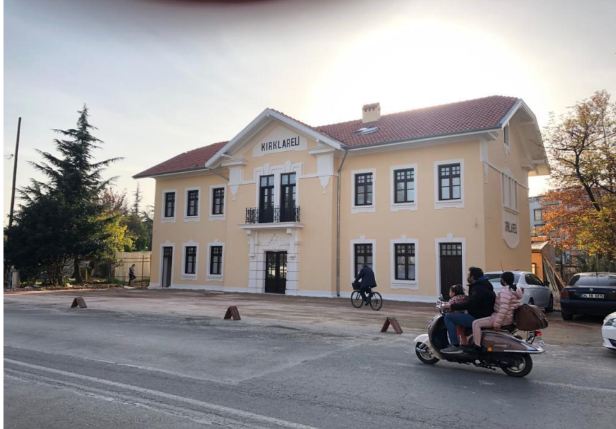
Şekil 6.107. Kırklareli Gar Binası Batı ve Kuzey cepheleri, cephe boyası imalatlarının tamamlanmış hali görülmektedir.
