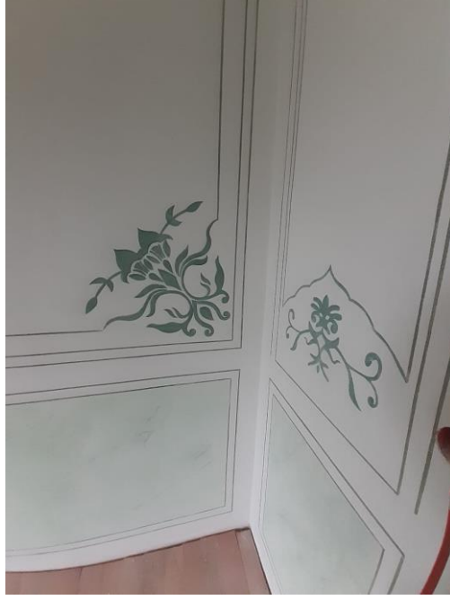
Şekil 6.127. Kırklareli Gar Binası 106 numaralı odanın duvarlarındaki kalem işi motifleri, filetolar ve mermer taklidi uygulaması görülmektedir.
