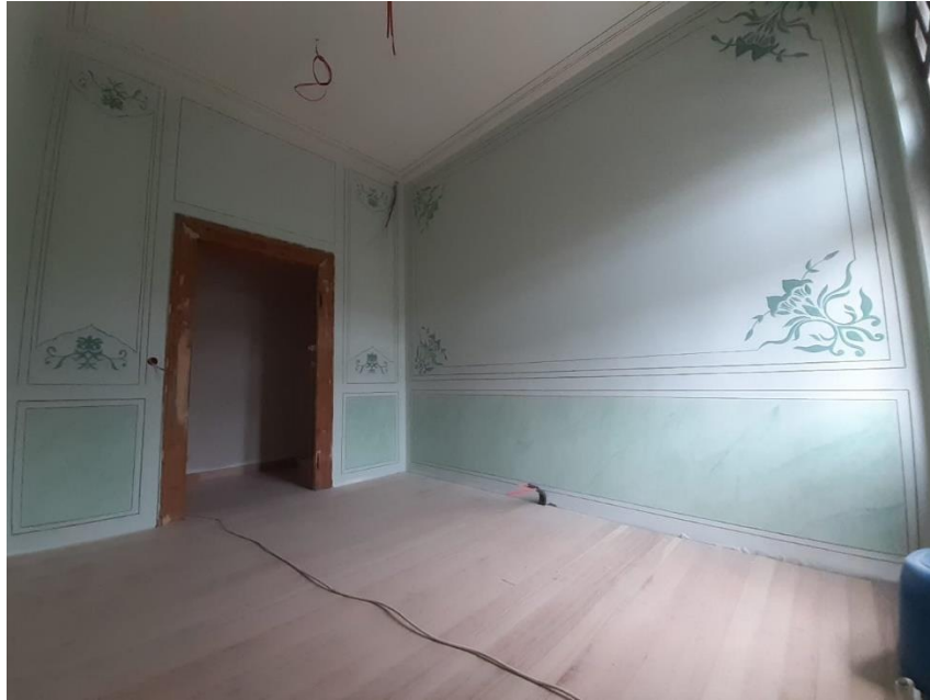
Şekil 6.126. Kırklareli Gar Binası 106 numaralı odanın duvarlarında ve tavanında kalem işi uygulaması bitmiş hali görülmektedir.
