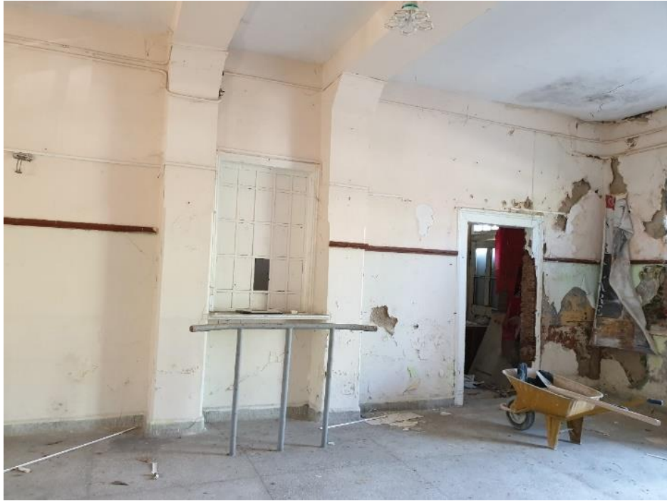
řekil 4.12. Z02 numaralı odanın bir kısmı yok olmuř kapı kasası,kanadı korunamamıřtır.
