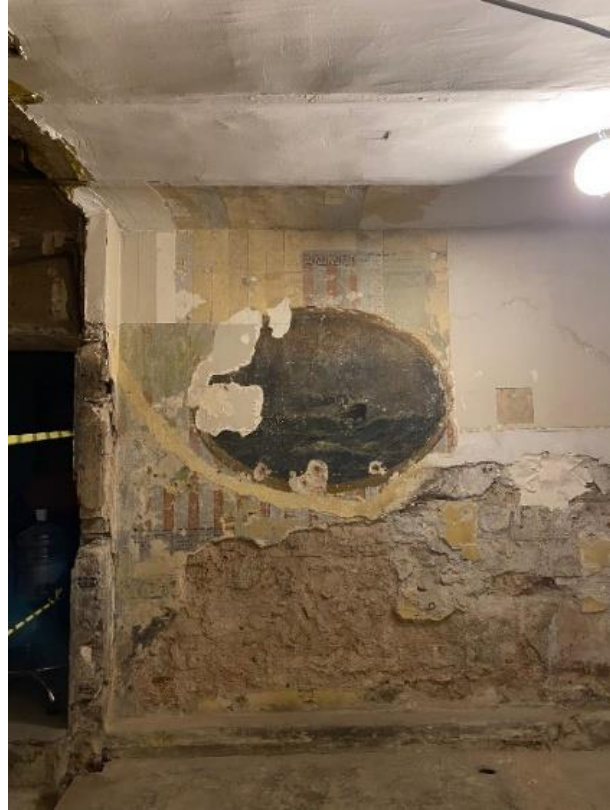
Şekil 5.11. St. Pierre Han- Araştırma raspası sonucu bulunan motif ve dönem renkleri görülmektedir.
