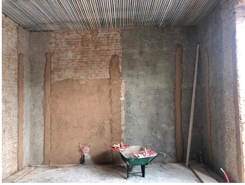
Şekil 6.81. Kaba sıva uygulaması önce 113 numaralı odada uygulanan sıva anoları görülmektedir.
