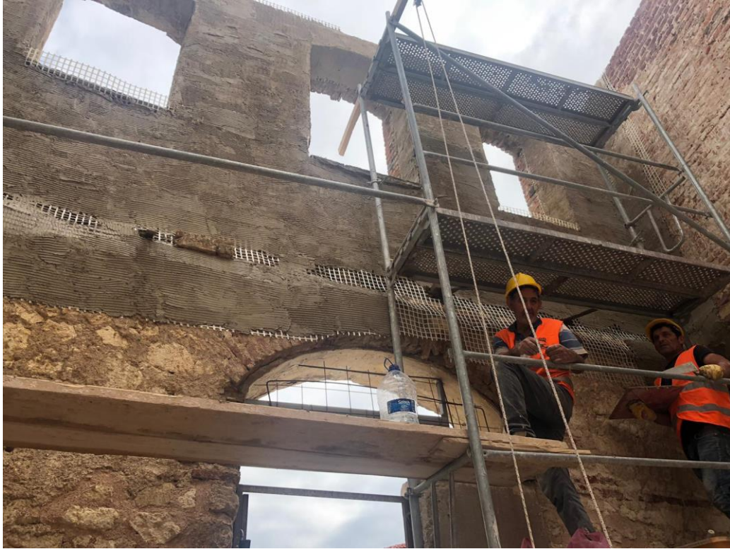
Şekil .6. Kırklareli Kaptan’ın Evi- Tuğla duvarlara uygulanan karbon fiberli güçlendirme filesi uygulaması görülmektedir.
