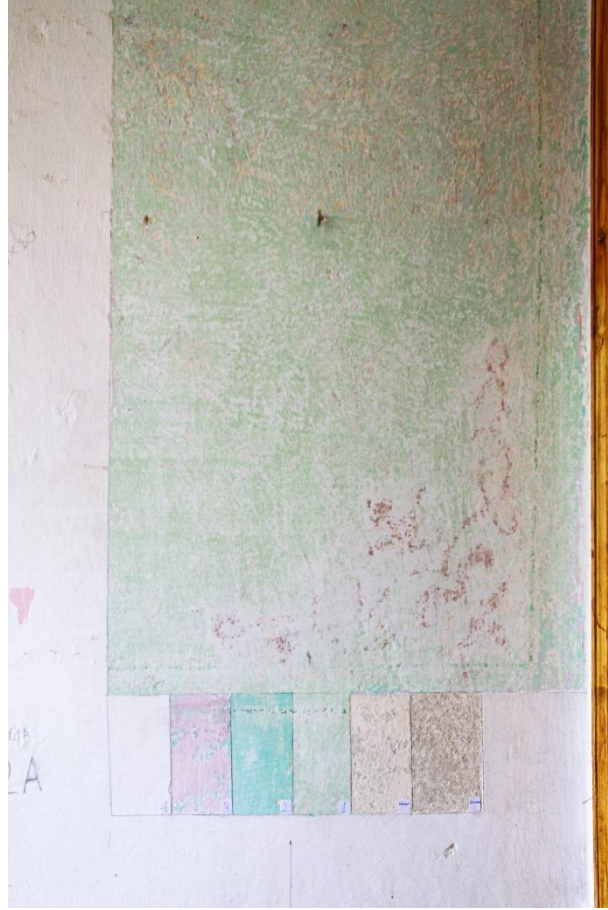
Şekil 6.51. 105 numaralı odanın duvarında yapılan 6 katman boya raspası ve 1.dönem köşe motifi görülmektedir.
