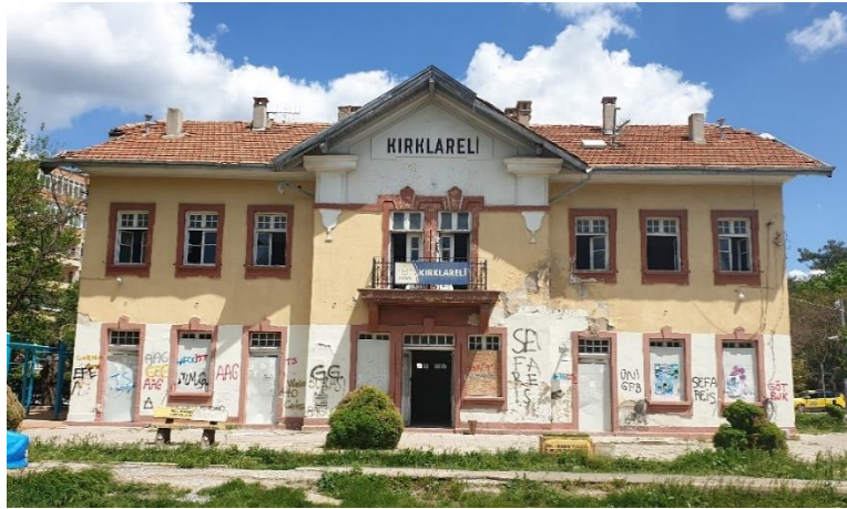
Şekil 4.11. Kırklareli Gar Binası Batı cephesi (Güven, 2020)
