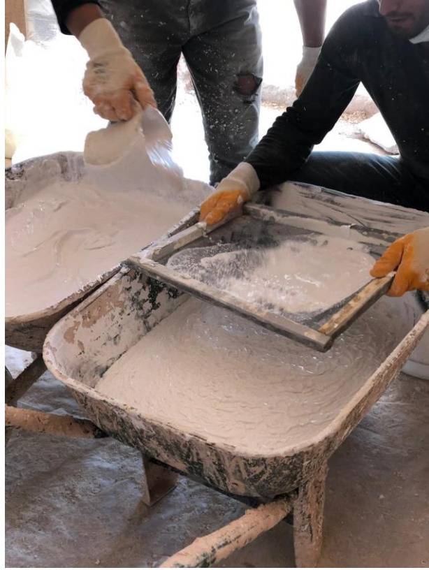
Şekil 6.85. Yapının nefaset sıvasının harcının içindeki kaymak kireç harca elenerek konulmuştur.
