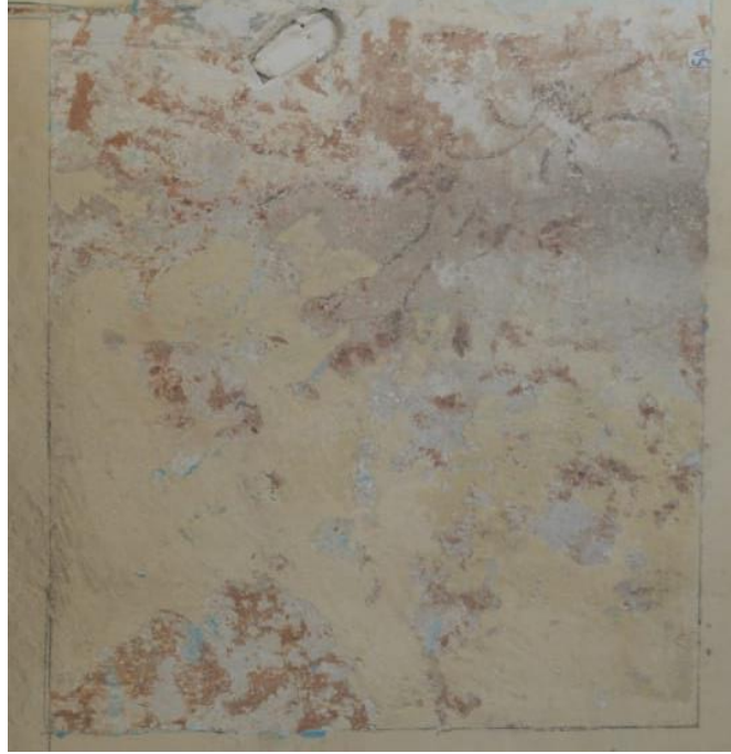
Şekil 6.58. 108 numaralı odanın batı duvarının köşesinde çıkan köşe motifi görülmektedir.
