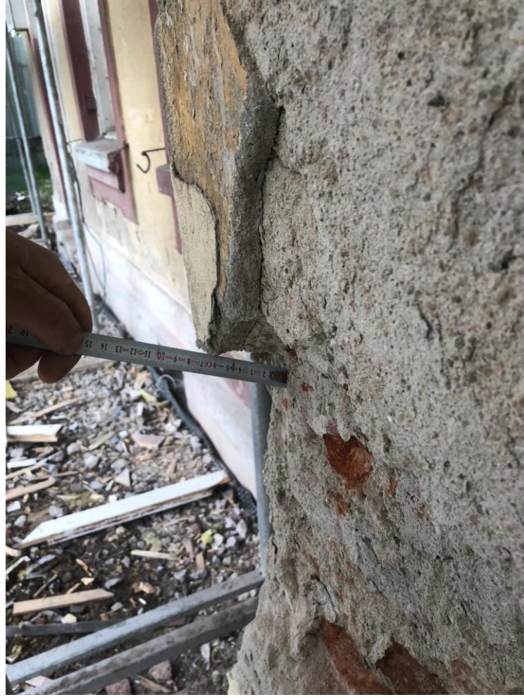
Şekil 6.75. Yapının Kuzey cephesindeki çimento esaslı sıva ve raspa uygulaması görülmektedir.
