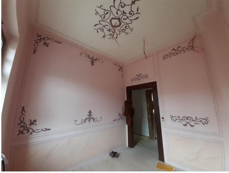
Şekil 6.124. Kırklareli Gar Binası 105 numaralı odanın duvarlarında ve tavanında kalem işi uygulaması bitmiş hali görülmektedir.
