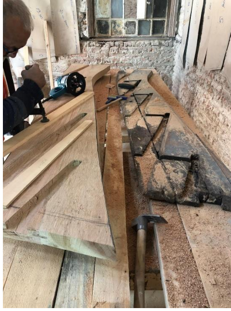
Şekil 6.156. Yeniden imalatı yapılan ve özgün taşıyıcı kiriş görülmektedir.
