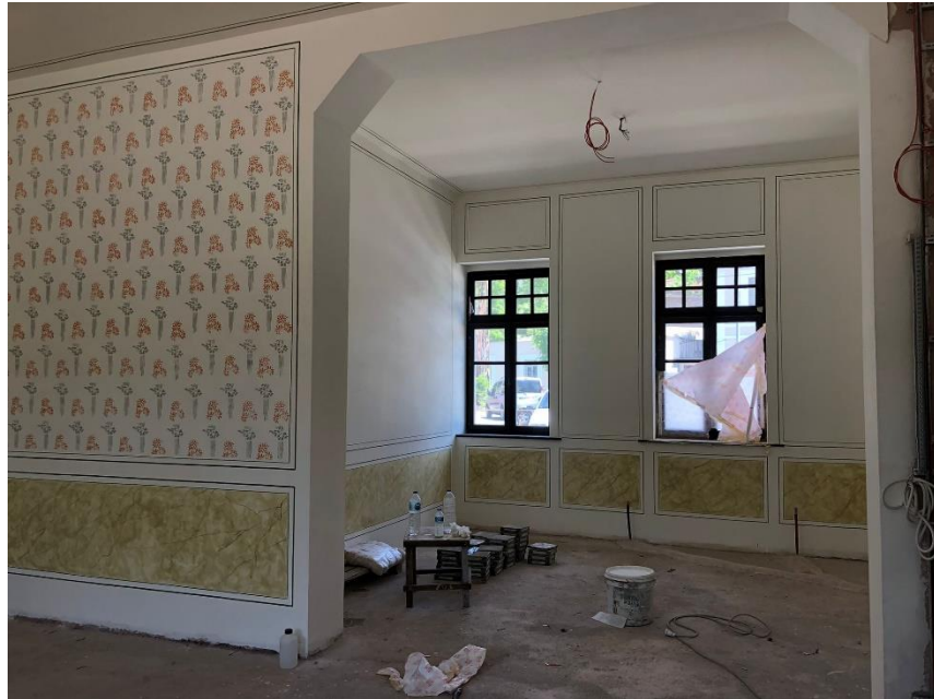
Şekil 6.115. Kırklareli Gar Binası Z05 numaralı odanın duvarlarına uygulanan kalem işi görülmektedir.
