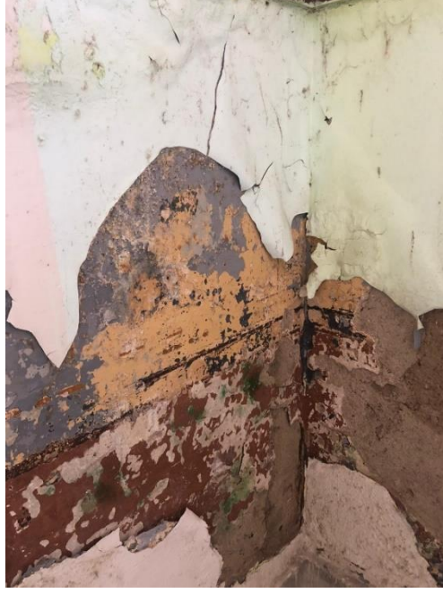
Şekil 6.36. Yapıda kalem işi olduğuna dair şüphe uyandıran Z01 numaralı odanın filetoları görülmektedir.
