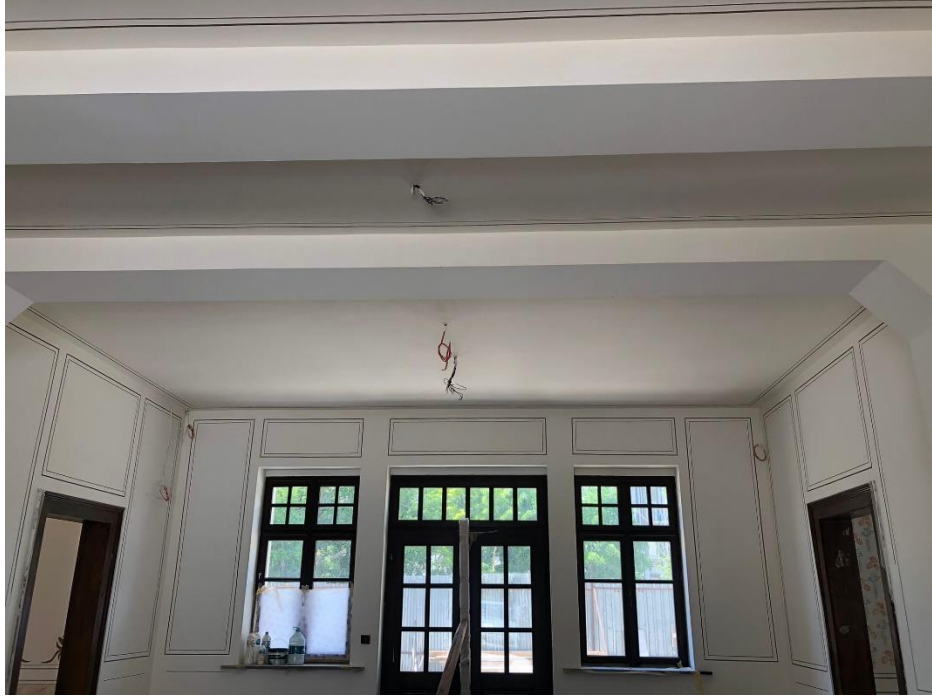
Şekil 6.109. Kırklareli Gar Binası Z01 numaralı odanın duvarlarına uygulanan filetolar görülmektedir.
