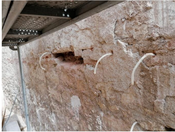
Şekil 5.9. Kırklareli Kaptan’ın Evi tuğla duvarlara uygulanan enjeksiyon uygulaması görülmektedir.
