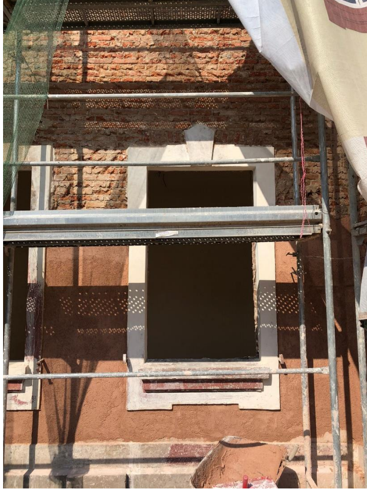
Şekil 6.90. Yapının Doğu cephesindeki kaba sıva uygulaması görülmektedir.
