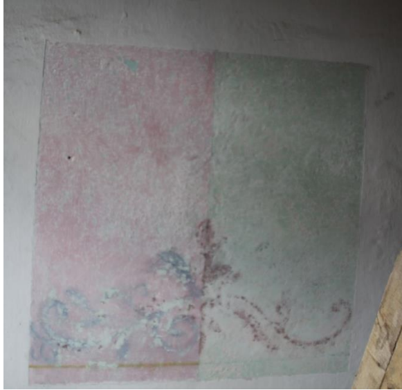
Şekil 6.53. 105 numaralı odanın güney duvarının köşesinde çıkan 1. Ve 2. Dönem renk ve motifleri görülmektedir.
