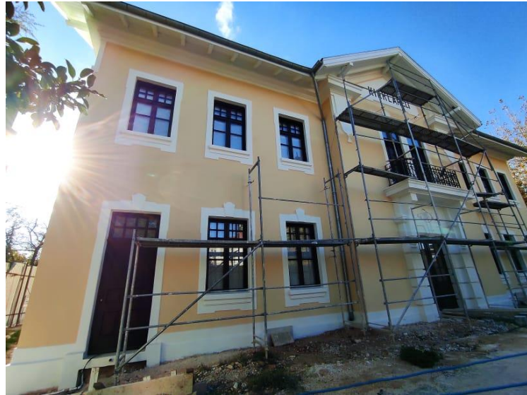
Şekil 6.167. Yapının Güney cephesinde yeniden imalatı yapıp montajı tamamlanan çift kanatlı pencereler görülmektedir.
