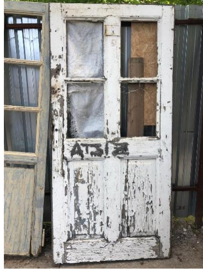
Şekil 6.161. Yapının Güney cephesindeki tek kanatlı giriş kapısının mevcut durumu.
