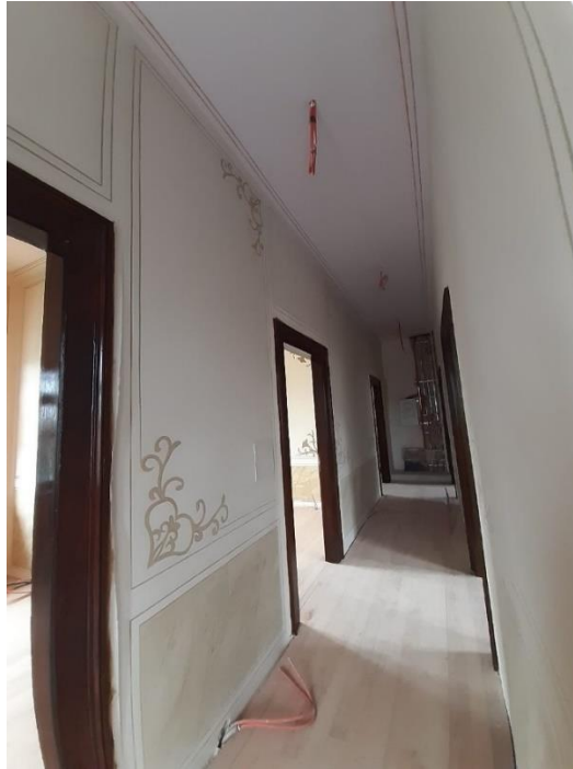
Şekil 6.132. Kırklareli Gar Binası 112 numaralı koridorun duvarlarındaki kalem işi motifleri, filetolar ve mermer taklidi uygulaması görülmektedir.
