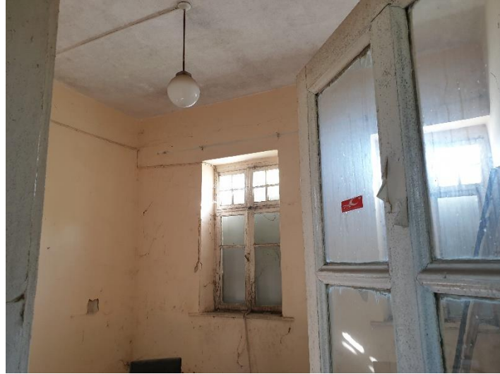
Şekil 3.23. Z04 numaralı odanın kapısı ve penceresi görülmektedir.
