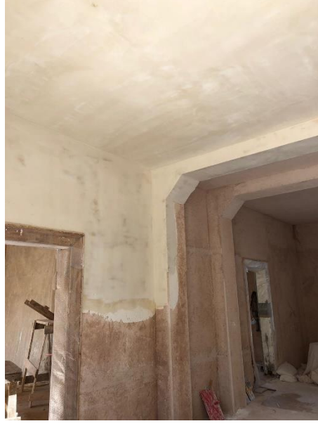
Şekil 6.86. Yapının Z01 numaralı giriş salonunda horasan esaslı kaba sıvası üzerine nefaset sıvasının uygulaması görülmektedir.
