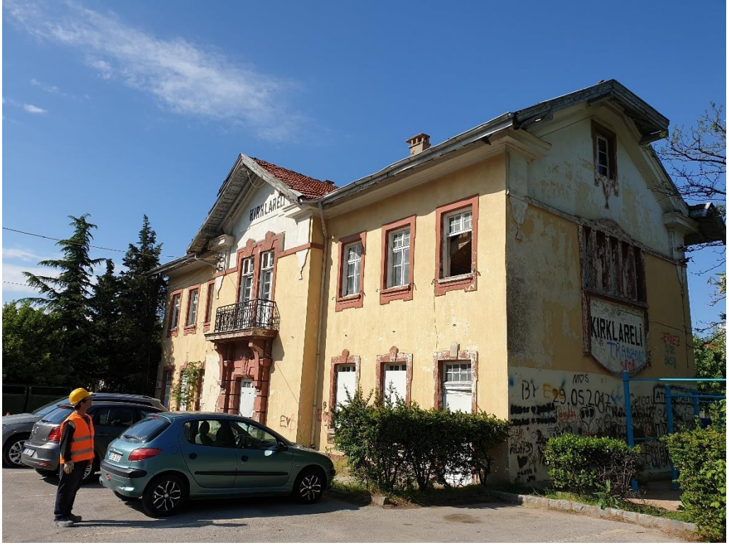
Şekil 3.18. Yapının Doğu ve Güney cephesi görülmektedir.
