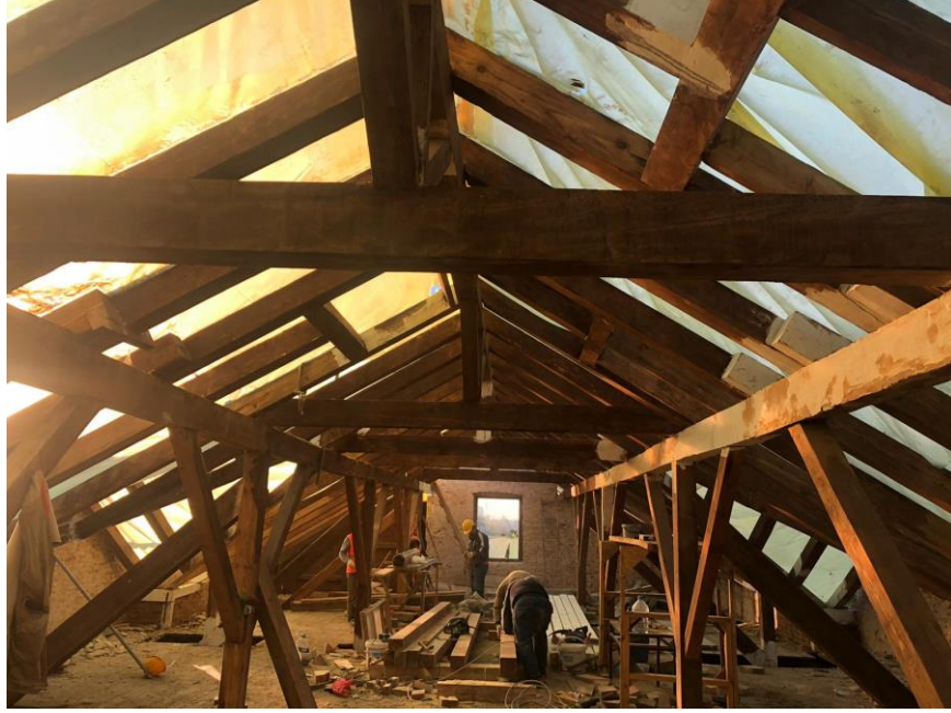
Şekil 6.5. Emprenyesi uygulanan çatı taşıyıcıları görülmektedir.
