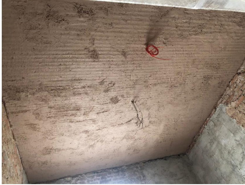
Şekil 6.82. Kaba sıva uygulanan 115 numaralı odanın tavanı görülmektedir.
