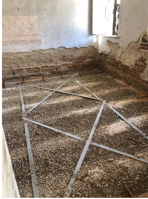
Şekil 6.25. Zemin kat zemin döşemesi olan volta döşemedeki I profillere 50/10 lama ile yapılan güçlendirme uygulaması görülmektedir.
