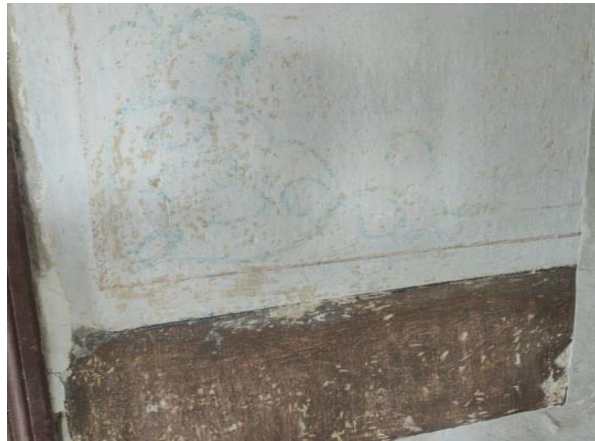
Şekil 6.62. 112 numaralı koridorun batı duvarında bulunan köşe motifinin, filetonun ve mermer taklidinin izleri görülmektedir.
