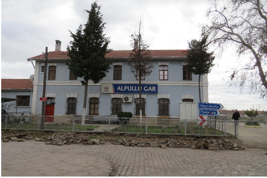
Şekil 1.9. Alpullu Gar Binası (Kırklareli Müzesi Arşivi, 2020)
