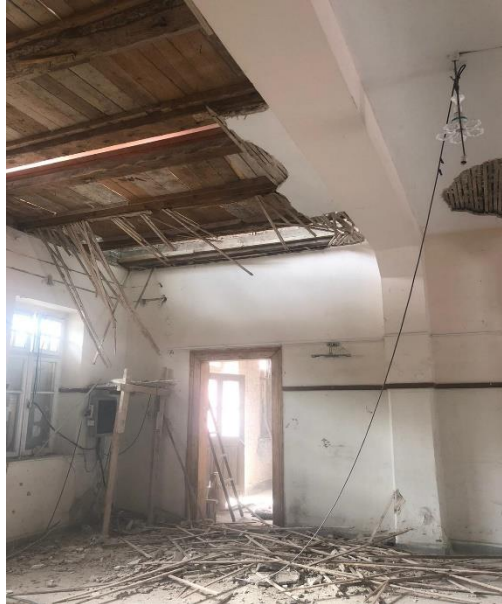
Şekil 6.74. Z01 numaralı odanın bağdadi tavanındaki sıva raspası uygulaması görülmektedir.
