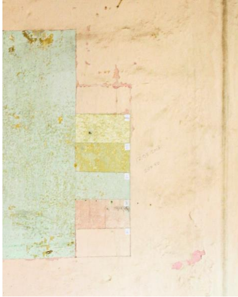
Şekil 6.61. 109 numaralı odanın güney duvarında yapılan sıva raspalarının katmanları görülmektedir.
