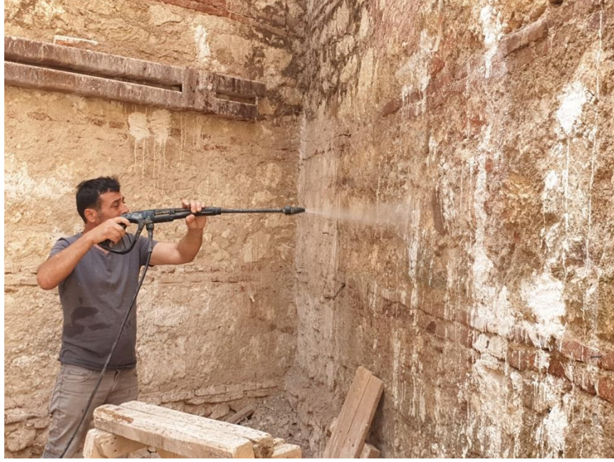
Şekil 5.5. Kırklareli Kaptan'ın Evi- Tuğla duvarlara basınçlı su ile temizlik müdahalesi görülmektedir.
