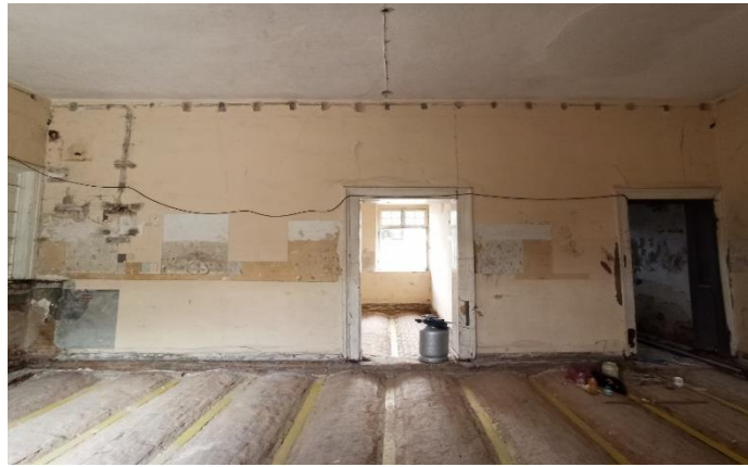
Şekil .40. Z02 numaralı odanın duvarlarında yapılan araştırma raspaları görülmektedir.
