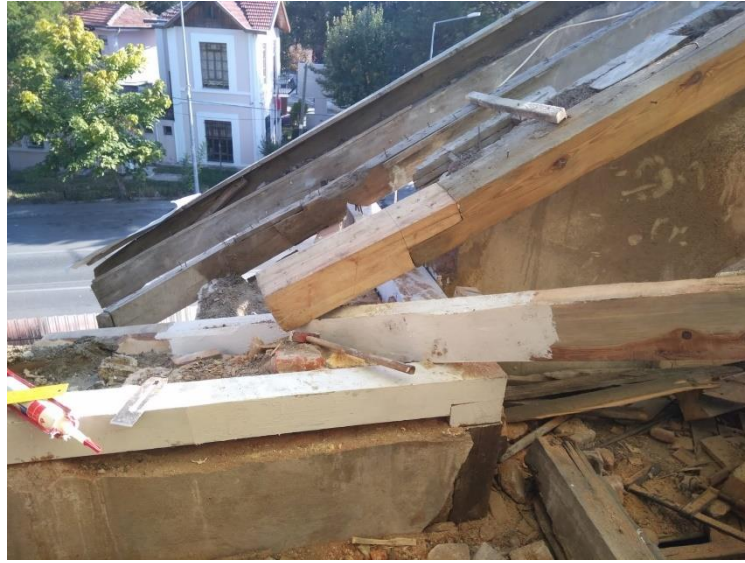
Şekil 6.4. Tamir ve tahkimi yapılan ahşap taşıyıcılar görülmektedir.
