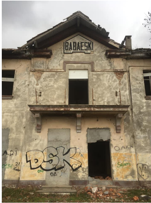
Şekil 1.4. Babaeski Gar Binası
