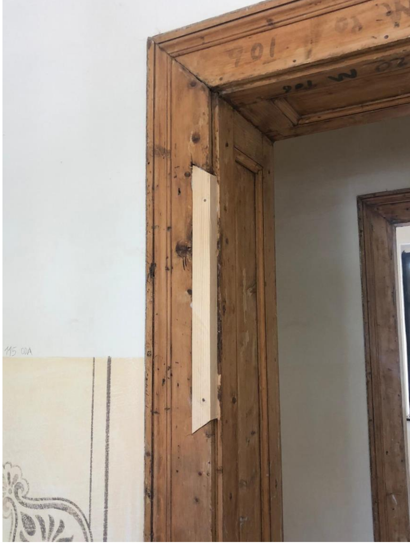
Şekil 6.147. Kırklareli Gar Binası 115 numaralı odasının kapı kanadında yapılan tamamlama görülmektedir.
