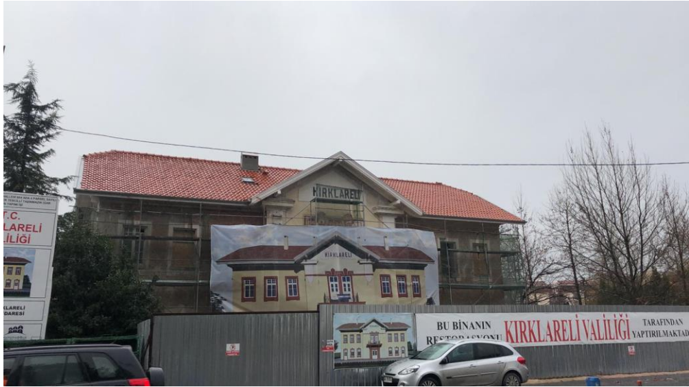
Şekil 6.77. Yapının Güney cephesinde sıva raspası tamamlanmış hali görülmektedir.
