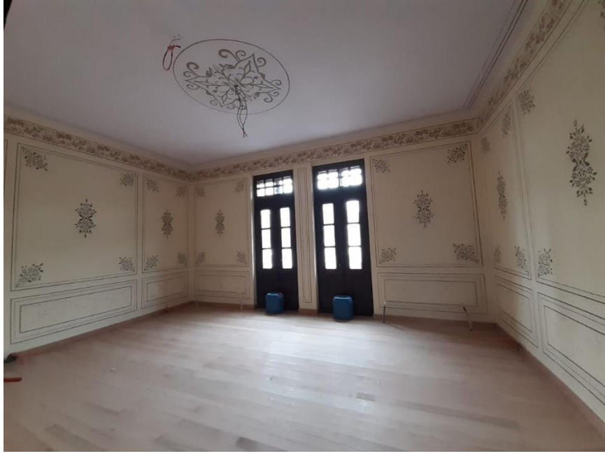
Şekil .139. Kırklareli Gar Binası 114 numaralı odasının duvarlarındaki kalem işi motifleri, filetolar ve mermer taklidi uygulaması görülmektedir.
