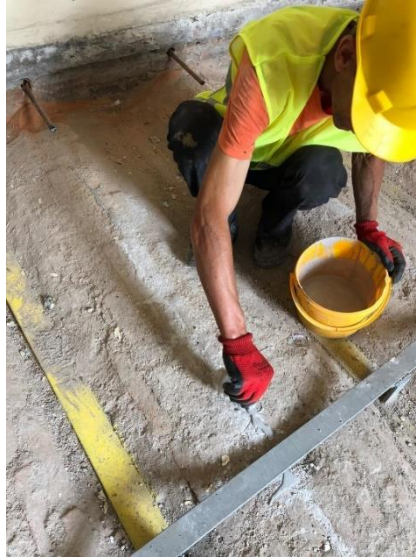
Şekil 6.24. Zemin kat zemin döşemesi olan volta döşemedeki tuğla döşemelerdeki çatlaklara enjeksiyon uygulaması yapıldığı görülmektedir.
