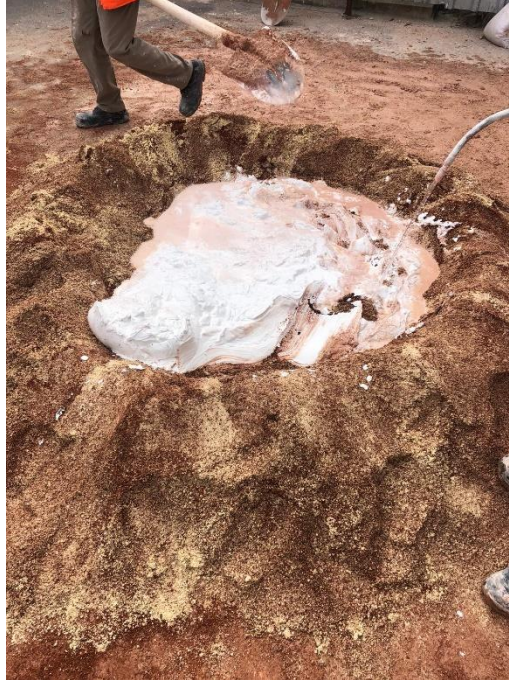
Şekil 6.80. Kaba sıva uygulaması mayalanmak üzere hazırlanan horasan harç hazırlığı görülmektedir.
