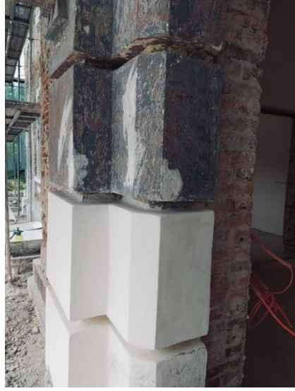
Şekil 6.92. Yapının Batı cephesindeki ana giriş kapısının kenar sövelerinin konservasyonu görülmektedir.
