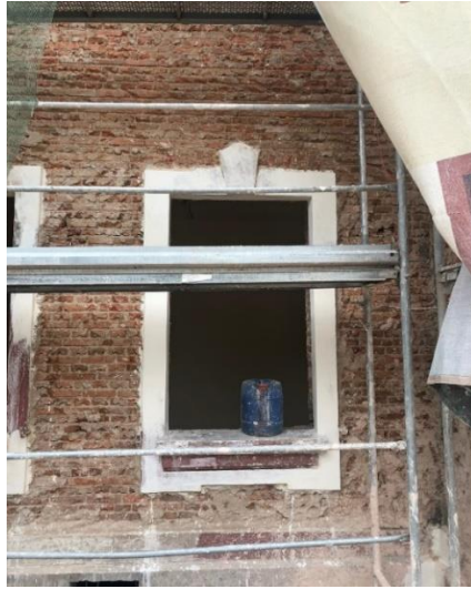
Şekil .93. Yapının Doğu cephesindeki pencere rozet ve kenar sövelerinin konservasyonu görülmektedir.
