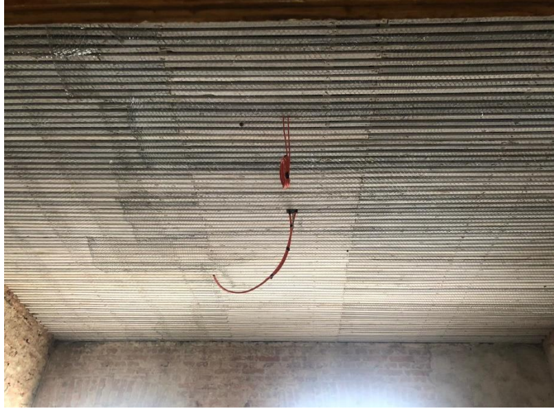
Şekil .79. Kaba sıva uygulaması öncesi bağdadî tavan üzerine rabitz teli uygulaması görülmektedir.
