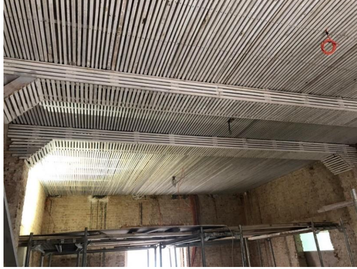
Şekil 6.19. Zemin kat tavanında ( Z01 giriş salonu) uygulanan bağdadi çıtalar görülmektedir.
