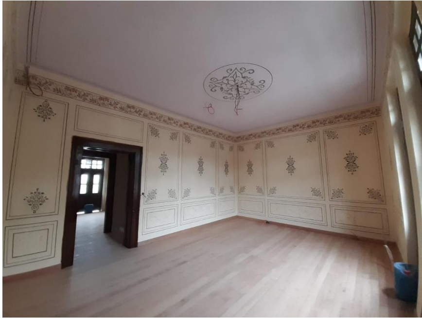
Şekil 6.138. Kırklareli Gar Binası 114 numaralı odasının duvarlarındaki kalem işi motifleri, filetolar ve mermer taklidi uygulaması görülmektedir.
