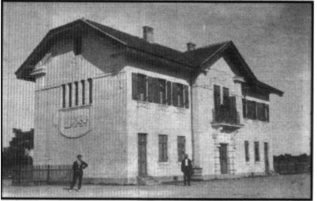
Şekil 3.5. Kırklareli Gar Binası İlk Fotoğrafi
