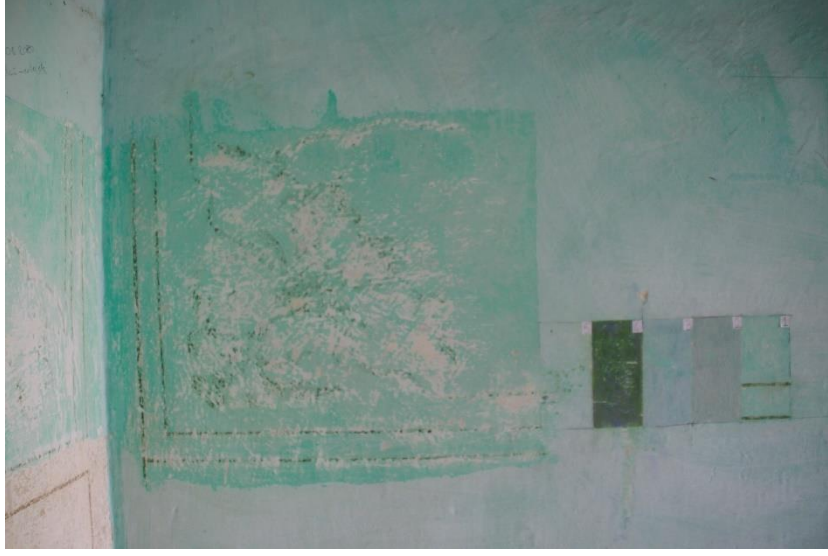
Şekil 6.55. 106 numaralı odanın kuzey duvarının köşesinde çıkan renk katmanları ve köşe motifi görülmektedir.
