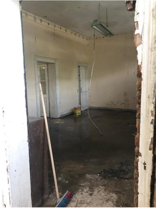
Şekil 3.17. Z02 numaralı odada artık var olmayan ahşap zemin döşemesi yerine atılan şap görülmektedir.
