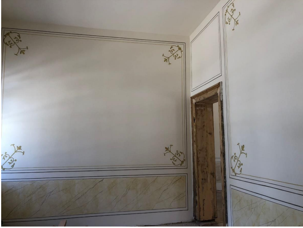
Şekil 6.113. Kırklareli Gar Binası Z04 numaralı odanın duvarlarına uygulanan kalem işi görülmektedir.
