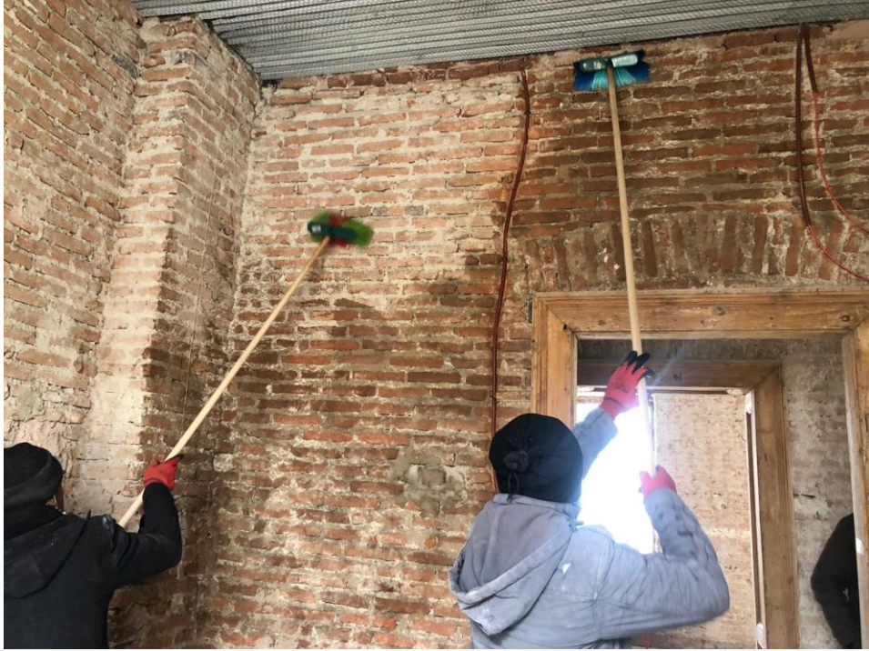
Şekil 6.78. Kaba sıva uygulaması öncesi tuğla duvarların temizlendiği görülmektedir.
