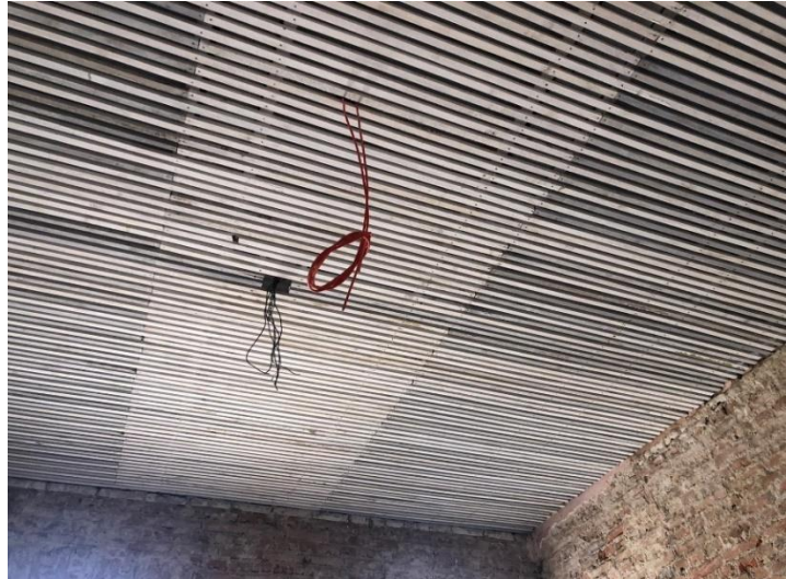
Şekil 6.20. Birinci kat tavanında ( 115 numaralı oda) uygulanan bağdadi çıtalar görülmektedir.
