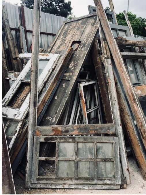
Şekil 6.162. Yapının Güney ve Kuzey cephelerindeki kapıların mevcut durumu.
