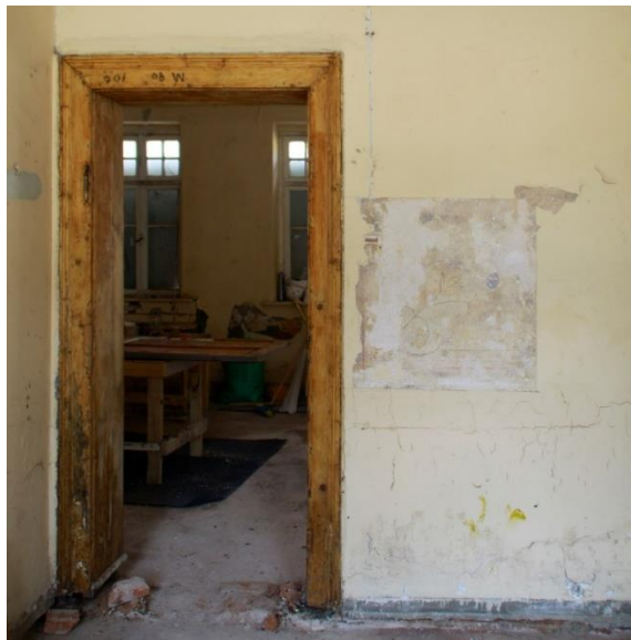
Şekil 6.43. Z04 numaralı odanın duvarında çıkan köşe motifi görülmektedir.
