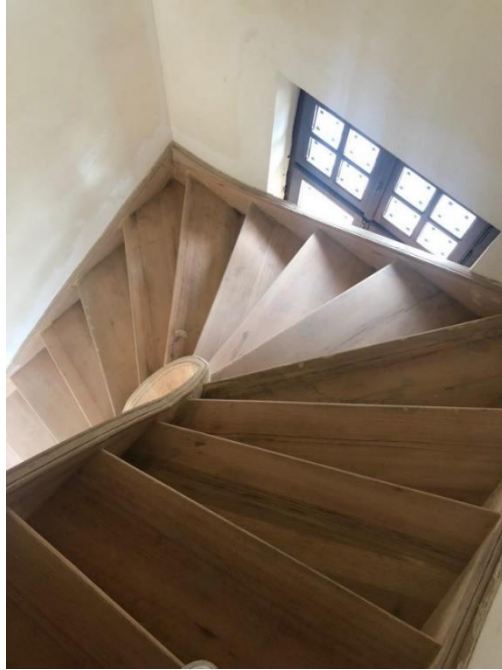
Şekil 6.159. Montajı yapılan merdiven basamakları görülmektedir.
