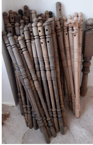
Şekil 6.157. Özgün merdiven küpeşterleri ve yeniden imalatı yapılan küpeşterler yanyana görülmektedir.
