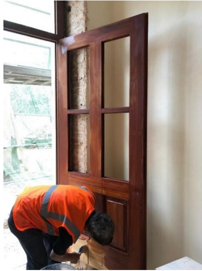
Şekil 6.164. Yapının Güney ve Kuzey cephelerindeki tek kanatlı giriş kapılarına emprenye uygulaması görülmektedir.
