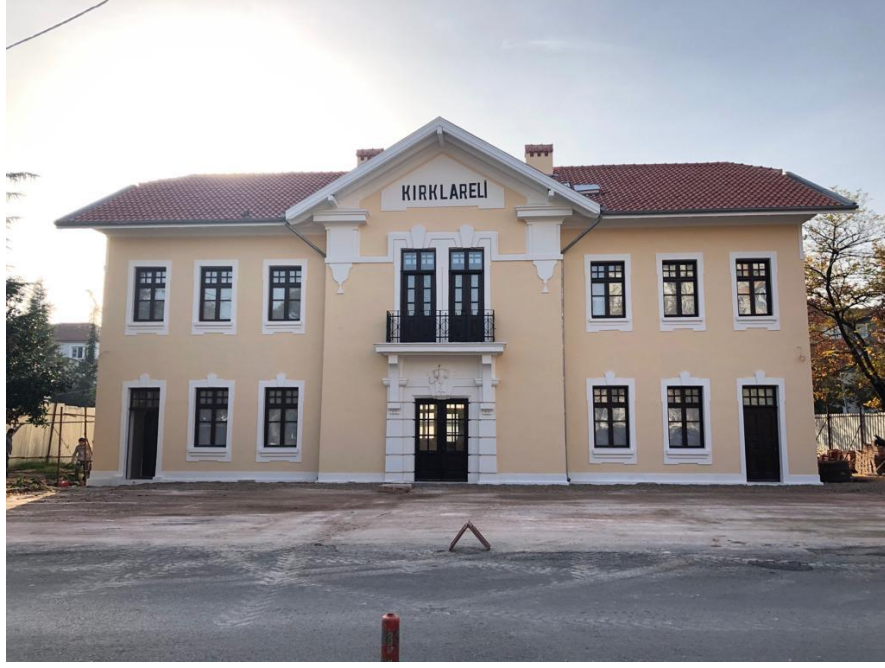
Şekil 6.106. Kırklareli Gar Binası Batı cephesi, cephe boyası imalatlarının tamamlanmış hali görülmektedir.
