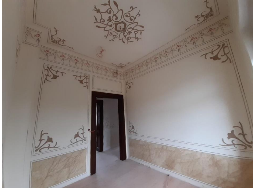
Şekil 6.130. Kırklareli Gar Binası 108 numaralı odanın duvarlarındaki kalem işi motifleri, filetolar ve mermer taklidi uygulaması görülmektedir.
