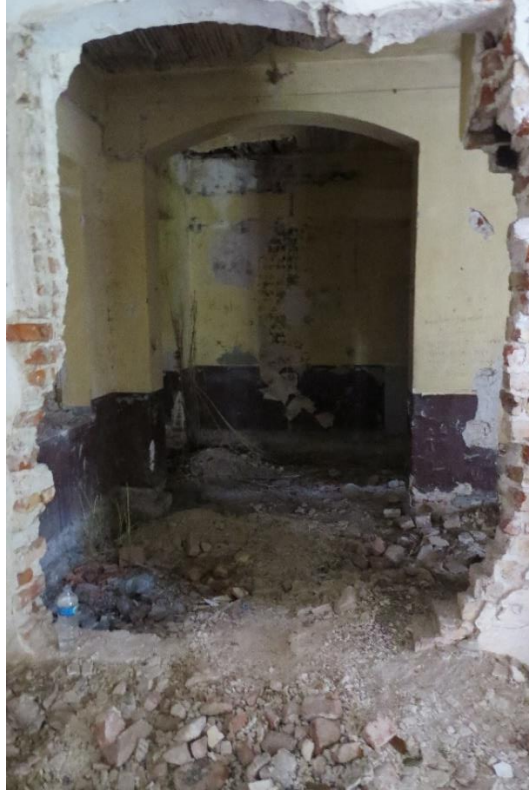
Şekil 1.6. Büyük Mandıra Gar Binası Zemin Katı
