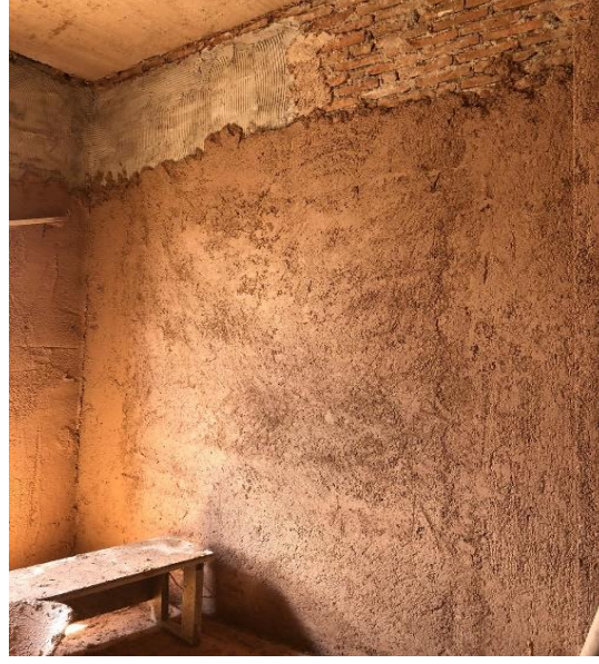
Şekil 6.83. Kaba sıva uygulanan 104 numaralı odanın duvarları görülmektedir.
