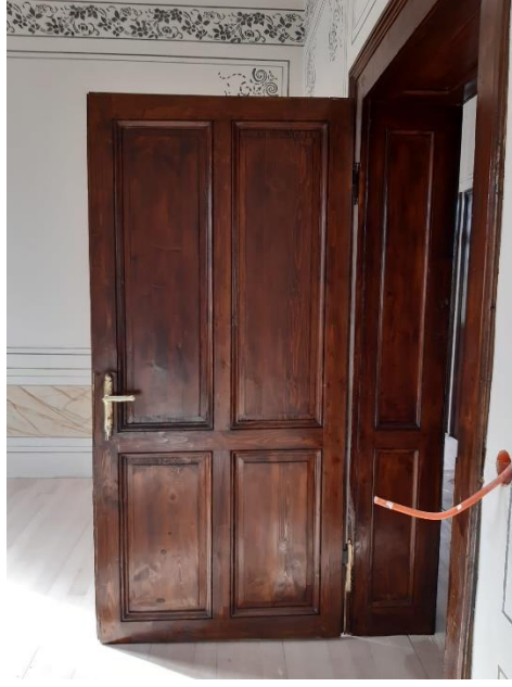
Şekil 6.152. Kırklareli Gar Binası 113 numaralı odasının kapısının boya ve montajı bitmiş hali görülmektedir.
