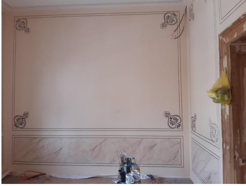
Şekil 6.142. Kırklareli Gar Binası 115 numaralı odasının duvarlarındaki kalem işi motifleri, filetolar ve mermer taklidi uygulaması görülmektedir.
