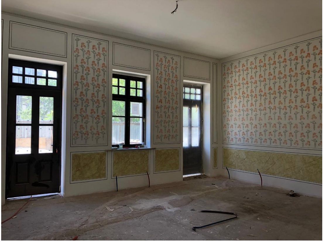
Şekil 6.117. Kırklareli Gar Binası Z07-8 numaralı odanın duvarlarına uygulanan kalem işi görülmektedir.
