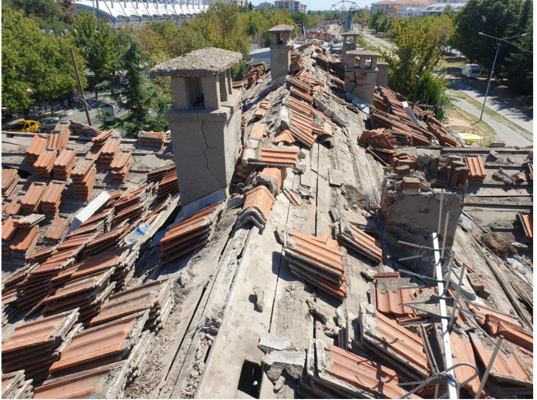
Şekil 6.1. Yapının marsilya tipi kiremitlerinin ve çürüyen ahşap kaplamalarının sökülmesi görülmektedir.
