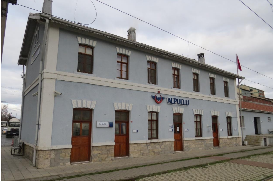
Şekil 1.8. Alpullu Gar Binası ray cephesi
