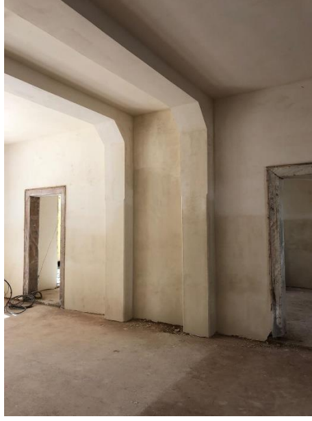
Şekil 6.88. Yapının Z01 numaralı giriş salonunun nefaset sıva uygulaması biten hali görülmektedir.
