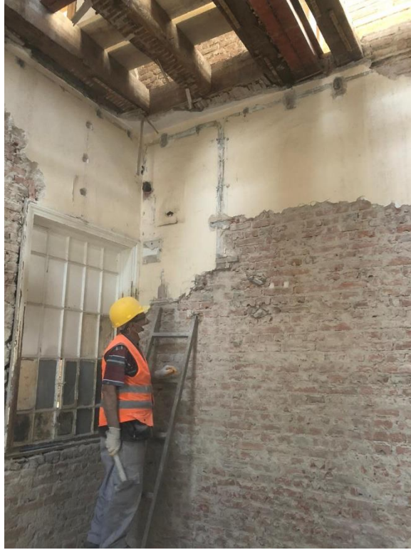
Şekil 6.72. Z02 numaralı odanın kuzey duvarında sıva raspası uygulaması görülmektedir.
