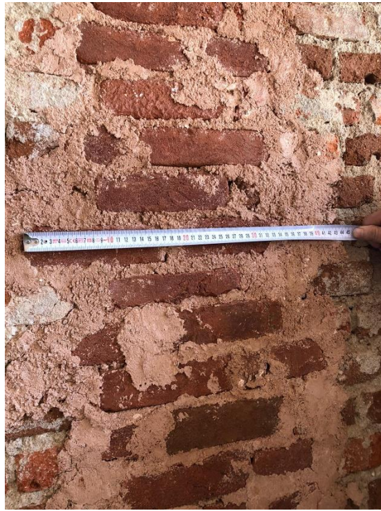
Şekil 6.31. Yapı Güney cephesinde yapılan tuğla dikiş görülmektedir.
