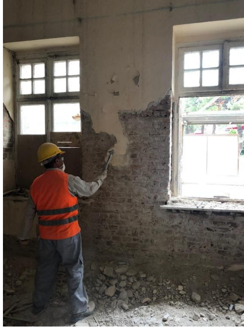
Şekil 6.73. Z05 numaralı odanın batı duvarında sıva raspası uygulaması görülmektedir.
