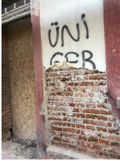
Şekil 6.76. Yapının Güney cephesindeki çimento esaslı sıva ve raspa uygulaması görülmektedir.
