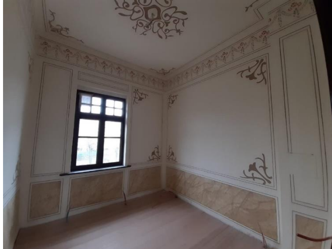
Şekil 6.129. Kırklareli Gar Binası 108 numaralı odanın duvarlarındaki kalem işi motifleri, filetolar ve mermer taklidi uygulaması görülmektedir.
