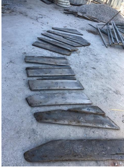
Şekil 6.155. Numaranlandırılarak sökülen merdiven basamakları görülmektedir.
