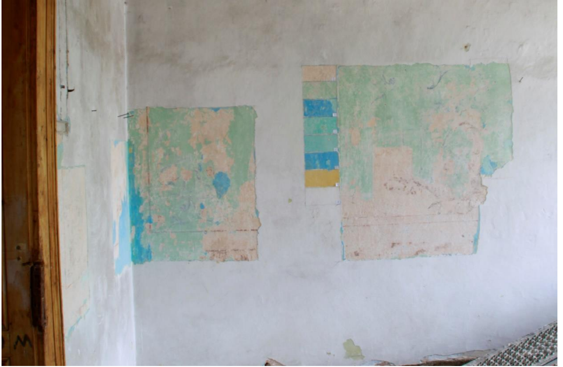
Şekil 6.69. 115 numaralı odanın kuzey duvarında raspası yapılan 7 katman boya raspası görülmektedir.
