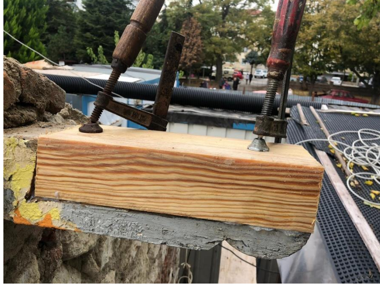
Şekil 5.2. Kırklareli kagir tuvalet yapısı- Tamamlaması yapılan çatı kirişi
