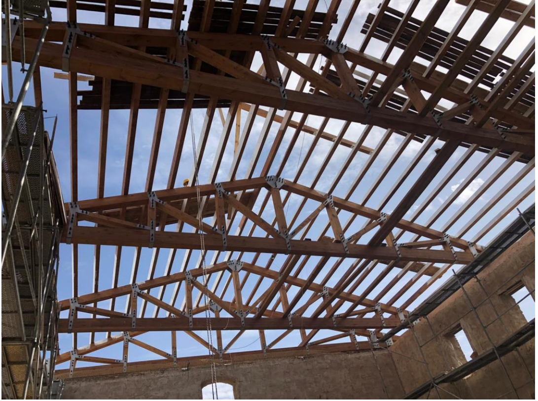
Şekil 5.13. Kırklareli Kaptan’ın Evi yeniden yapılan çatı makasları görülmektedir.
