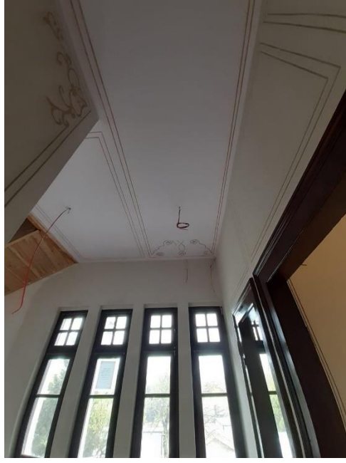
Şekil 6.133. Kırklareli Gar Binası 112 numaralı koridorun tavanındaki kalem işi motifleri, fileto uygulaması görülmektedir.
