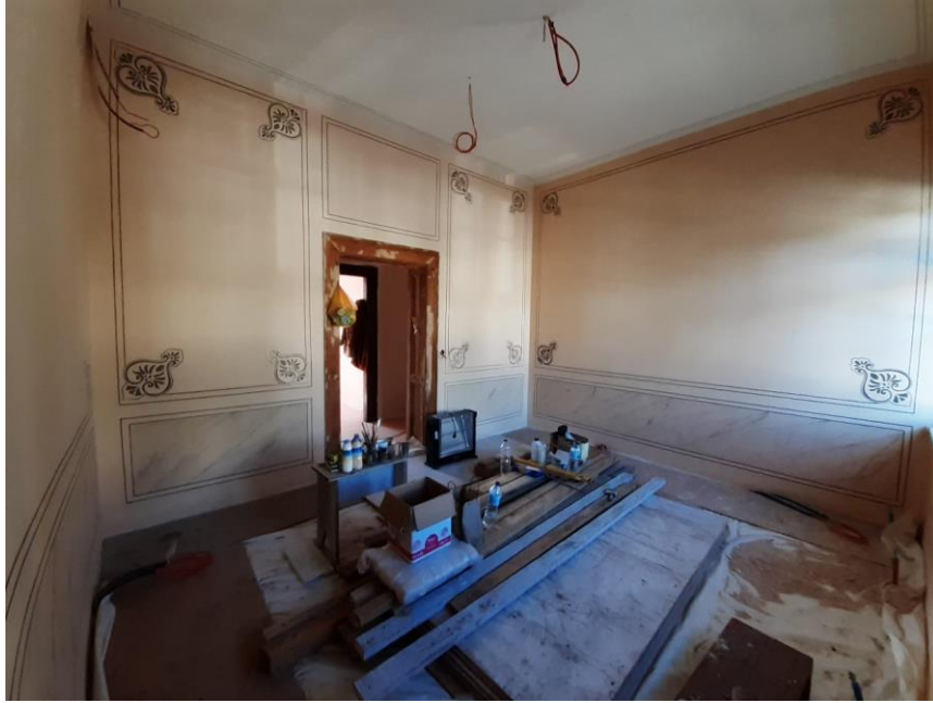
Şekil 6.141. Kırklareli Gar Binası 115 numaralı odasının duvarlarındaki kalem işi motifleri, filetolar ve mermer taklidi uygulaması görülmektedir.
