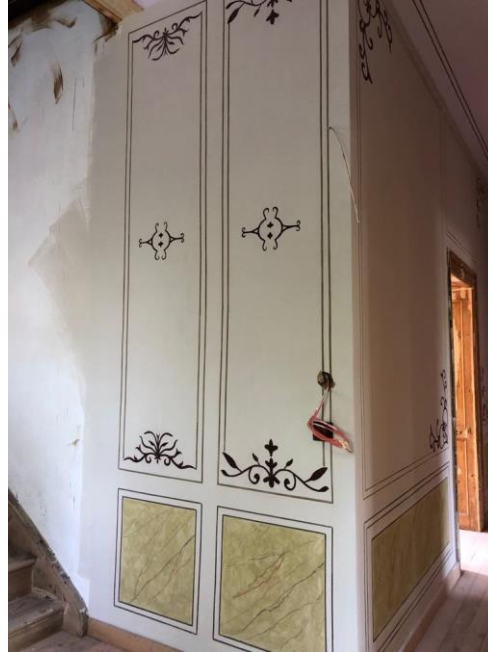
Şekil .119. Kırklareli Gar Binası 101 numaralı koridorun duvarlarına uygulanan kalem işi görülmektedir.
