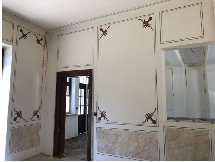
Şekil 6.111. Kırklareli Gar Binası Z02 numaralı odanın duvarlarına uygulanan kalem işi görülmektedir.
