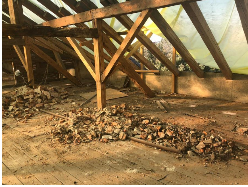
Şekil 6.2. Raspa ve zımpara uygulaması biten çatı taşıyıcıları
