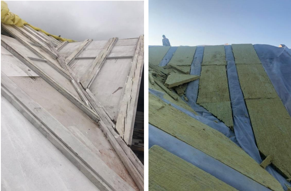
Şekil 6.6-7. Çatı taşıyıcılarının yangın geciktirici,playwood kaplama ve taş yünü serilmiş durumu görülmektedir.
