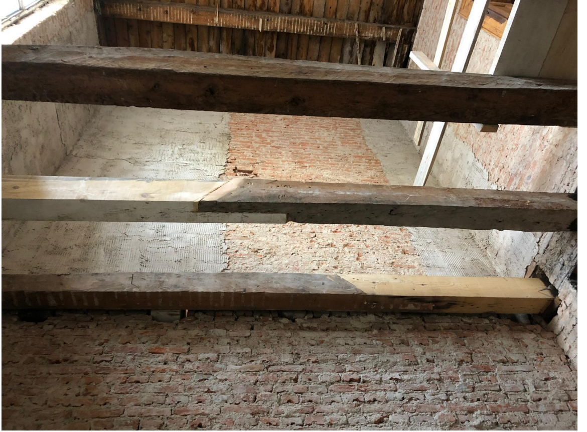
Şekil 6.14. Zemin kat tavanındaki tamir ve tahkimi yapılan ana taşıyıcı kirişler
