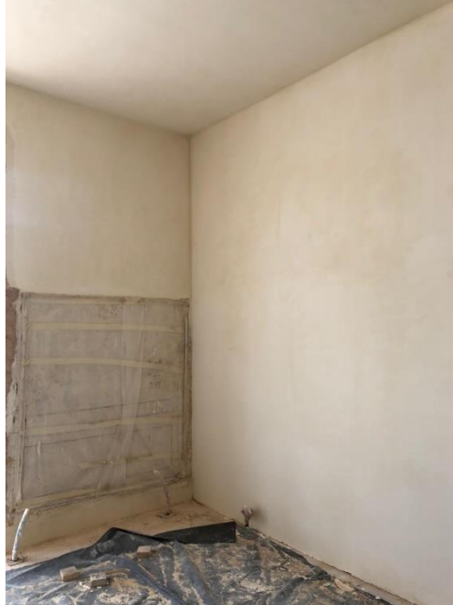
Şekil 6.89. Yapının 114 numaralı salonunun nefaset sıva uygulaması biten hali görülmektedir.
