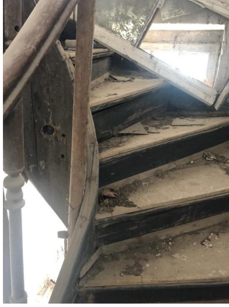
Şekil 6.154. Geçirdiği yangın sonrası taşıyıcılık özelliğini kaybeden merdiven basamakları görülmektedir.
