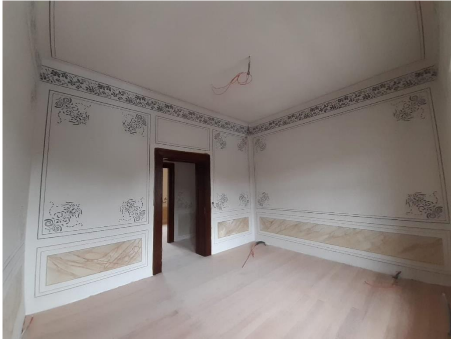
Şekil 6.135. Kırklareli Gar Binası 113 numaralı odasının duvarlarındaki kalem işi motifleri, filetolar ve mermer taklidi uygulaması görülmektedir.
