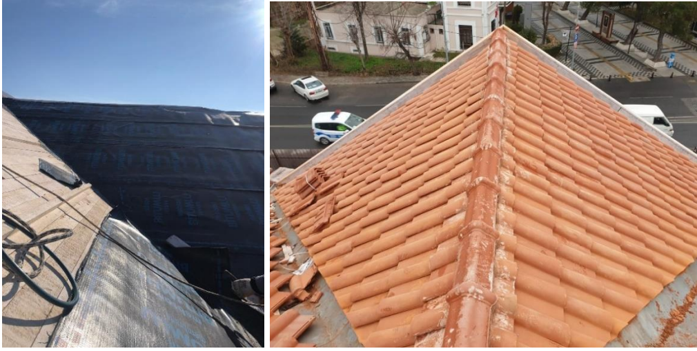
Şekil 6.8-9. Çatı kaplama tahtaları üzerine yapılan su yalıtımı membran uygulaması ve valensiya kiremitlerinin uygulaması görülmektedir.
