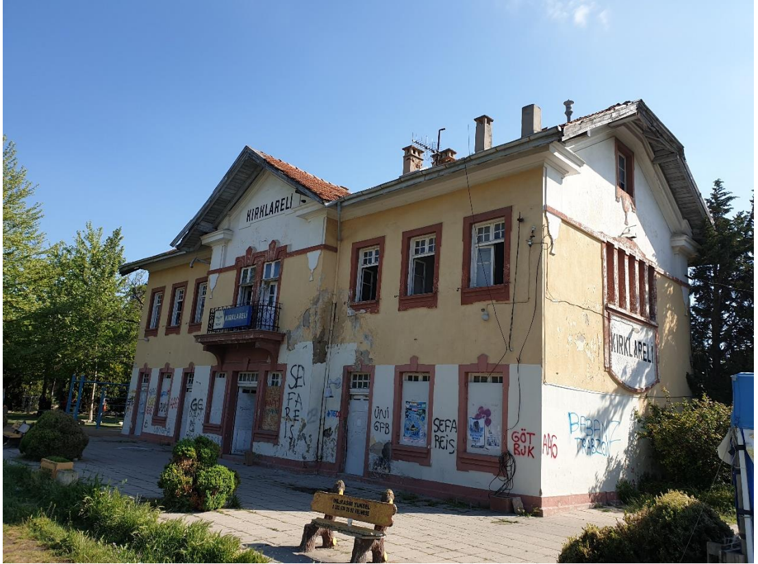
Şekil 4.7.Kırklareli Gar Binası Batı ve Kuzey cephesi
