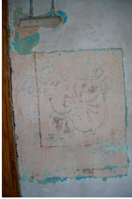
Şekil 6.70. 115 numaralı odanın batı duvarında raspa sonrası ortaya çıkan köşe motifin izleri görülmektedir.
