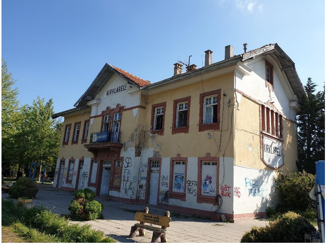
Şekil .19. Yapının Batı ve Kuzey cephesi görülmektedir.
