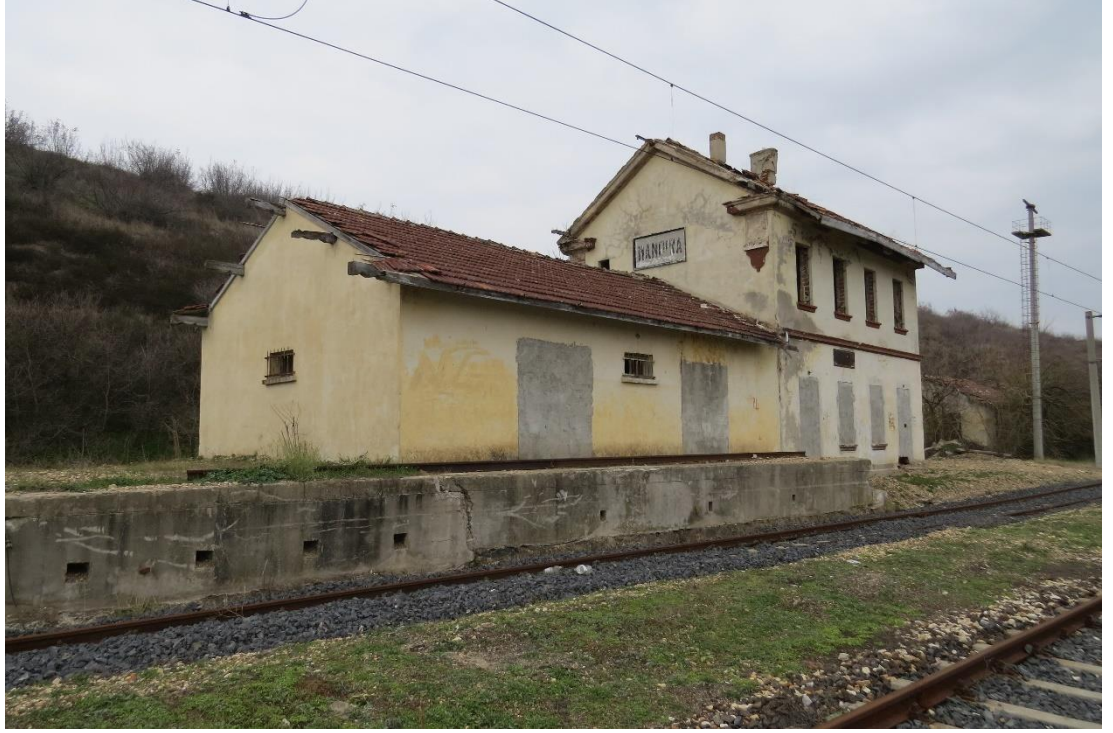
Şekil 1.5. Büyük Mandıra Gar Binası
