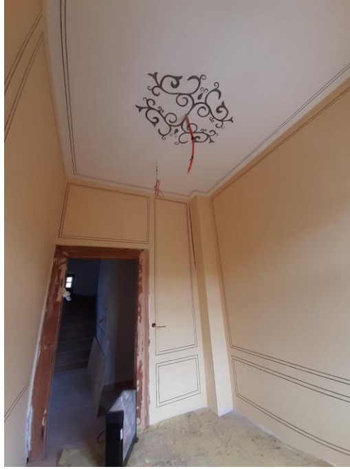
Şekil 6.121. Kırklareli Gar Binası 104 numaralı odanın kalem işi uygulaması bitmiş hali görülmektedir.
