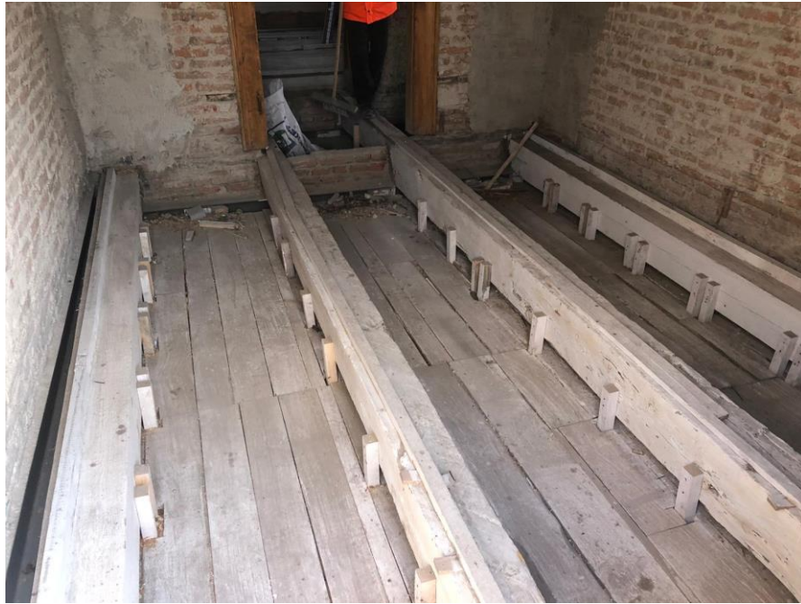
Şekil 6.18. Birinci kat zemin döşemesinde tamir ve tahkimi yapılan ana taşıyıcı kirişler ve kaplama tahtaları görülmektedir.
