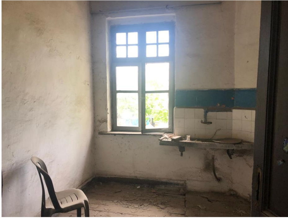
Şekil 3.14. 109 numaralı odaya eklenen mutfak tezgahı görülmektedir.
