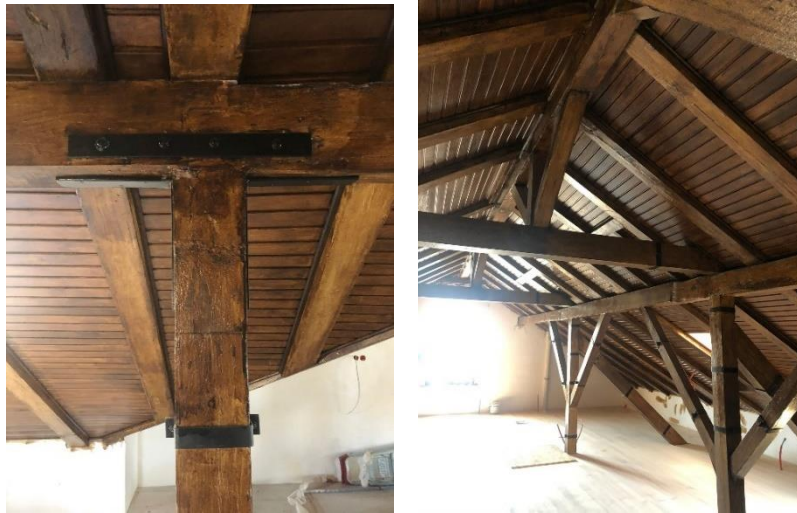
Şekil 6.10-11. Çatı taşıyıcılarının lama kelepçe ve su bazlı ahşap koruyucu boya uygulanmış son halleri.
