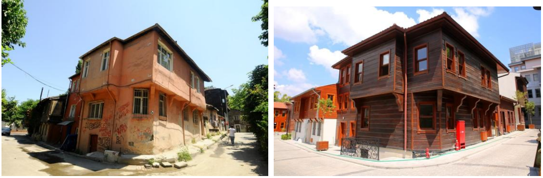
Resim 2.30 Ayvansaray dönüşüm öncesi ve sonrası yapı fotoğrafları (Url-29)
