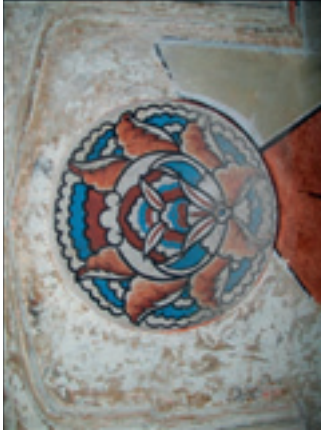
Fotoğraf 41 S.C. MO5 köşe mekanında eyvan hacminde bırakılan özgün mukarnaslar ile F.40'da geç dönem onarımında boyanmış olan kalitesiz ayraç çizgileri ve raspa sonuçları (a,b,c,d,e)
