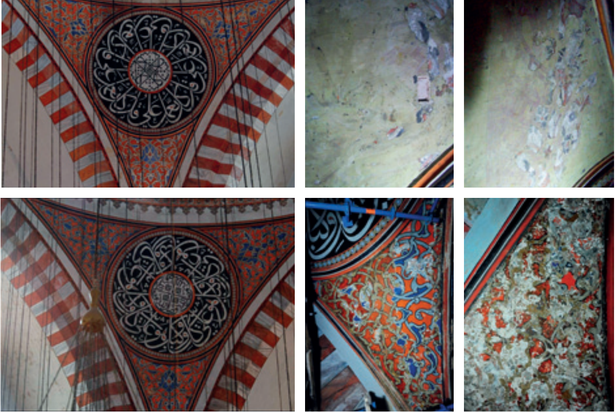
Fotoğraf 24-26 S.C.Merkezi kubbe pandantif (as2) yüzeyinde raspa sonuçları
