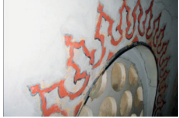
Fotoğraf 34 Mihrap yönündeki yarım kubbeye bağlı trompların pencere kalemişi raspa sonucu.
