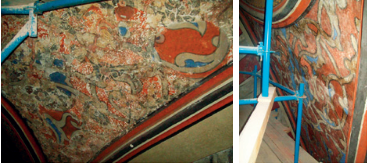
Fotoğraf 22,23 S.c.Merkezi kubbe psndantif yüzeylerinde raspa sonuçları
