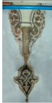
Fotoğraf 41 S.C. MO5 köşe mekanında eyvan hacminde bırakılan özgün mukarnaslar ile F.40'da geç dönem onarımında boyanmış olan kalitesiz ayraç çizgileri ve raspa sonuçları (a,b,c,d,e)
