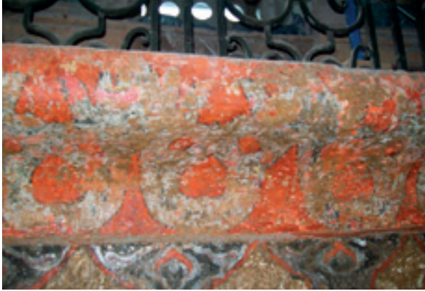
Fotoğraf 18,19 Merkezi kubbe kasnağı araştırma raspası sonuçları
