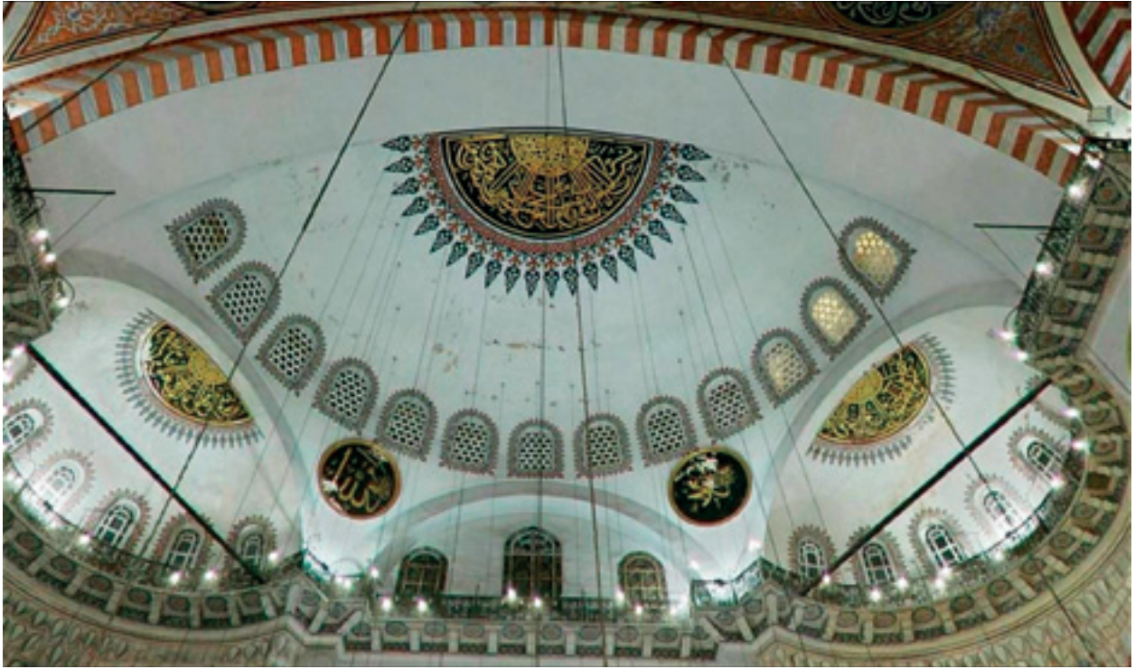
Fotoğraf 36 a,b. S.C. Mihrap ve giriş yönündeki yarım kubbelerde tromplardaki pencerelerde araştırma.
