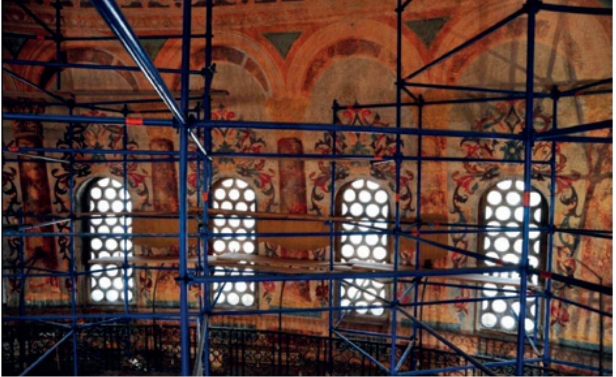
Fotoğraf 16 S:C:Harim merkezi kubbe badana raspası sonrası
