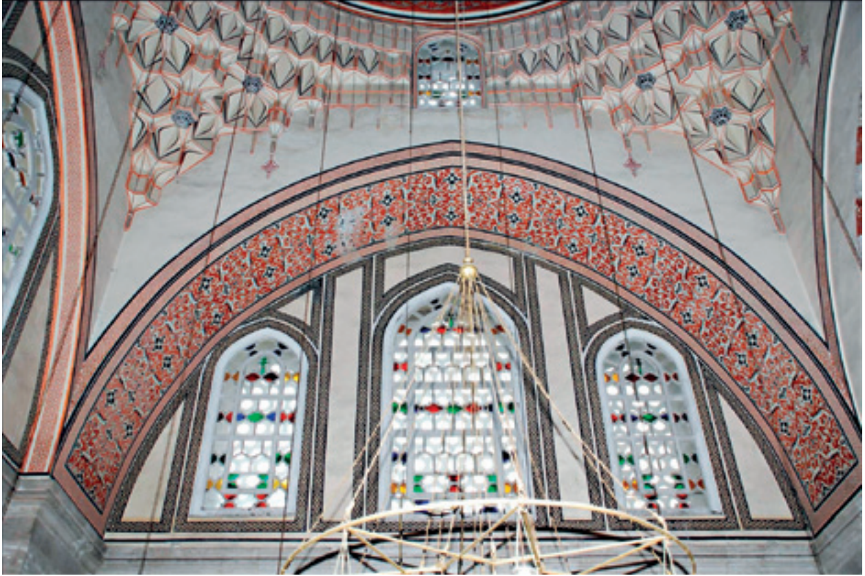
Fotoğraf 49 S.C.Hünkar Mahfili çimentolu sıva üzerinde mevcut bezeme.
