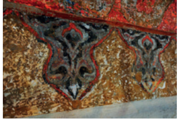
Fotoğraf 18,19 Merkezi kubbe kasnağı araştırma raspası sonuçları
