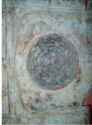
Fotoğraf 41 S.C. MO5 köşe mekanında eyvan hacminde bırakılan özgün mukarnaslar ile F.40'da geç dönem onarımında boyanmış olan kalitesiz ayraç çizgileri ve raspa sonuçları (a,b,c,d,e)
