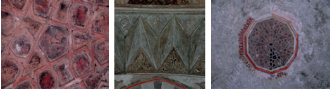
Fotoğraf 9-10-11 S.C. Avlu revakları Kba10 Kubbesinden raspa detayları
