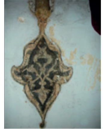
Fotoğraf 41 S.C. MO5 köşe mekanında eyvan hacminde bırakılan özgün mukarnaslar ile F.40'da geç dönem onarımında boyanmış olan kalitesiz ayraç çizgileri ve raspa sonuçları (a,b,c,d,e)
