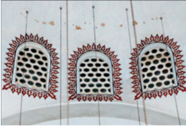
Fotoğraf 34 Mihrap yönündeki yarım kubbeye bağlı trompların pencere kalemişi raspa sonucu.
