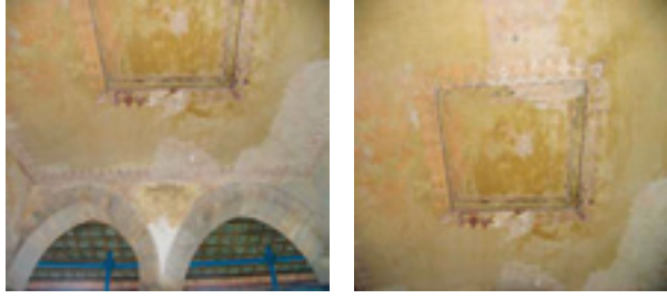
Fotoğraf 1-2 R1-2b ve 1-2b revakı araştırma raspası
