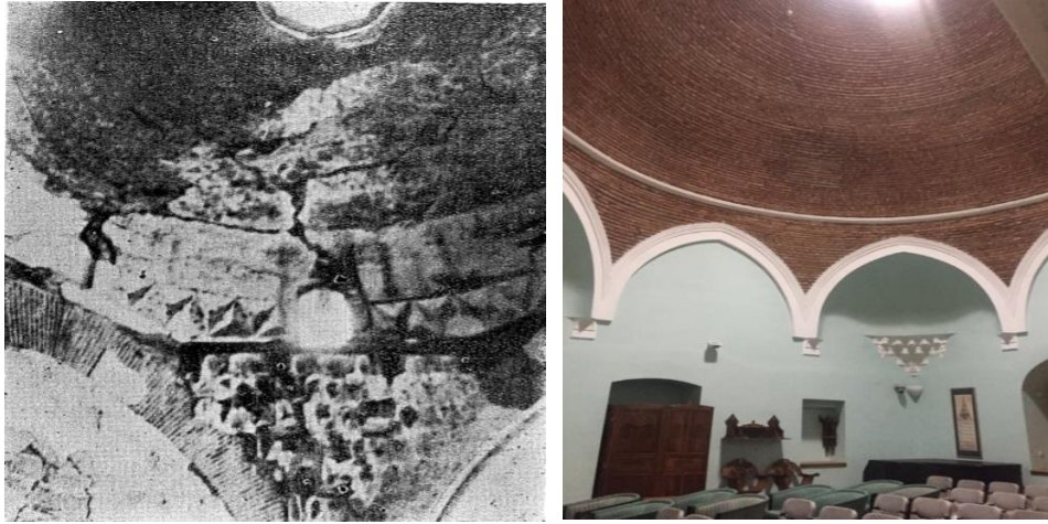
Şekil 2.3.14: Solda: Geleneksel “Baklava kabartma friz ve köşe mukarnasları”, (Aru, 1949, s.47) ve sağda: Saraybosna'da Gazi Hüseyin Hamamı'nda basitleştirilmiş versiyonu (yazar 2017).
