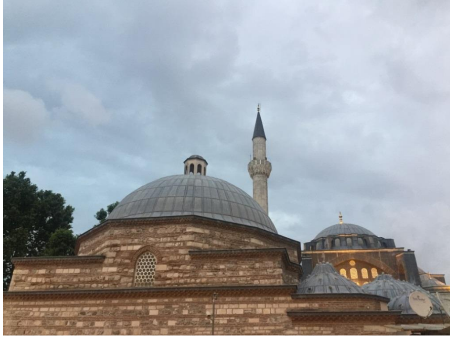
Şekil 3.3.2: İstanbul'daki Kılıç Ali Paşa Hamamı. Yapı son dönemde restore edilerek yine ilk işlevine uygun biçimde hamam binası olarak kullanıma girmiştir ( yazar tarafından çekilen fotoğraf, 2017 ).
