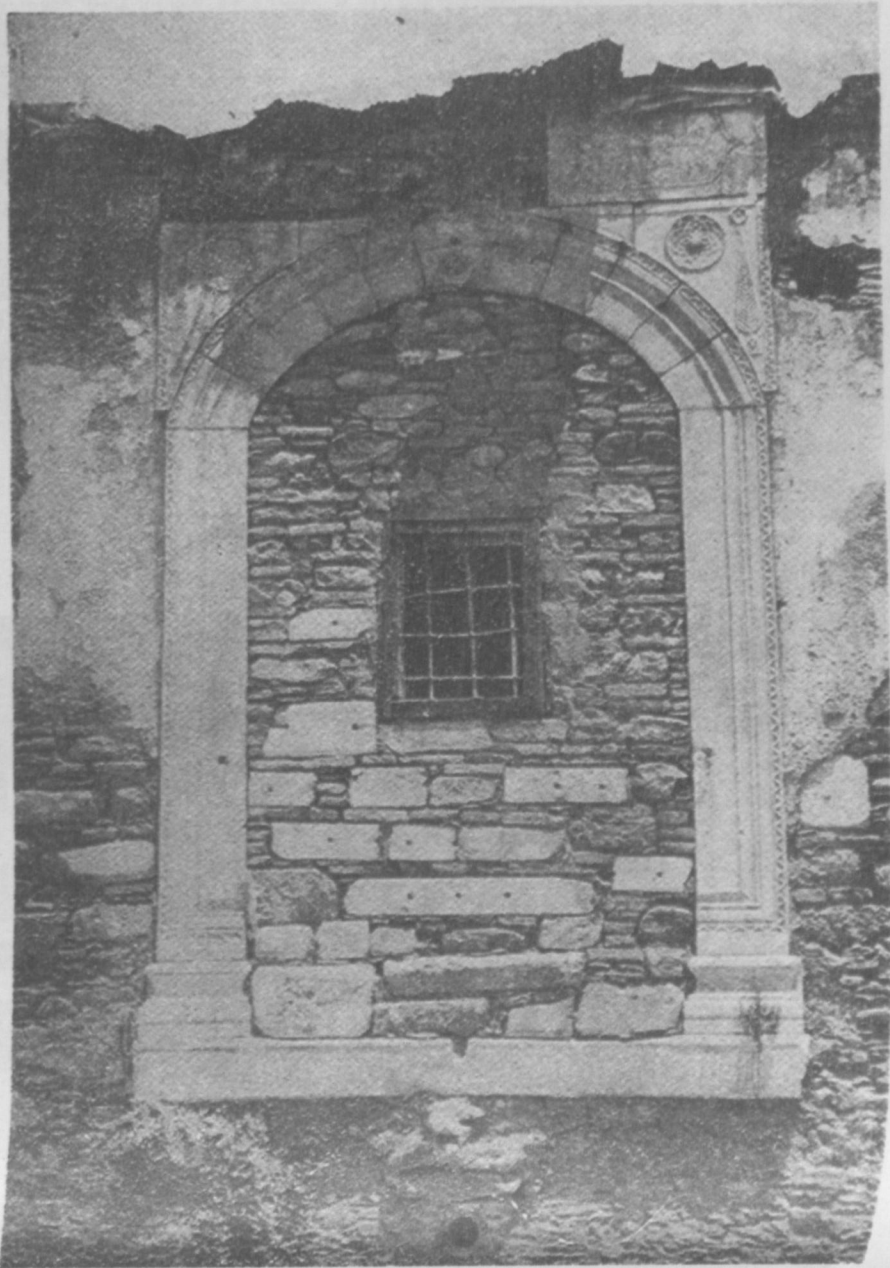
Res.: 5) Medrese, giriş kapısı.
