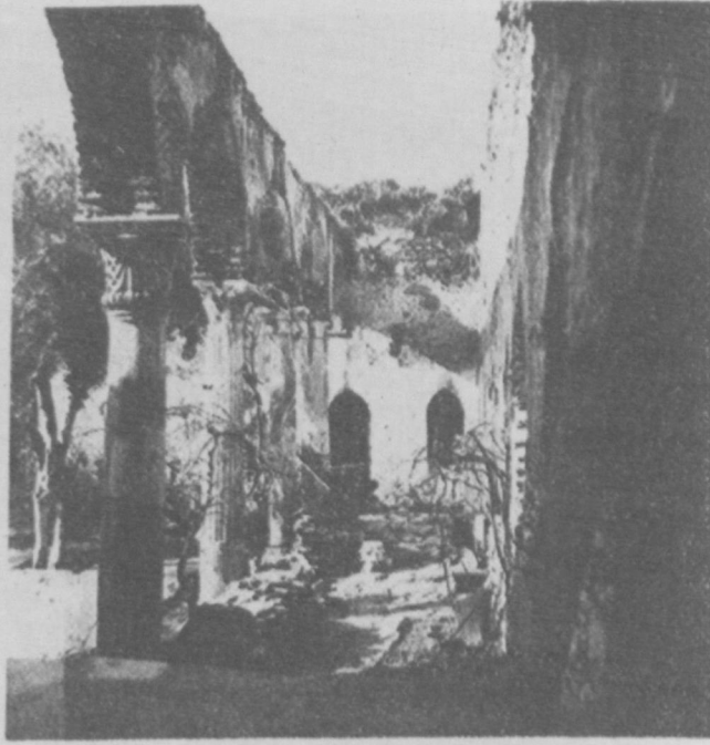
Res.: 25) Tire, Karakadı Meccedinin Medresesi. Revaklar, (1970 senesindeki onarımda üstü orjinaline uygun olarak meyilli ahşap kirişleme ile kapatılmıştır.)
